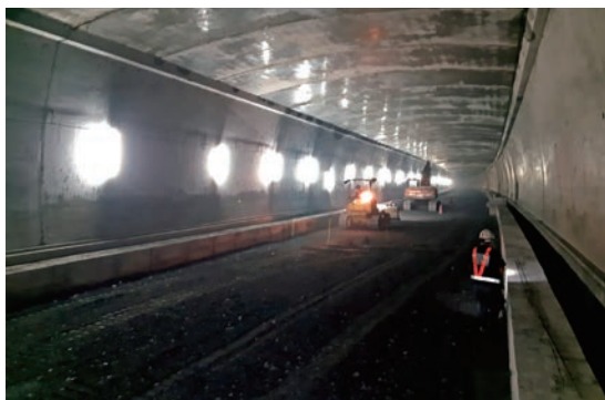
■ 觀音隧道級配回填
