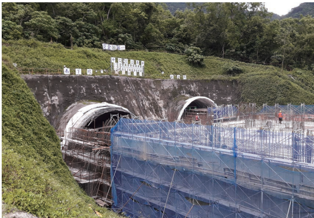
■ 南口機房施工情形
