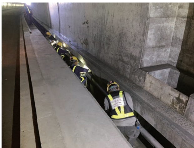
■ 給水管路安裝作業
