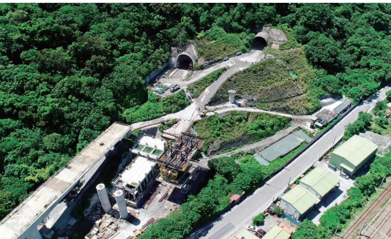
■ 谷風南口機房現況
