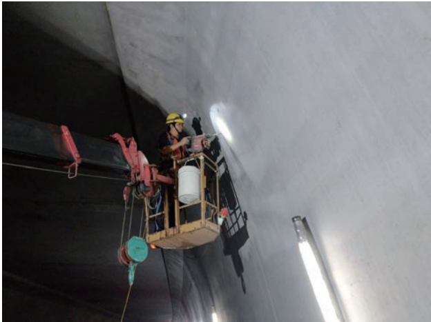
■ 仁水隧道漏波電纜支架安裝
