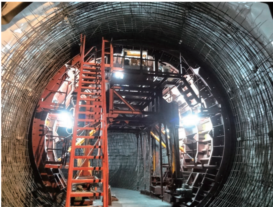
■ 車行聯絡道襯砌施工
