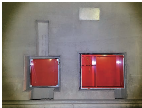
■ 水霧及消防栓箱安裝
