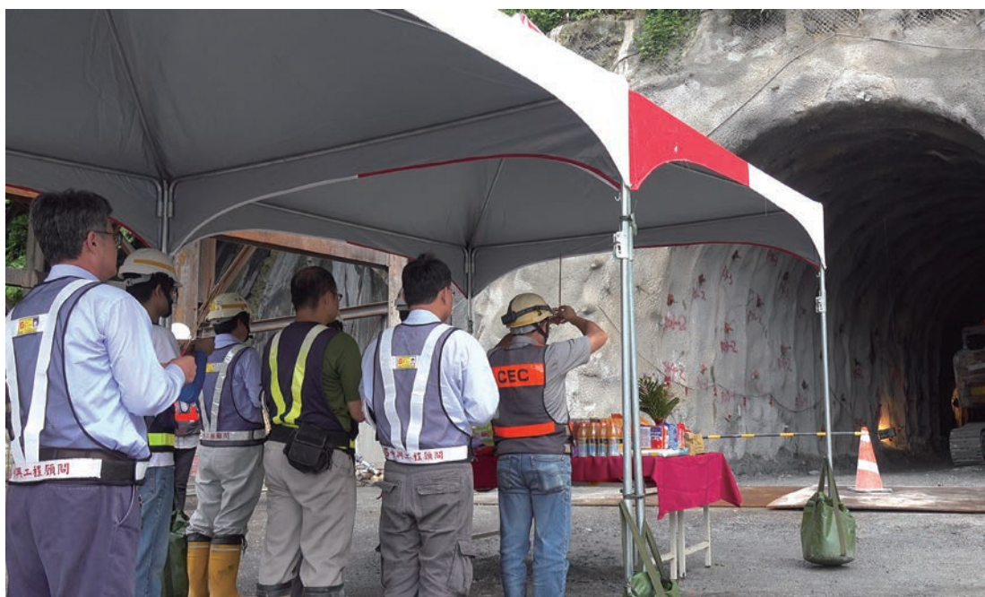
■ 107 年 7 月 23 日安全疏散通道開挖貫通照片
