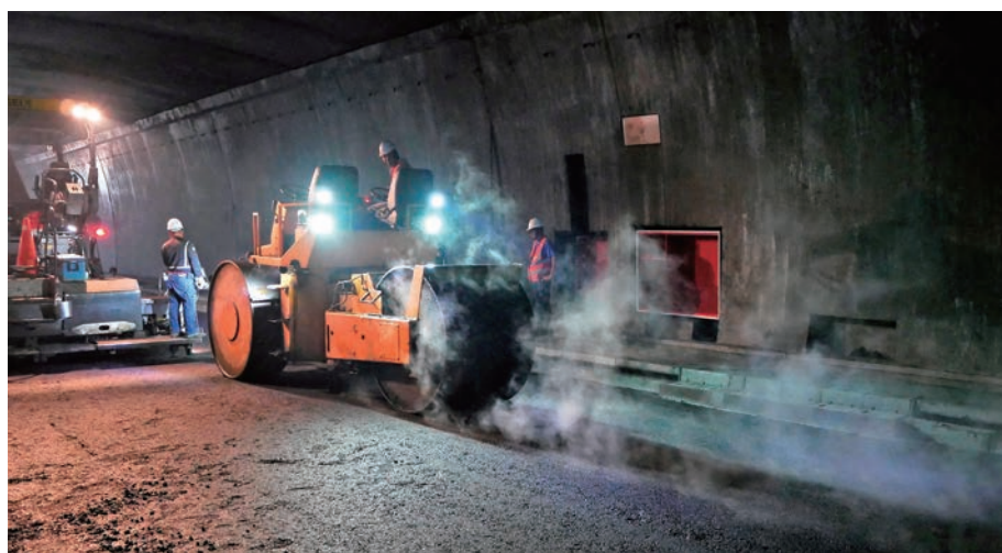
■ 瀝青混凝土滾壓施工
