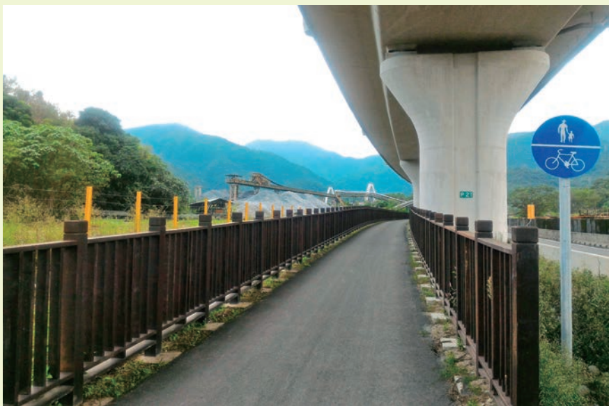
■ 白米高架橋下自行車道
