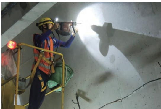
■ 觀音隧道漏波電纜支架安裝
