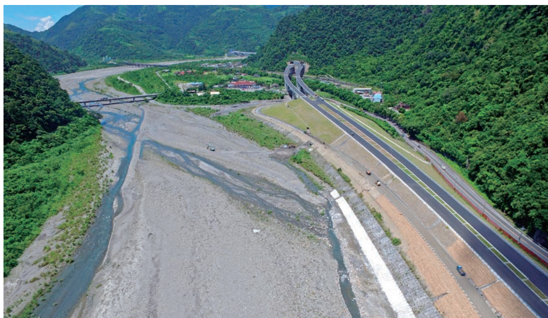
■ 南澳南溪路堤及武塔高架橋
