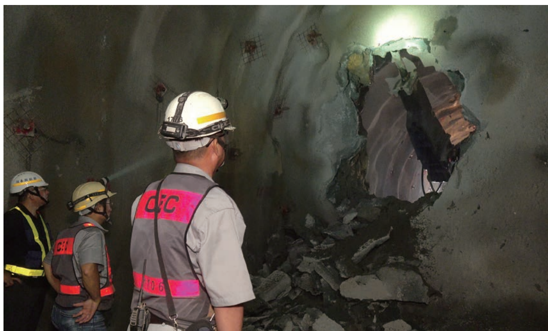
■ 107 年 7 月 23 日安全疏散通道順利貫通照片
