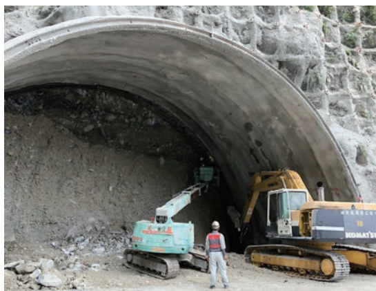
■ 南口主隧道開挖施工情形
