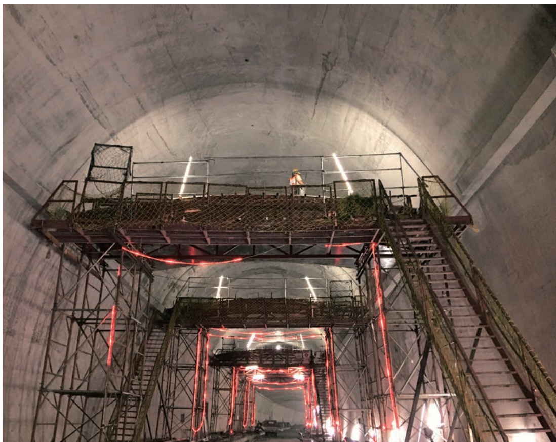
■ 通風隔板施工
