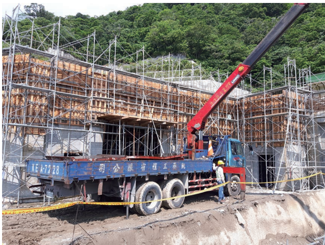
■ 北口機房施工情形
