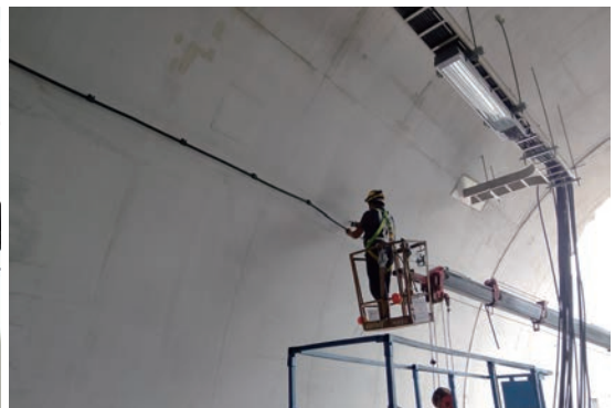
■ 武塔隧道無線電漏波電纜佈放
