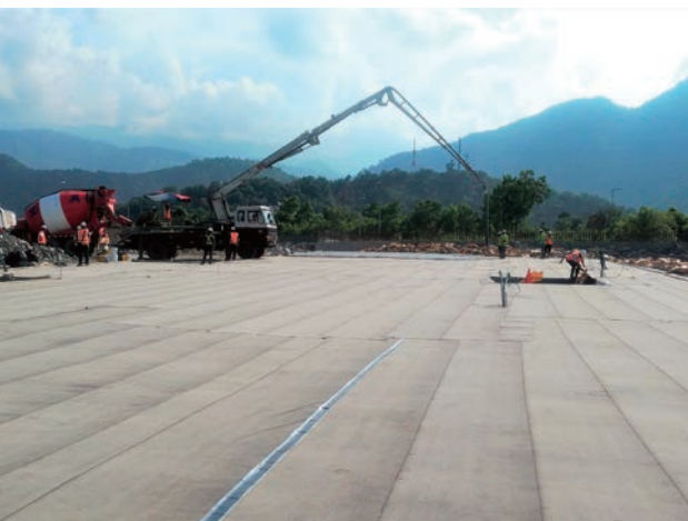
■ 防水膜鋪設完成及上層 PC 澆置
