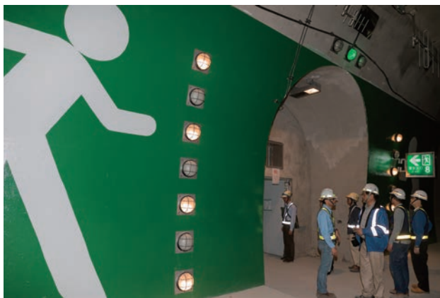
■ 第2階段通車勘驗
