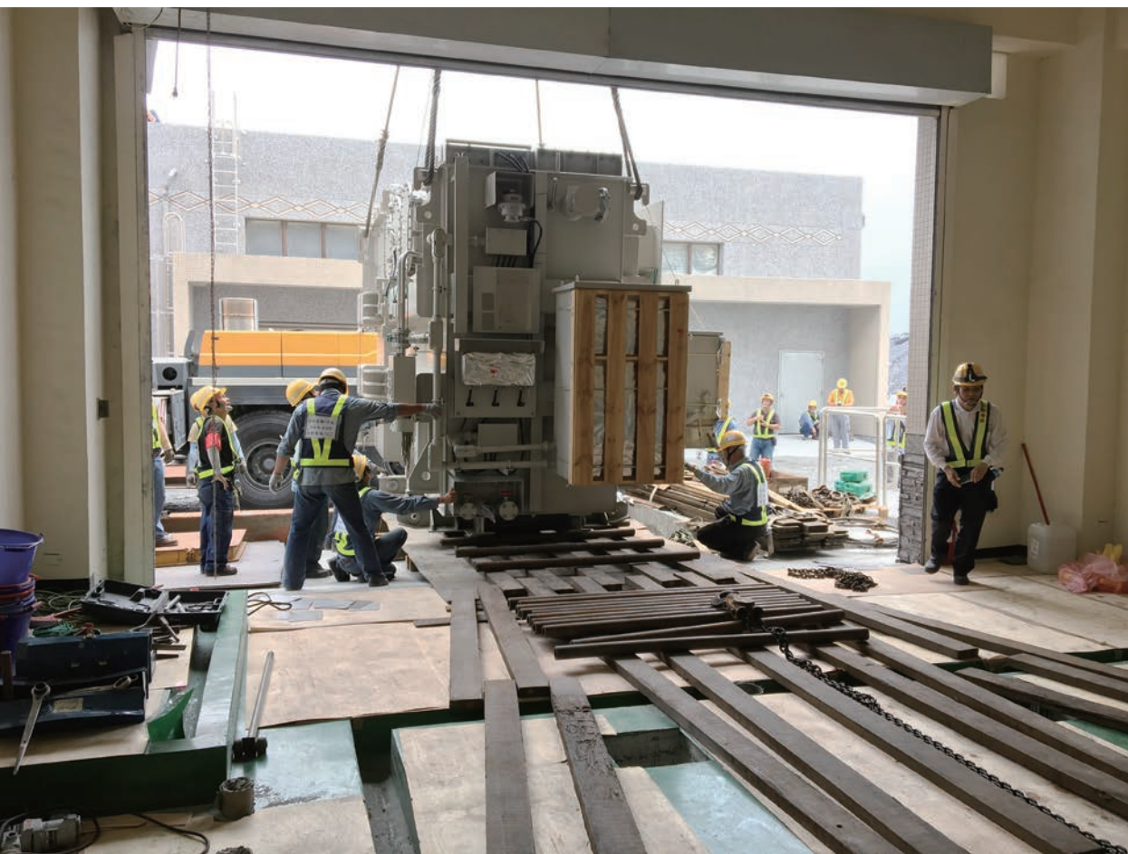
■ 161kV 變壓器進場吊掛作業
