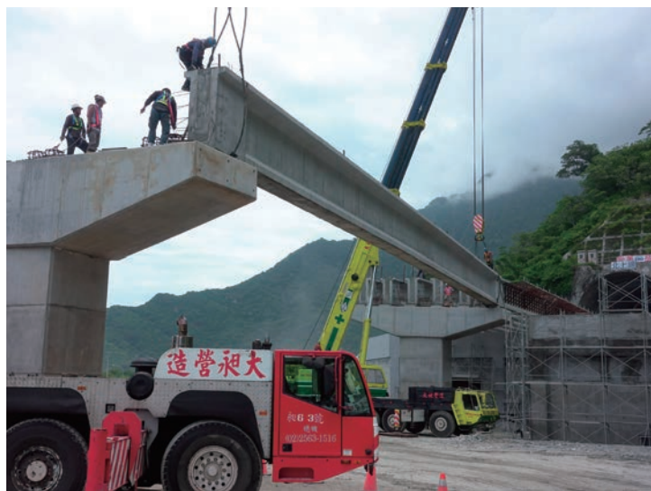
■ 北上線大梁吊裝
