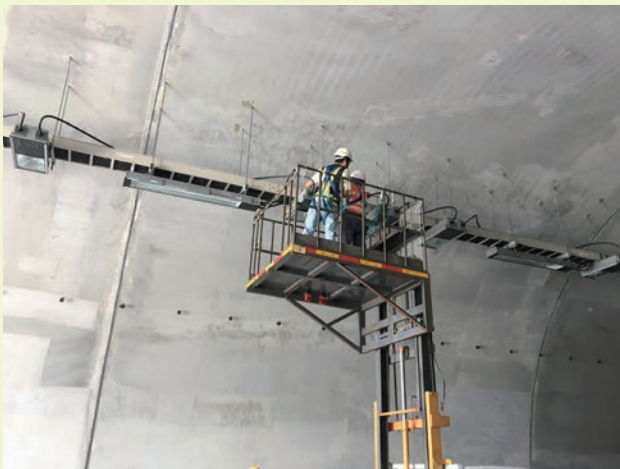
■ 武塔隧道電纜線架、燈具首件檢驗
