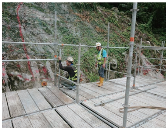
■ 排氣排煙隧道洞口邊坡保護施工架組立
