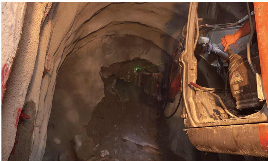
■ 107 年 7 月 23 日安全疏散通道開挖貫通照片
