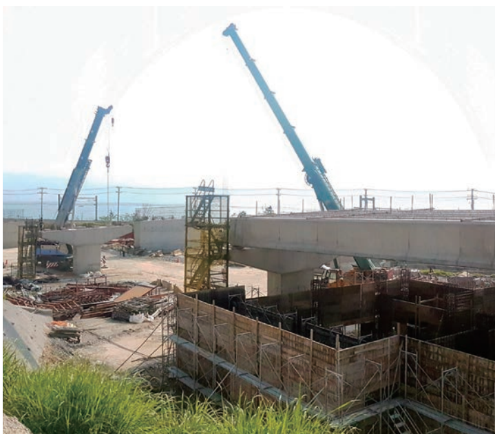
■ 南下線大梁吊裝
