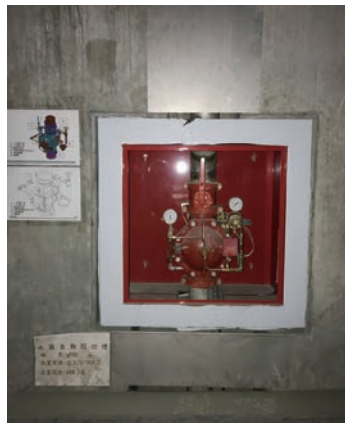
■ 水霧自動閥安裝作業
