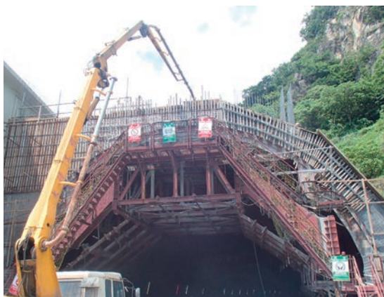
■ 主隧道北洞口明挖覆蓋段施作
