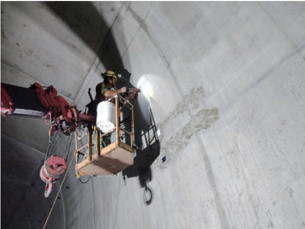
■ 中仁隧道漏波電纜支架安裝
