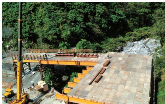
■ 主隧道南洞口施工構台完成
