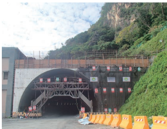
■ 主隧道北洞口明挖覆蓋段襯砌完成
