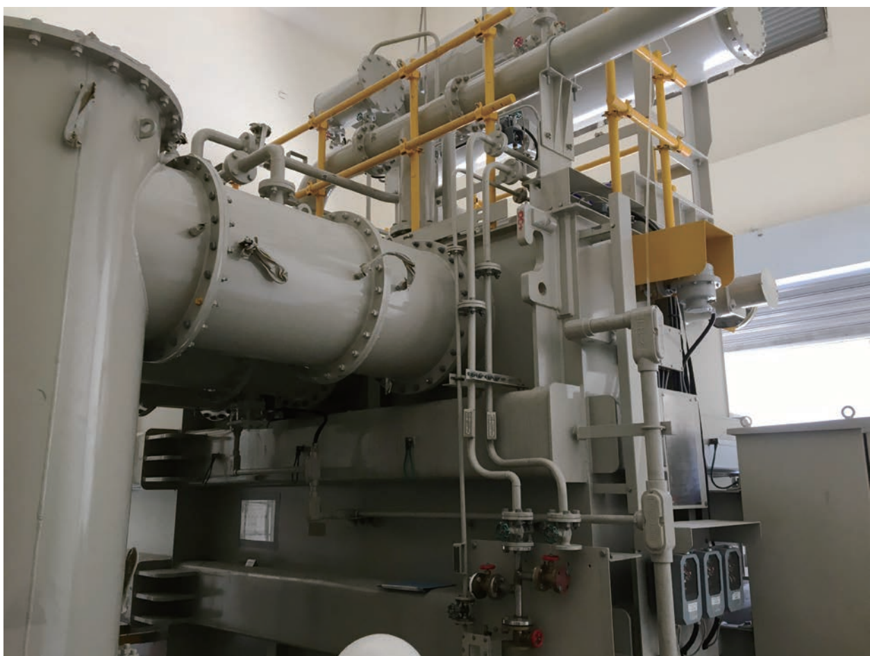
■ 161kV 變壓器組裝過程
