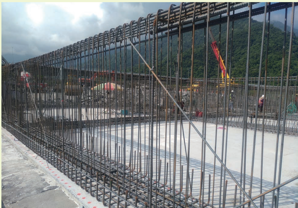
■ 筏式基礎鋼筋組立
