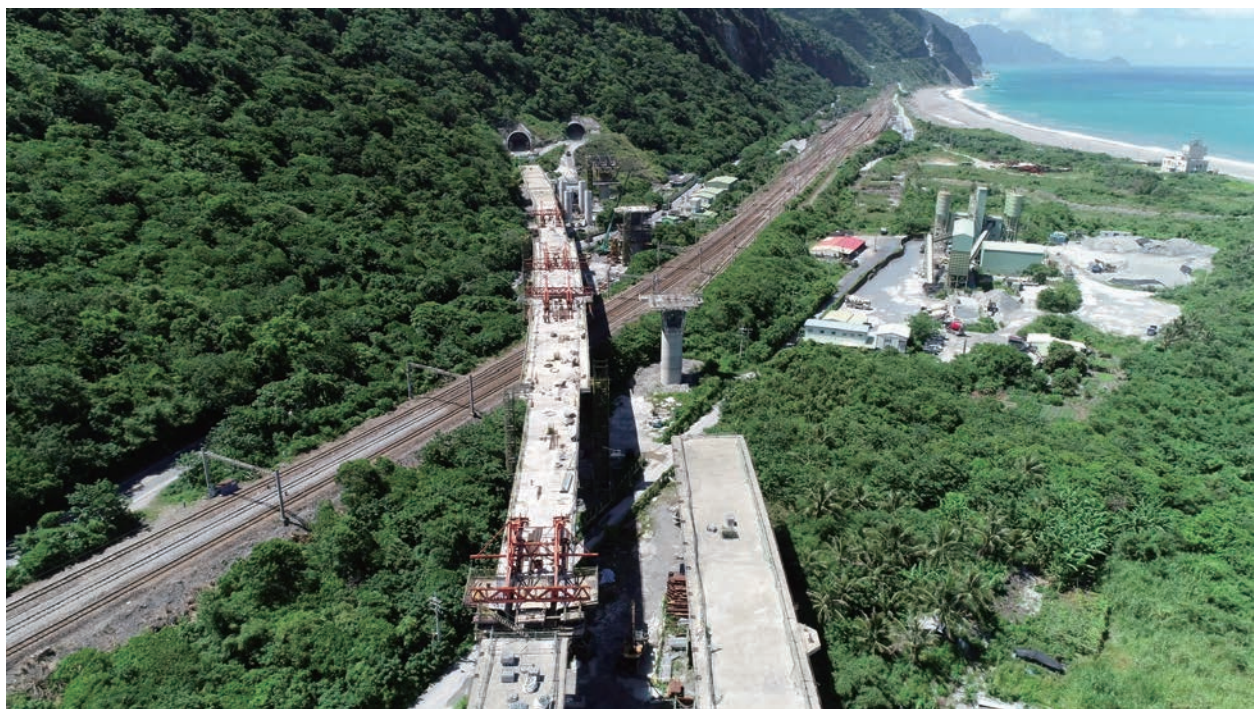
■ 漢本高架橋現況
