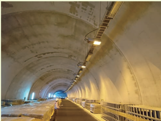
■ 武塔隧道照明系統迴路測試
