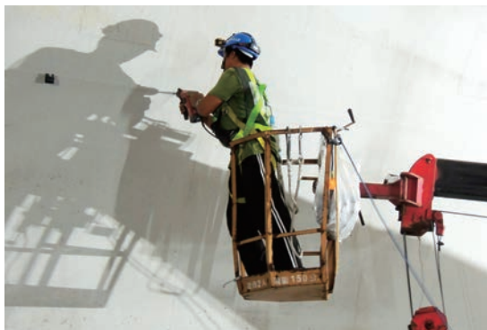
■ 武塔隧道漏波電纜支架安裝
