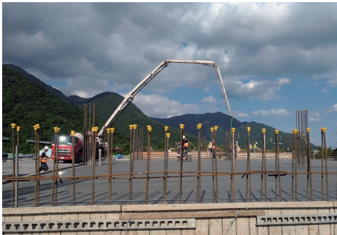
■ 1FL 版混凝土澆置
