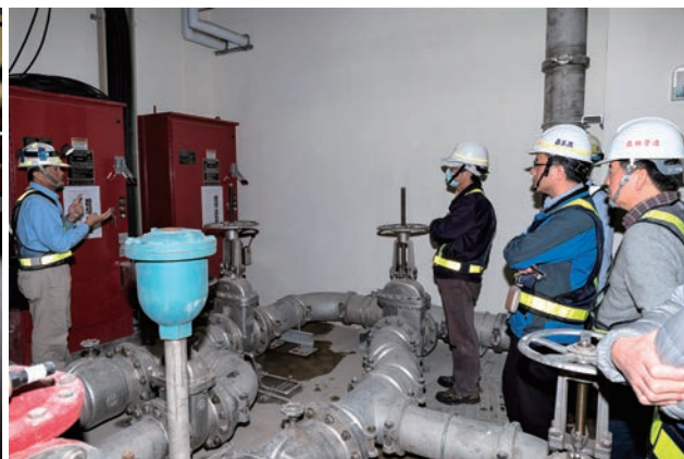
■ 第2階段通車勘驗
