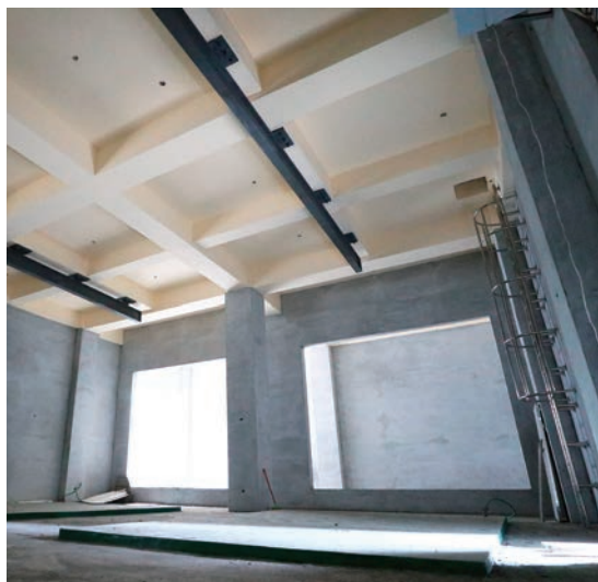
■ 北口機房風機設備室
