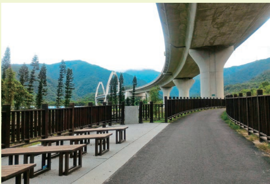
■ 白米高架橋下自行車道景觀平台
