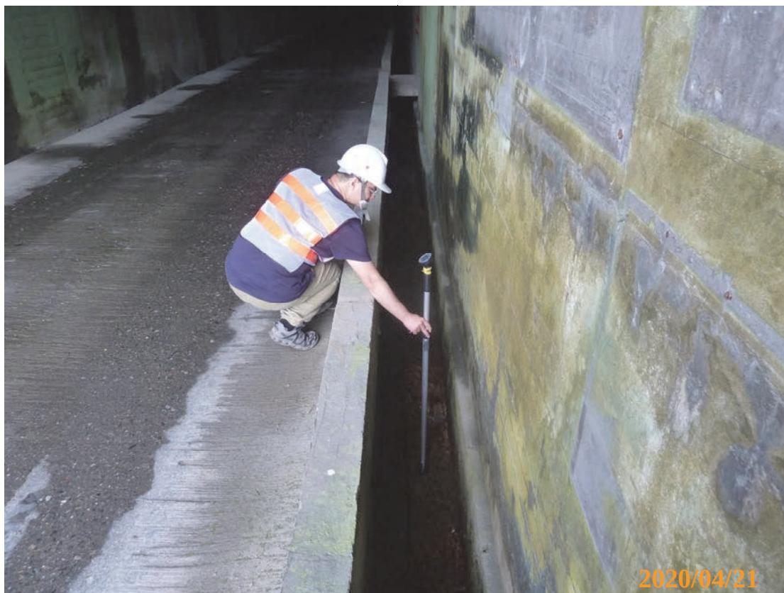
圖 2 觀音鐵路隧道北口排水量觀測作業
