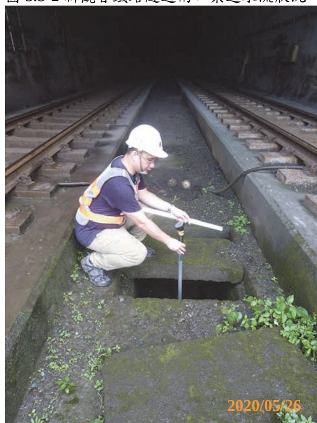
圖 3.3-4 新和平鐵路隧道北口渠道水流狀況
