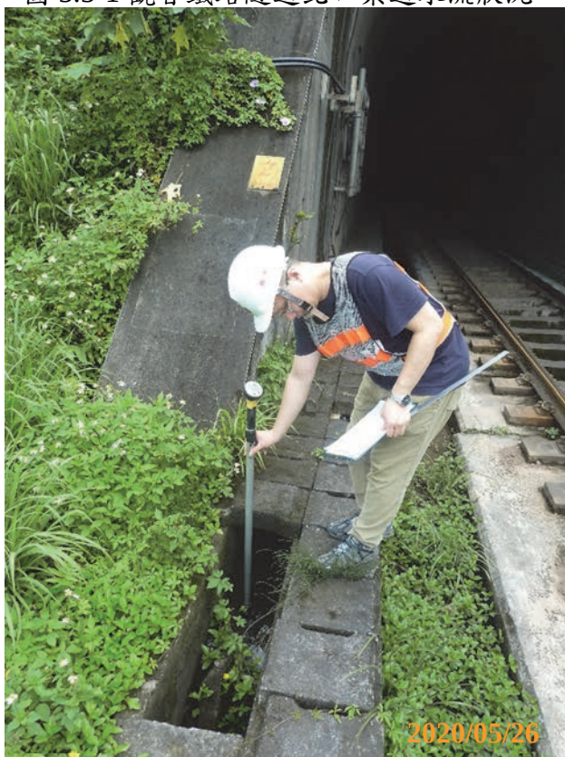
圖 3.3-3 新南澳鐵路隧道南口渠道水流狀況
