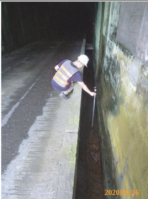
圖 3.3-1 觀音鐵路隧道北口渠道水流狀況
