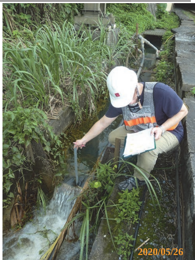
圖 3.3-2 新觀音鐵路隧道南口渠道水流狀況
