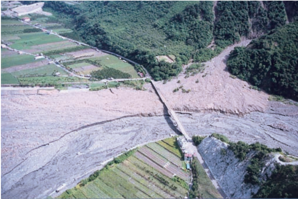
十八重溪橋受損空拍，2001年8月
