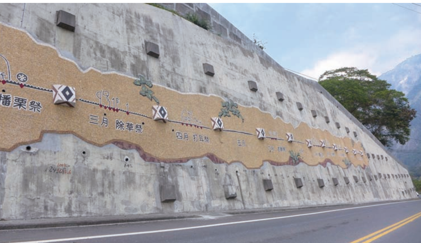
台21線100K的岩錨護牆嵌有布農族歲時曆版的圖樣，2014年2月
