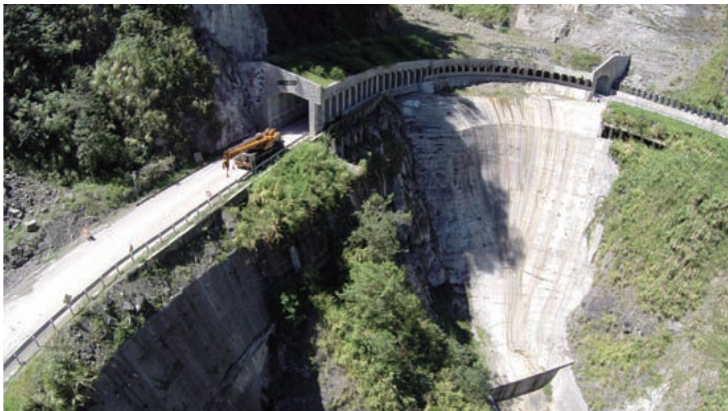
桂兒明隧道空拍，可見深達50公尺的水泥嵌入地錨「幕牆」，2014年10月
