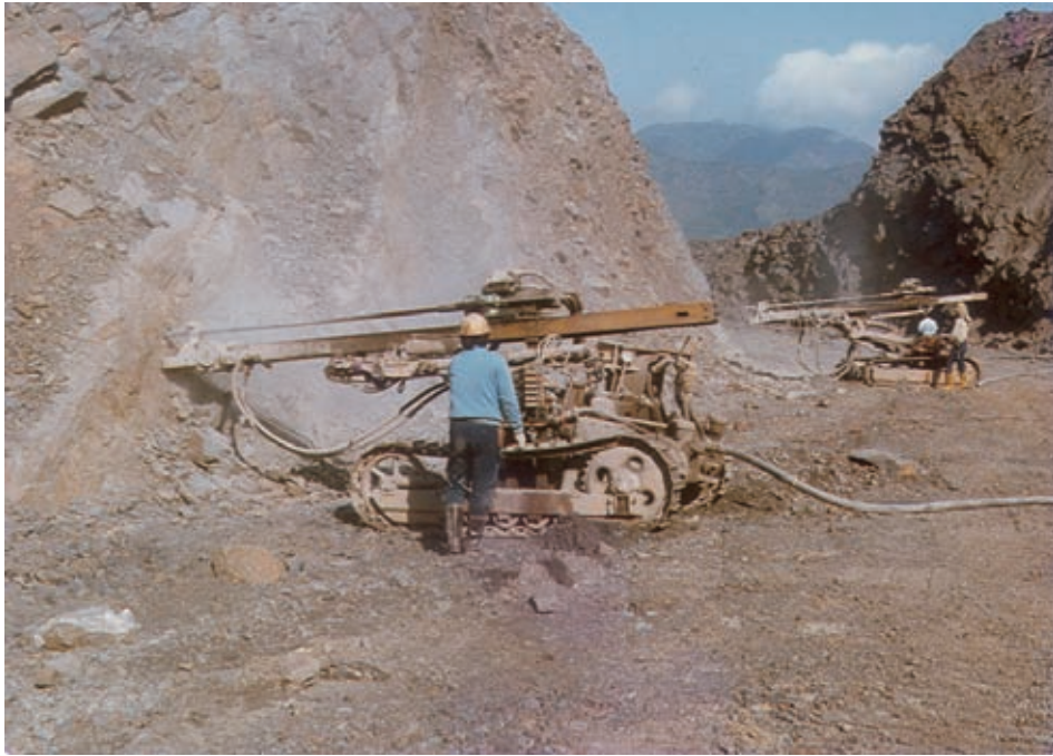
操作鑽岩機，原里程39K+800路段（今台21線113K+100），1986年
