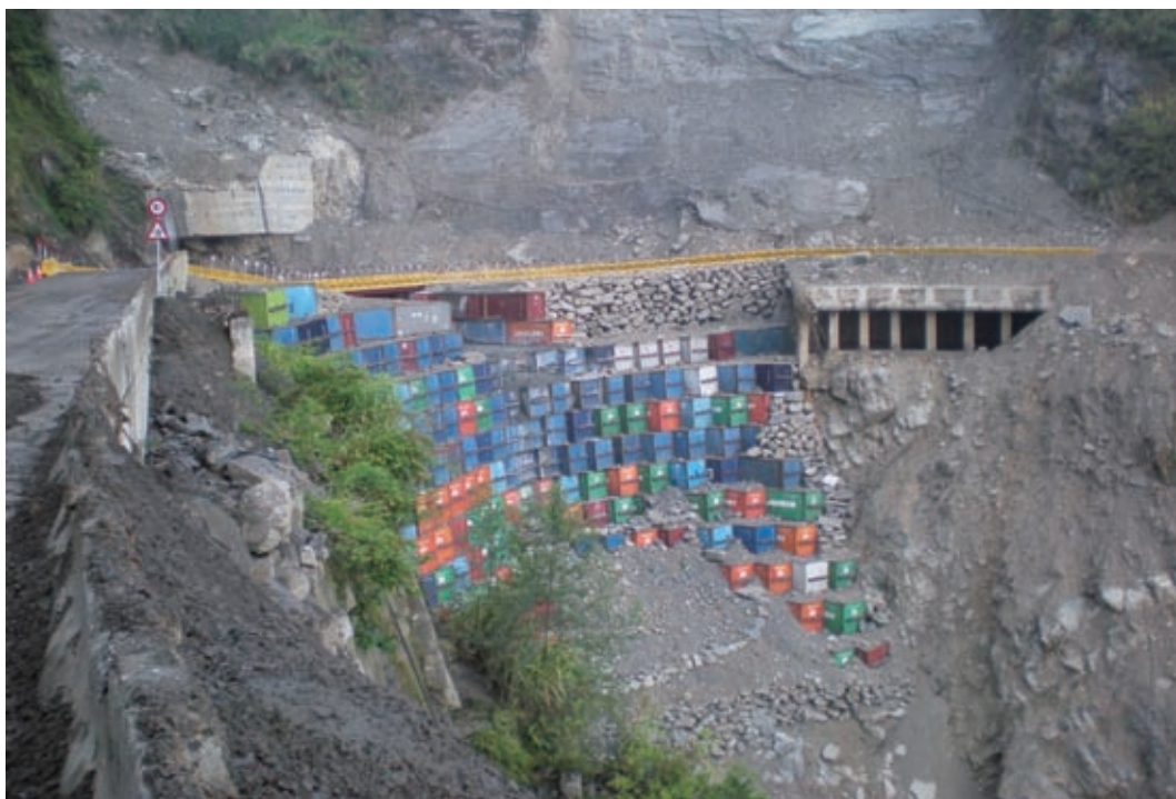
烏乾溪桂兒明隧道貨櫃工法，2009年10月3日
