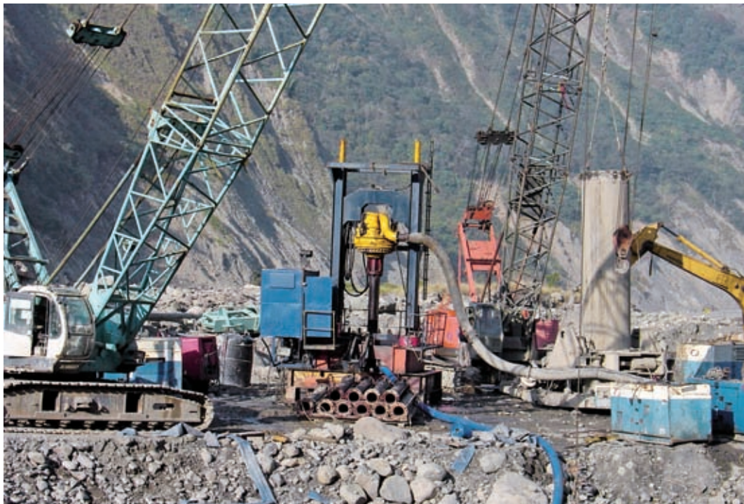
全套管基樁R.C.D鑽岩用反循環基樁系統機組，為國內第一次引進此類鑽岩機首例，後續國道六號興建也有沿用，是國內山區道路得以改線闢建長跨距高架橋梁的重要因素，2005年2月
