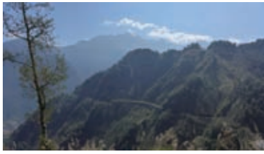
俯瞰東埔二號明隧道
