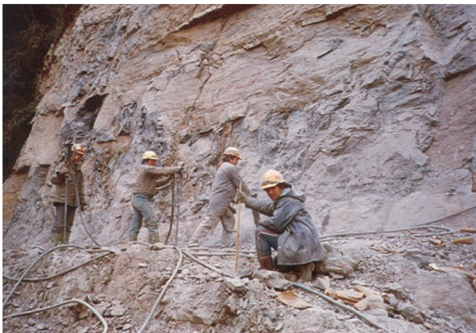
工人操作手持式鑽岩機，原里程 42K+280 路段（今台 21 線 117K），1986 年 1 月 26 日
