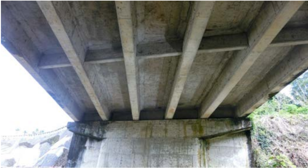
照片 5-2 橋面為 T 型梁結構
