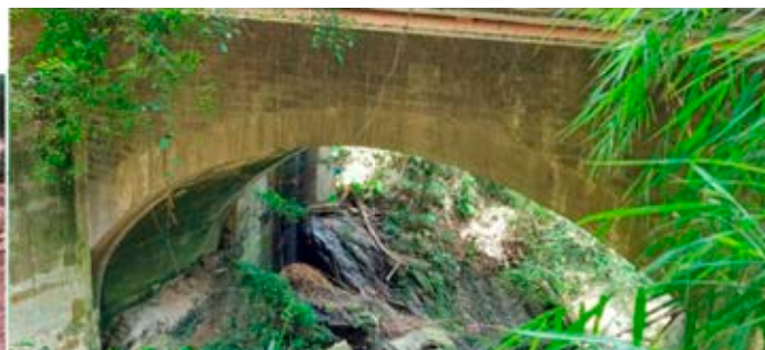
新庄橋拓寬完成後，保留下部結構為石拱橋。
