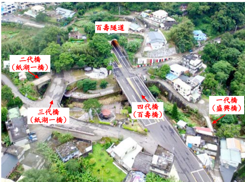
照片 1-1 百壽村台 3 線 4 代橋
