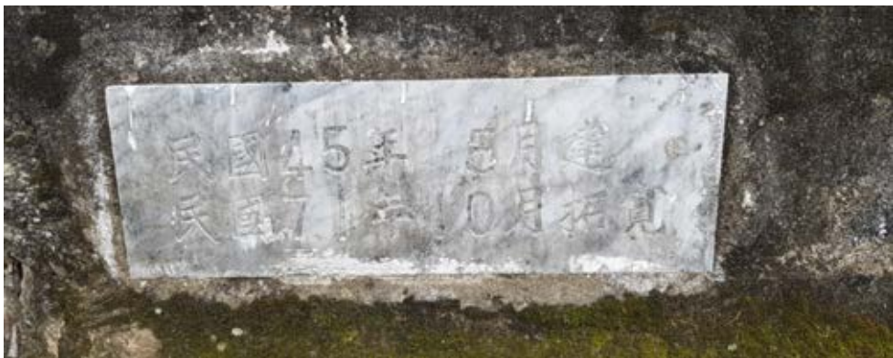
照片 5-4 竣工時間註記「45 年 5 月建 71 年 10 月拓寬」，係誤用同時間施作「新庄橋」資料。
