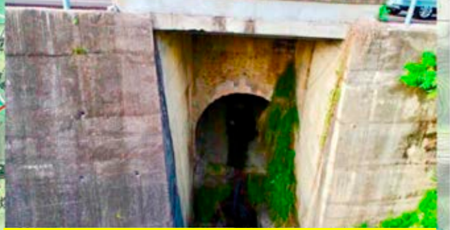
台 3 線 110K+145 永興二號橋下部結構為石拱橋。
