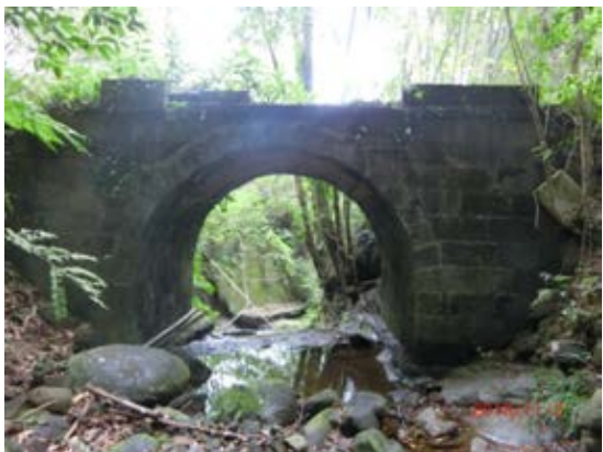
石橋照2 獅潭 永東橋
