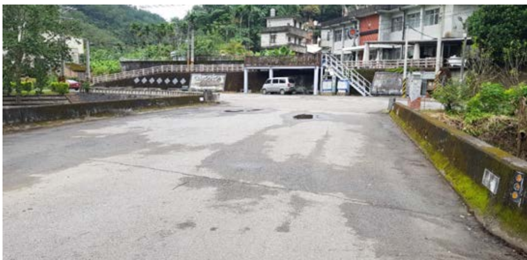
照片 5-1 紙湖三代橋梁，橋面鋪設瀝青混凝土路面。
