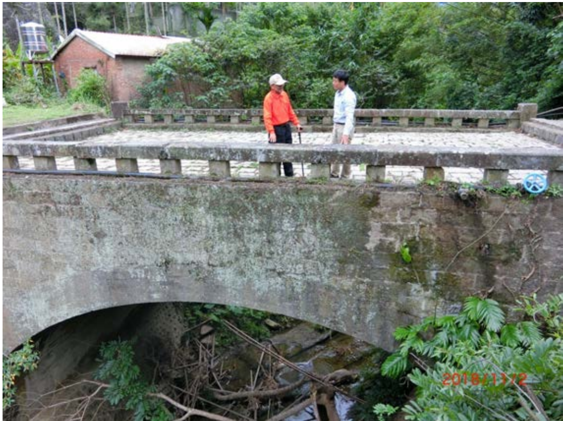
照片 4-2 楊萬壽（左）說明所施作簡潔石護欄及橋身兩側砌石牆。
