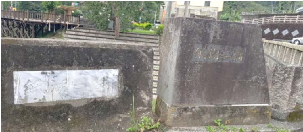
照片 5-3 左邊原竣工時所註記橋名為「紙湖一橋」，後續城鄉風貌營造時更改為「紙湖二橋」。
