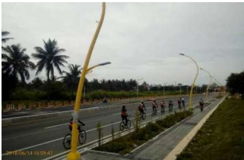
圖 2.12-3 17K+500~17K+600 南濱公園段南下車道拓寬後現況照片
