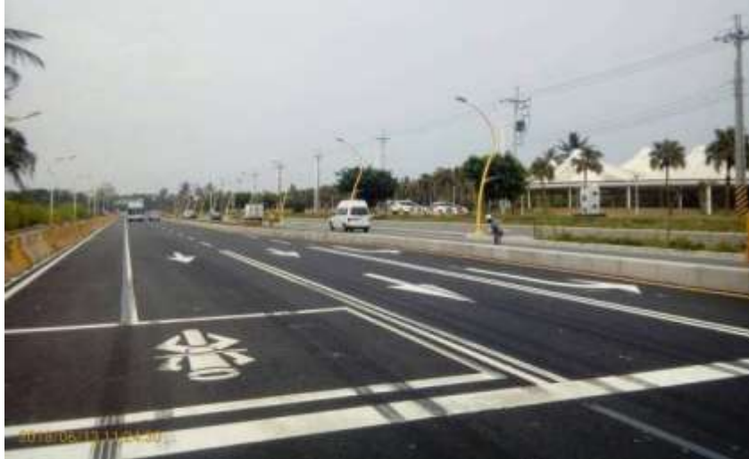
圖 2.12-2 17K+300~17K+400 南濱公園段南下車道拓寬後現況照片
