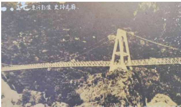
東河橋一代橋是鋼索吊橋，橋身護欄全由紅檜木打造。
