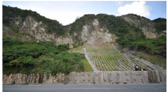
護坡工程施工完成的樣貌。
