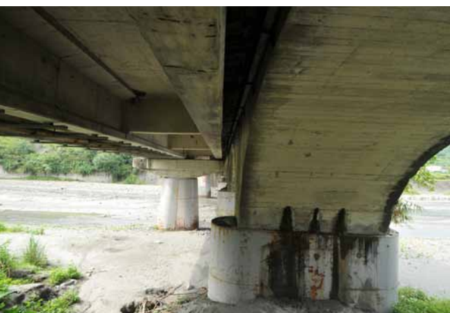
豐濱橋新舊橋橋底結構，右為日據時舊橋。
