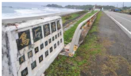
台 11 線烏石鼻路段旁的海堤。
