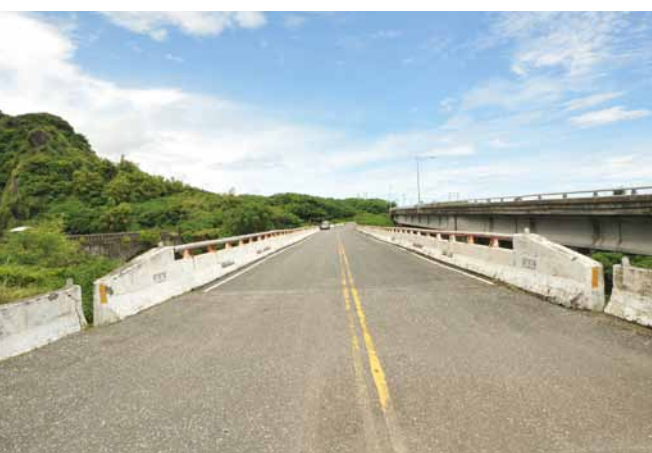
第二代樟原橋橋面仍可通行汽車。
