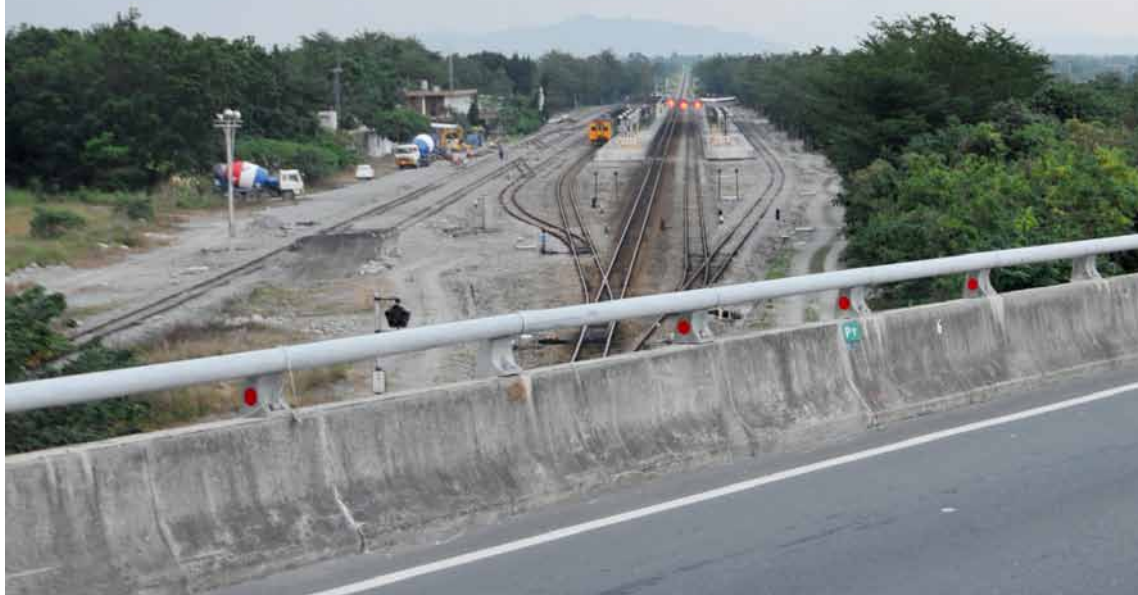
台 11 線知本陸橋是台 11 線 178 公里中唯一的跨越鐵路橋梁。
