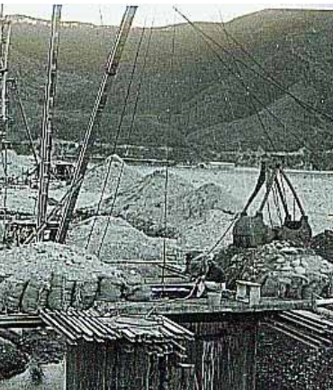
一代橋沉箱施作。
