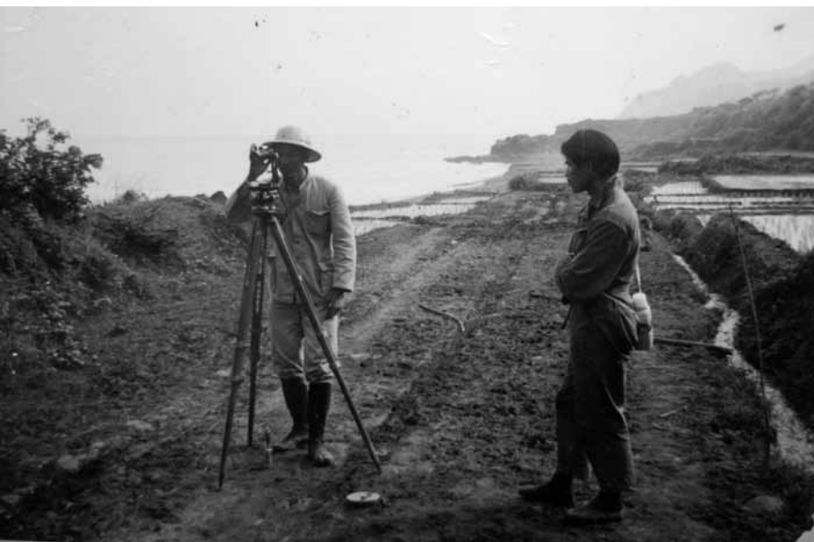
花東海岸產業道路初期測量作業在民間便道上展開。 圖片 / 陳精微
