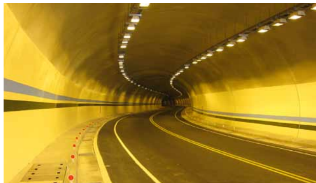
完工的 新豐隧道 內部車道。 圖片 / 鄒忠文
