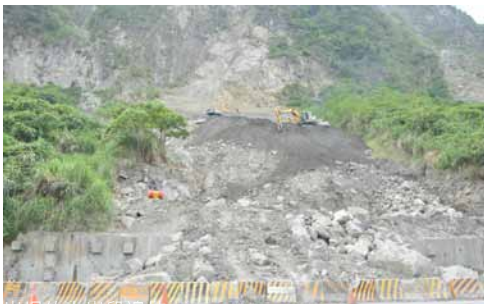
護坡工程施工進行的樣貌。
