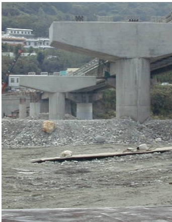
逐一完成的橋墩。
