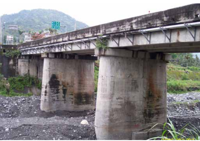
30 號橋改善前舊橋側面
