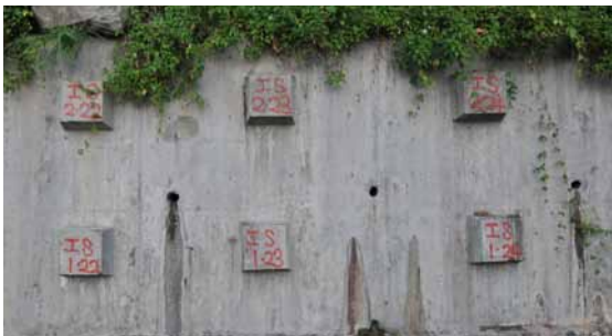
配有地錨的擋土牆，增加泥岩抗剪強度。
