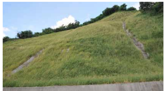
大崩段邊坡施以植生護坡工法後綠色植被包覆完好。
