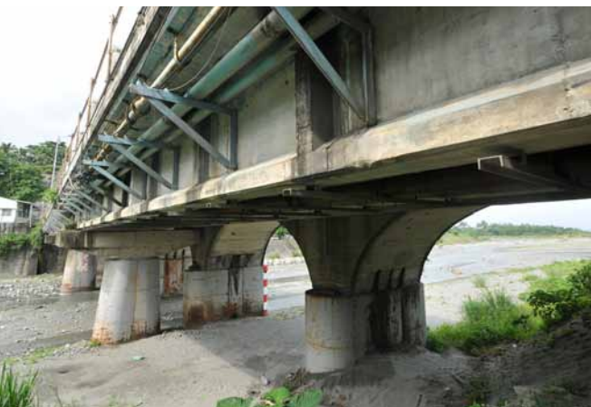
豐濱橋上游側新橋下
