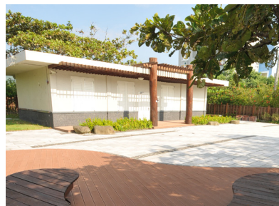
修整後的水璉道班房。
