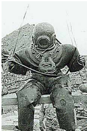
一代橋沉箱作業的潛水伕。
