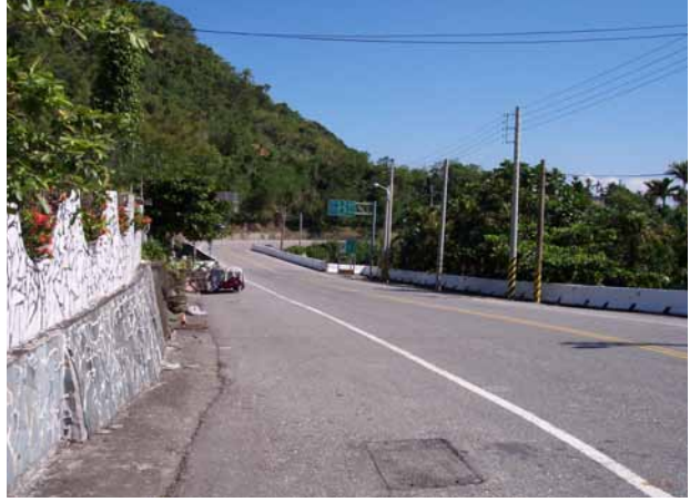
30 號橋改善前端呈近 90 度的轉角。 圖片提供 / 公路總局第四區養護工程處
