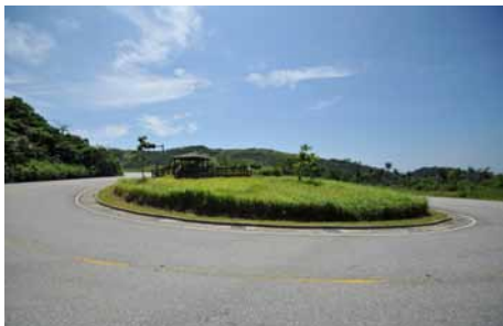
芭崎段舊路線上的髮夾彎道。
