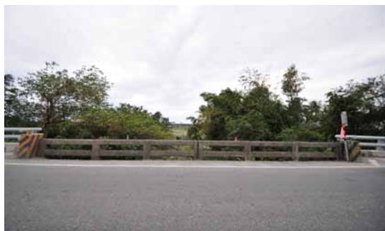
民國 61 年搭建的富源橋橋寬見證舊台 11 線的路面寬度。
