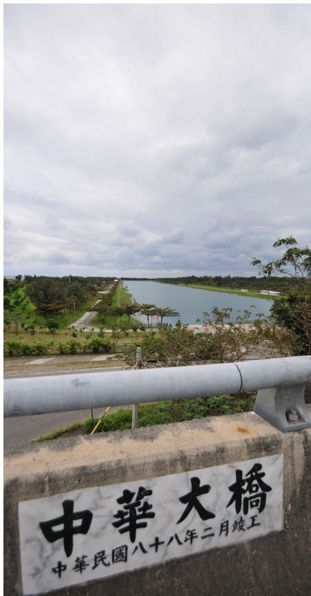
中華大橋卑南溪下游側橋名石上的竣工年份是民國 88 年。
