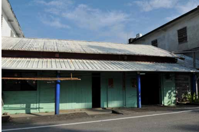
舊台 11 線木造家屋，馬路地基墊高後，房子與路面有落差。
