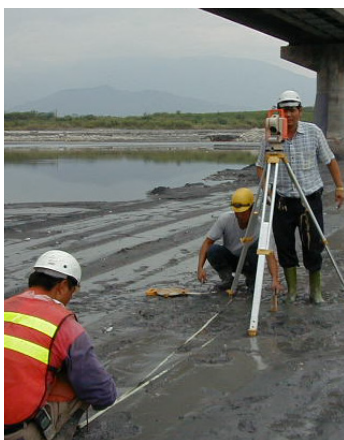
花蓮大橋二代新橋施工測量。
