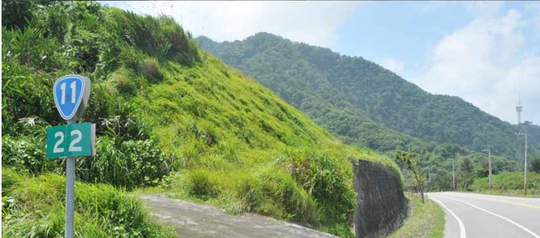
台 11 線 22K 邊坡整治後，不再崩塌，22K 上坡是台 11 線全線唯一的不對稱車道，這是針對坡度超過 10% 時多關給重車的爬坡道。
