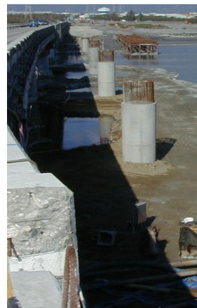
二代新橋橋墩柱施工。
