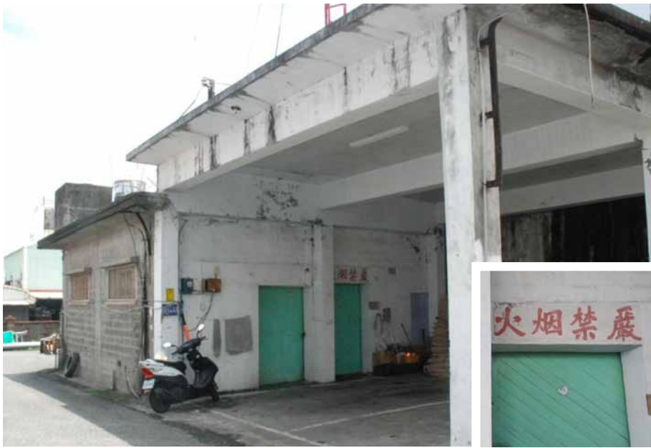
因應台 11 線台東段需求而設的成功監工站，站內還保有火藥庫房。 圖片 / 公路總局第三區養護工程處
