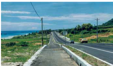
臨海側設 2.5 公尺寬腳踏車專用道，圖為施工時。
