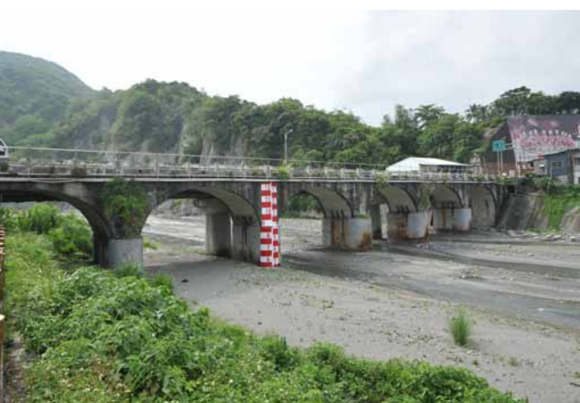
豐濱橋下游側邊舊橋
