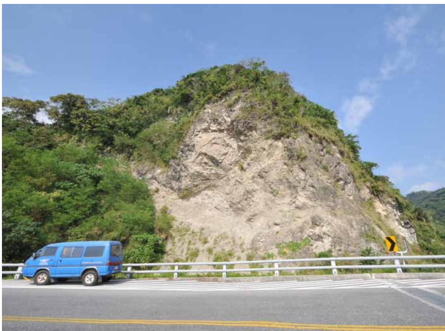
台 11 線 35K+867，20 號橋南端的崖壁有罕見砂質岩脈露頭，地質脆弱有經常性落石故另靠海側築一新橋，取橋名為砂脈橋。
