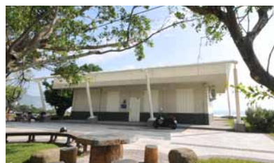
整修後成為磯崎監工站。
