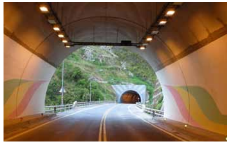
跳浪段改線並興建隧道群現況。 圖片 / 公路總局第四區養護工程處
