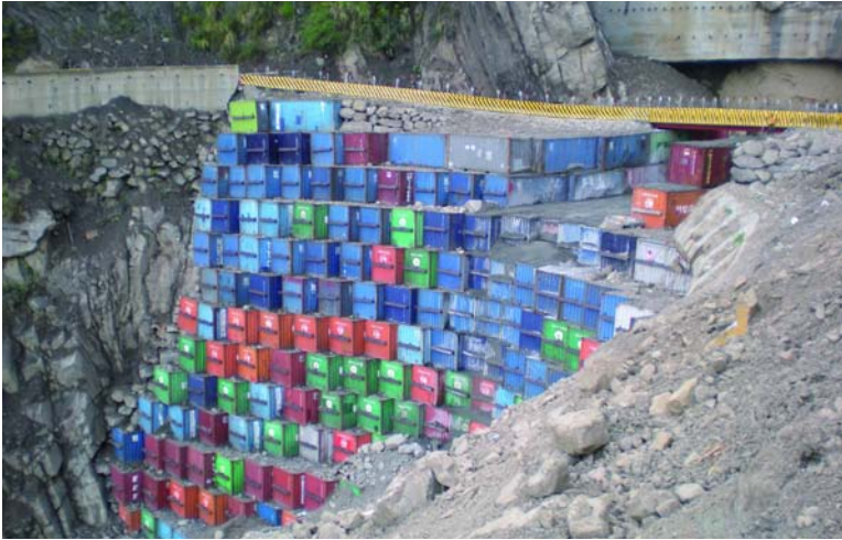
↑ 台 21 線 122.6k 邊坡工程
