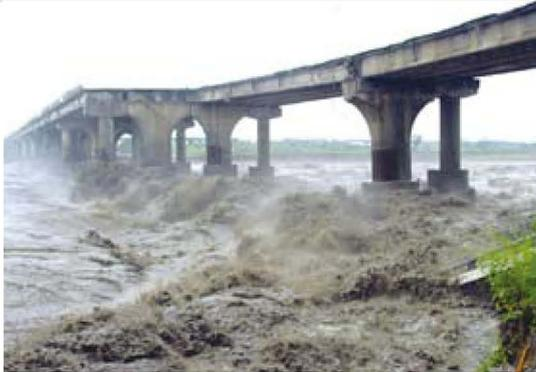
本局所轄省道橋梁達2,000餘座，各養護工程處對轄區之橋梁維護不遺餘力，但近年來全球氣候異常，又因臺灣地區河川坡陡流急，每逢汛期及颱風之暴雨，洪水迅速漲落且水勢洶湧，劇烈淘刷橋墩及橋臺之基礎處河床，致每年幾乎都有橋梁受損，更甚者造成土石流、洪水災害而導致原本已裸露之橋基更形惡化，甚至橋梁傾斜、倒塌，造成交通中斷，對人民生命及財產安全造成莫大的傷害。97年9月強烈颱風辛樂克（SINLAKU）造成台13線后豐大橋發生橋面斷落事件後，行政院責成交通部應就橋梁全面進行檢測，篩選出有潛在風險之橋梁，在最短時間內完成改善作業，維護民衆通行安全。
