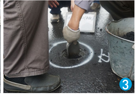
3 填入瀝青砂調平坑洞底部
