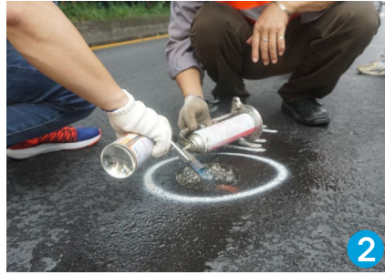
2 以噴燈烘乾鑽孔表面乾燥
