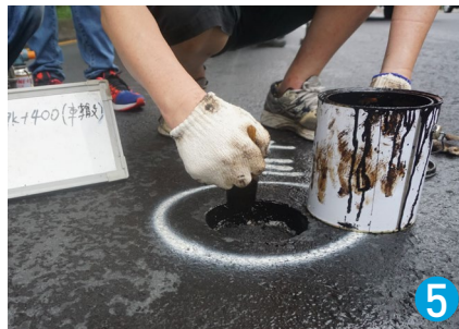
5 鑽孔四周及底部均勻塗抹黏著劑
