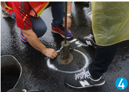
4 使用夯錘夯實瀝青砂底部平整
