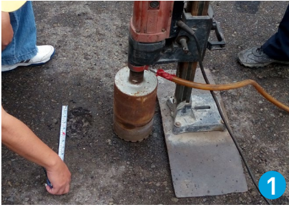
1 於坑洞中心處先進行鑽孔
