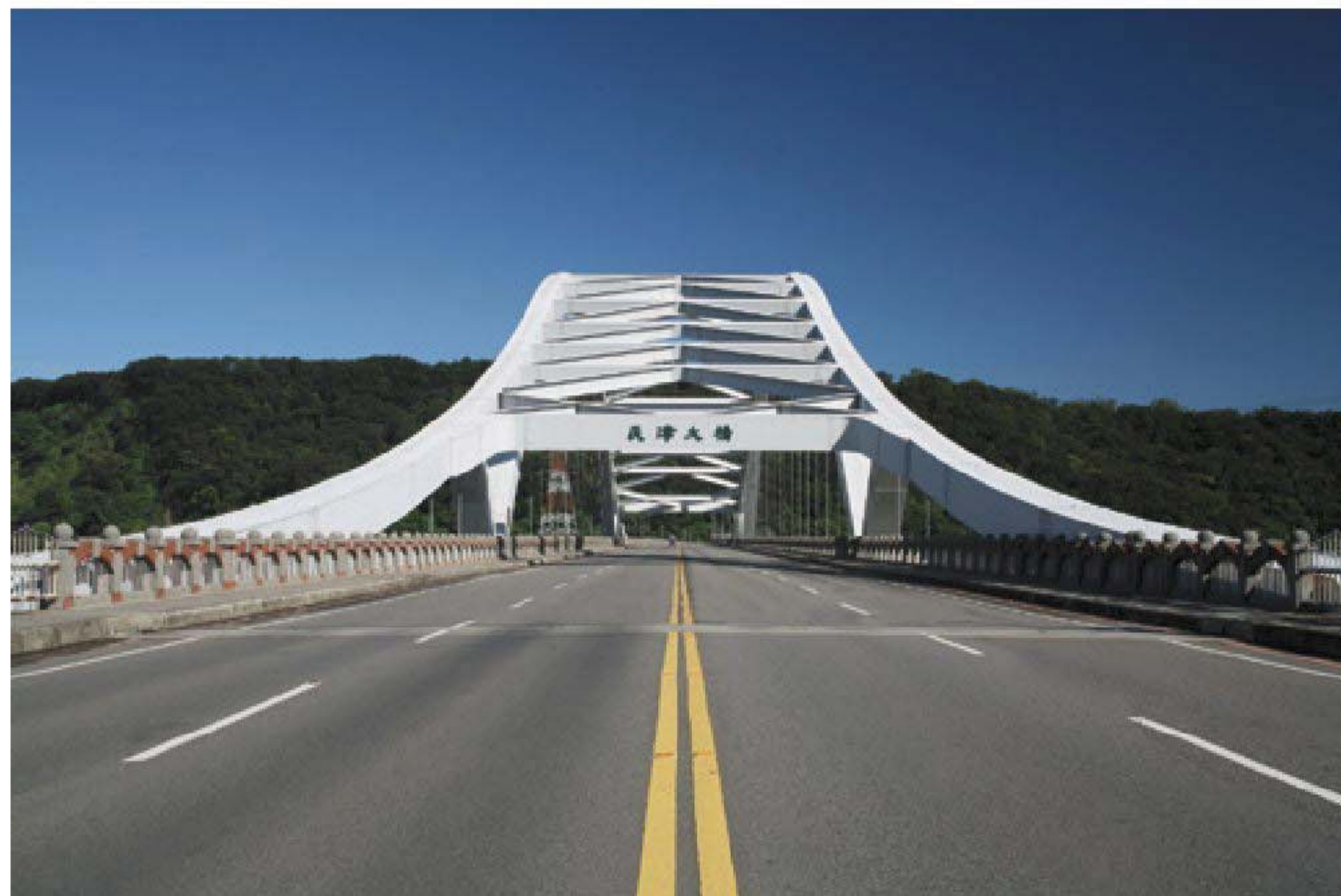
臺4線炭津大橋—跨越大漢溪，全長776公尺，91年8月完工通車。
