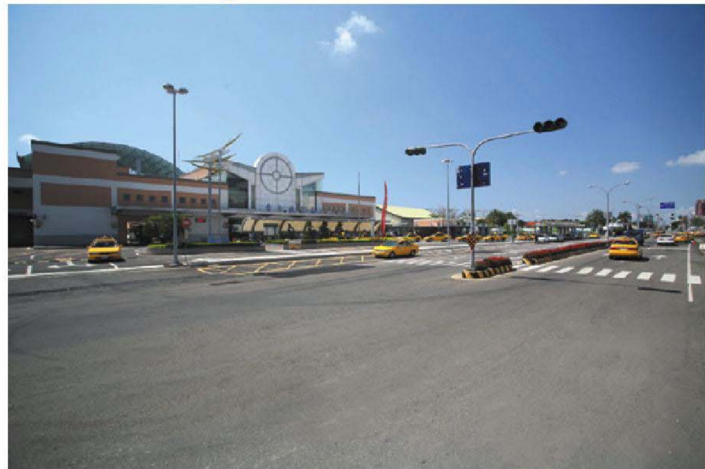
臺南機場聯外道路一起點為臺南航空站南側銜接現有道路，終點則銜接臺1線，總長1.1公里，路寬25公尺，93年1月完工通車。
