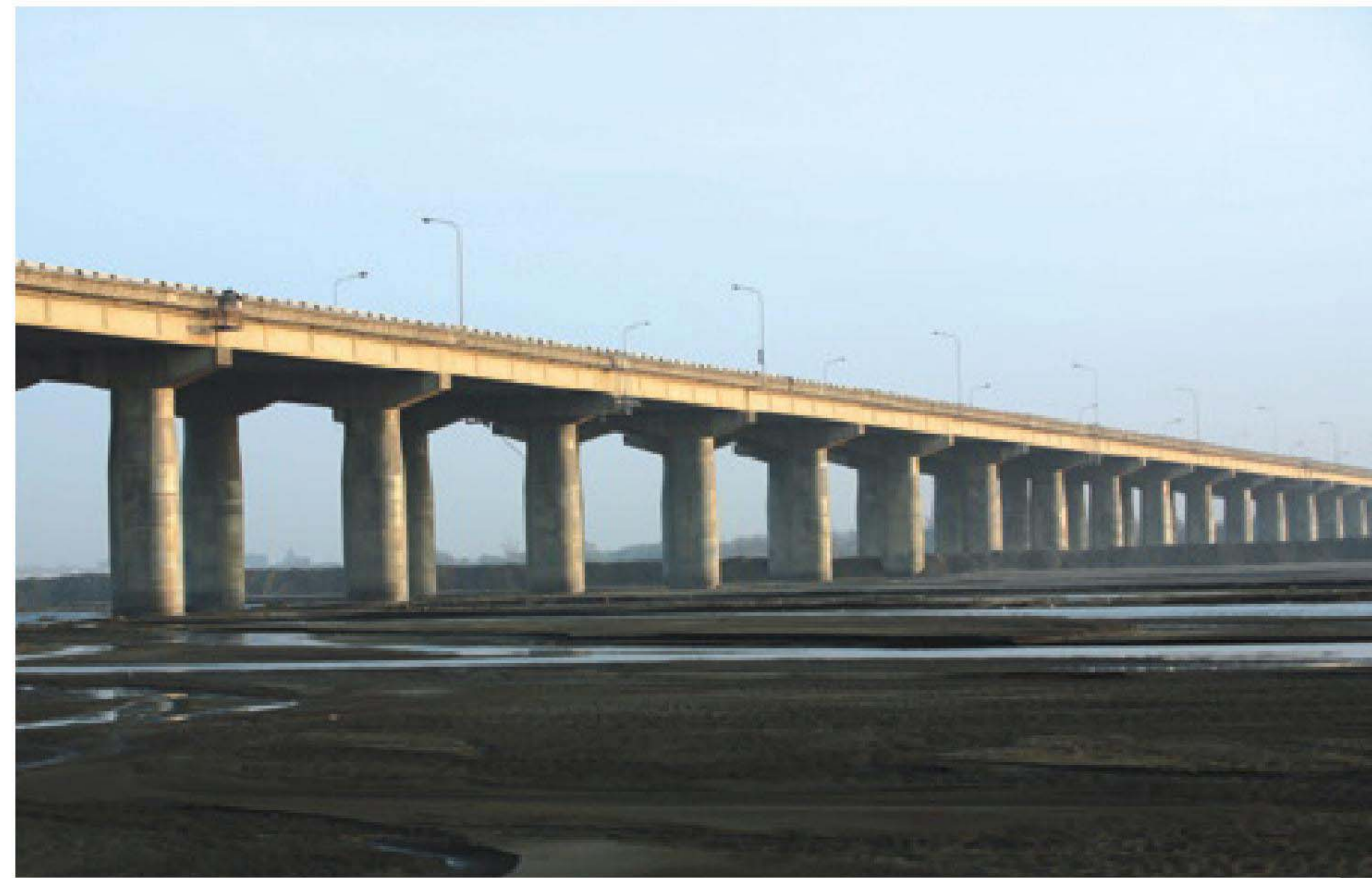
臺1線溪州大橋—跨越濁水溪，全長3.03公里，83年10月完工通車。
