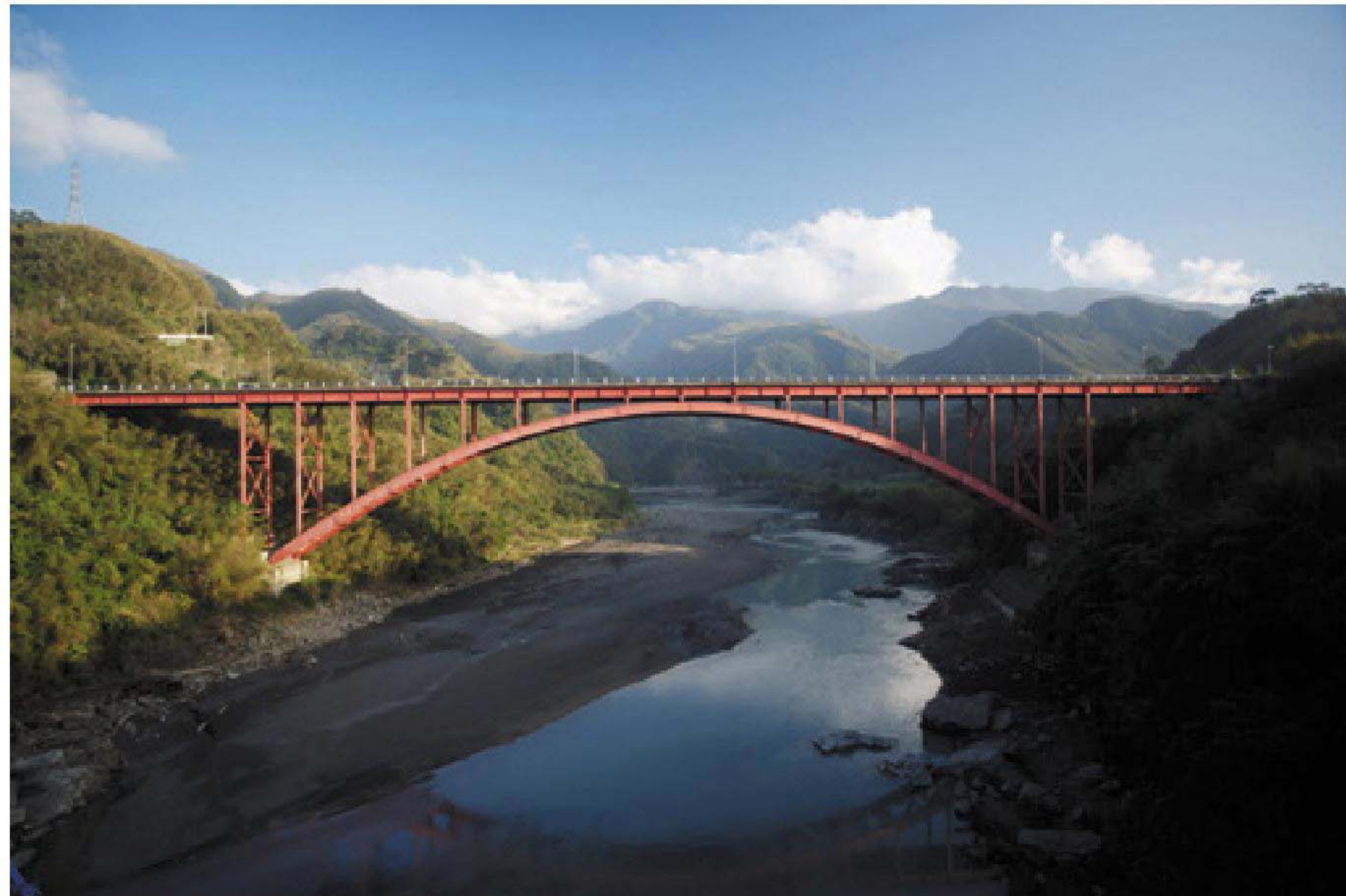
臺7線羅浮橋—跨越大漢溪，全長230公尺，81年1月完工通車。
