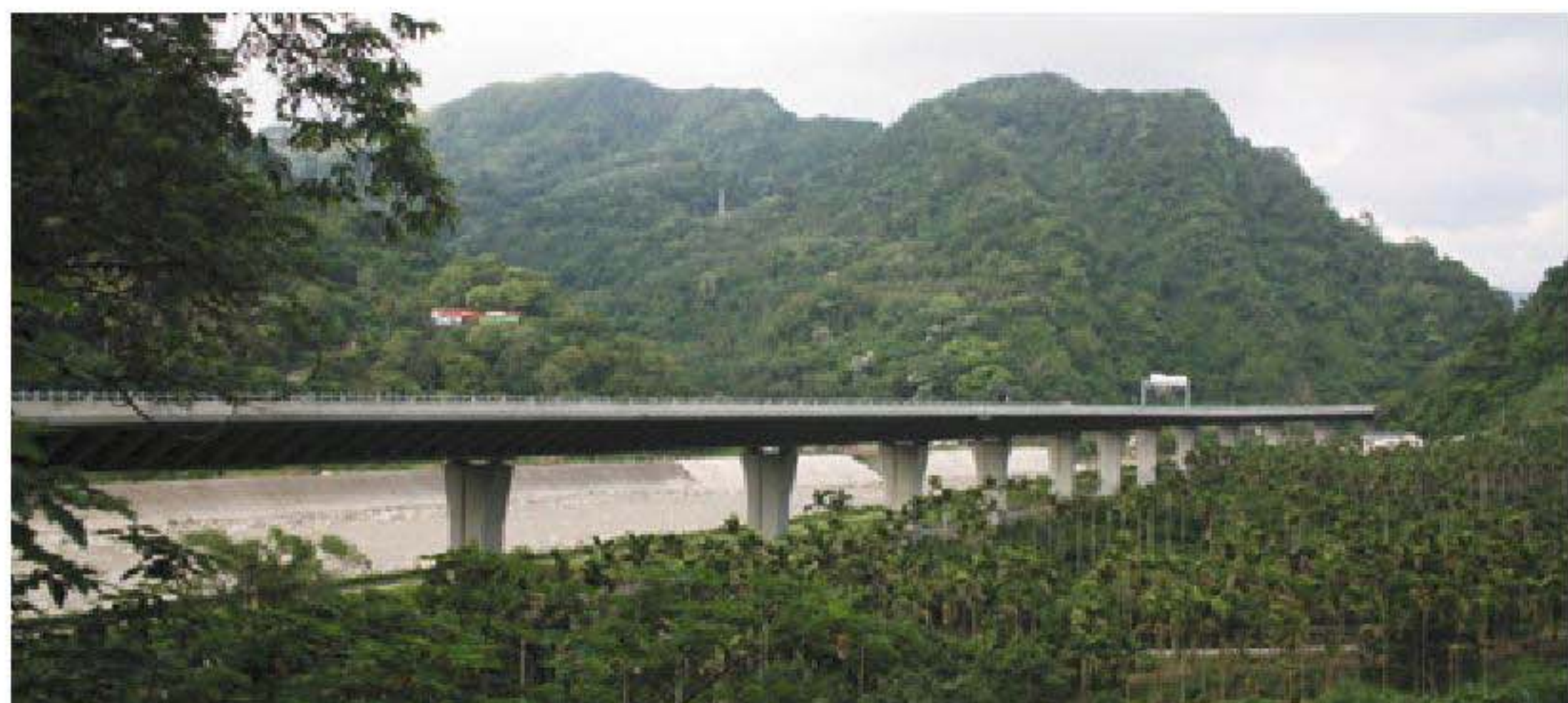
臺72線 27K Taiwan Provincial Highway No.72 27K
