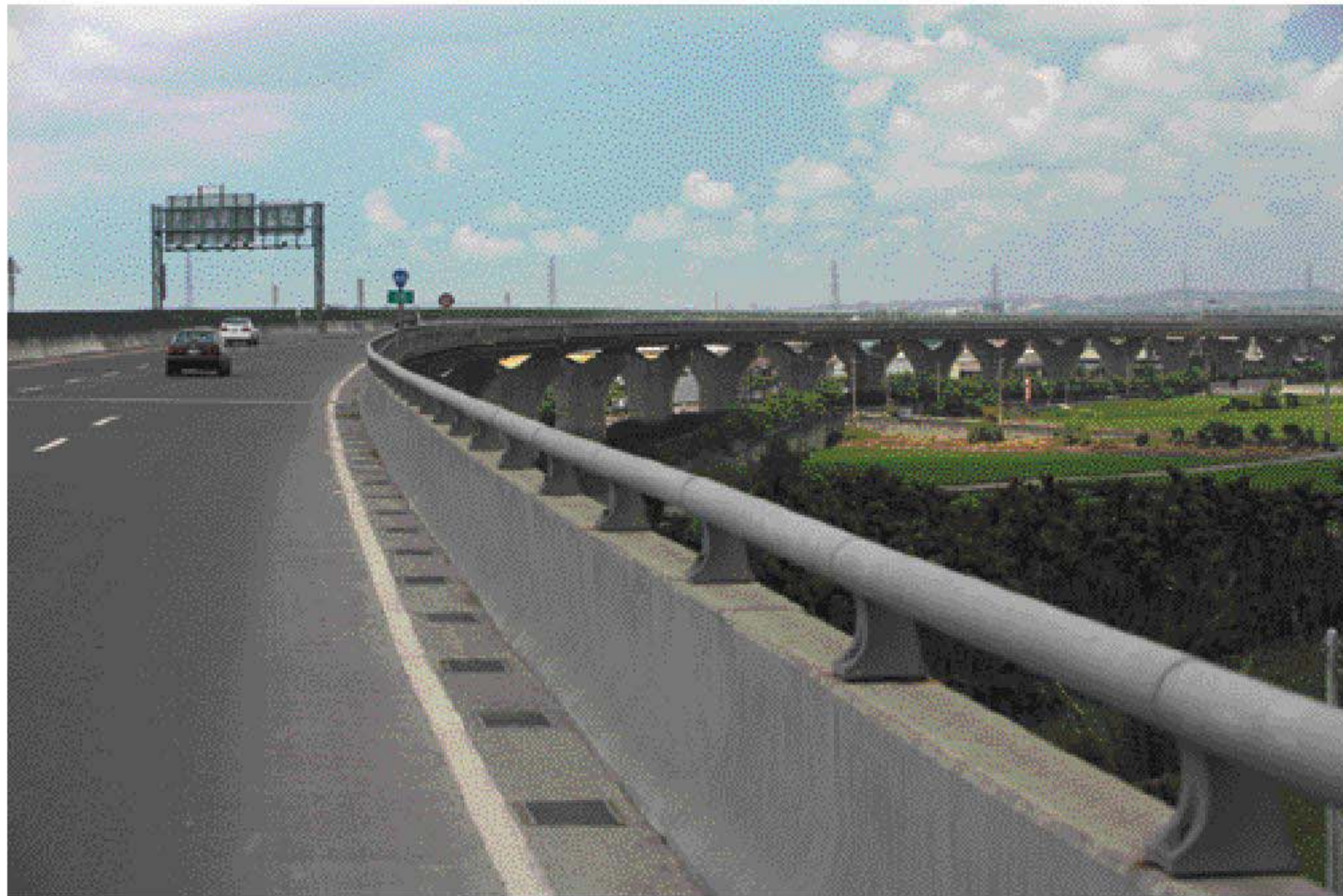
臺88線 15K Taiwan Provincial Highway No.88 15K
