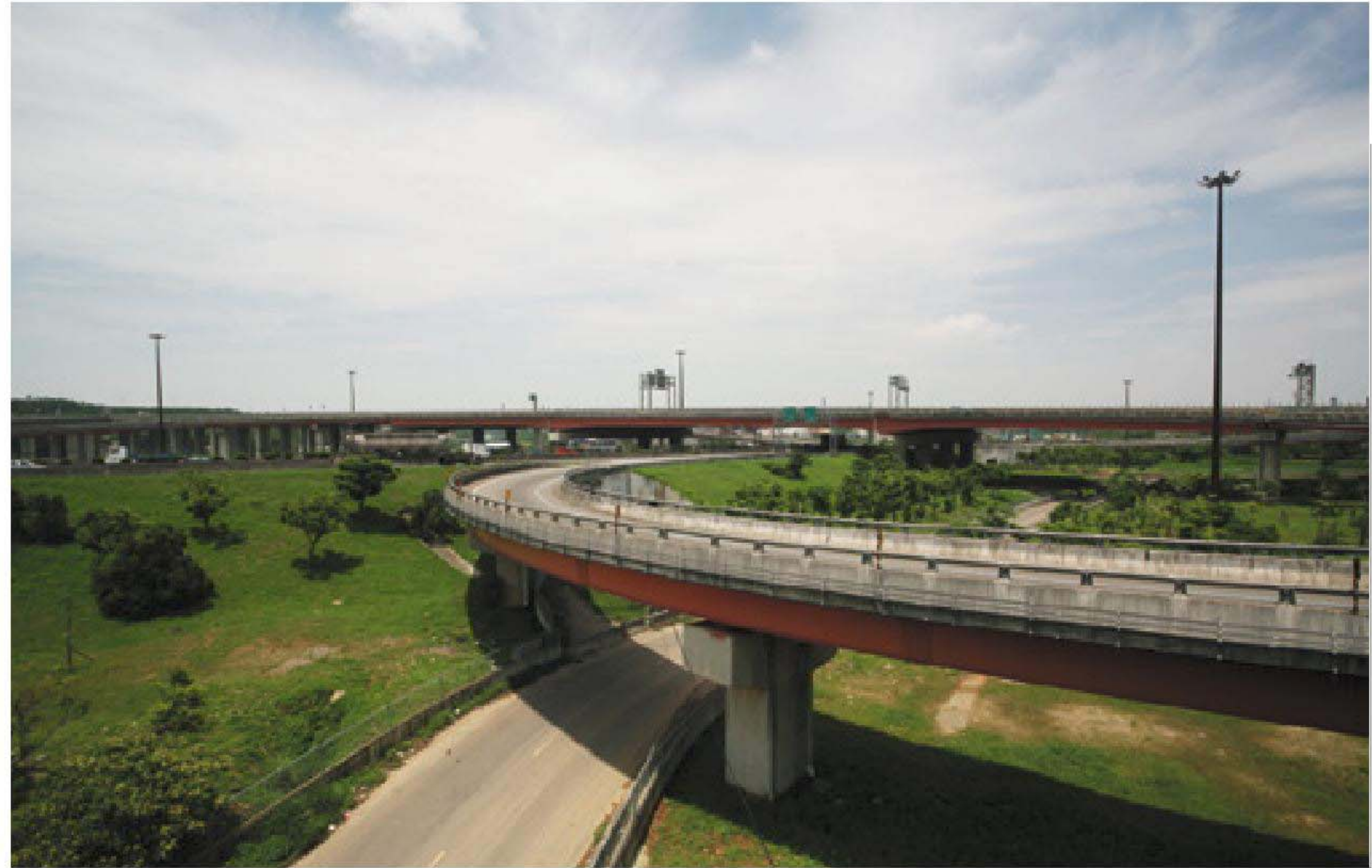
平鎮系統交流道（國道1/臺66） Pingjhen Interchange System (National Freeway No.1 / Taiwan Provincial Highway No.66)
