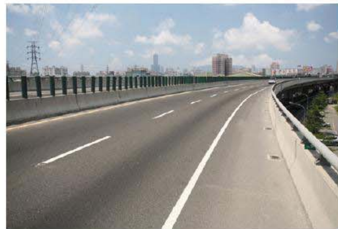
臺88線 0.9K Taiwan Provincial Highway No.88 0.9K
