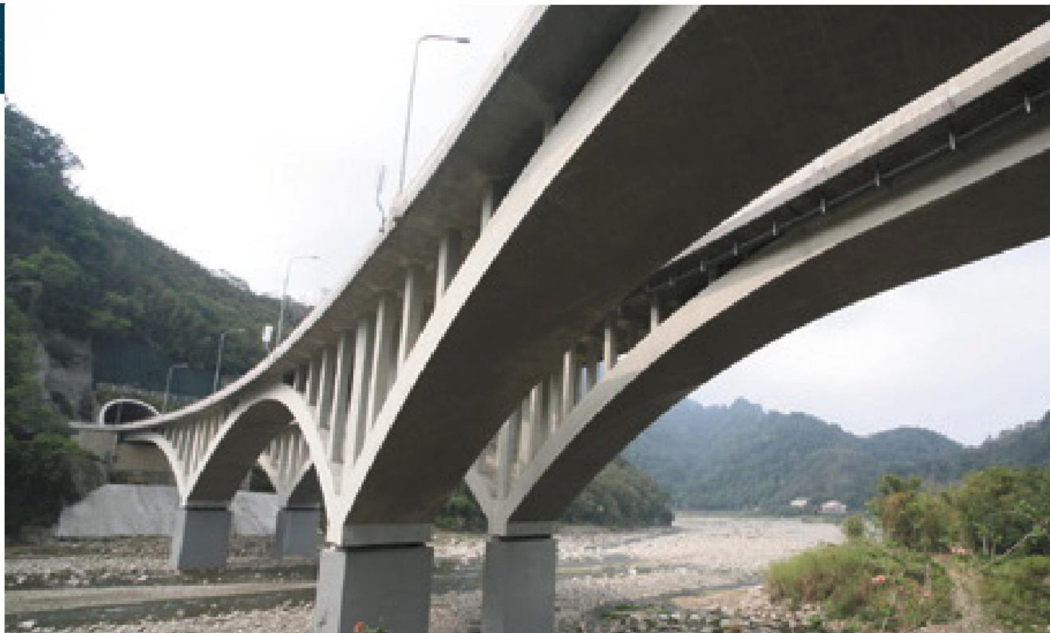
28 汶水橋 Wunshuei Bridge
