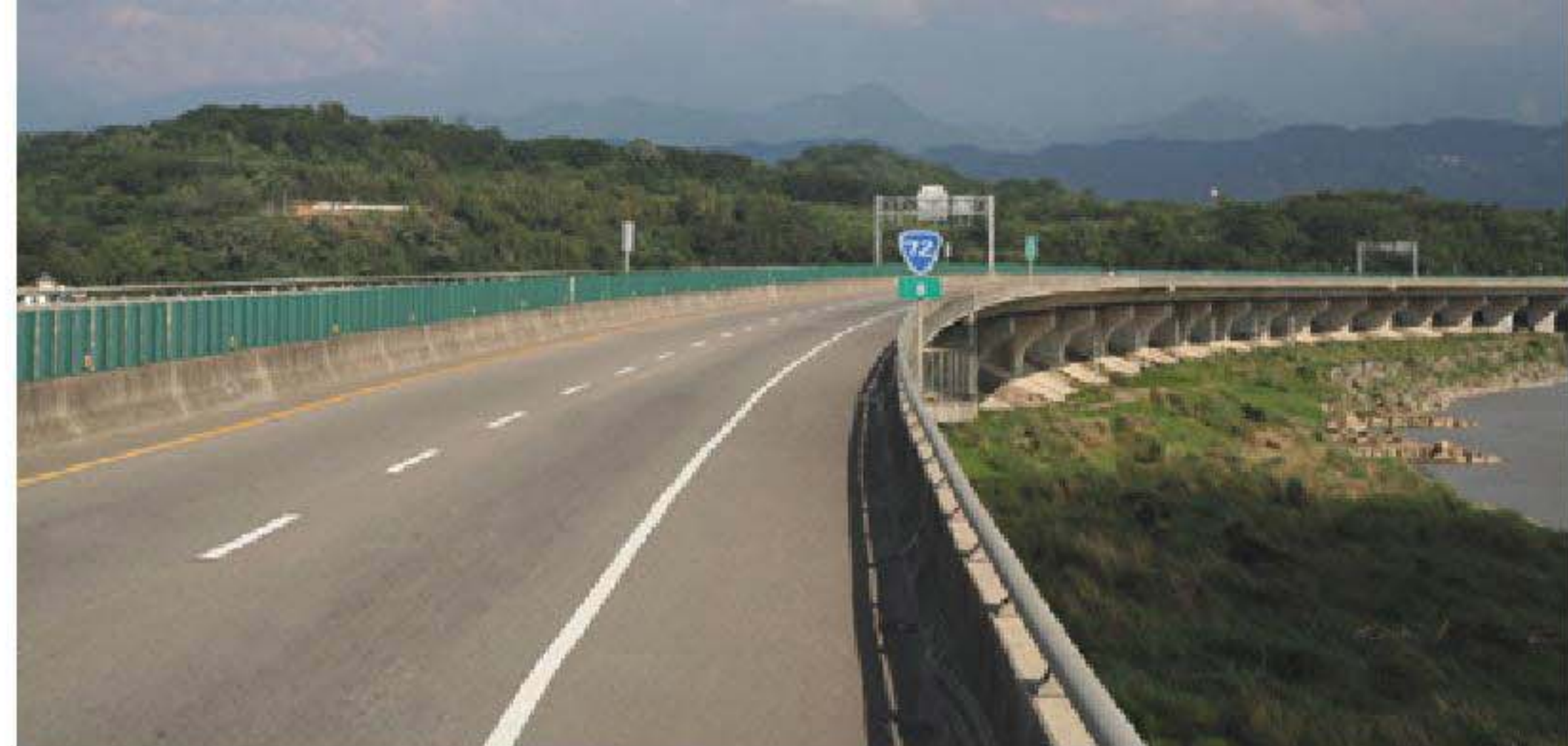
臺72線 8K Taiwan Provincial Highway No.72 8K
