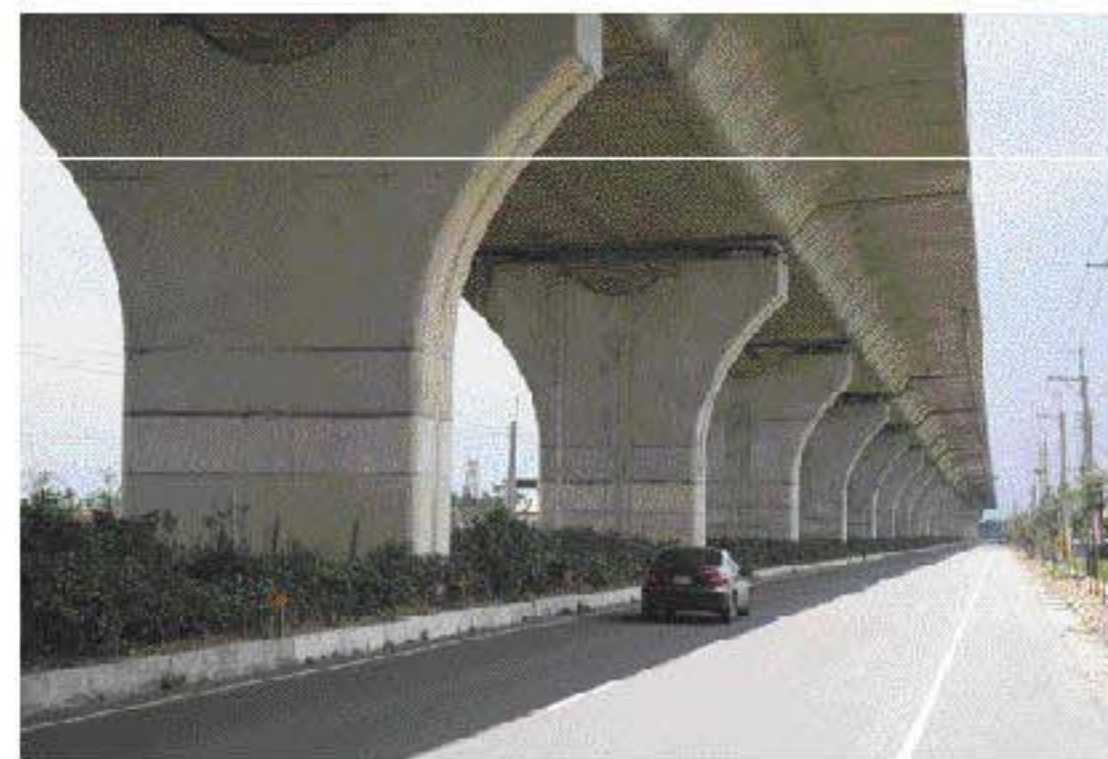
臺88線 16K Taiwan Provincial Highway No.88 16K
