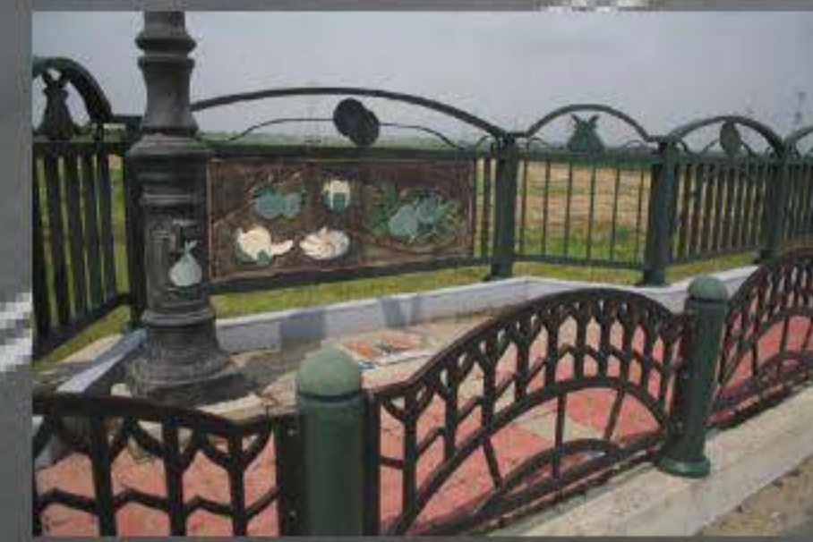
臺19甲線麻善大橋—跨越曾文溪，全長918公尺，92年11月完工通車。
