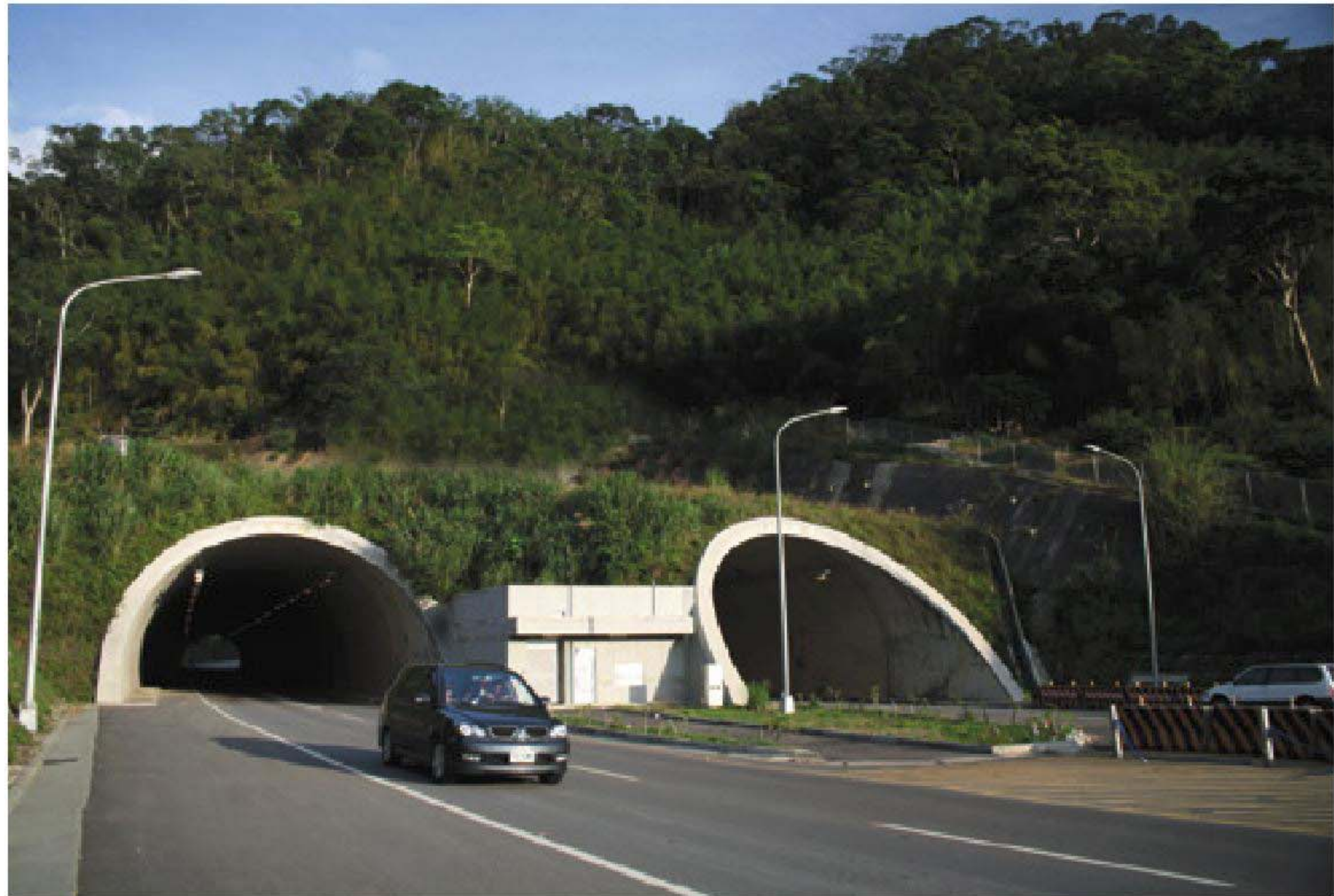
汶水隧道 Wunshuei Tunnel
