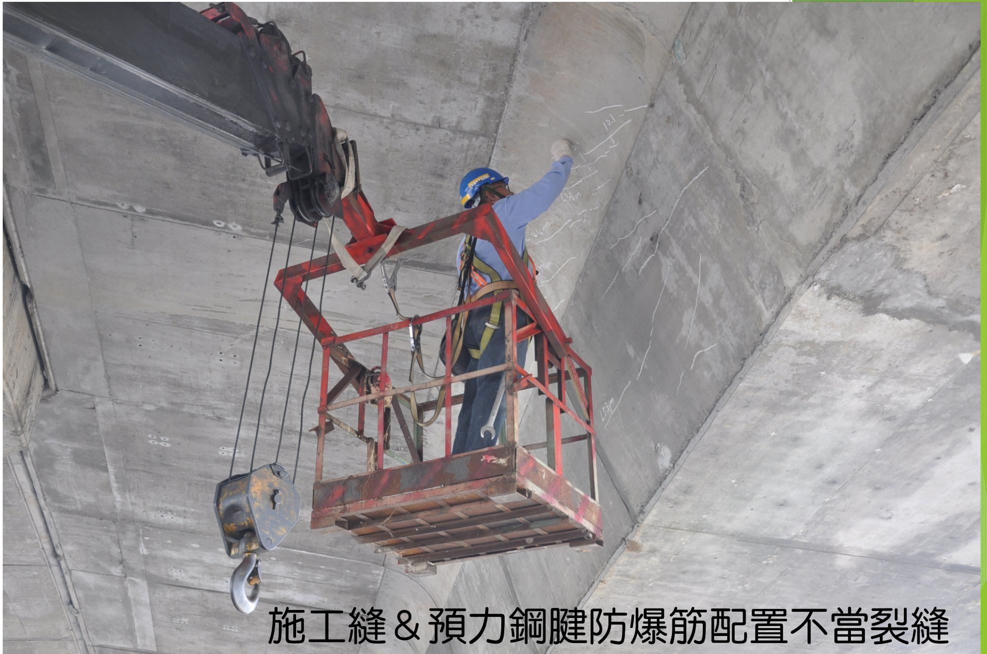
施工縫 & 預力鋼腱防爆筋配置不當裂縫
