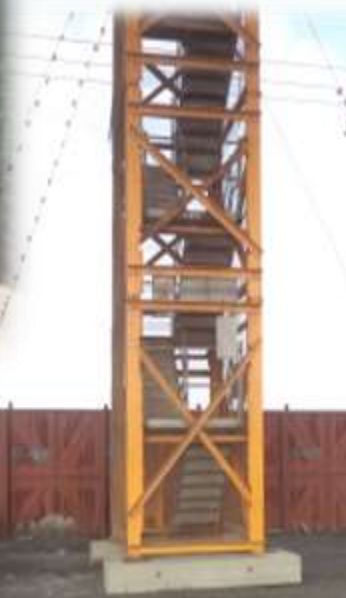
橋梁上下設備
