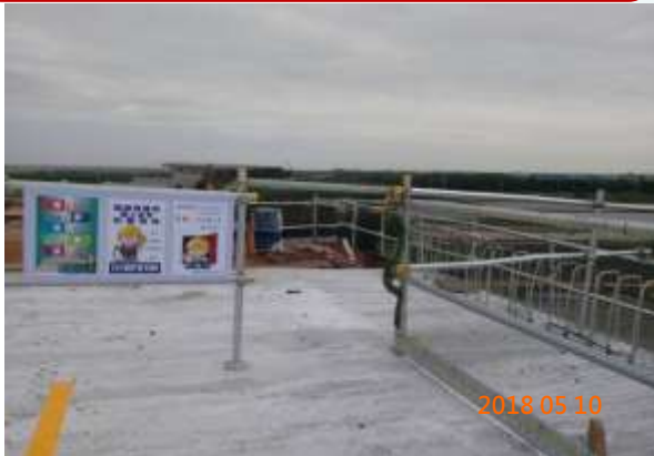
進入管制區須著實個人防護具(背負式安全帶等)方可進入
