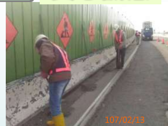
3.清掃-工區每日清掃， 保持工區乾淨
