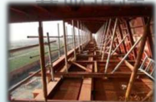
整組翼版鋼模推移(含護欄)
