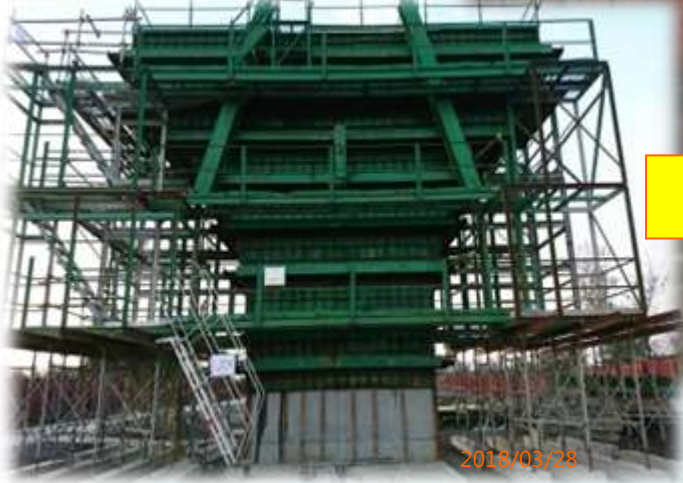
墩柱上下設備
