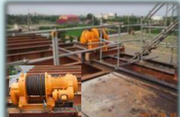
利用牽引馬達拖曳系統鋼模，可避免多次吊裝作業之危害
