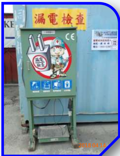
設置漏電檢測箱
