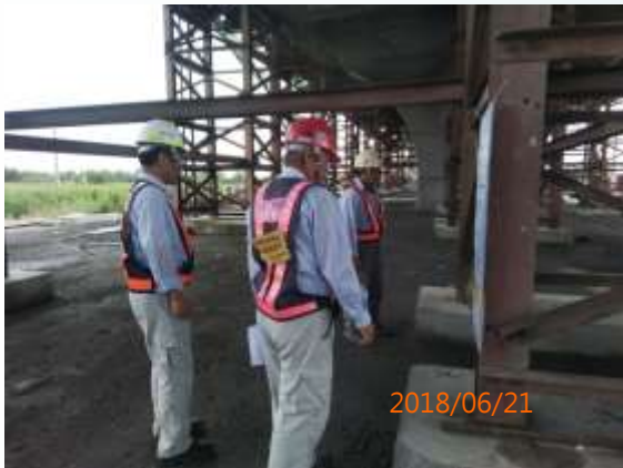
支撐架組立檢查
