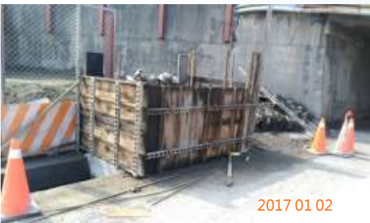
集水井牆身施作
