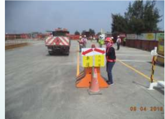
工區出入口人車分道管制
