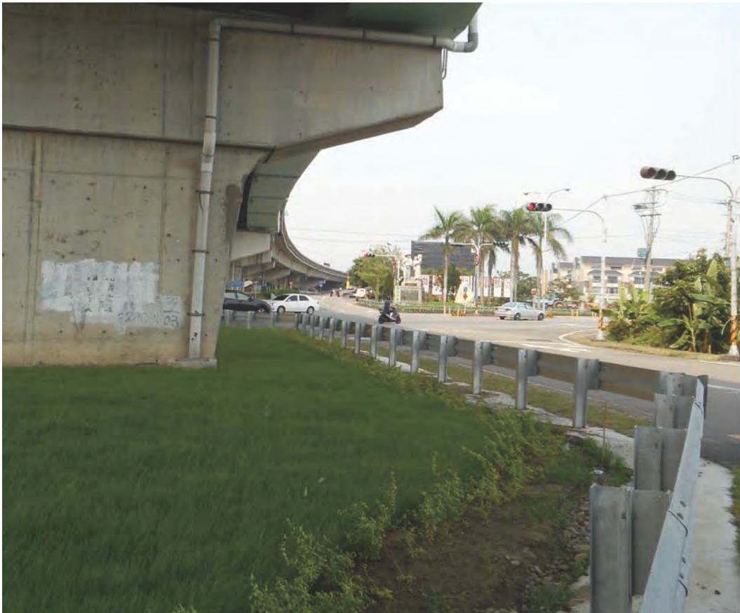
▲ 橋下空間增設鋼板護欄橋下空間增設鋼板護欄，並綠化植栽
