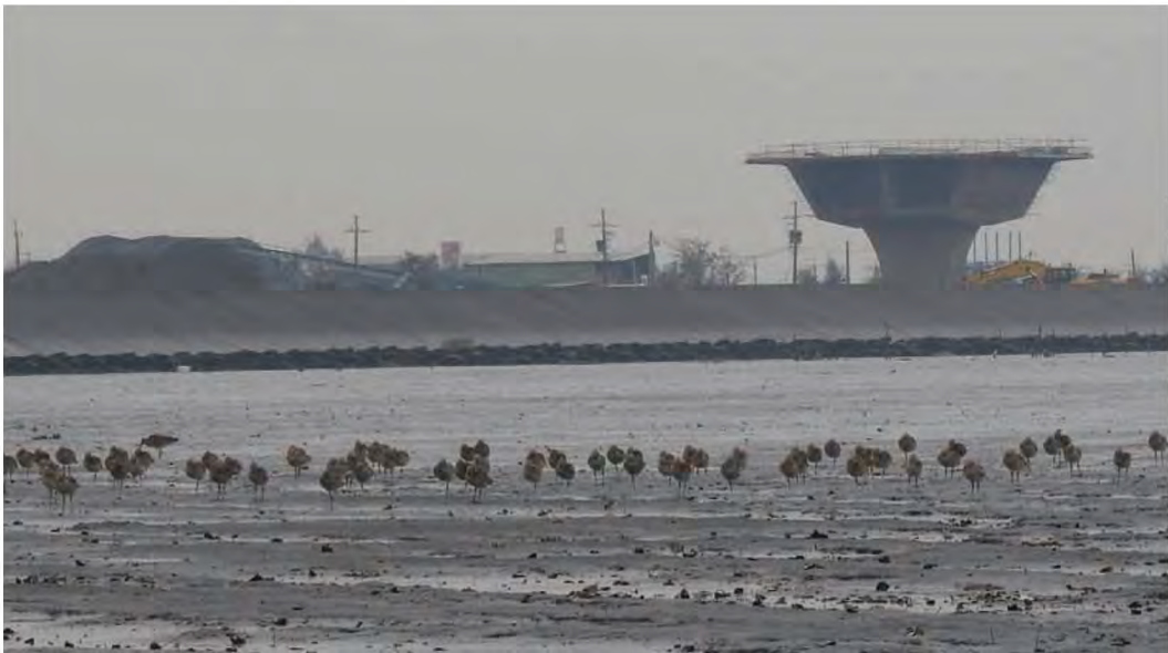
▲ 道路開發難免會造成自然環境內生物的衝擊，圖為員林大排至西濱大橋路段的台 61 線新建工程，此路段的台 61 線緊鄰海岸濕地，興建工程可能會影響濕地鳥類
