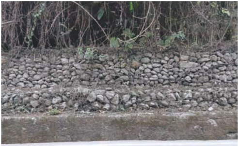
▼ 台21線80K處的蛇籠擋土牆
