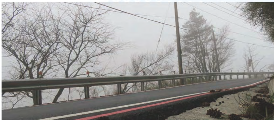
▲ 公路兩旁使用透空的鋼板護欄，讓動物容易查看路上的狀況
