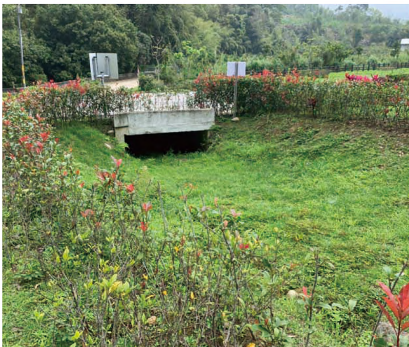
▲ 現有箱涵設計成生態廊道
