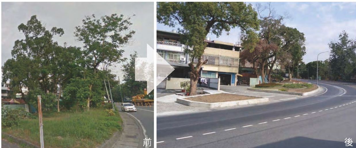
▼ 台16線0K+500左側槽化島改善前與後，道路視野變較開闊明亮
