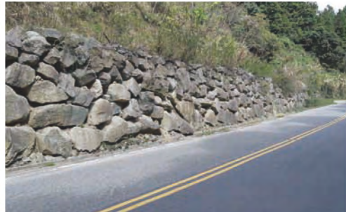
▼ 台21線124K處的砌石擋土牆
