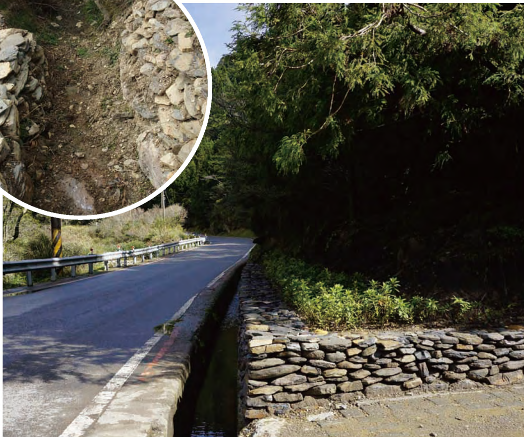
▲ 臨溝側裸露處同樣以透水方式修復
