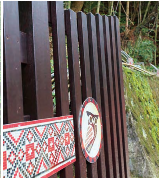
▲ 台21甲線邊坡水管整理改善及美化，以邵族的文化代表，貓頭鷹和圖騰作為裝飾
