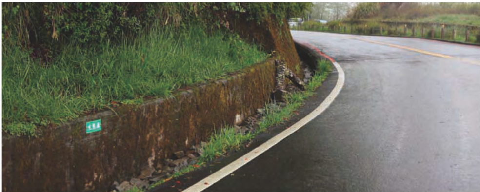
▲ 台21線141K處路旁的生態溝，提供生物躲藏和生存的環境
