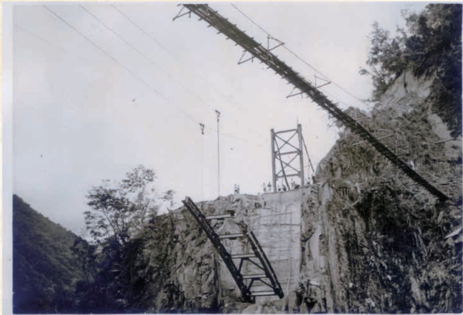
橫隔梁連接拱圈主梁
