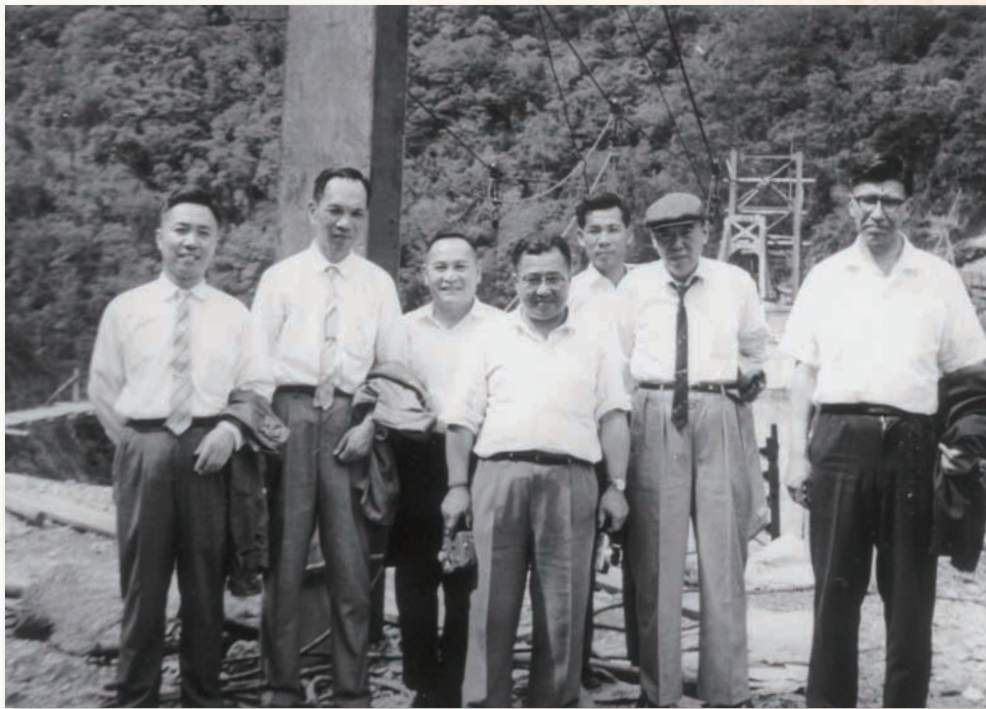
公路局長官視察大曼橋，由左至右依次為張廷珩、王賢彬、鄒元輝、胡美璜、李清賢、楊廷英、魏傳基，1965年。日治時期的大曼鐵線橋(大曼吊橋)宜蘭端橋塔仍在
