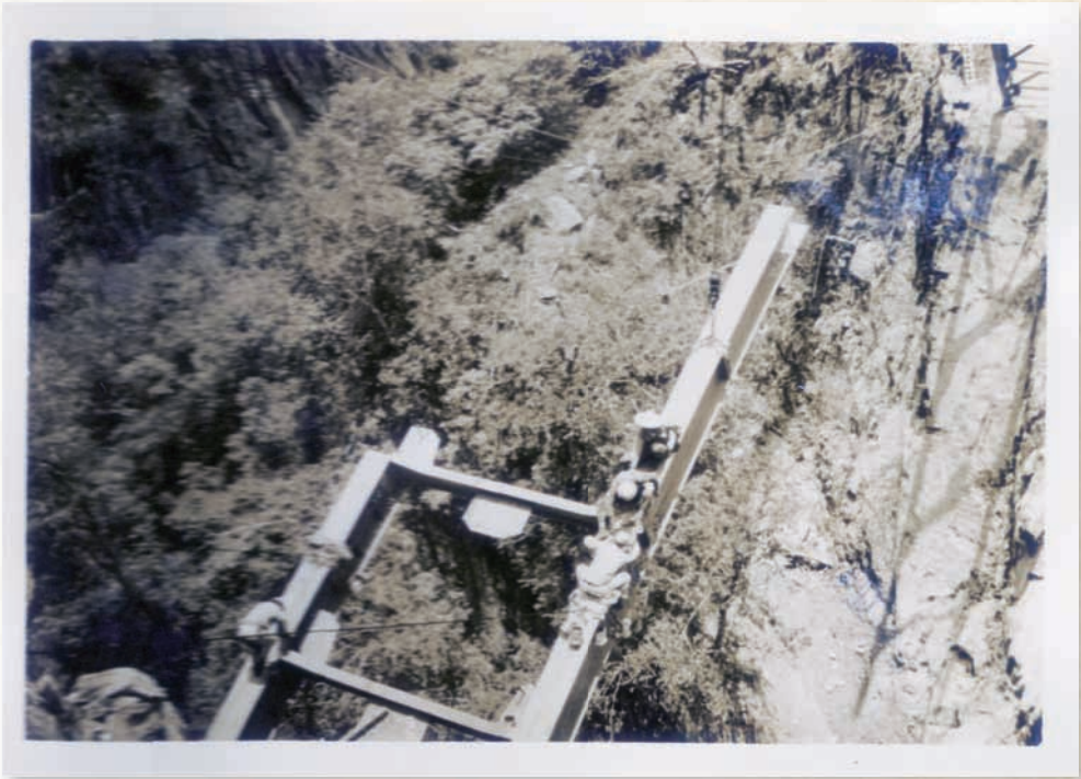
橫隔梁連接拱圈主梁
