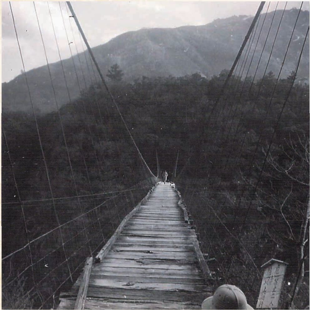
巴壟鐵線橋，1914年10月竣工，接連這4張照片攝於1958年1月
