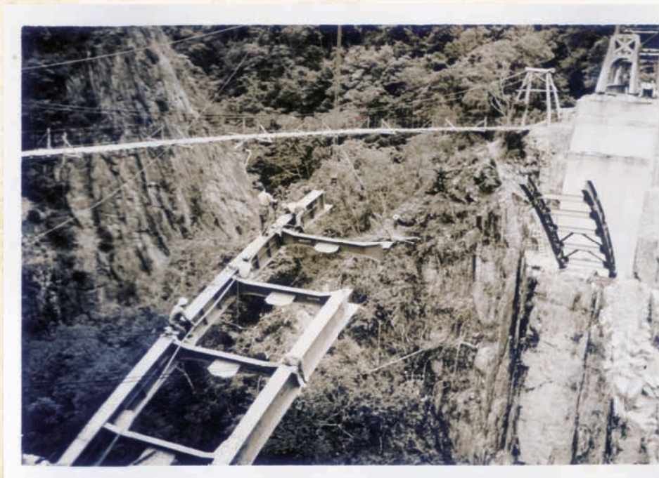
橫隔梁連接主梁後斜纜吊掛固定
