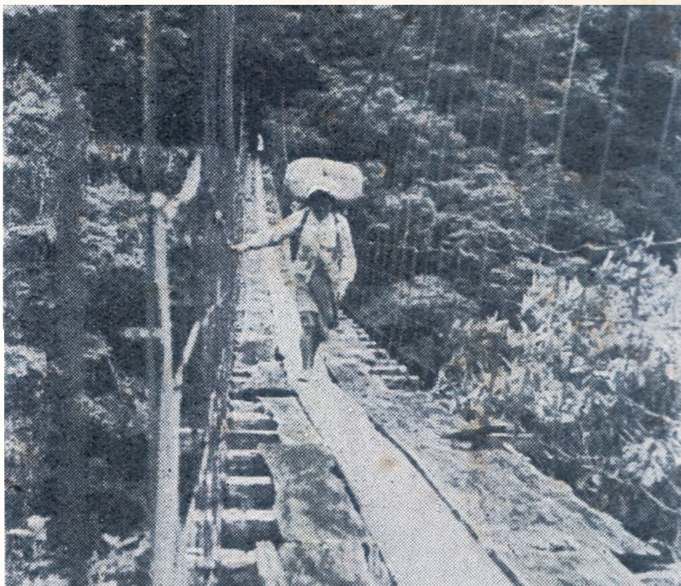
北橫公路正式測量，1958年。拉號至高坡間路線一般情形(左上)木材商修建之運材便道(右上)大曼吊橋損壞情形，每次僅限一人通過(下)
