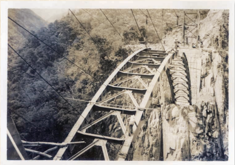
橫隔梁連接拱圈主梁
