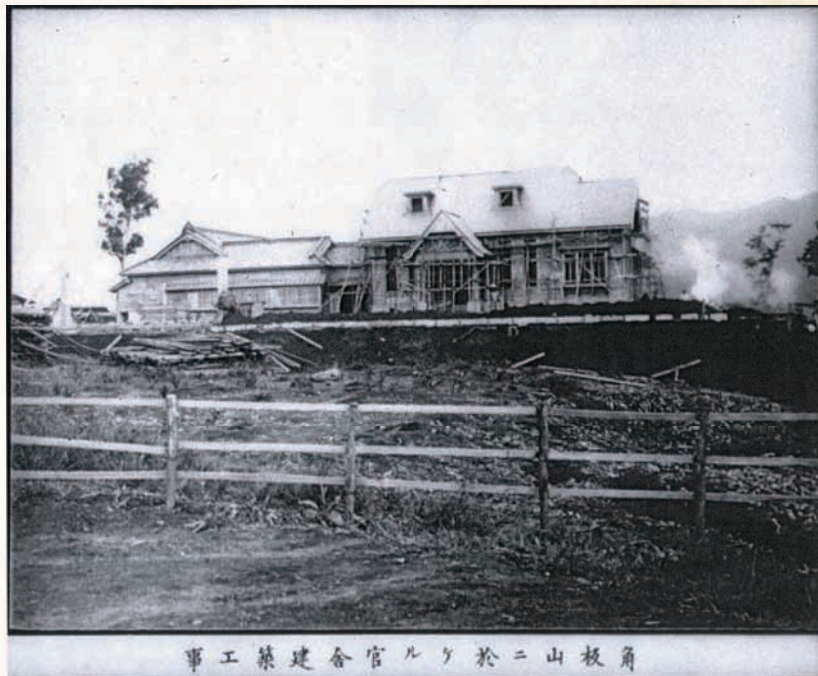
修築中の角板山檜御殿，亦即貴賓館，1913年8月11日
