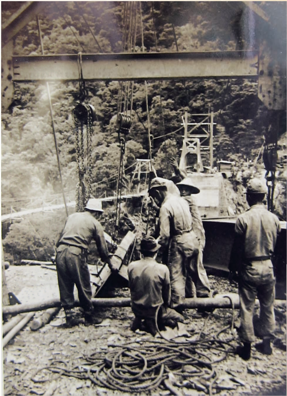
吊橫隔梁，架上運材索纜
