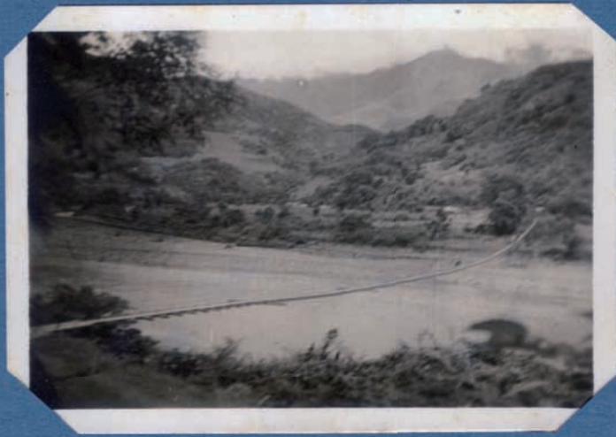
角板山吊橋(鐵線橋)全貌，共長235公尺。接連這11張照片貼在藍晒圖紙上面，攝於1950年8月
