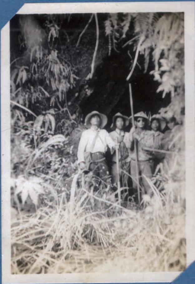
西村隧道東峒口
