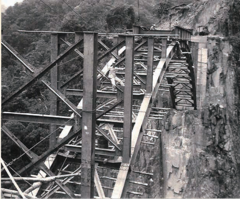
大曼橋搭鋼支架，巫燐坐於拱圈上，1965年5月24日
