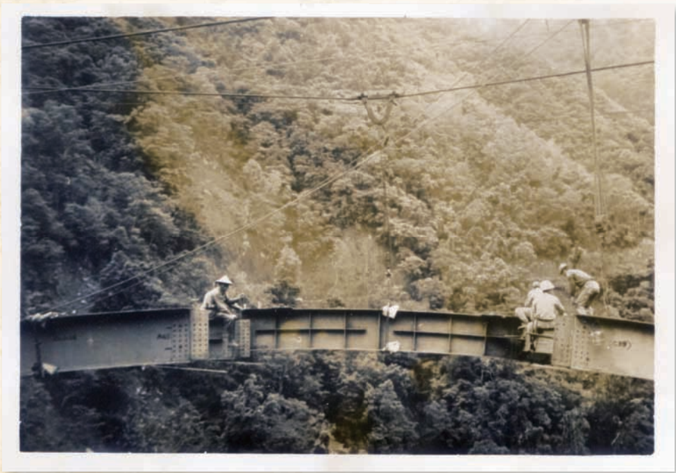
先以螺栓固定，再以鉚釘連接拱圈頂主梁，1965年5月17日
