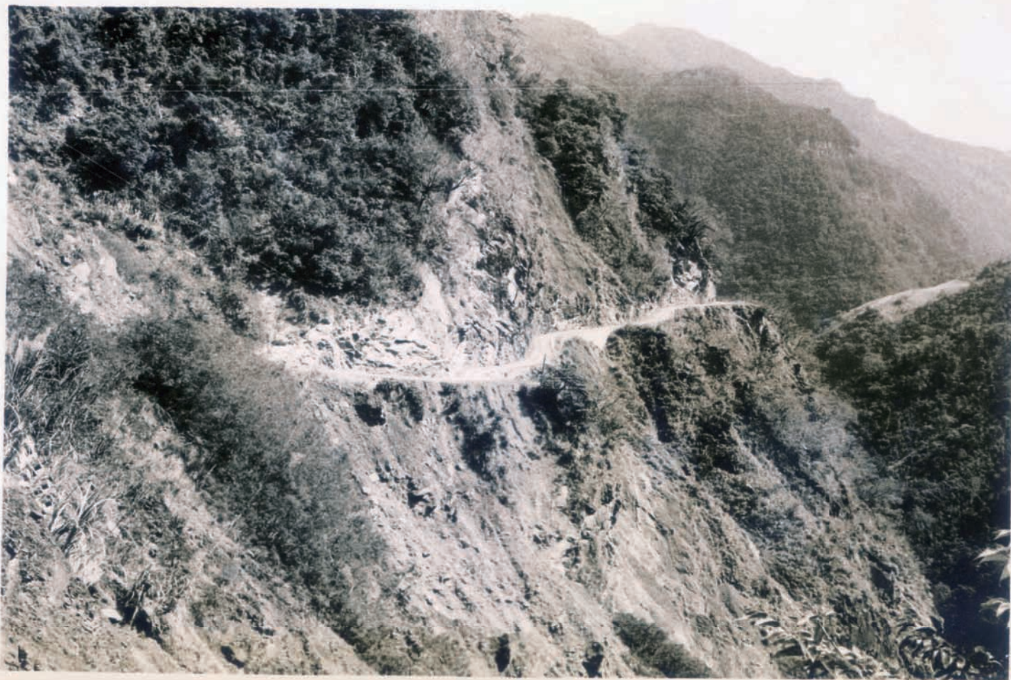
雪霧隧道的外側岩壁又名大崖，常有落石紛墜，今已開鑿雪霧隧道，不再經過此段，於1960年代
