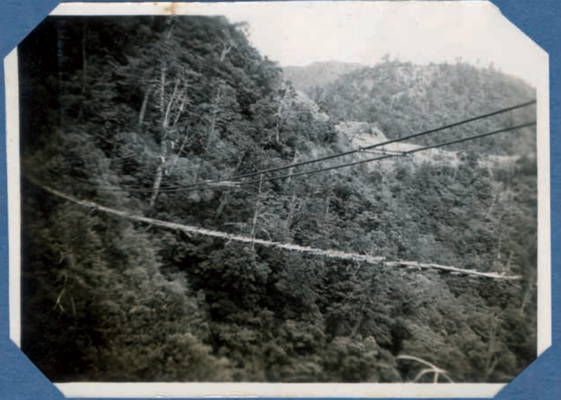
西村吊橋全貌，已損壞不能行人
