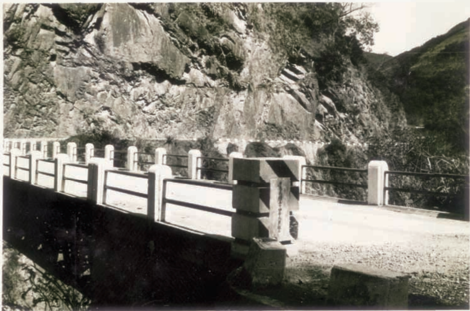
榮華橋，自宜蘭端望向復興端，單線道，橋欄為鐵桿。今已改為雙線道，約1960年代
