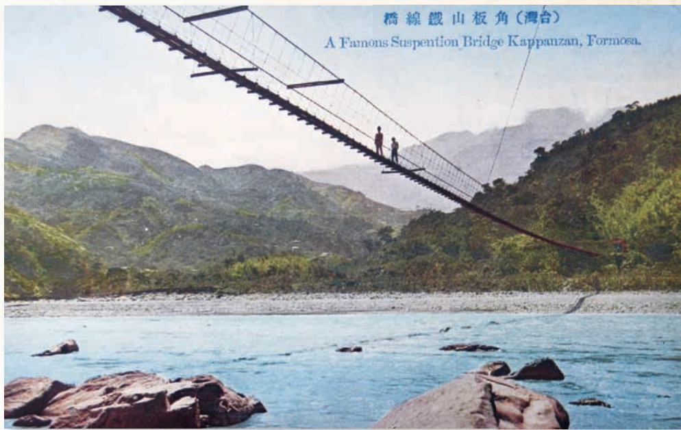
角板山鐵線橋，又名拉號鐵線橋、大崙崁第一鐵線橋，長度235公尺，寬度0.8公尺，1912年5月完成。
