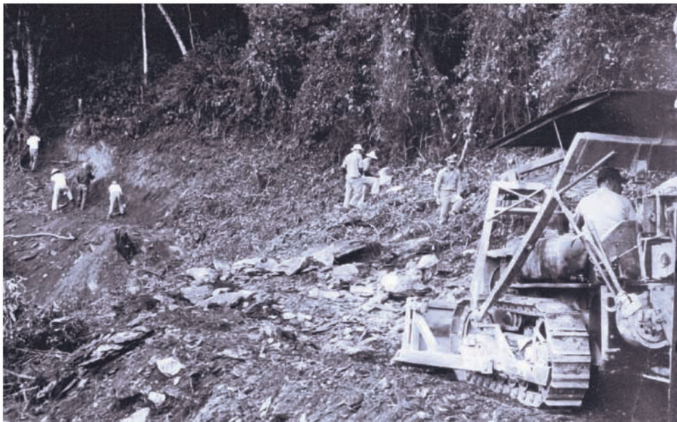
榮民操作D4型推土機築路，約1961年
