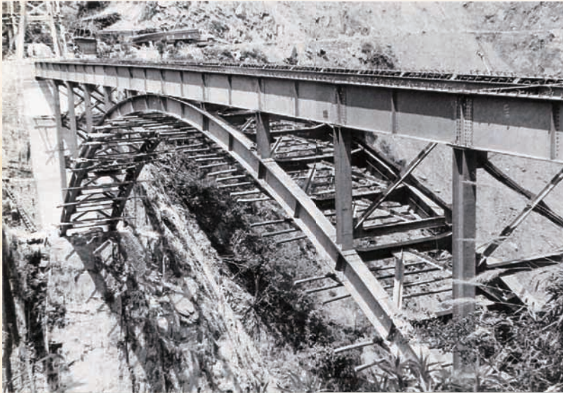
大曼橋水平梁完成，1965年6月
