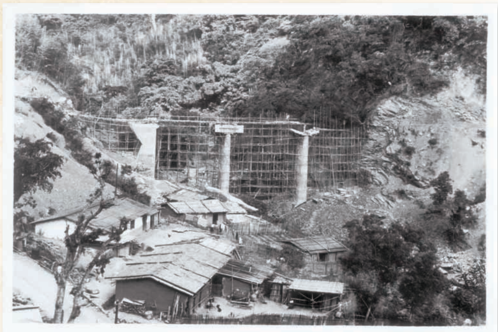
霞雲橋施工情形，1964年
