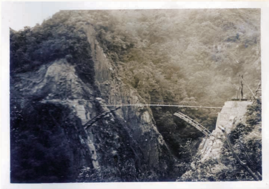
吊裝拱圈主梁
