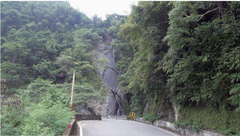
台7線33K處，為仙琴橋舊址，現今為新山月橋短橋，攝影2014年9月
