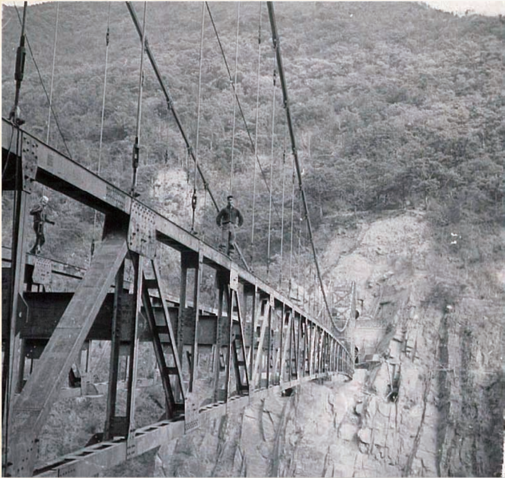
巴陵橋加勁桁架下弦鋼構件架設，1966年3月6日
