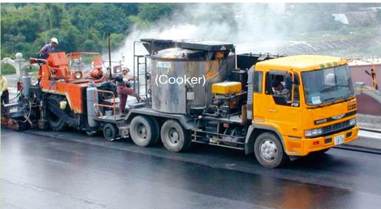
圖3-2-5 Guss瀝青路面施工
