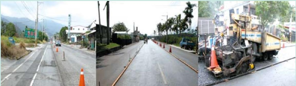
圖4-2-7 刨除、控制準線、邊條設置及再生AC鋪築（林進芳拍攝）
