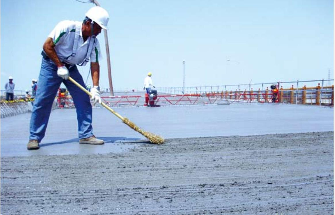
圖3-3-2 接續作業為AC鋪設，混凝土表面鏟平尚未初凝時進行掃帚刷糙
