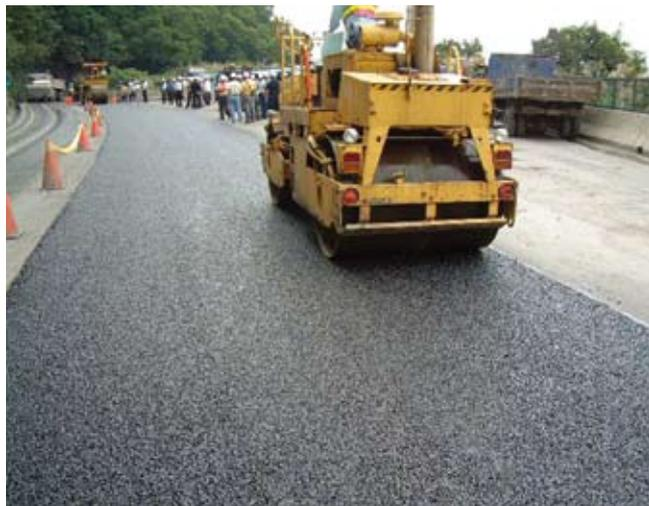
圖3-2-3 石膠泥瀝青路面施工
