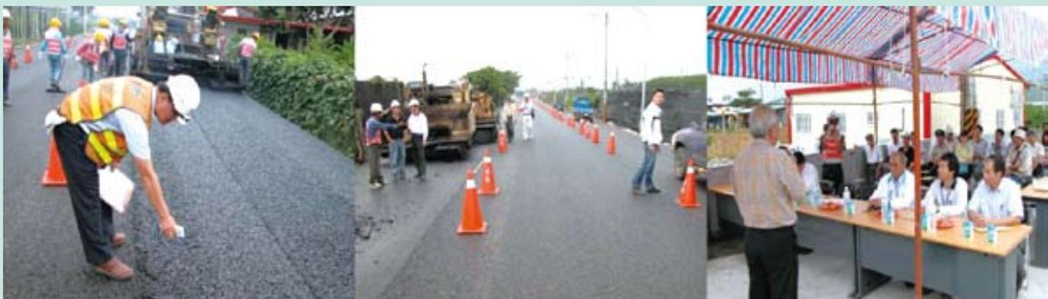
圖4-2-8 面層PA鋪築及現場觀摩簡報（林進芳拍攝）
