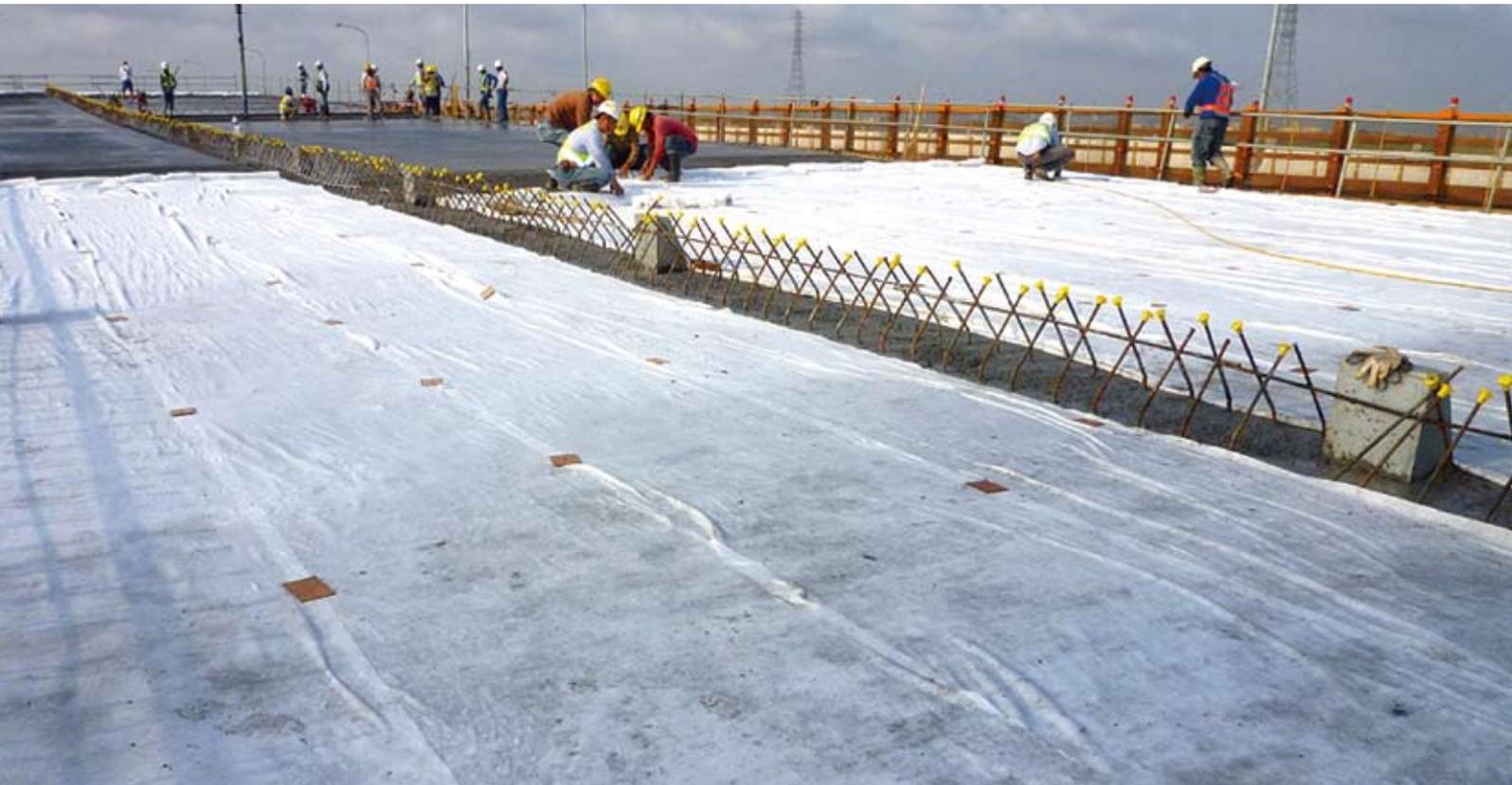
圖3-3-3 採用濕物覆蓋法進行養護作業
