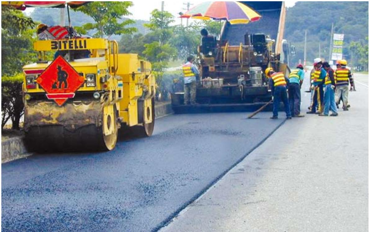
圖3-2-4 橡膠瀝青路面施工
