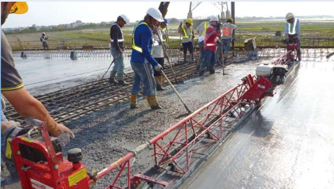
圖3-3-1 橋面版混凝土灌漿並以橋面整平機配合人工整平施工
