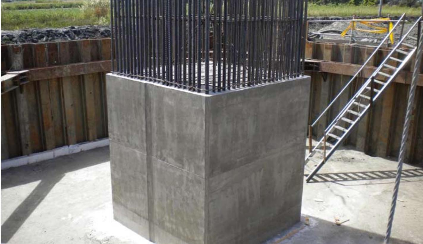
圖3-3-5 自充填混凝土拆模後照片
