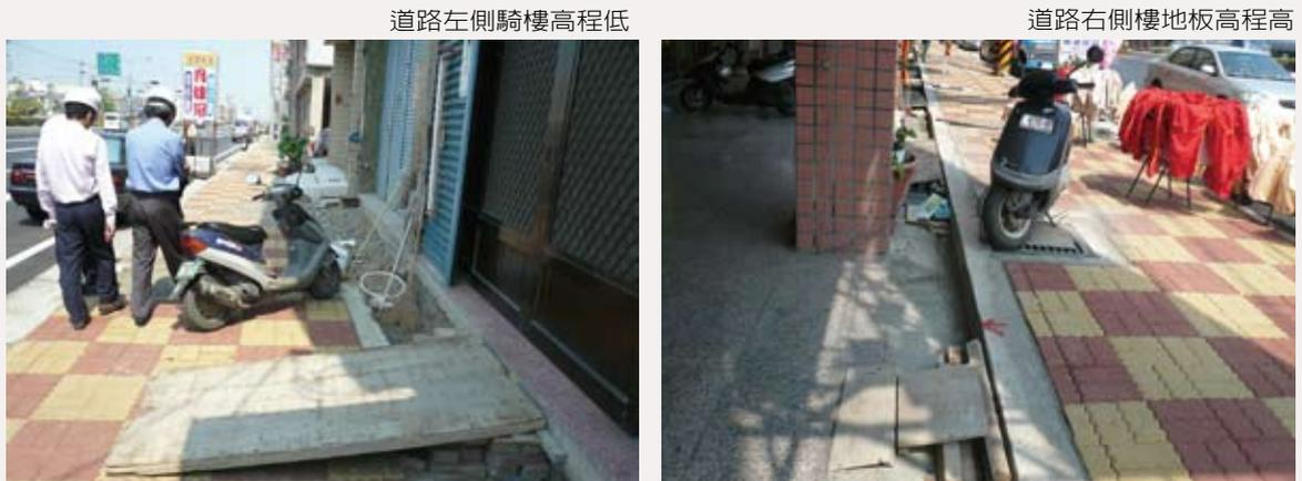
圖2-2-3 既有道路拓寬工程如何同時兼顧道路平整舒適以及鄰路住戶、商家出入與人行道間產生高低差問題（住戶騎樓地板高程不一），已非公路單位獨自調整道路設計高程所能克服。
