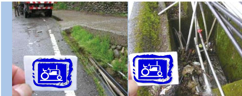
圖2-2-1 山區民衆基於用水需求（無自來水幹管地區）私設管線，該管線如何兼顧用水需求與既有排水設施管養，亟需研思協調解決。
