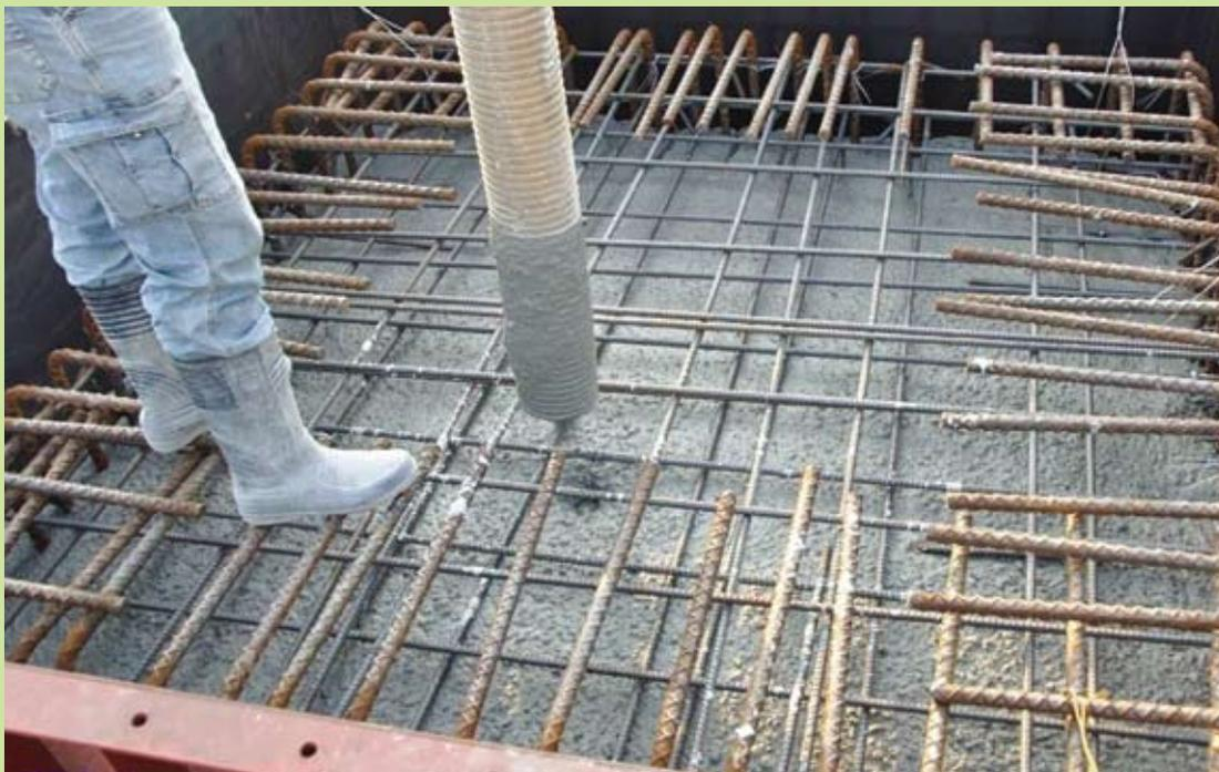
圖3-3-4 自充填混凝土免搗實，不需任何震動
