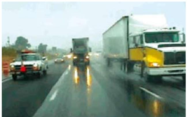
圖3-2-2 排水性AC（右）與傳統AC（左）路面比較。
