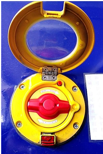
圖 4.4-6 緊急裝置防護遮蓋
