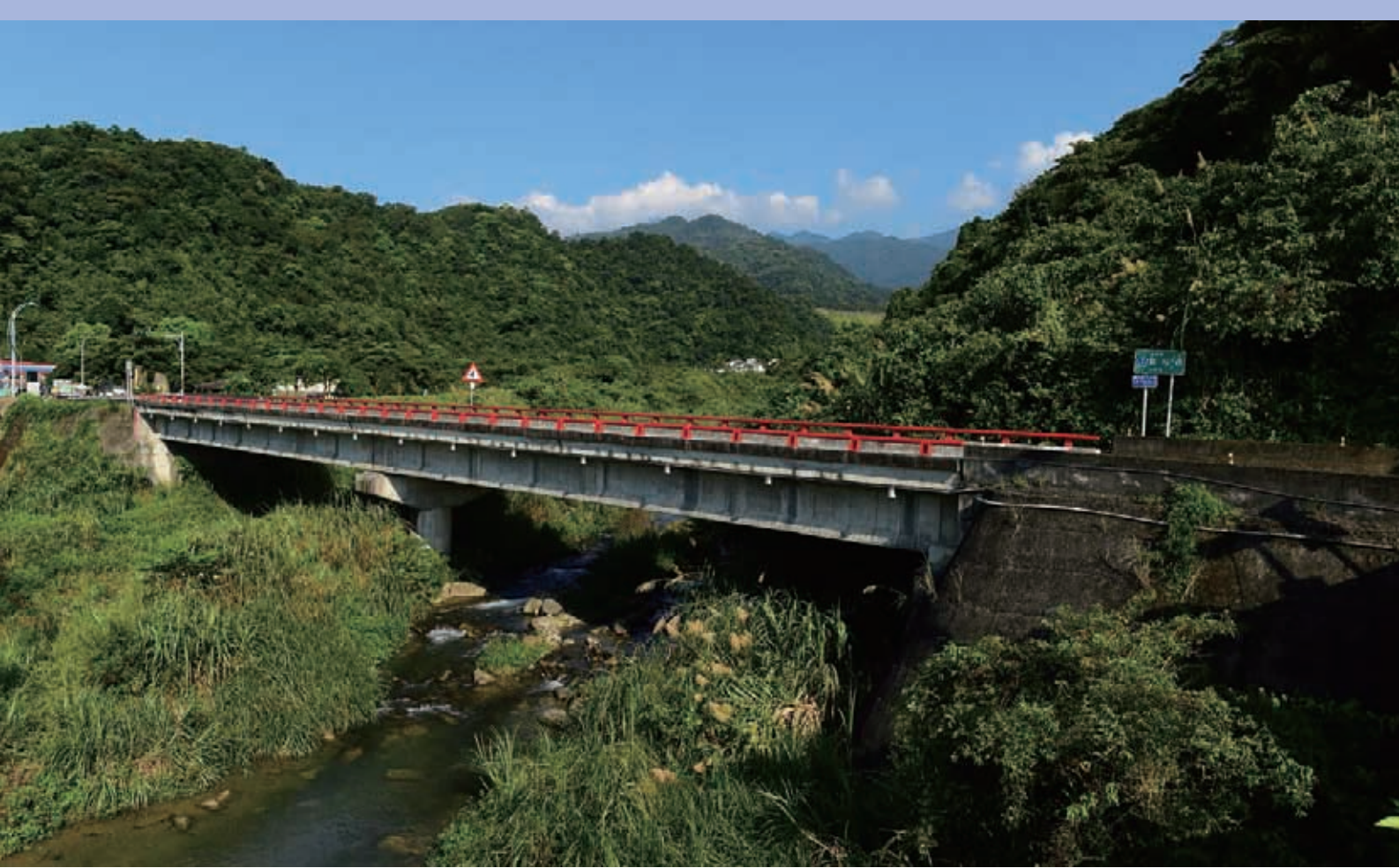
▲ 羅裕橋橋體結構養護良好。
