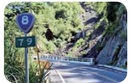
▲座落 79K 處的靈甫橋，於民國 99 年改建竣工，是佳陽部落出入山區的交通要道。
