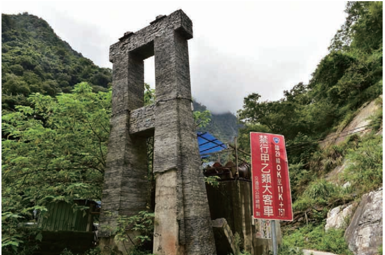
▲丹大吊橋遺址。
