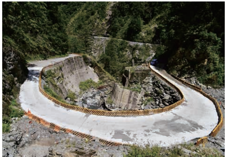
▶ 登高點眺望進涇橋舊址，目前僅靠臨時便道通行（沿線以紐澤西護欄防護）。
