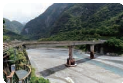
▲ 位於東西橫貫公路牌樓旁的錦文橋。
