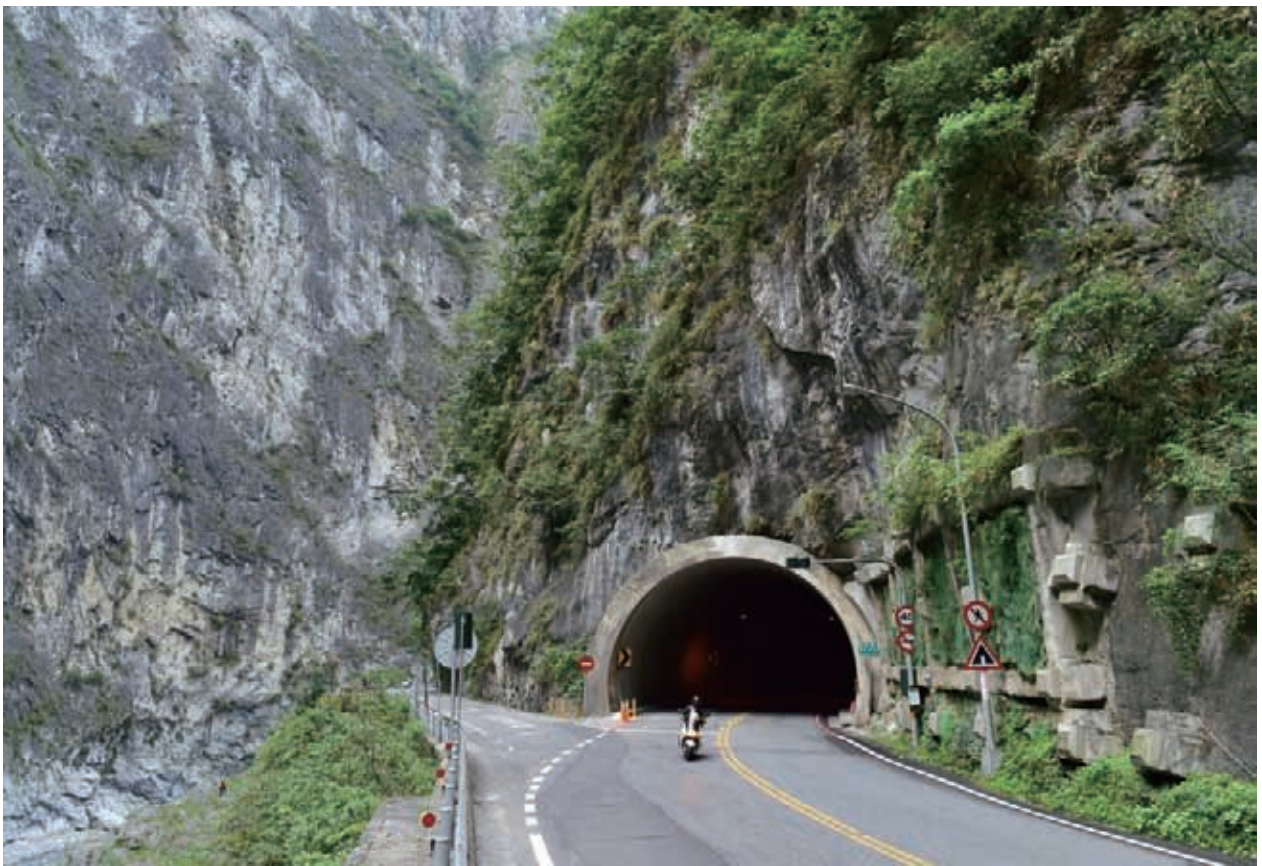
▲ 隧道出口處是陡峭岩壁。
