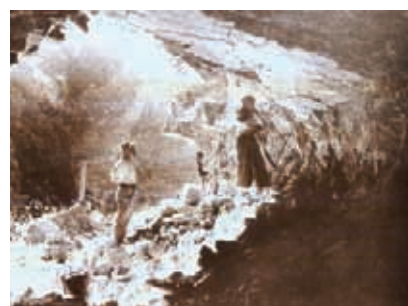
▲ 昔日東西橫貫公路人工開鑿隧道施工情形。 （圖／公路總局）
