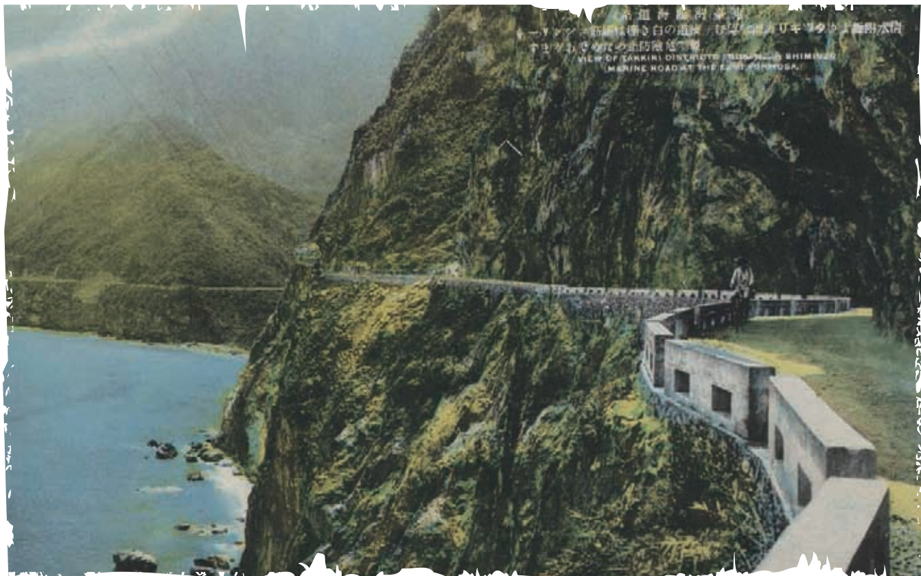
▲日據時代、民國 29 年發行的明信片——東臺灣臨海道路（由清水附近往立霧溪方向望去）。右上方文字「隧道兩旁的白字柵欄是鋼筋水泥製的，用以防止危險」。（圖／臺灣記憶，國家圖書館）
