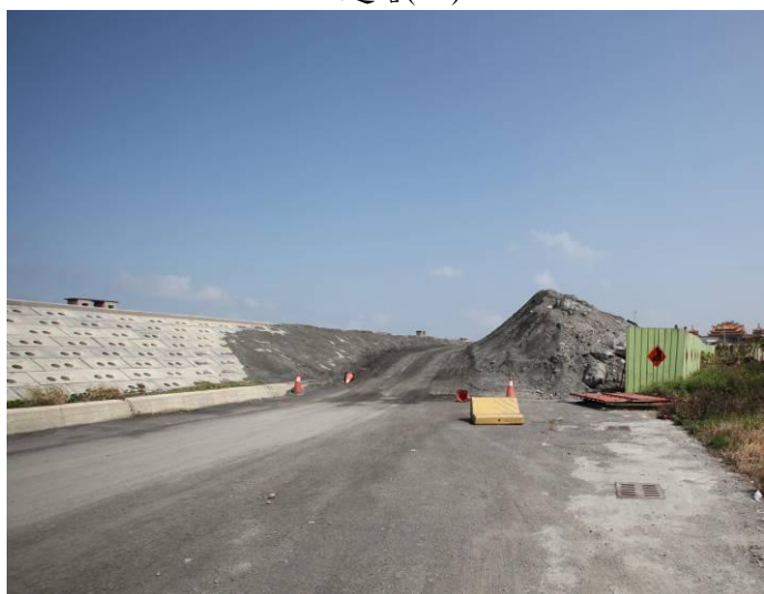
16施工中的抽水站(H1)
