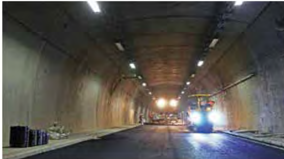
● 瀝青混凝土鋪築
