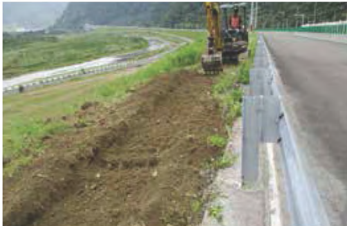
● 路堤北上車道沃土換置
