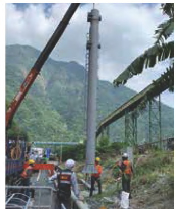
● 鋼構吊裝施工作業
