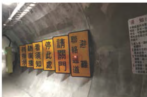
● 觀音隧道人行聯絡通道及標誌牌面安裝完成
