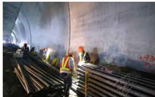
● 東側 A 型導線管群配管
