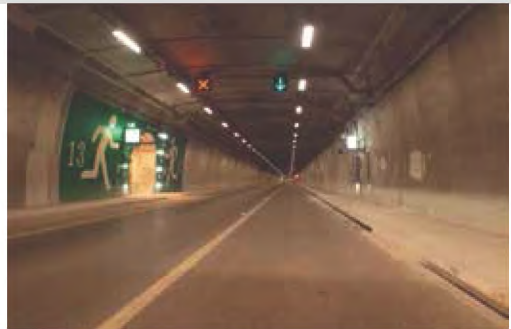
● 觀音隧道完工
