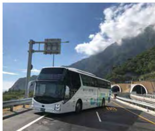
● 回遊號與蘇花改中仁隧道
