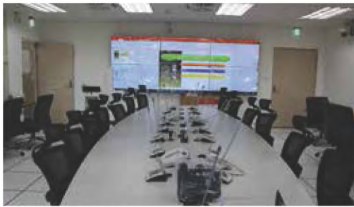
● 南澳交控中心控制室控制桌實景
