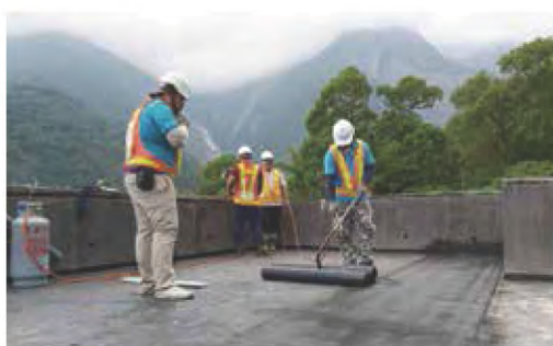
● 中仁隧道南口機房屋頂綠化設施 - 樓板防根布施作
