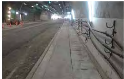
● A、B 型導線管群及消防管槽完成
