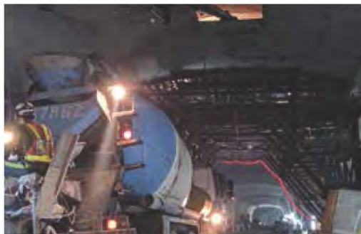
● C1A 通風隔板完成
