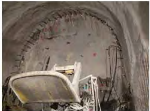
● 排氣排煙隧道開挖
