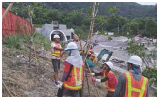
● 中仁隧道南口左側邊坡喬木種植
