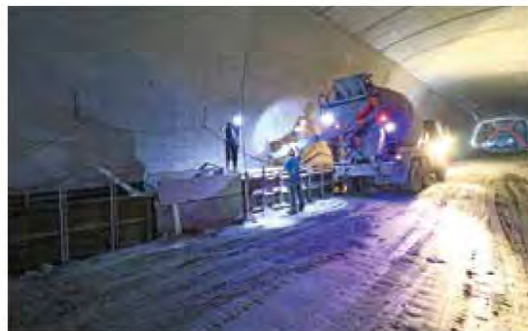
● 第 1 昇層混凝土澆置
