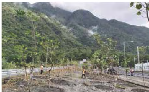
● 中仁隧道南口南下線邊坡黃槿(灌木)種植
