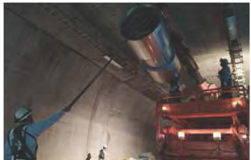
● 隧道噴流式風機安裝
