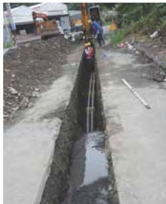
● 克尼布東路管道施工
