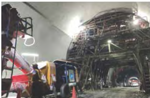
● 襯砌鋼模混凝土澆置
