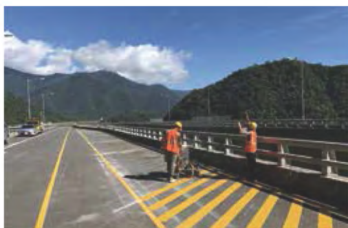
● B1 標道路標線施作
