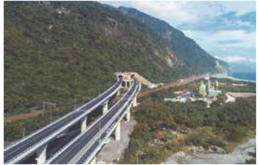
● 漢本高架橋空拍
