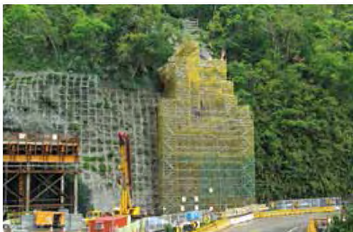
● 洞口採穩固安全之施工架搭設方式進行
