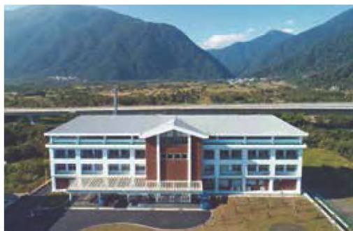
● 南澳基地 交控中心建築
