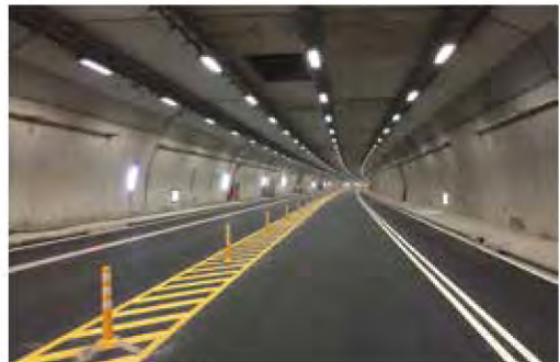
● 路面 AC 鋪設完成
