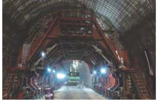
● 谷風隧道抽坍段襯砌混凝土澆置
