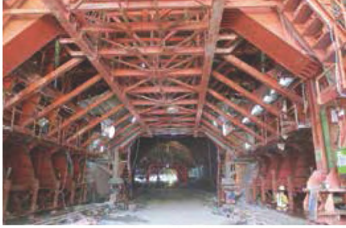
● 谷風隧道 10K 通風橫坑鋼模組裝
