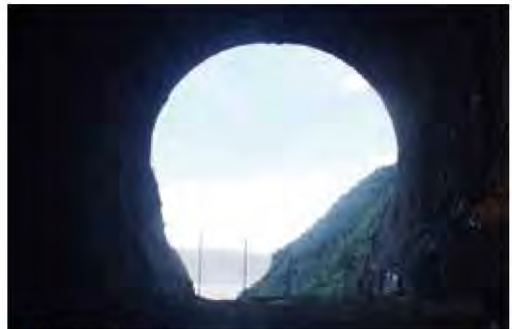
● 排氣排煙隧道開挖完成
