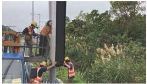
● 資訊可變標誌吊裝施工作業
