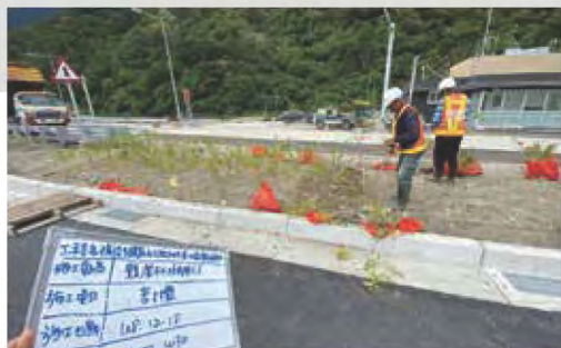
● 中仁隧道北口地磅站苦林盤（灌木）種植
