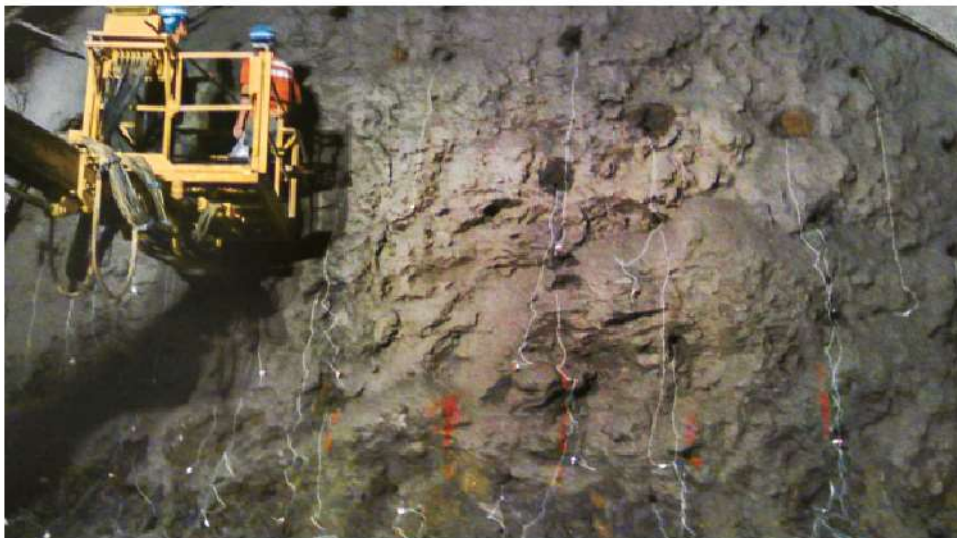
照0-92 北口南下線第43輪裝填炸藥，預備隧道鑽炸作業
