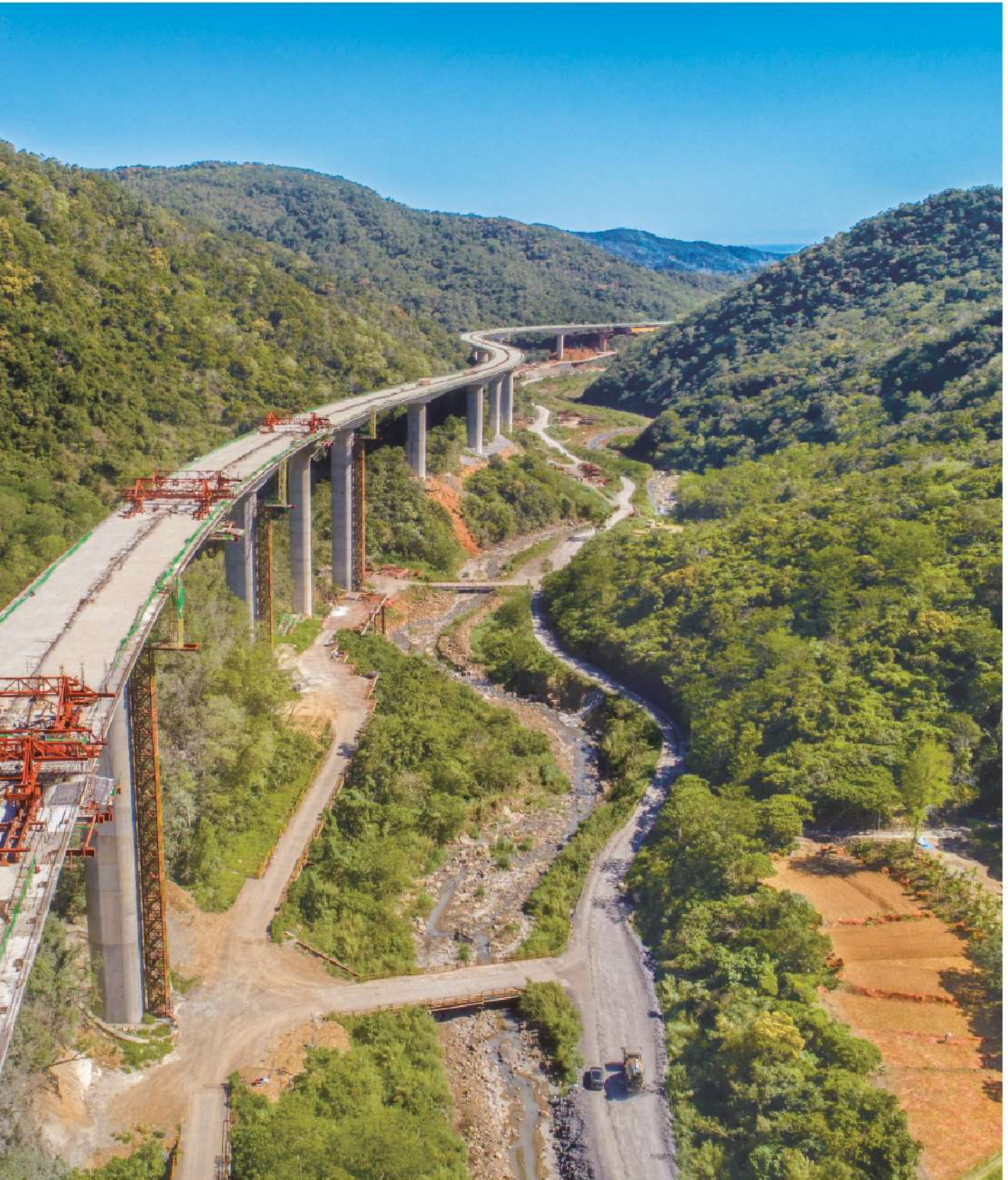
照0-52 施工中的安朔高架橋上部結構 93
