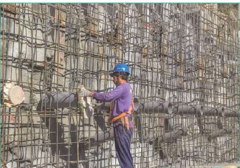
照0-13 鋼筋綁紮後預埋PVC管
