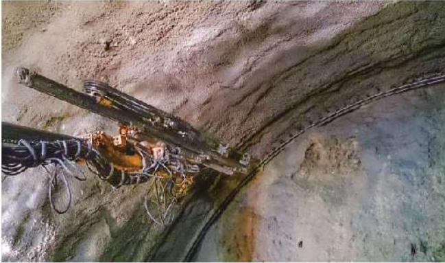
照0-108 南口南下線第86輪噴凝土施工
