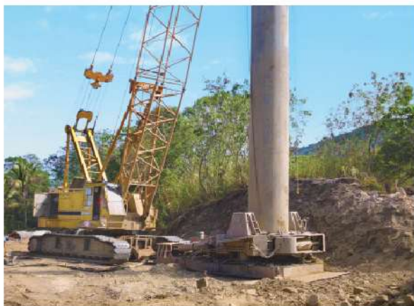
照0-11 全套管基樁步驟3：搖管機定位後進行鑽掘作業
