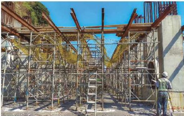
照2-23 明隧道支撐架搭設
