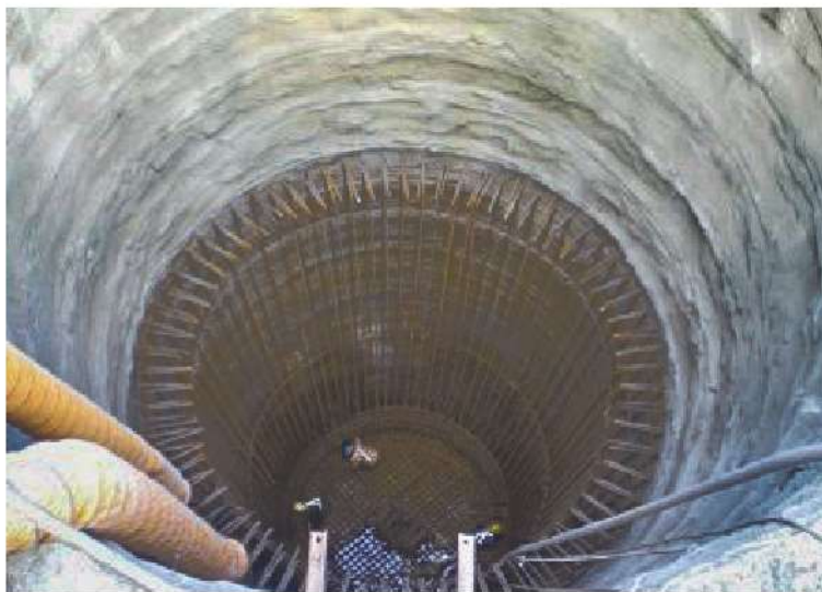
照0-38 井基板鋼筋組立作業
