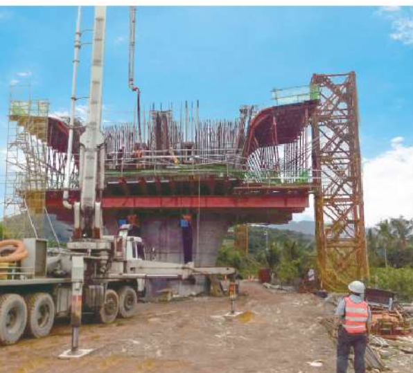
照0-57 懸臂工法：柱頭節塊底腹板澆置
