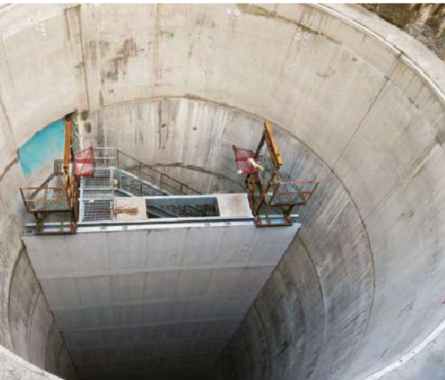
照0-79 草埔森永隧道的豎井內徑9公尺，深達112公尺
