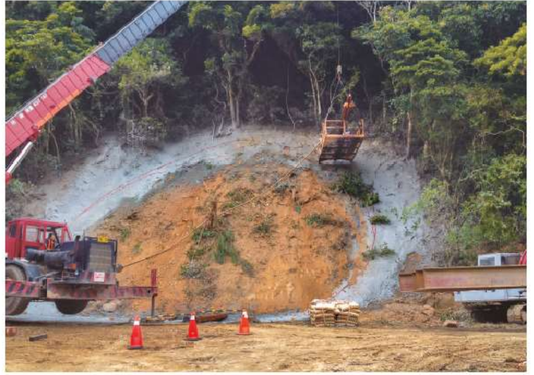
照0-28 上環形梁打設岩栓及灌漿
