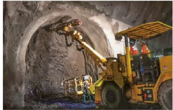
照0-112 採24小時全能工班施工
