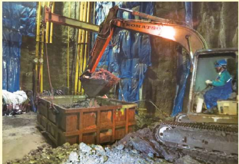
照0-94 將土石運出隧道
