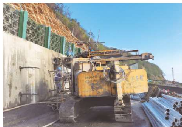
照0-14 岩錨牆地錨打設
