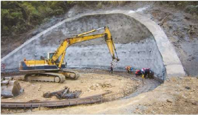
照0-32 井基環梁鋼筋組立
