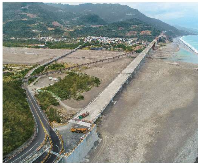
照1-20 金崙大橋施工過程
