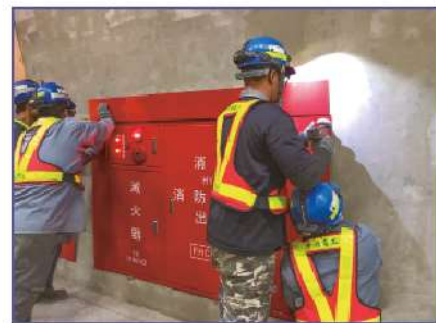
照0-04 消防箱封板檢修
