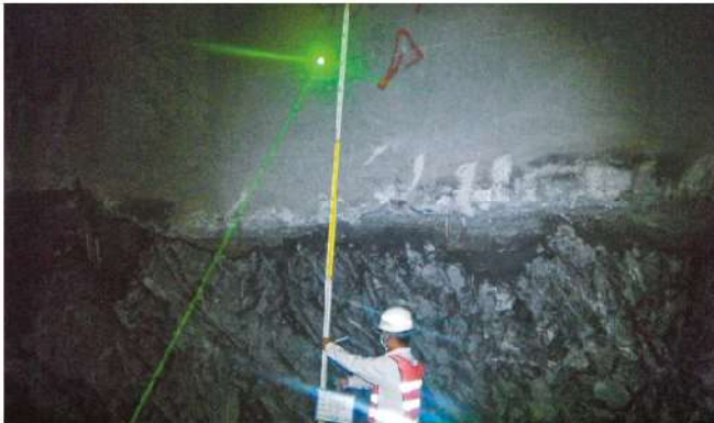
照0-109 南口北上線底梁查驗
