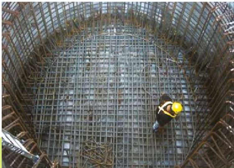
照0-41 井基頂板墩柱鋼筋綁架
