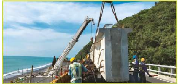
照2-10 預力梁吊梁
