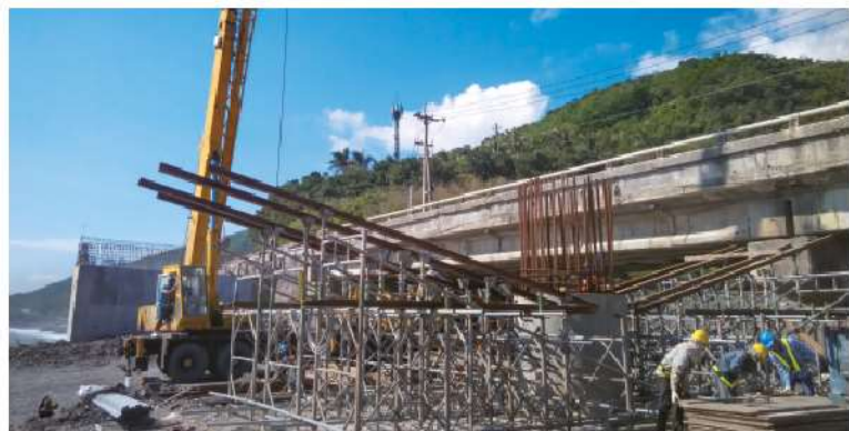
照2-32 富山橋帽梁支撐組立
