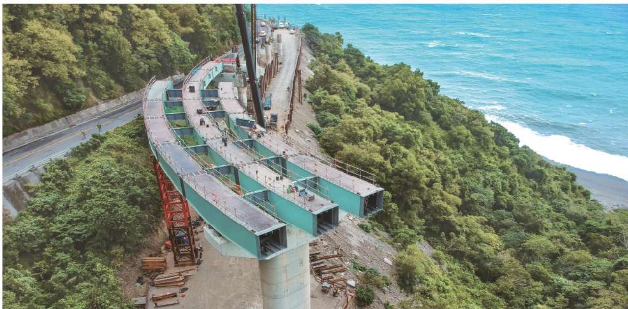
照1-06 香金2號橋鋼箱梁吊裝作業
