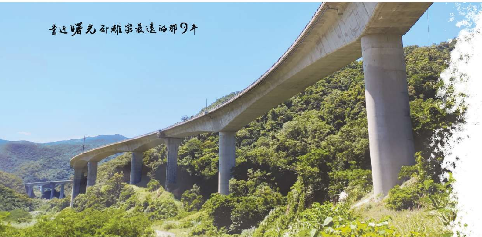
照0-21 座落於斜坡之基礎採用竹削工法
