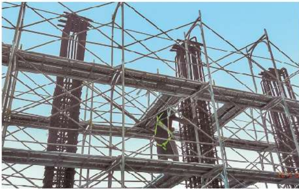
照2-20 明隧道地梁組模
