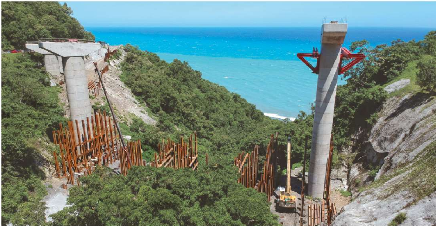
照1-05 香金2號橋構台搭設實景
