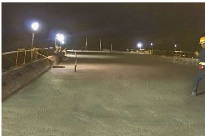
照0-71 支撐先進工法：頂板混凝土澆置
