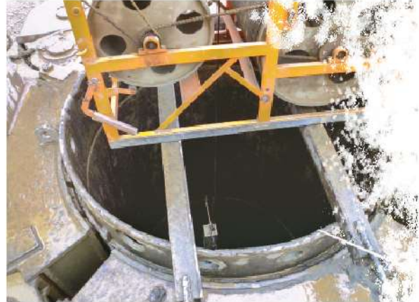
照0-12 全套管基樁步驟4：以超音波檢測儀器檢測基樁垂直度
