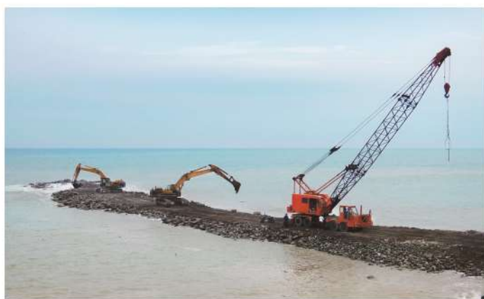
照0-05 填築150公尺的堤心石
