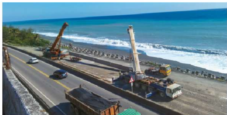
照2-33 富山橋預鑄梁吊放
