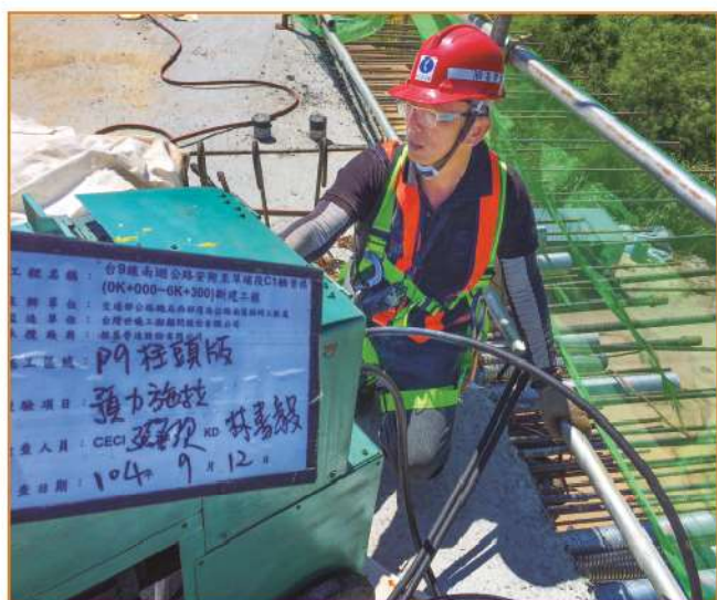
照0-61 懸臂工法：柱頭節塊預力施拉
