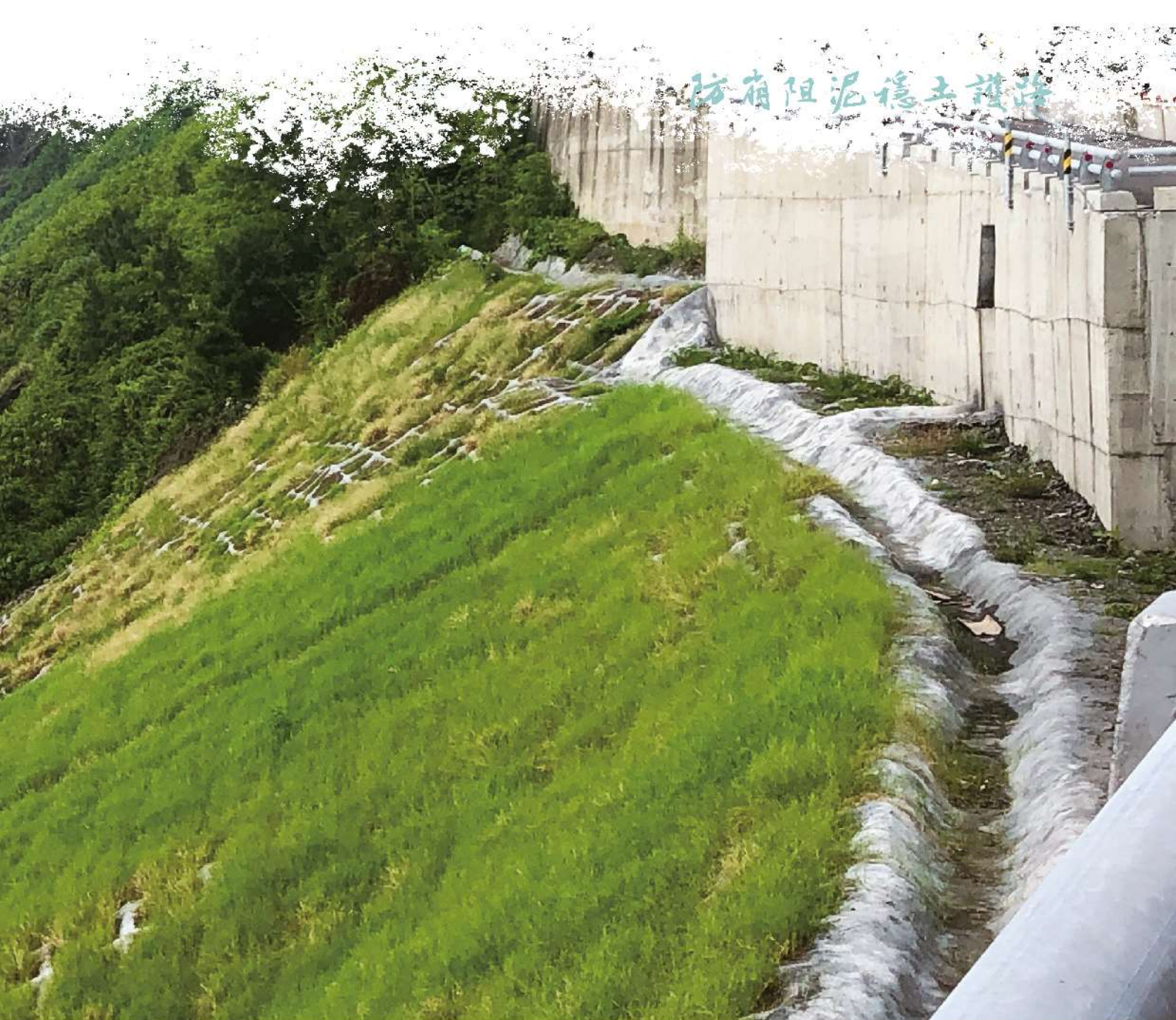
照0-01 台9南迴路段海側下坡擋土護坡實景
