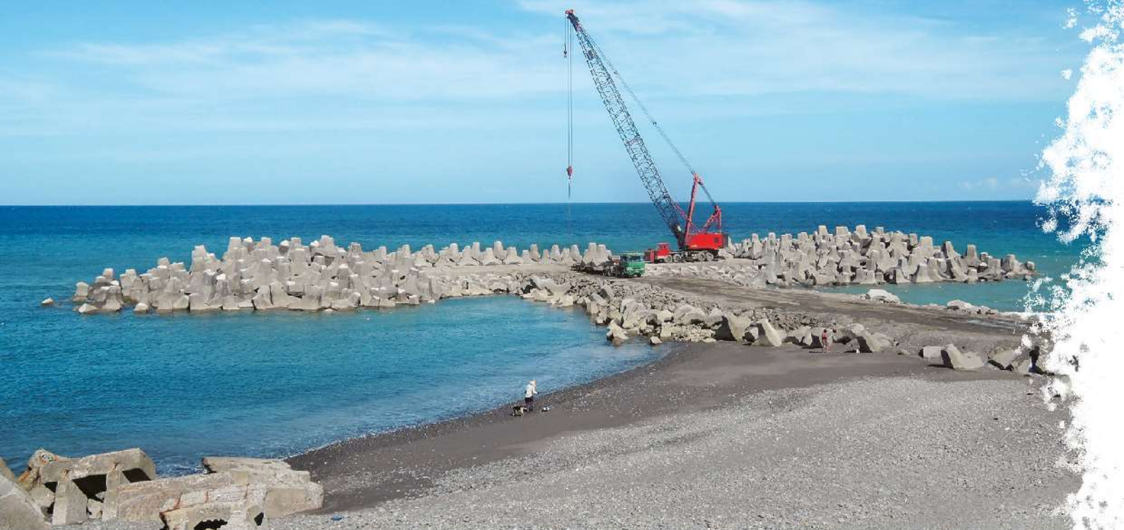
照0-04 吊排15噸的消波塊
