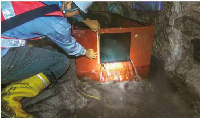
照0-110 豎井VNS量水堰量測
