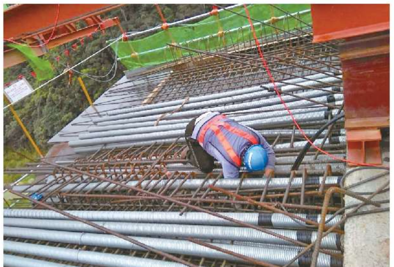
照0-60 懸臂工法：預力套管安裝 97
