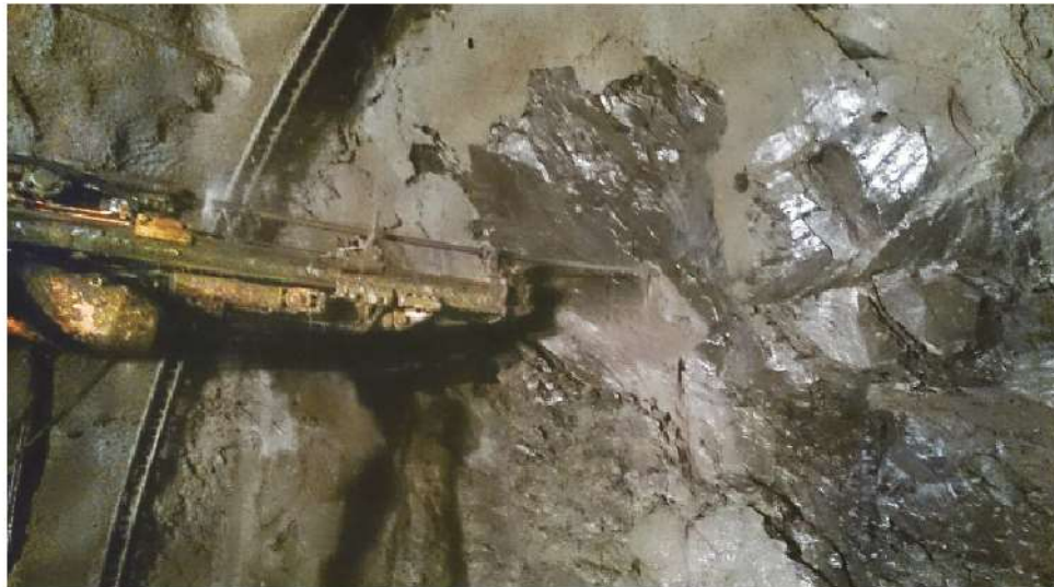
照0-91 南口北上T235炸孔鑽孔，預備裝填炸藥
