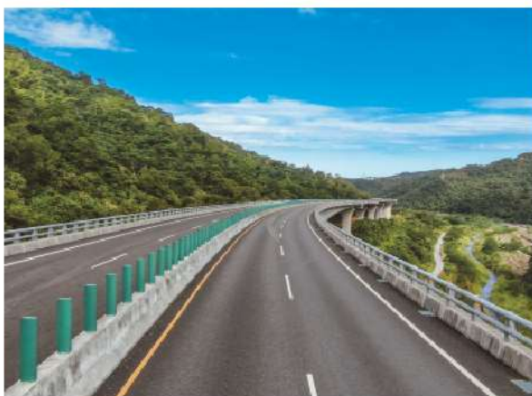
照0-78 安朔高架橋路面鋪築完成
