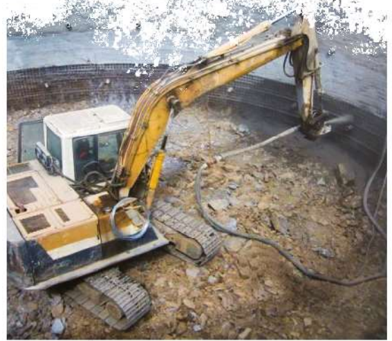
照0-36 噴凝土進行壁面保護
