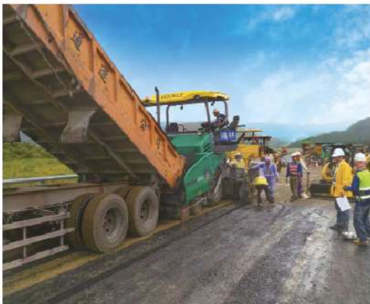
照0-76 安朔高架橋路面鋪築多孔隙瀝青
