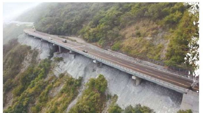
照 1-15 香金4號橋完工通車實景
