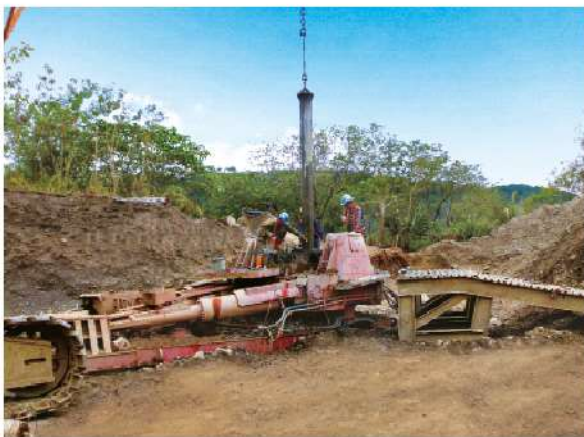
照0-16 全套管基樁步驟8：特密管吊放
