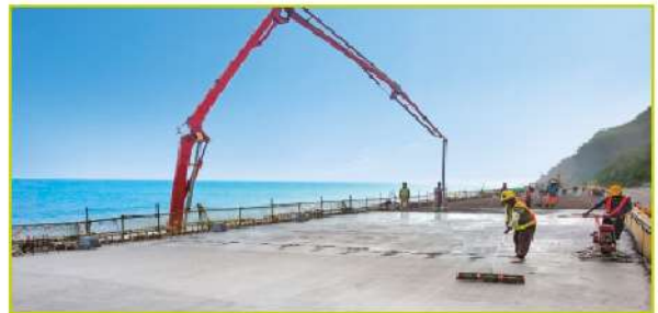
照2-11 橋面板澆置
