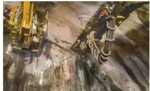
照0-115 北口北上抽坍處管幕單數孔打設
