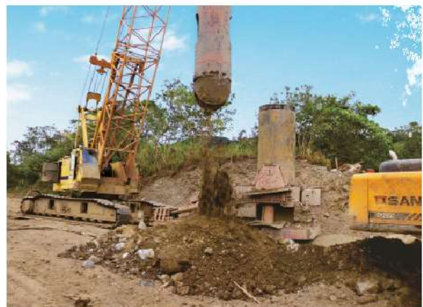
照0-14 全套管基樁步驟6：取出管內土石
