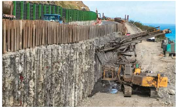
照0-17 放入型鋼後，進行地錨打設
