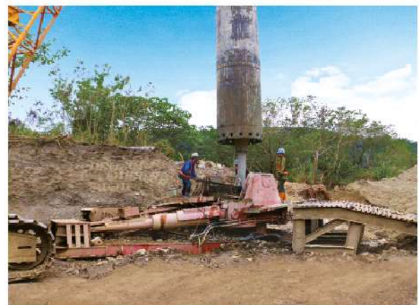
照0-18 全套管基樁步驟10：鋼套管逐節拔出
