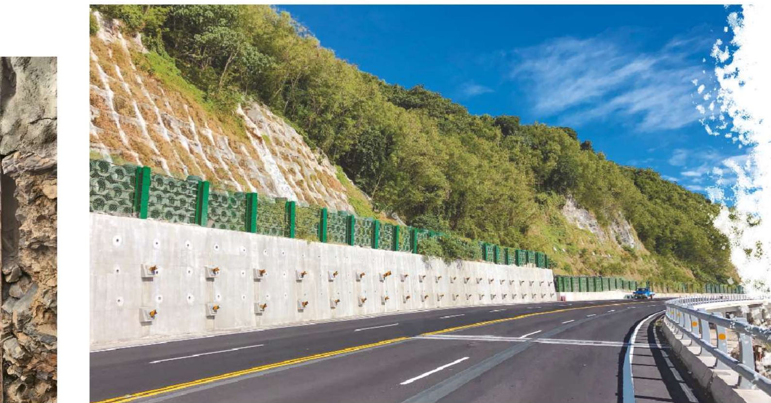
照0-12 岩錨牆完工
