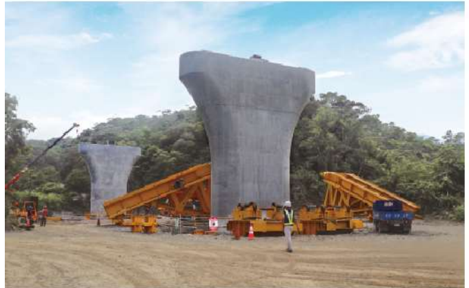
照0-03 安朔高架橋墩柱使用自充填混凝土減少二氧化碳排放量
