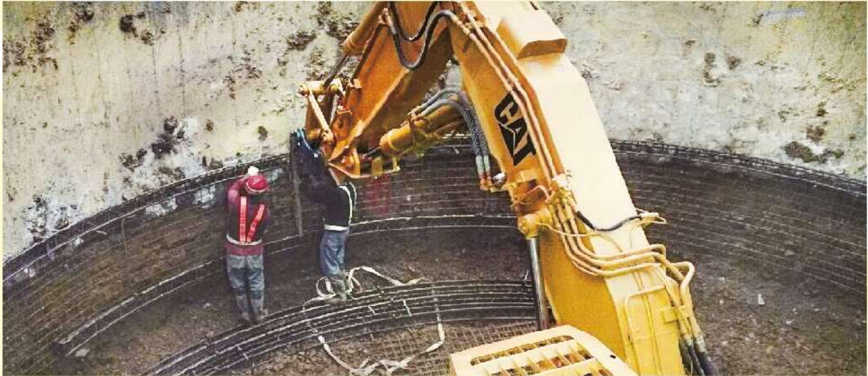
照0-95 鋪設鋼線網
