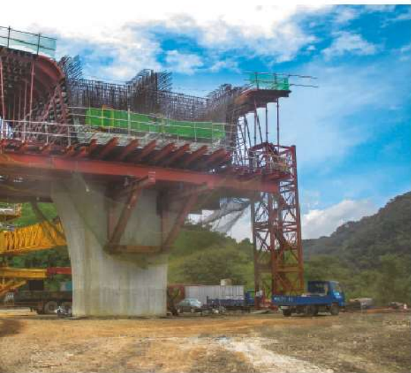
照0-56 懸臂工法：柱頭節塊底腹板鋼筋組立
