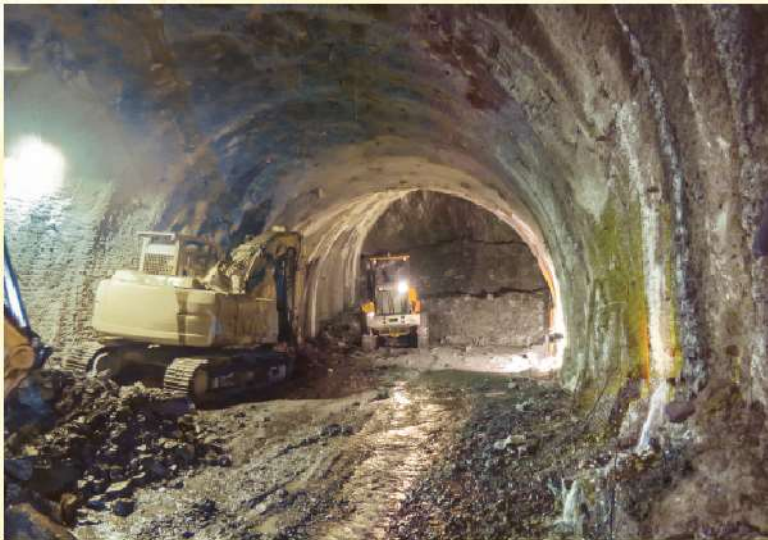
照0-93 流通煙塵後，工程人員入隧道執行出渣作業
