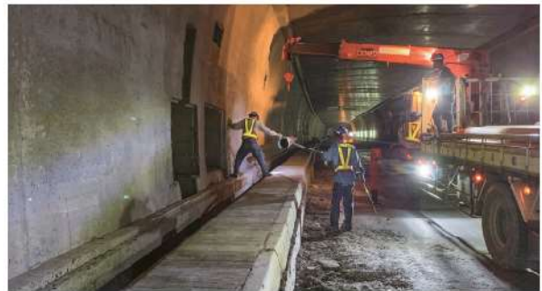
照0-07 消防管路施作情形
