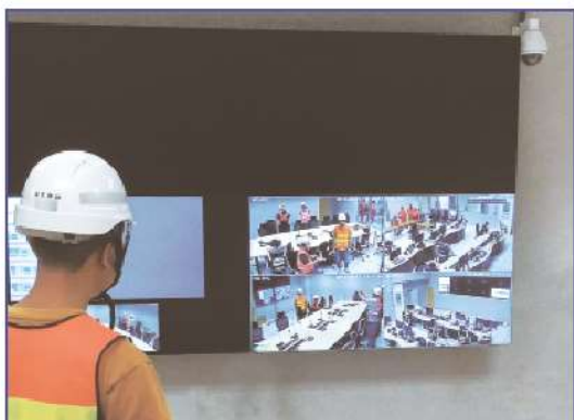
照0-10 安朔交控中心設備測試
