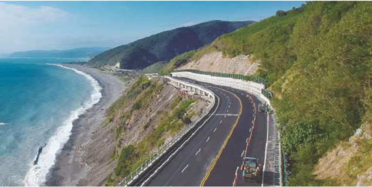
照2-40 新大島橋及棧橋
