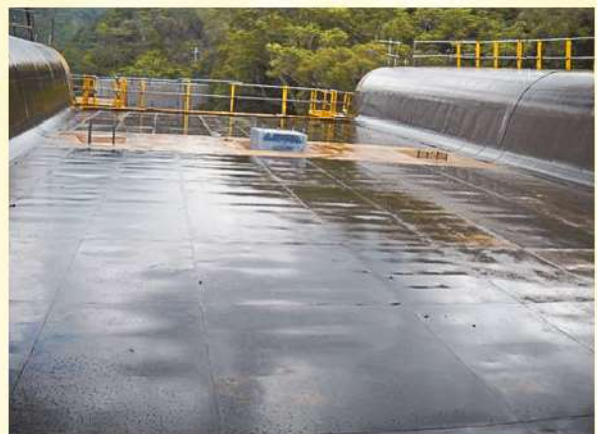
照0-67 支撐先進工法：外模調整及支承處底模組立完成
