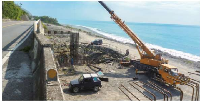
照2-30 富山橋橋墩基礎鋼筋綁架
