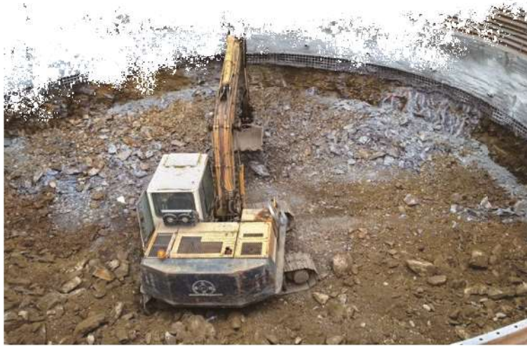
照0-35 井基開挖並架設支堡及鋼線網
