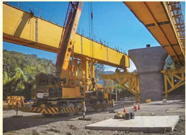
照0-66 支撐先進工法：大梁組立、吊裝
