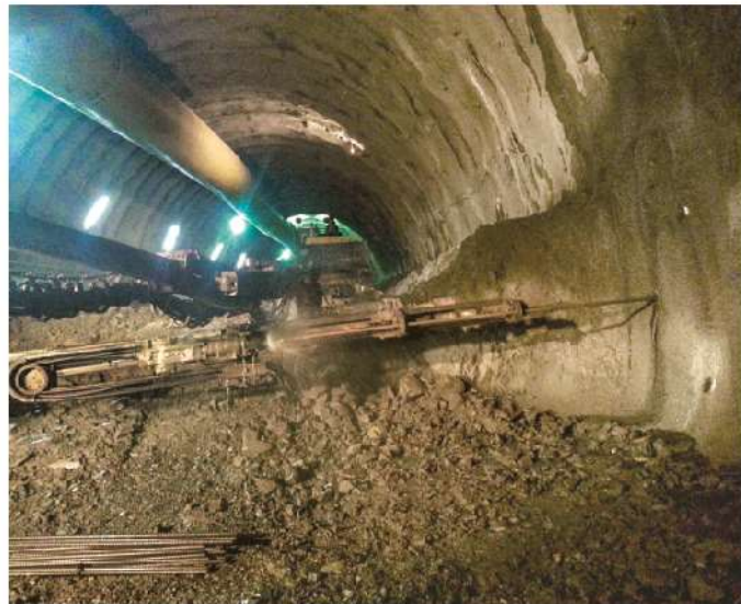
照0-99 北口北上線台階開挖岩栓施作
