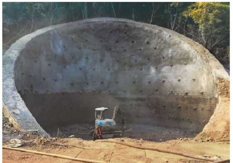
照0-31 完成底座環形梁結構，準備井基輪道開挖
