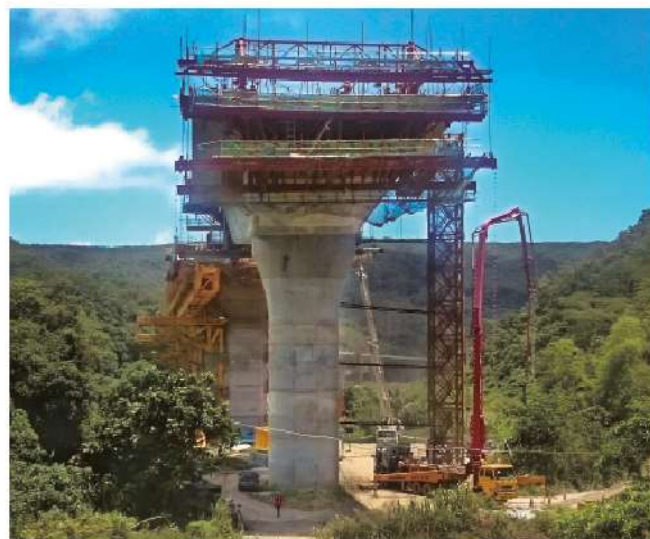
照0-63 懸臂工法：懸臂節塊澆置
