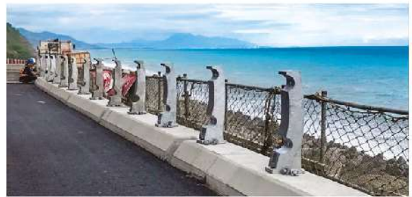
照2-12 橋欄杆安裝
