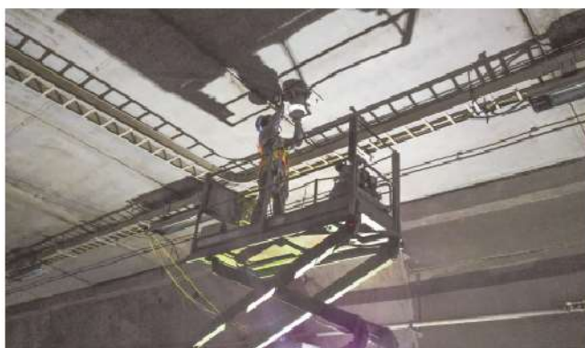
照0-12 草埔森永隧道北上車道管制號誌(LCS)支架安裝施工作業
