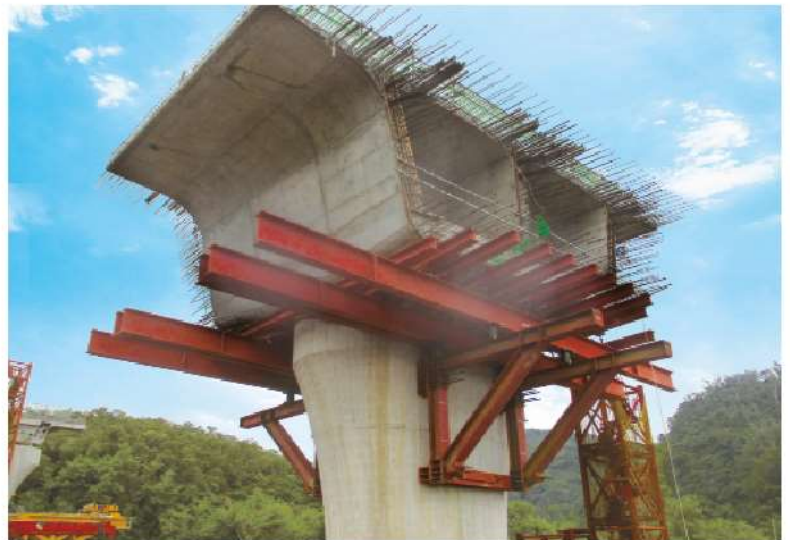
照0-59 懸臂工法：柱頭節塊頂板澆置及養護
