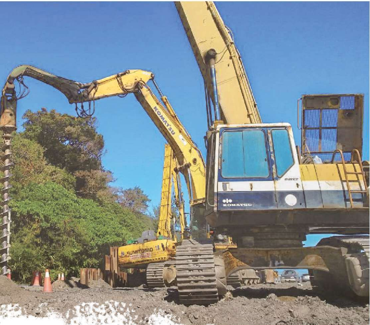
照0-18 機具定位引孔，準備放置套管 145
