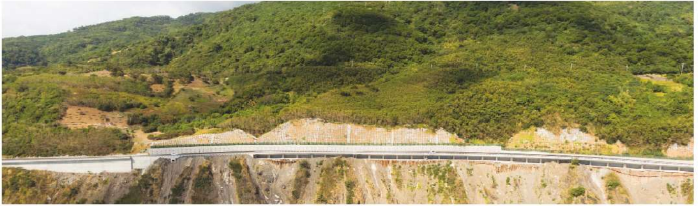
照2-45 棧橋與邊坡完工
