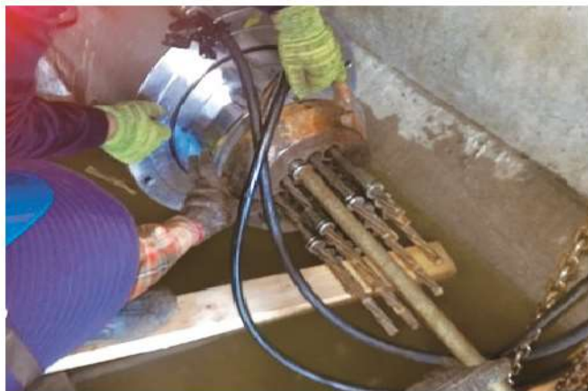
照0-72 支撐先進工法：預力施拉、套管灌漿
