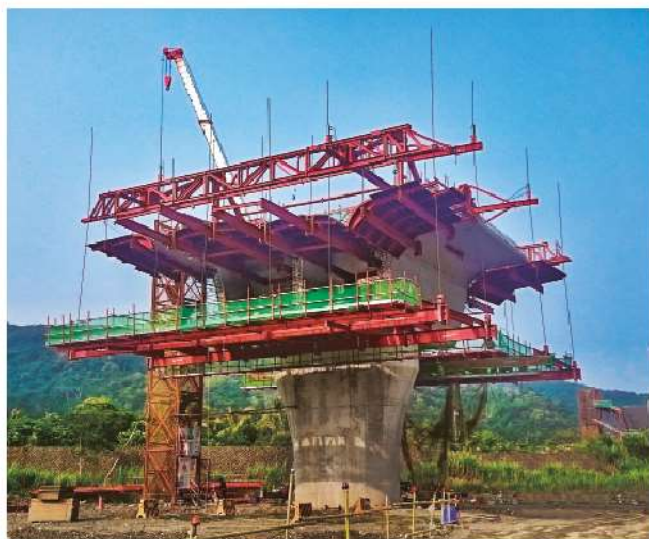
照0-62 懸臂工法：懸臂工作車組立
