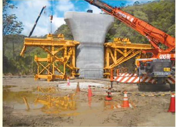
照0-65 支撐先進工法：托架、支撐架搭設
