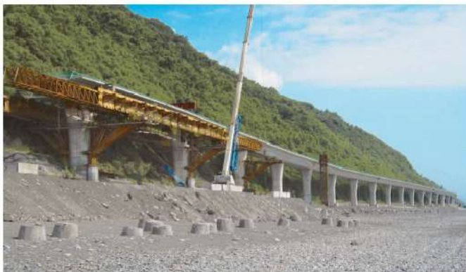
照 1-11 多良高架橋施工過程
