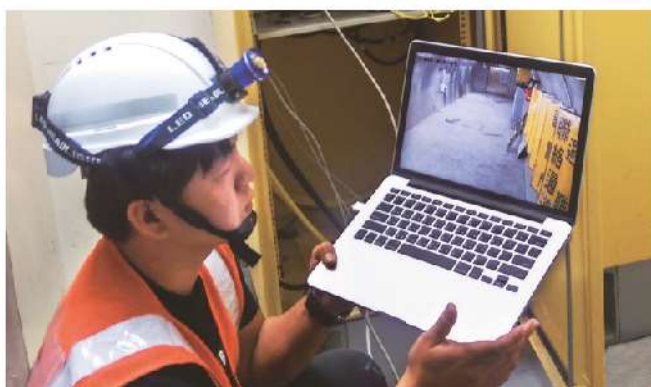
照0-11 CCTV影像調整
