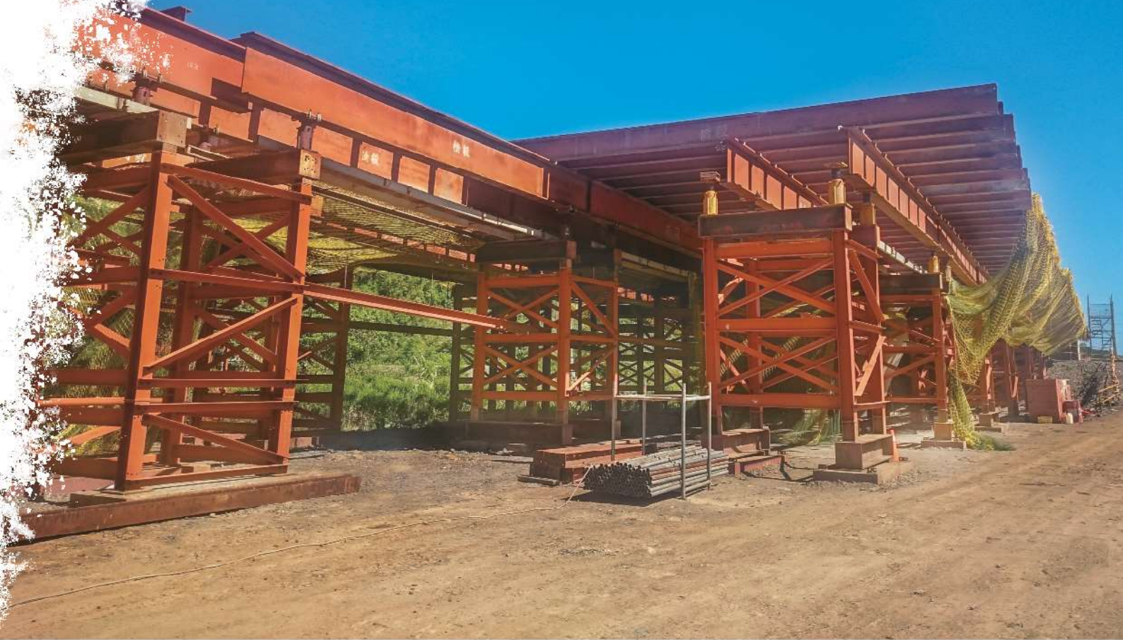
照0-75 完成場撐逐跨是最普遍的橋梁工法
