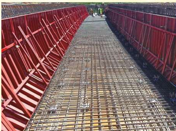
照0-68 支撐先進工法：底腹板紮筋、組模完成
