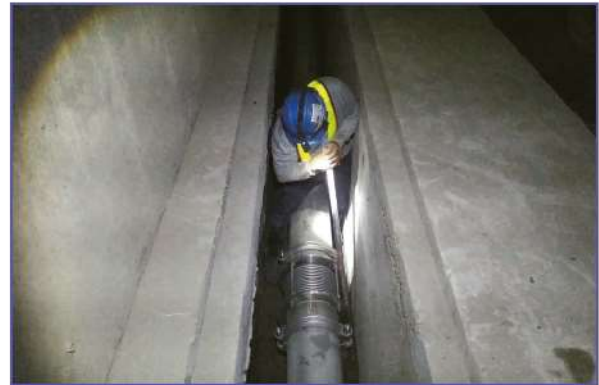
照0-09 消防管路施作情形
