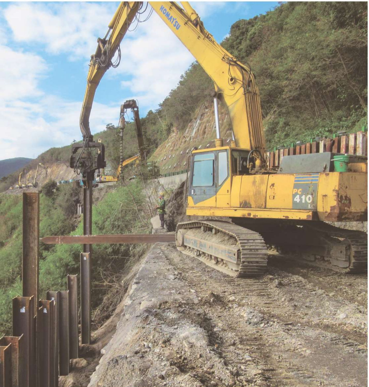
照0-03 H型鋼打設
