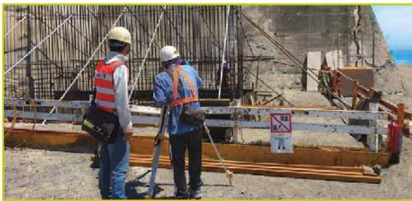
照2-07 A1橋台施作
