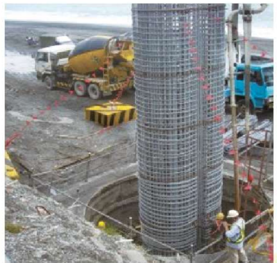
照0-42 井基準備封頂及澆置混凝土作業
