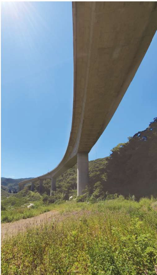
照0-22 低谷仰望高架橋
