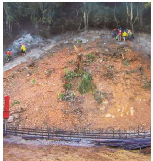
照0-24 上環形梁鋼筋綁紮組立
