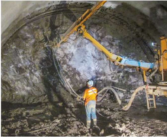
照0-98 南口南下線第96輪噴凝土施工
