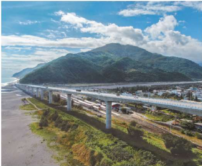
照1-19 金崙大橋通車後，鄰近村落的交通更加順暢
