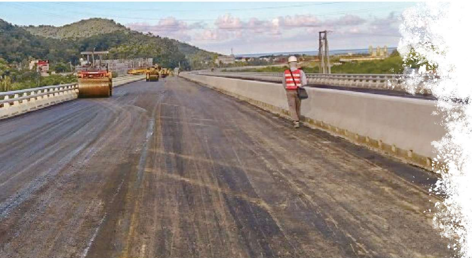
照0-77 安朔高架橋路面工程
