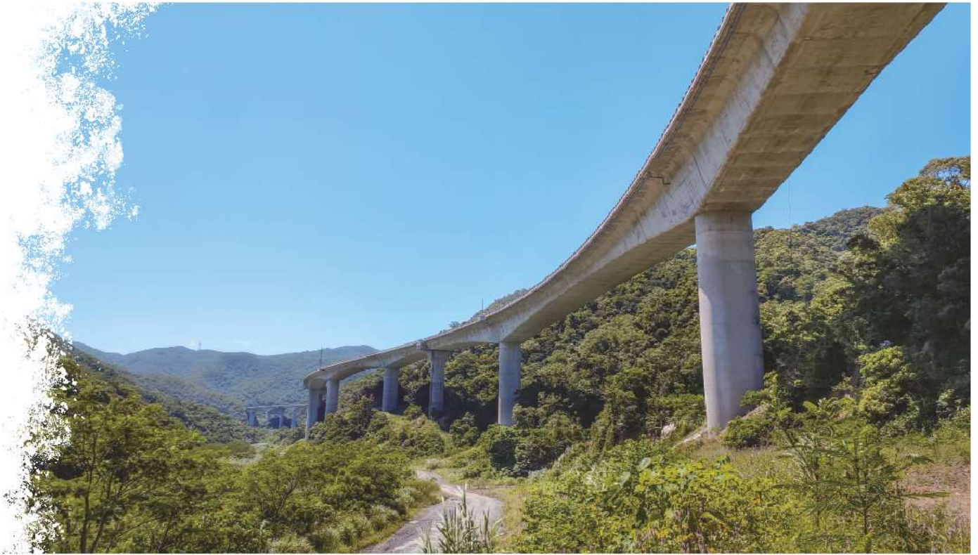
照0-03 竹削護基工法運用在斜坡上的承載力佳且對環境友善
