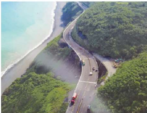
照2-02 截彎取直的新大島橋使道路不再崎嶇
