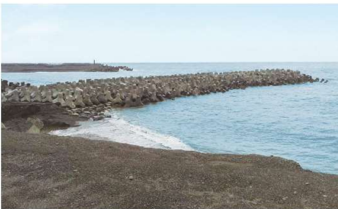
照0-14 北突堤吊排完成
