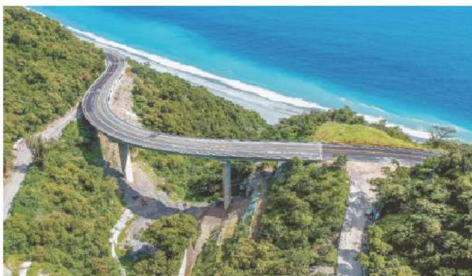
照 1-12 香金2號橋截彎取直通車現況
