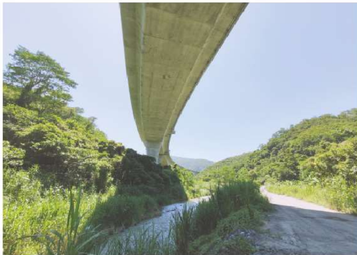
照0-02 安朔高架橋下五福谷溪河谷
