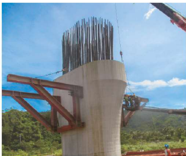
照0-54 懸臂工法：柱頭節塊支撐架組立
