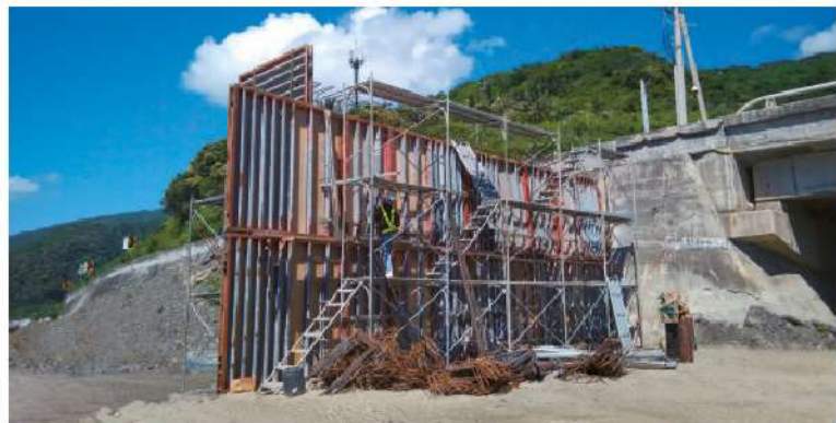
照2-31 富山橋橋台模板組立
