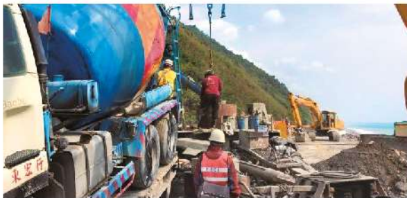
照2-06 全套管基樁施作
