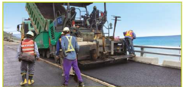
照2-13 瀝青混凝土鋪築
