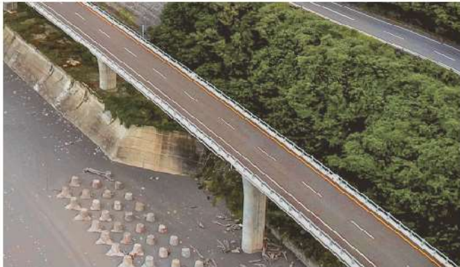
照 1-10 多良高架橋構築防浪牆並佈設消波塊
