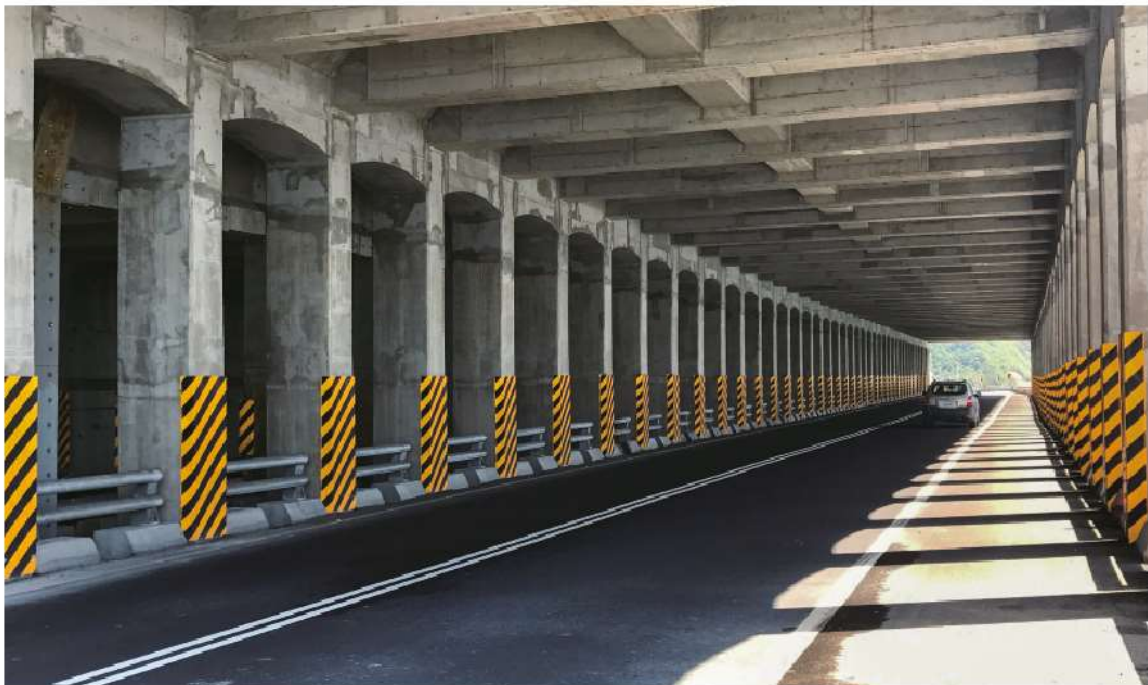
照2-28 明隧道完工通車實景
