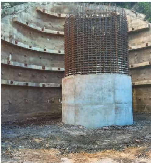
照0-43 井基完成回填復舊
