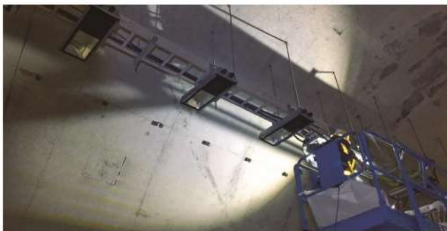
照0-08 隧道照明燈具檢修
