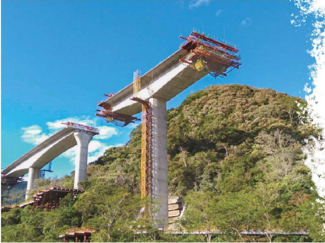
照0-53 懸臂工法向橋墩兩側以左右對稱的方式推進施作節塊
