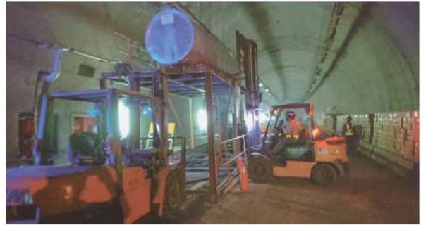
照0-06 隧道噴流式風機施工
