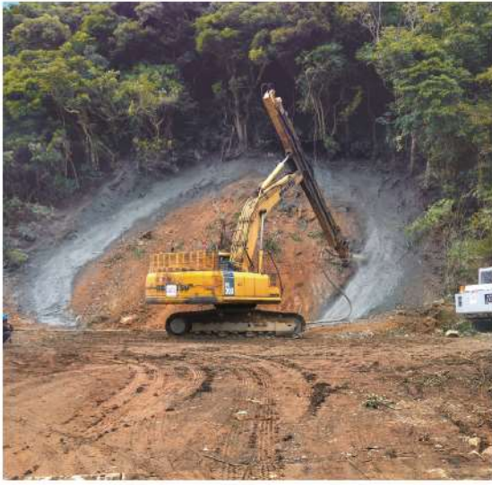
照0-26 上環形梁底部噴凝土
