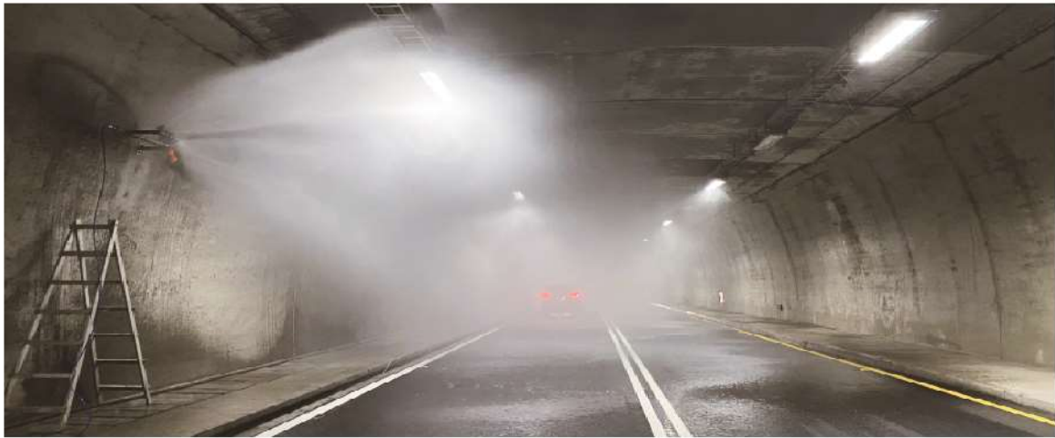
照0-03 水霧消防系統噴灑測試
