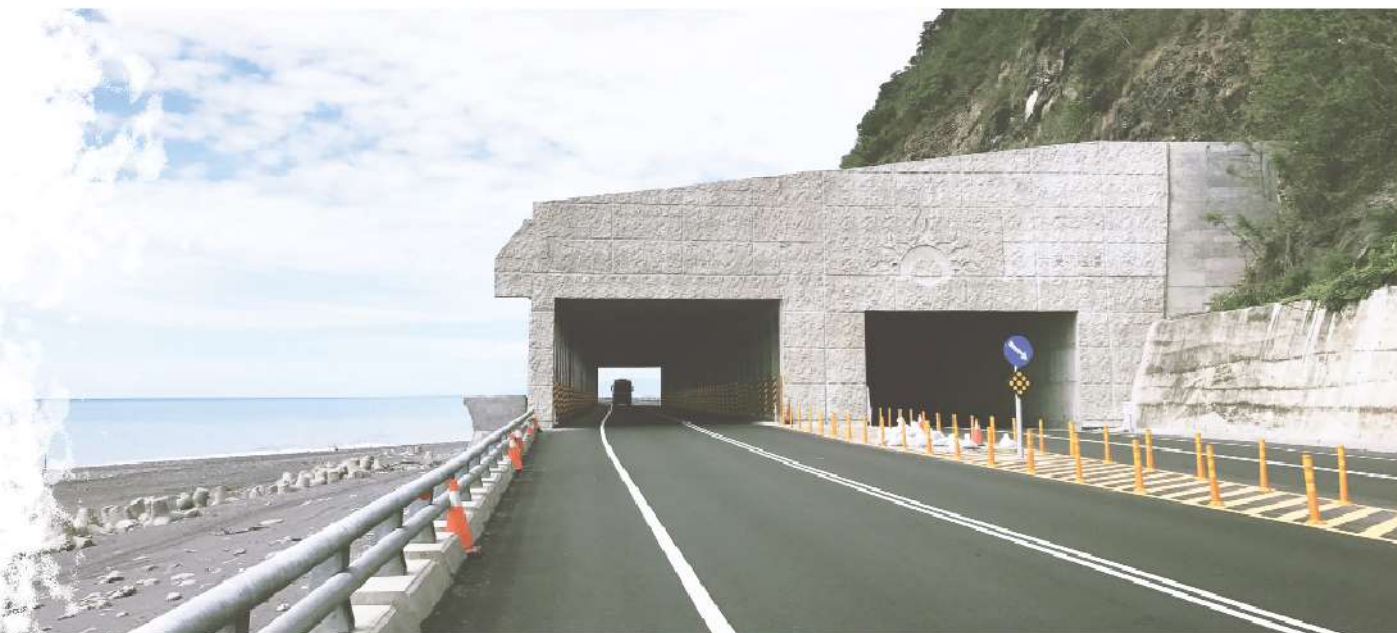
照0-06 大溪明隧道
