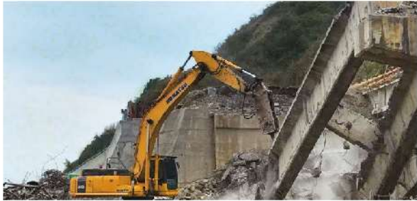
照2-05 既有多良橋海側橋拆除
