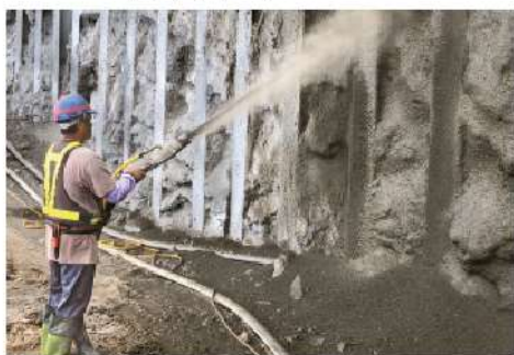
照0-09 開挖後進行表面噴漿固定牆面
