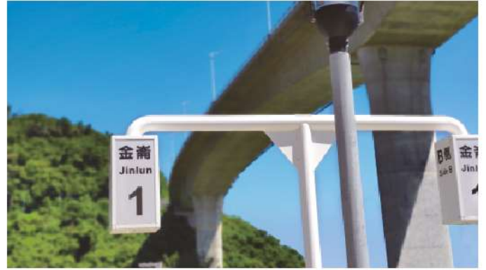
照1-24 金崙車站與金崙大橋
