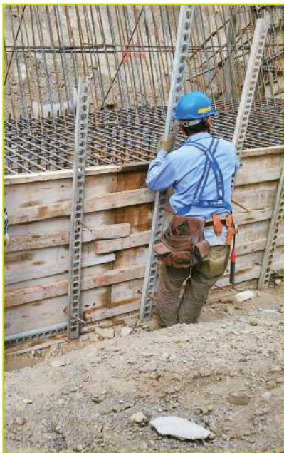
照2-17 防浪牆基礎模板施工
