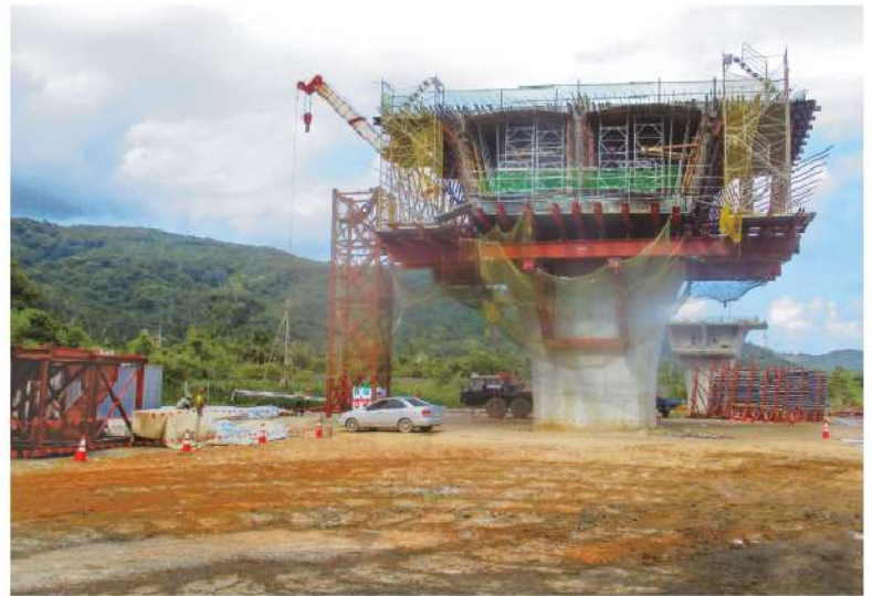
照0-58 懸臂工法：柱頭節塊頂板鋼筋組立及預埋件安裝
