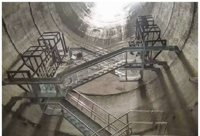
照0-83 豎井鋼樓梯組裝作業
