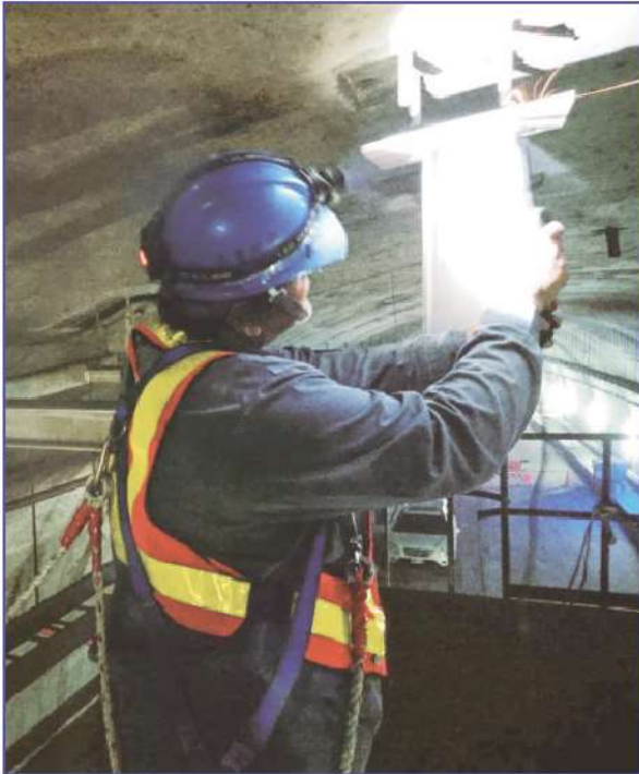
照0-05 隧道噴流式風機施工
