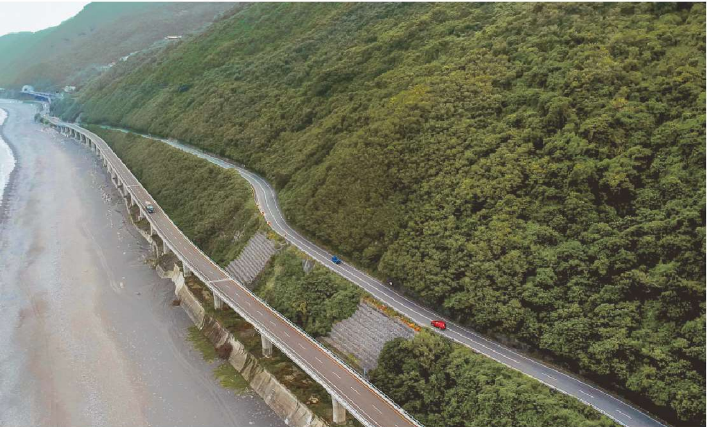
照1-16 多良高架橋
