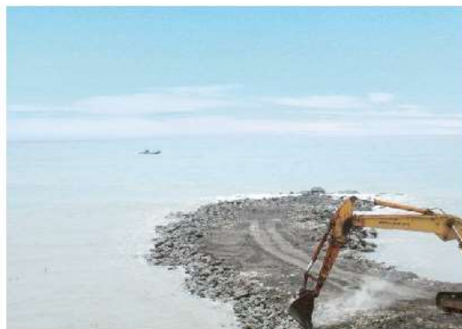
照0-07 北突堤修坡
