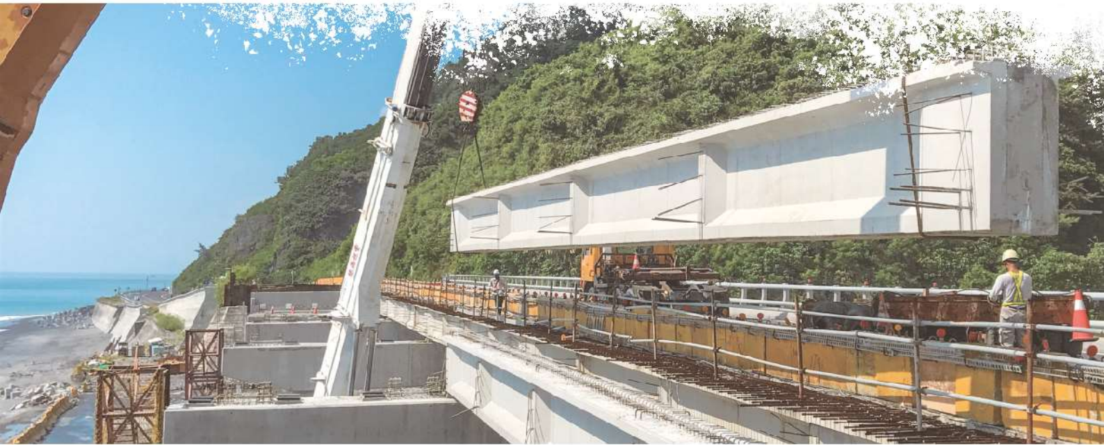
照2-39 香蘭至大鳥段預力梁吊梁
