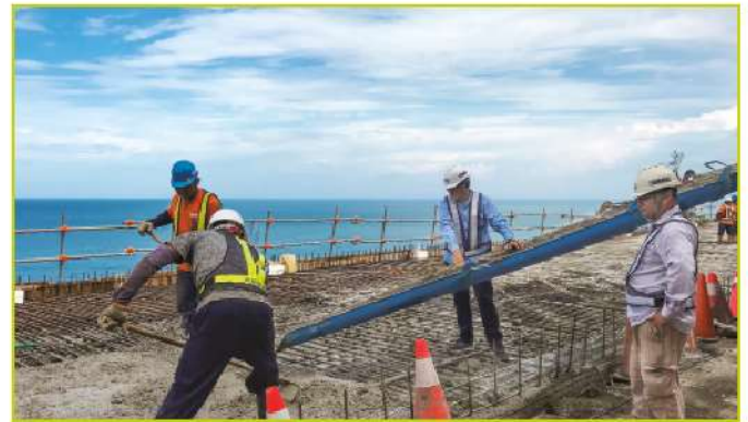
照2-47 棧橋橋面板混凝土澆置作業
