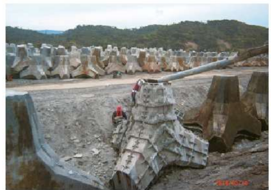
照0-13 養灘-消坡塊施作
