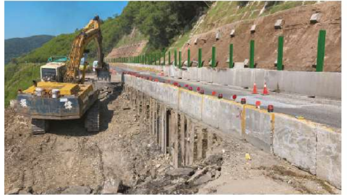
照2-42 挖土機在有限的空間下開挖
