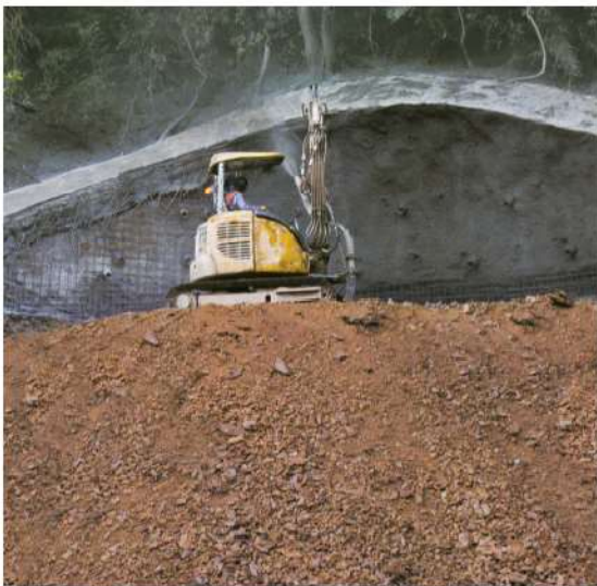
照0-27 上環形梁牆身噴凝土
