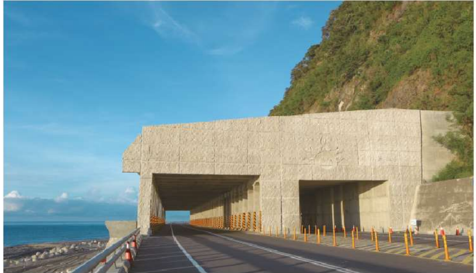
照2-27 明隧道拓寬完工
