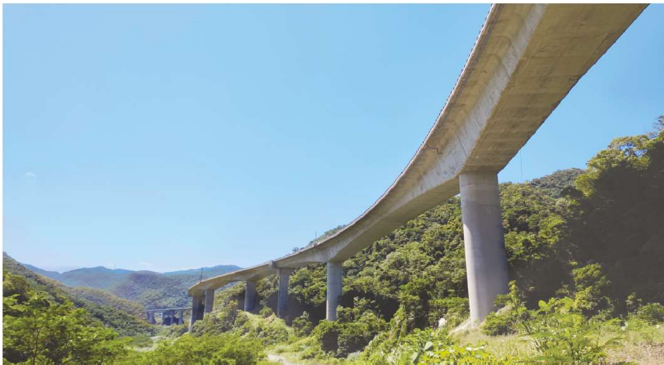
照0-05 減少鋼筋混凝土用量的低碳工法
