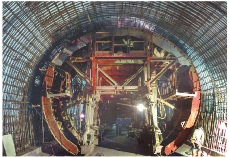
照0-81 豎井橫坑頂拱鋼筋綁紮
