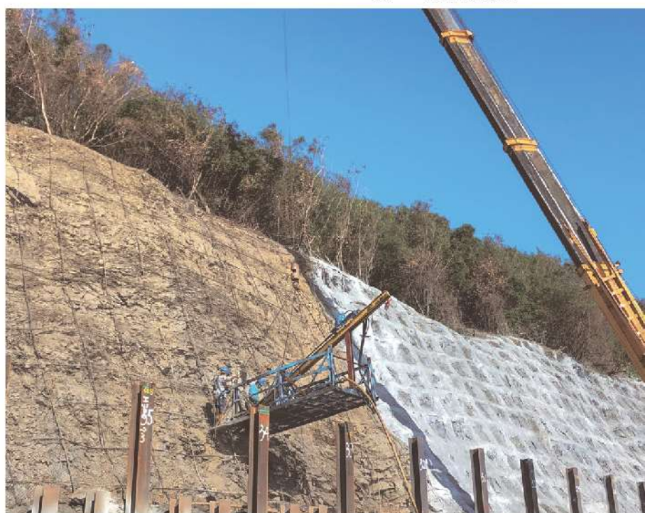
照0-05 格框錨筋打設
