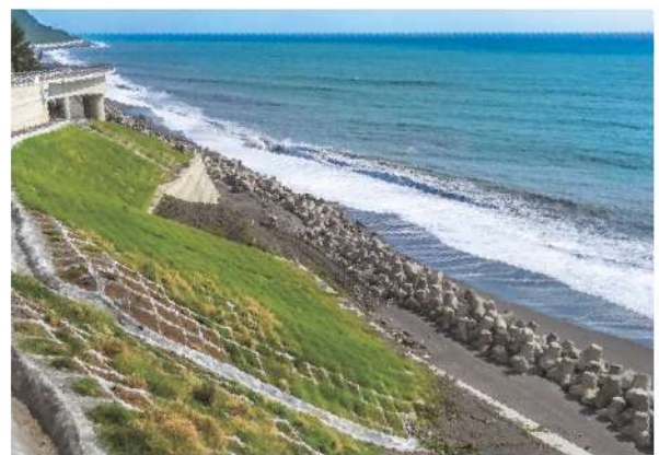
照0-08 海側邊坡植草
