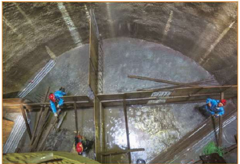
照0-82 豎井坑底集水井模板組立
