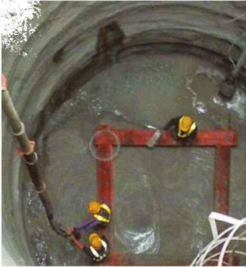
照0-37 井基混凝土封底
