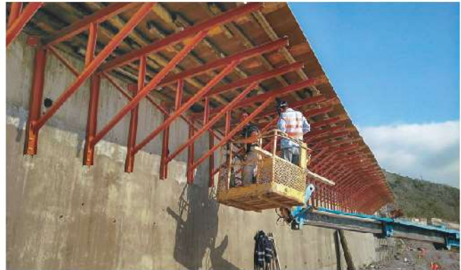
照2-15 大烏段擋土牆懸臂板施工
