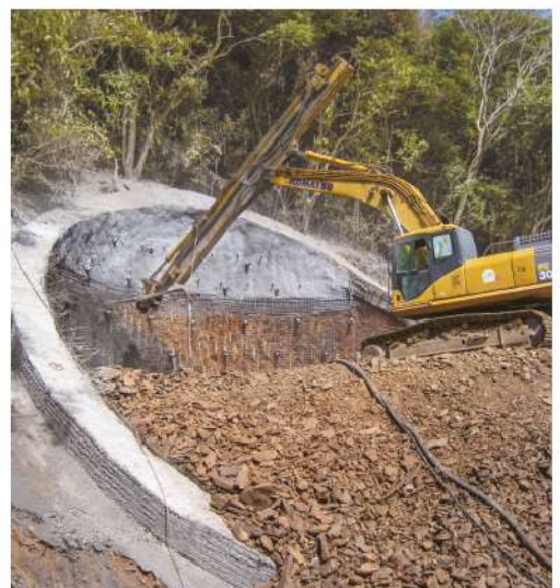
照0-25 竹削第二階段開挖與噴凝土作業
