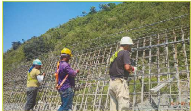
照2-16 防浪牆頂圓弧造型收尾處鋼筋綁紮
