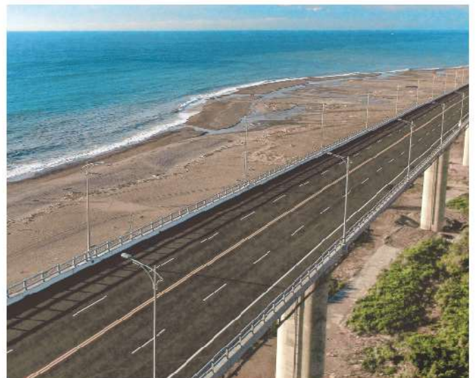
照1-22 金崙大橋緊鄰海岸
