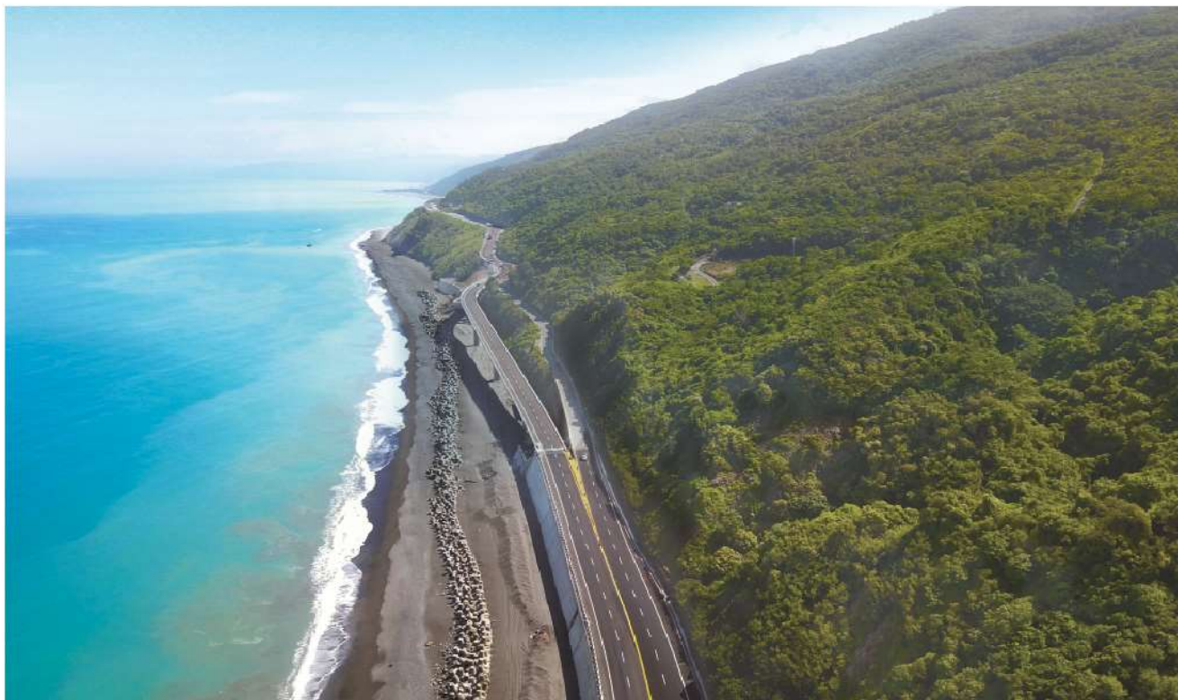
照2-37 新加津林橋完工實景
