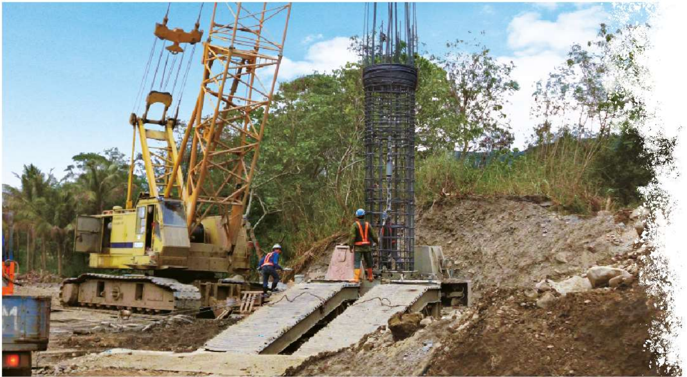
照0-15 全套管基樁步驟7：鋼筋籠吊放
