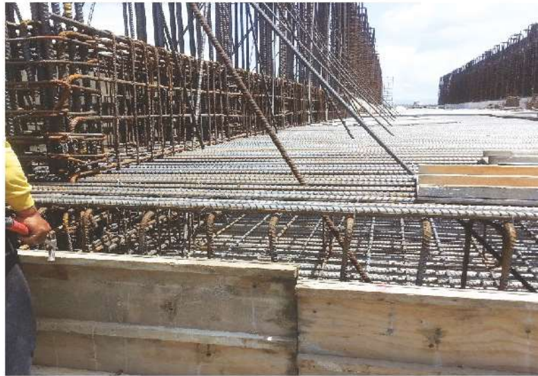
照2-25 明隧道柱鋼筋綁紮
