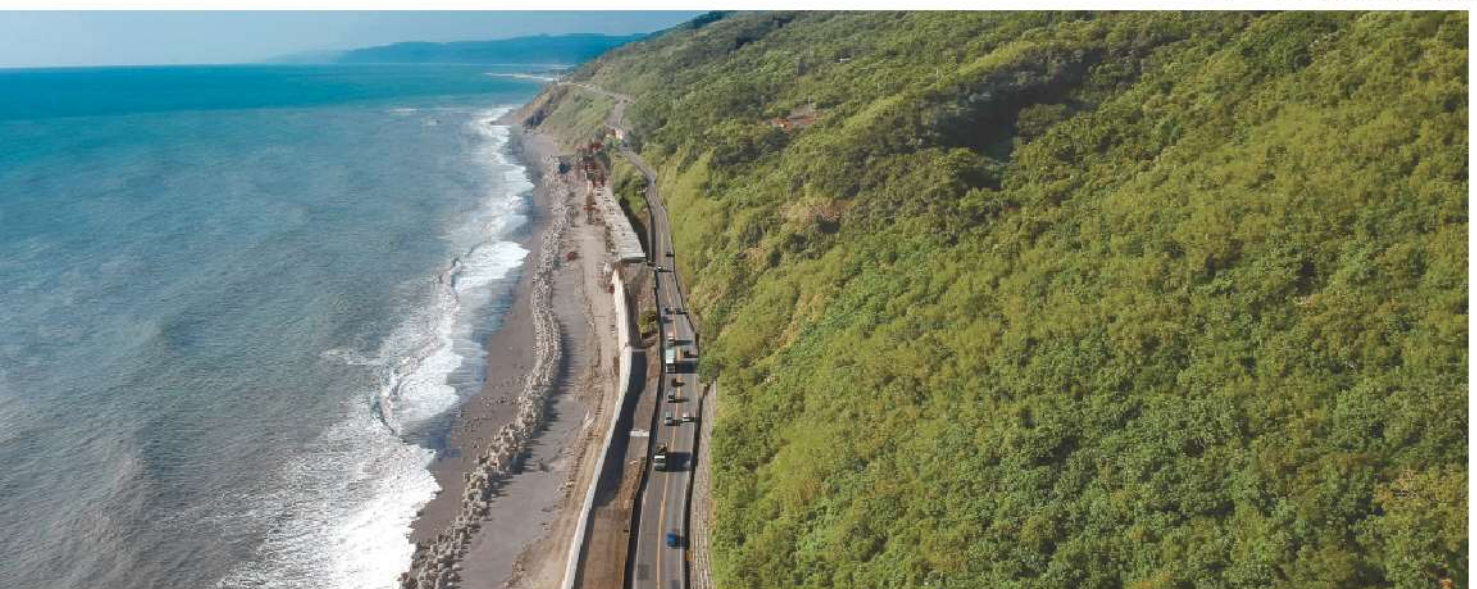
照2-19 擋土牆施作緊鄰太平洋
