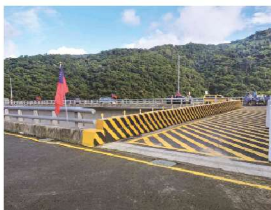
照0-16 隧道洞口迴轉道
