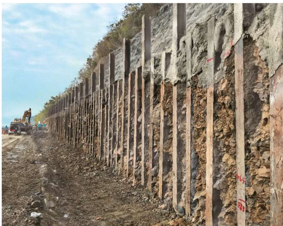
照0-10 第二層向下開挖預留基礎位置
