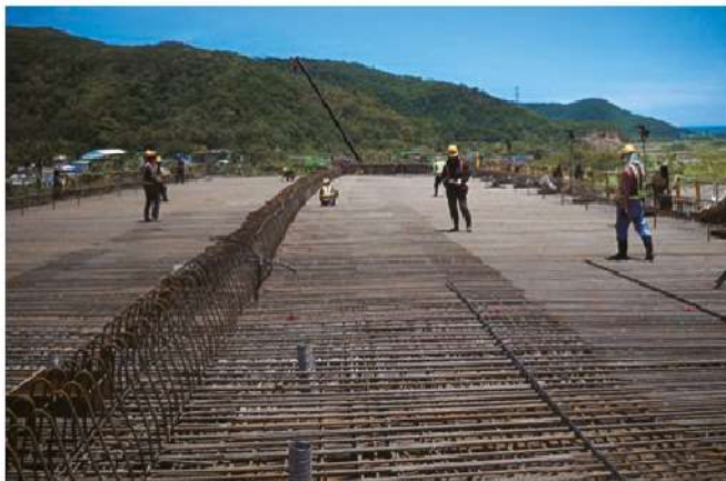
照0-70 支撐先進工法：頂板鋼筋綁紮
