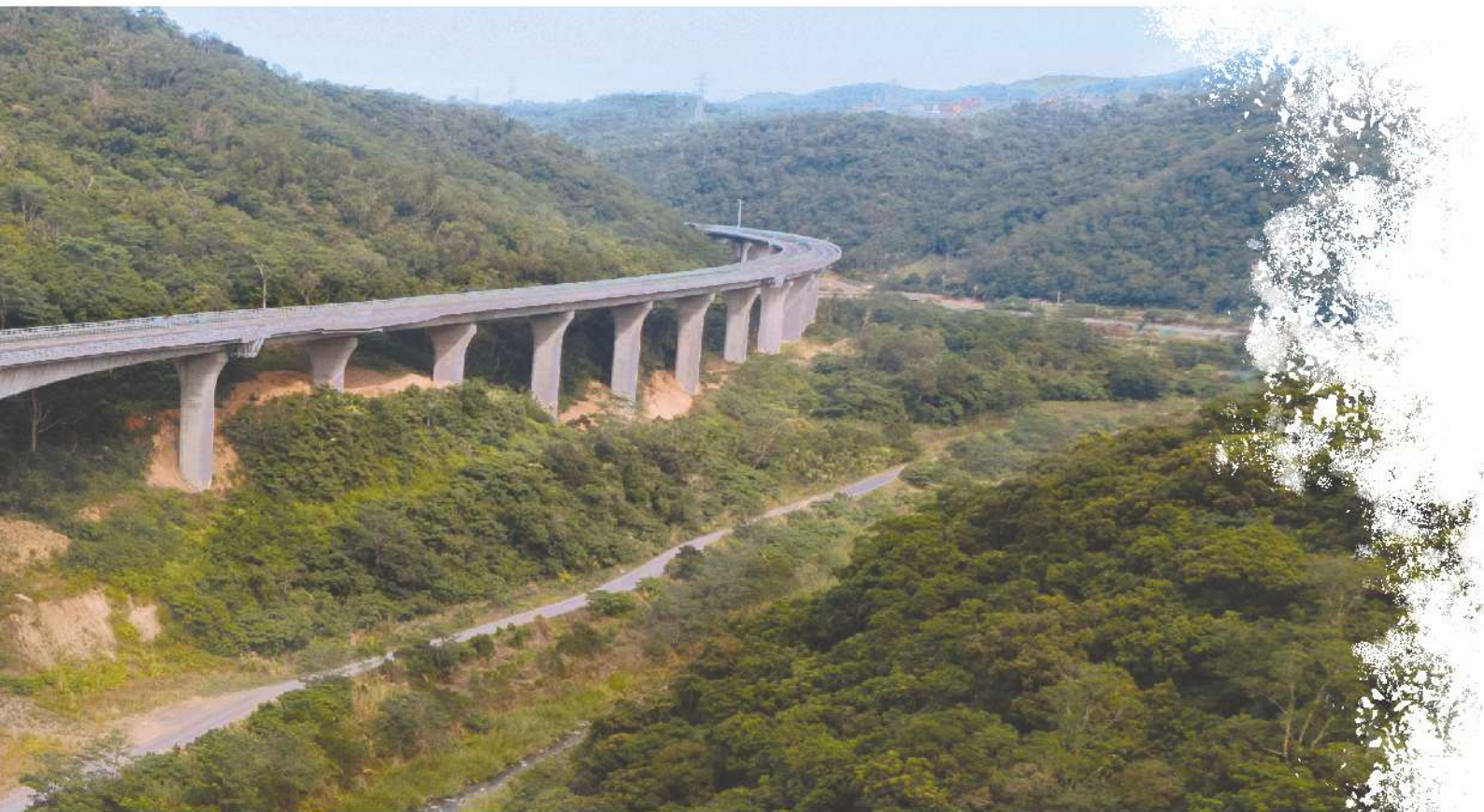
照0-06 安朔高架橋橋墩基礎因應地形採不同施工工法
