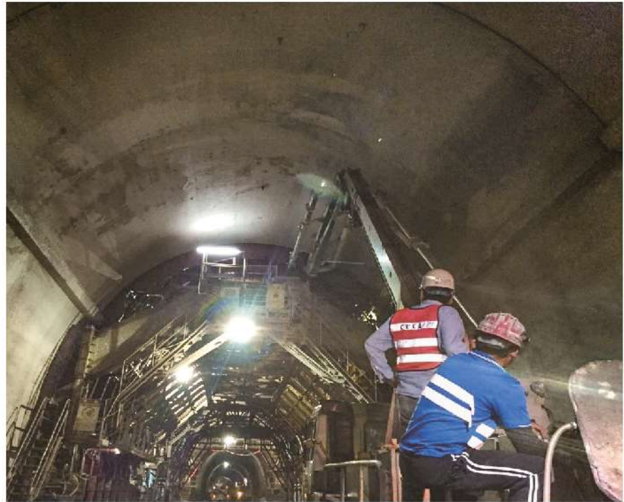
照0-102 南口北上線頂拱混凝土澆置
