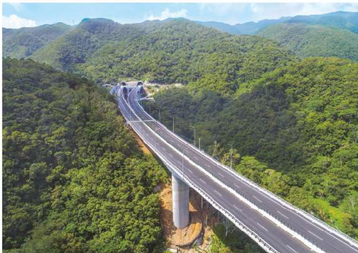
照0-04 行駛在安朔高架橋體驗穿山越嶺的暢快
