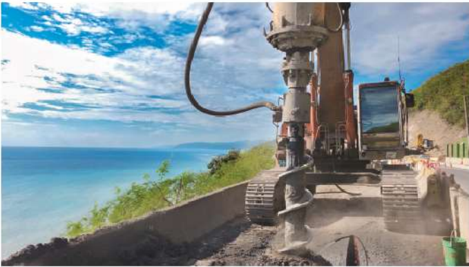
照2-41 打設型鋼保護既有台9線
