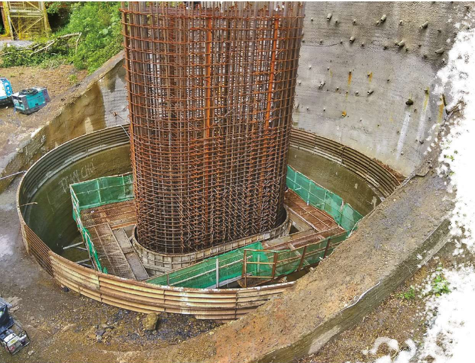
照0-49 井式基礎施工完成
