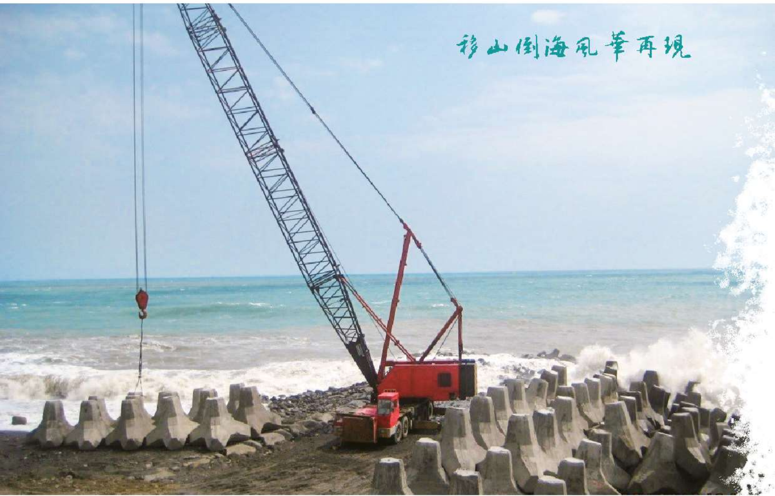
照0-11 海浪撲打下拋放南突堤之堤心石
