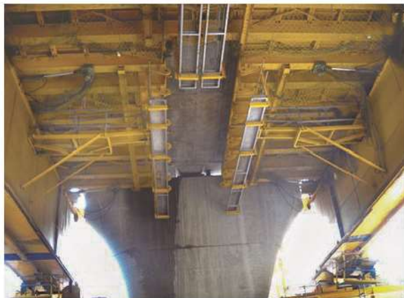
照0-73 支撐先進工法：主梁下降脫模
