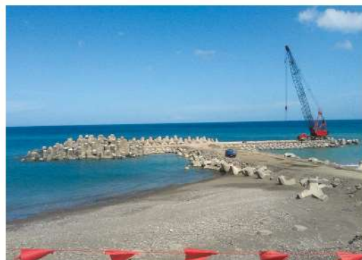
照0-10 北離岸堤消波塊吊排
