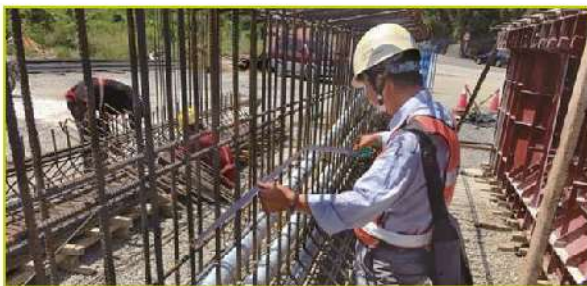
照2-08 預力梁施作
