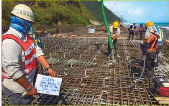
照2-22 明隧道頂板澆置
