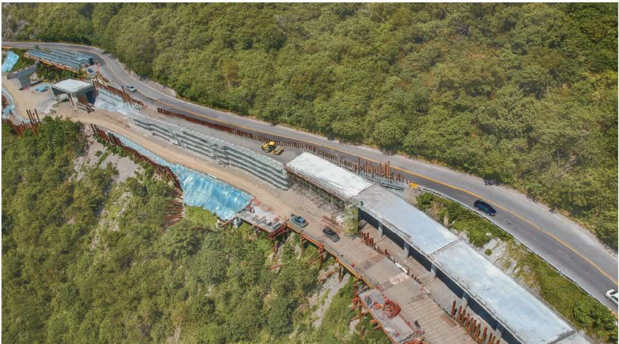
照1-09 第一階段先進行海側拓寬工程
