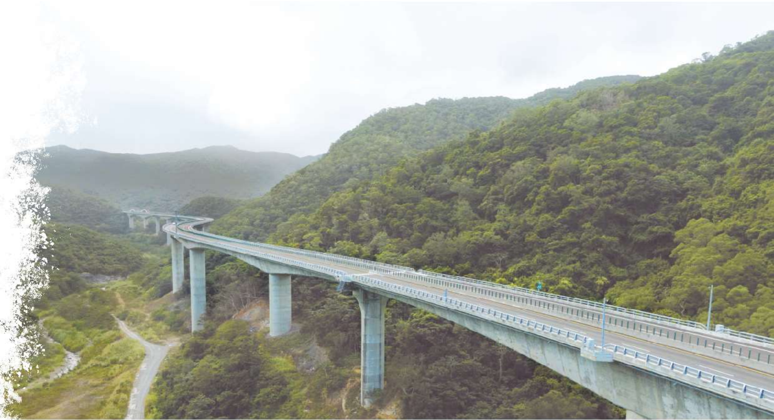
照0-08 安朔高架橋完工景
