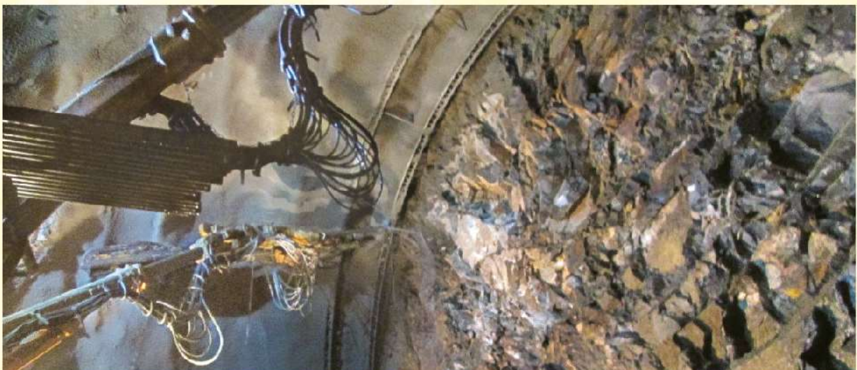
照0-97 南口南下線第86輪噴凝土施工
