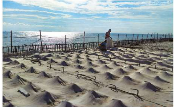
照2-24 明隧道頂板養護
