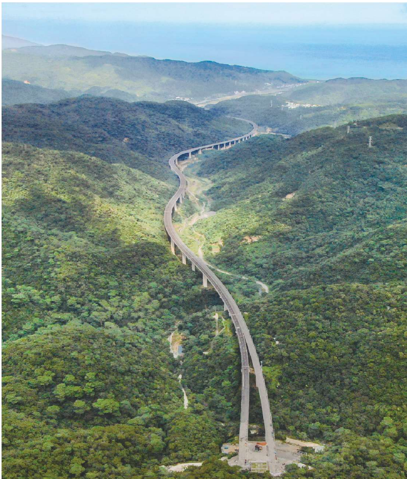
60 照0-01 安朔高架路段鳥瞰
