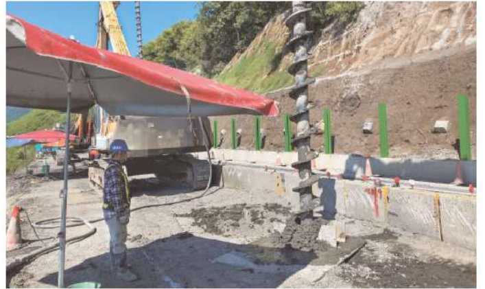
照O-15 放置套管及持續引孔
