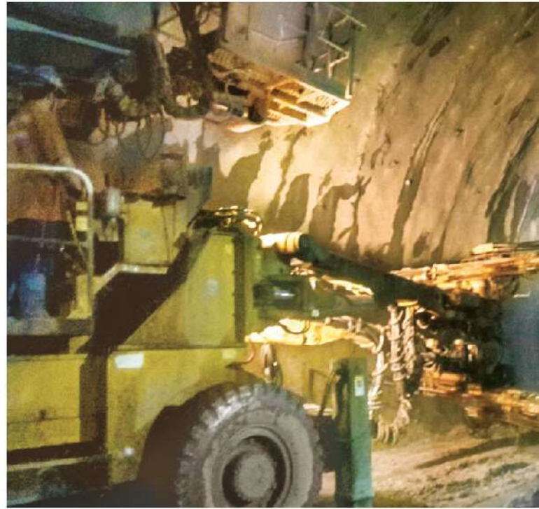
照0-100 北口南下SB176~187岩栓鑽設作業
