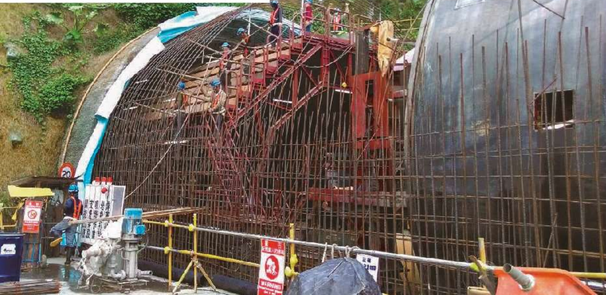
照0-101 北口南下明挖段襯砌鋼筋綁架
