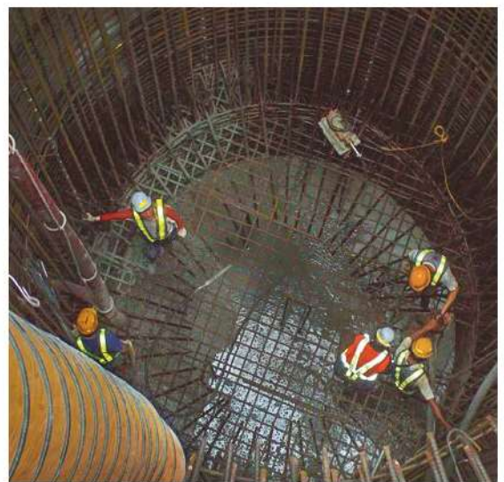
照0-39 井基板混凝土澆置
