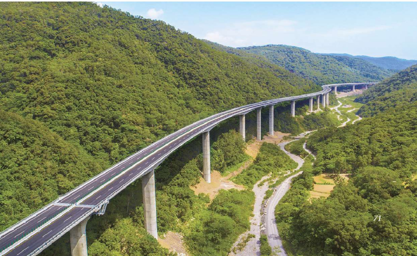
照0-19 安朔高架路段蜿蜒於山巒之間，下部結構座落溪谷河床地
