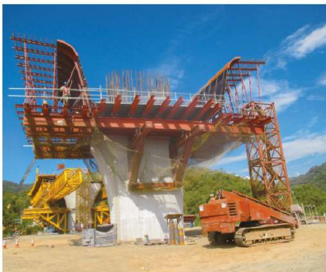
照0-55 懸臂工法：柱頭節塊底腹板外模組立
