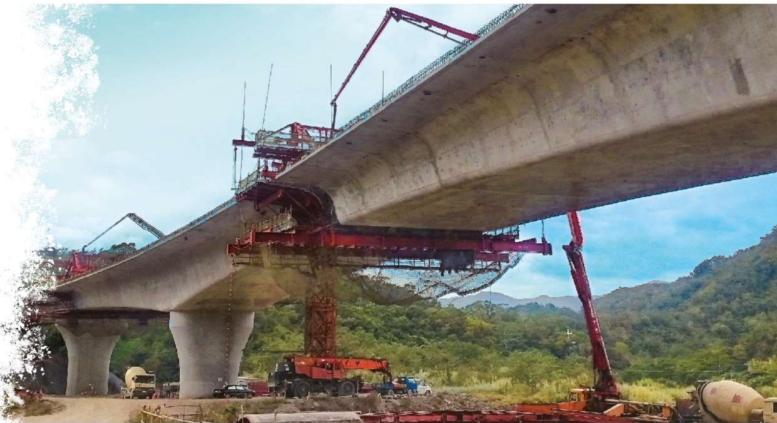
照0-64 懸臂工法：閉合節塊及邊跨節塊澆置
