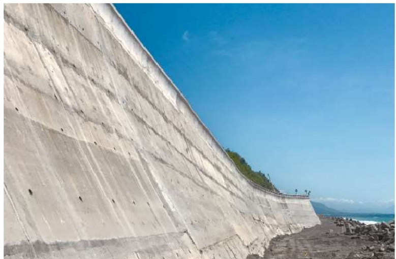
照2-18 防浪牆完工景
