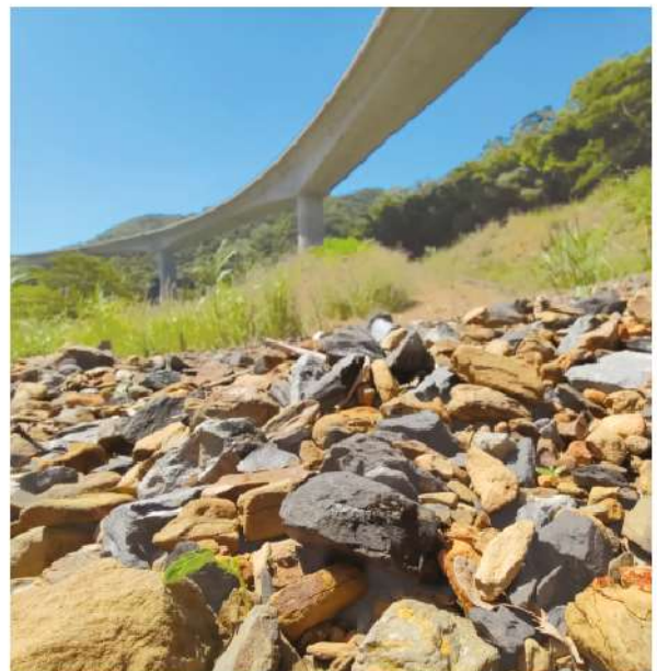
照0-10 安朔高架橋下的彩色礫石 157
