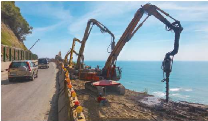
照2-46 棧橋海側擋土型鋼鑽掘引孔
