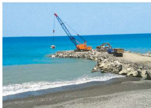
照0-08 北離岸堤左側推進
