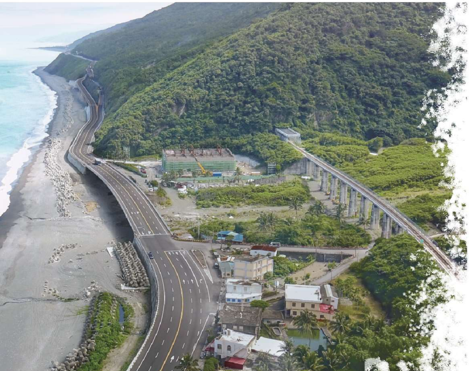
照2-36 加津林橋完工實景
