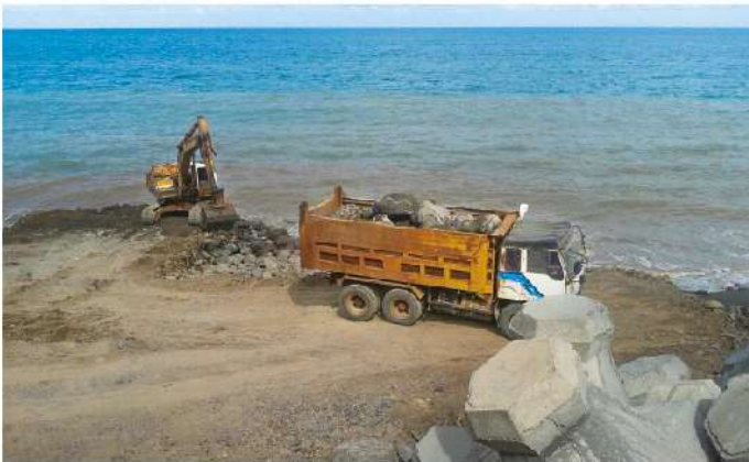
照0-12 南突堤心石填築施工便道
