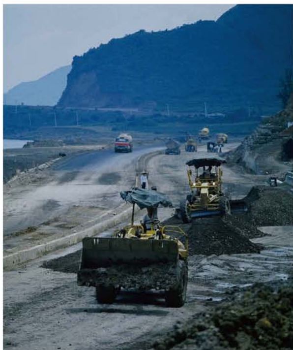
▼屏鵝公路施工，攝於民國71年。(來源：外交部)
