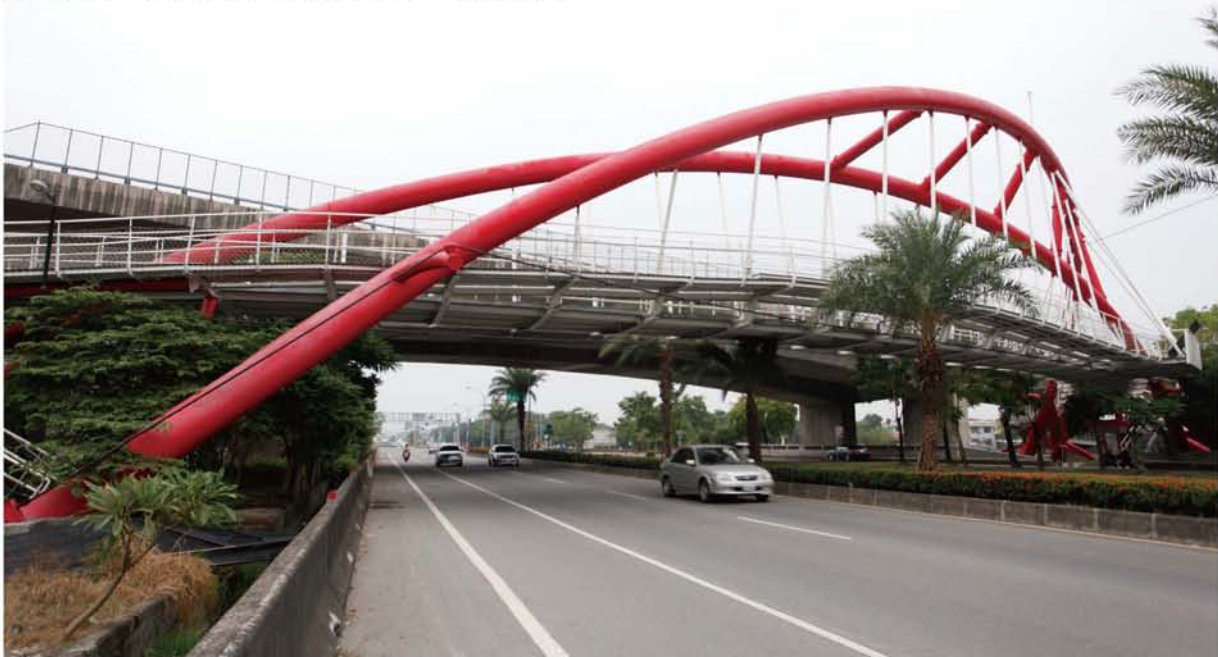
▲穿越國3後，抬頭可見一座小型鐵橋，是自行車專用道。
