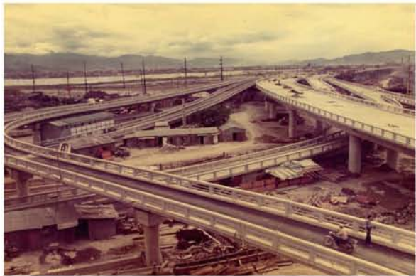
▲施工中的重新大橋。(來源：公路總局)
