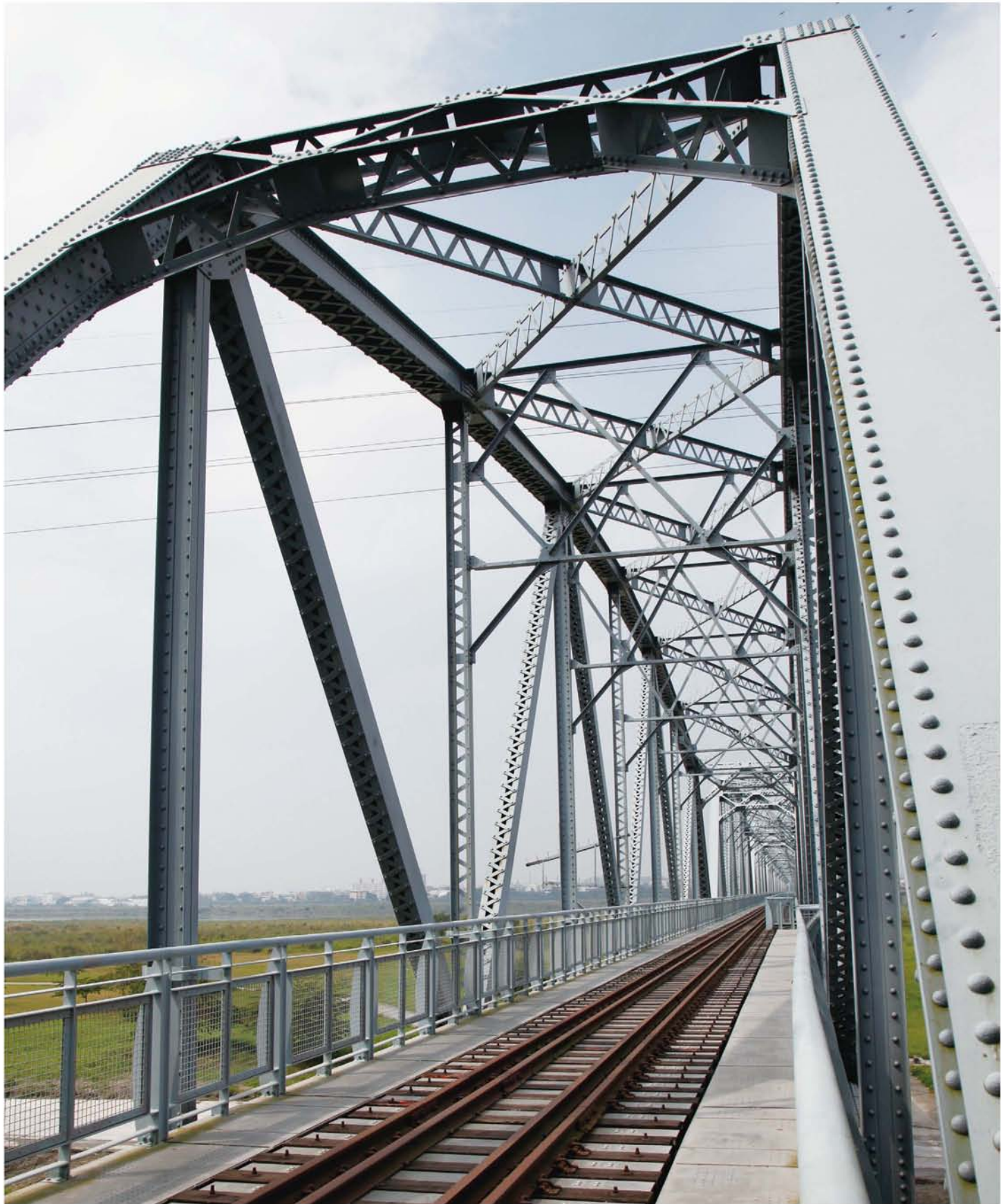
▲下淡水溪鐵橋，又被稱為舊高屏大橋，現已被列為古蹟，供人參觀。
