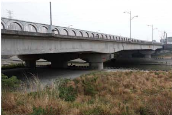
▲通霄橋不同於一般的橋梁，而是將伸縮縫改置於橋下。
