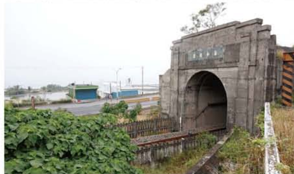
▲枋山嘉和隧道
