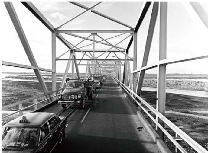
▼西螺大橋攝於民國 64 年。(來源：外交部)
