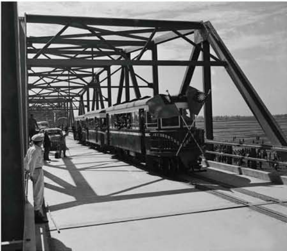
▲民國 42 年，西螺大橋正式通車，橋上設有糖業鐵路，形成鐵、公路同行的現象。(來源：外交部)
