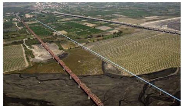
▲俯瞰舊台 1 線 - 西螺大橋與新台 1 線 - 溪州大橋。
