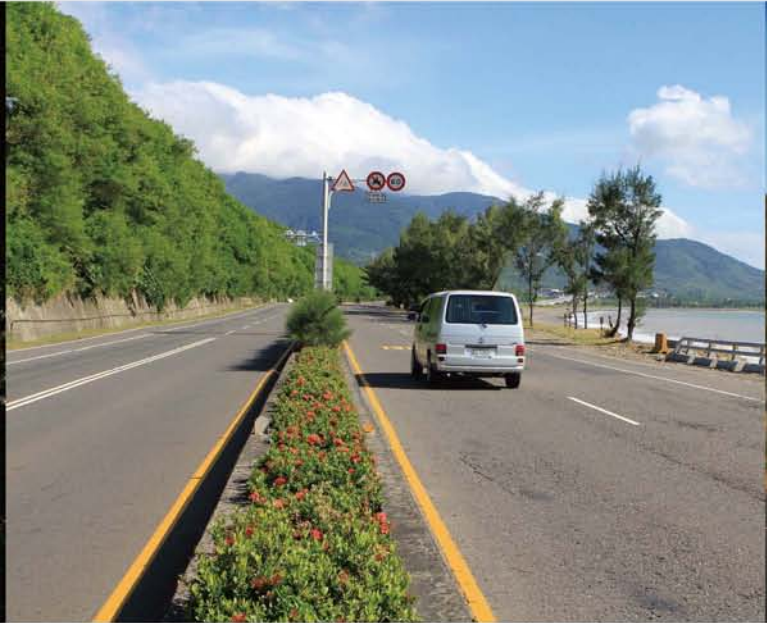
▲枋山台1線緊鄰海岸線。
