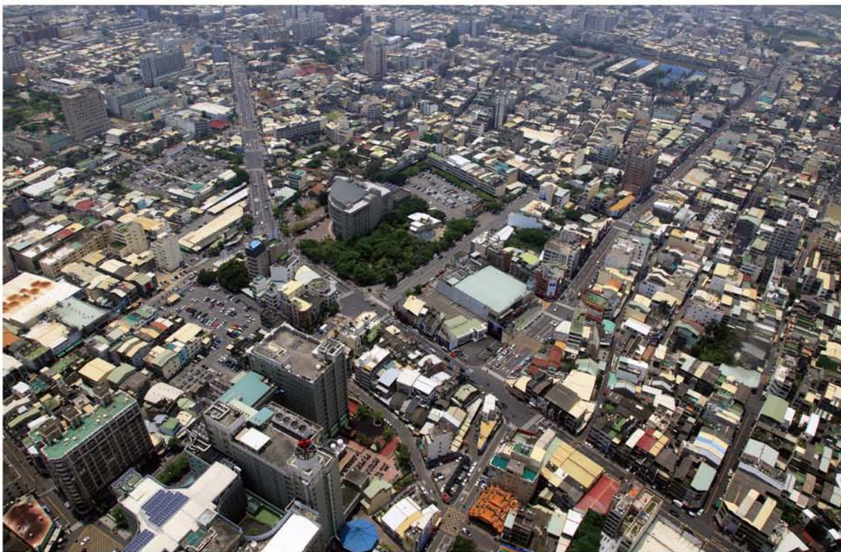
▲彰化縣因人口集中在台 1 線上，道路難以拓寬，成為全臺唯一台 1 線路段沒有中間分隔島的城市。
