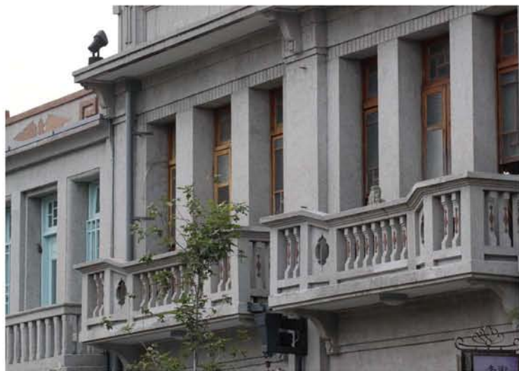
▲四柱三間的設計是典型分段隔面方式。
