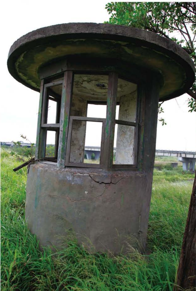
▲大甲溪橋旁的守橋碉堡。
