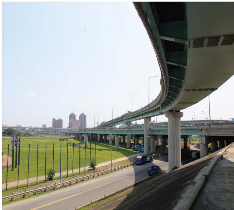
▲圖右之台1線中山橋跨越二重疏洪道，遠處為三重市區。
