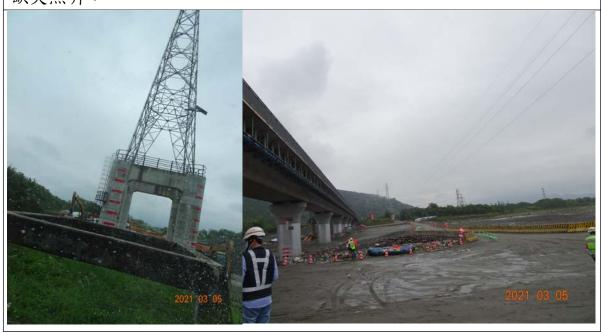
工程名稱 台 9 線 242k+592~243k+600 萬里溪橋改建工程 缺失項目 已完成之北上線橋墩防撞鋼版一處有遭撞損痕跡,主梁翼板部分表面 待修飾。
