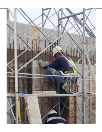
缺失項目 工地施工架置放模板、鋼材等物料。
