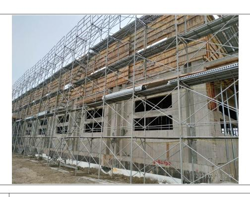
缺失項目 工地施工架交叉拉桿未確實固定。
