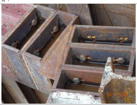
工程名稱 台 9 線 287k+000~292k+625(大禹至玉里段)道路拓寬工程 缺失項目 基礎工程護欄下鋼板及地面鋼板突出,有撞擊及絆倒之虞,請改善。
