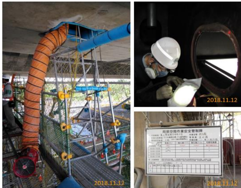
圖 8.4 箱梁下翼板開設人孔
