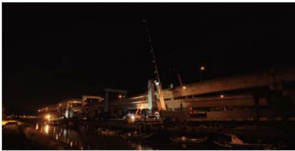
104 年 11 月 01 日 第一標鋼橋墩柱帽梁 (P43) 吊裝
