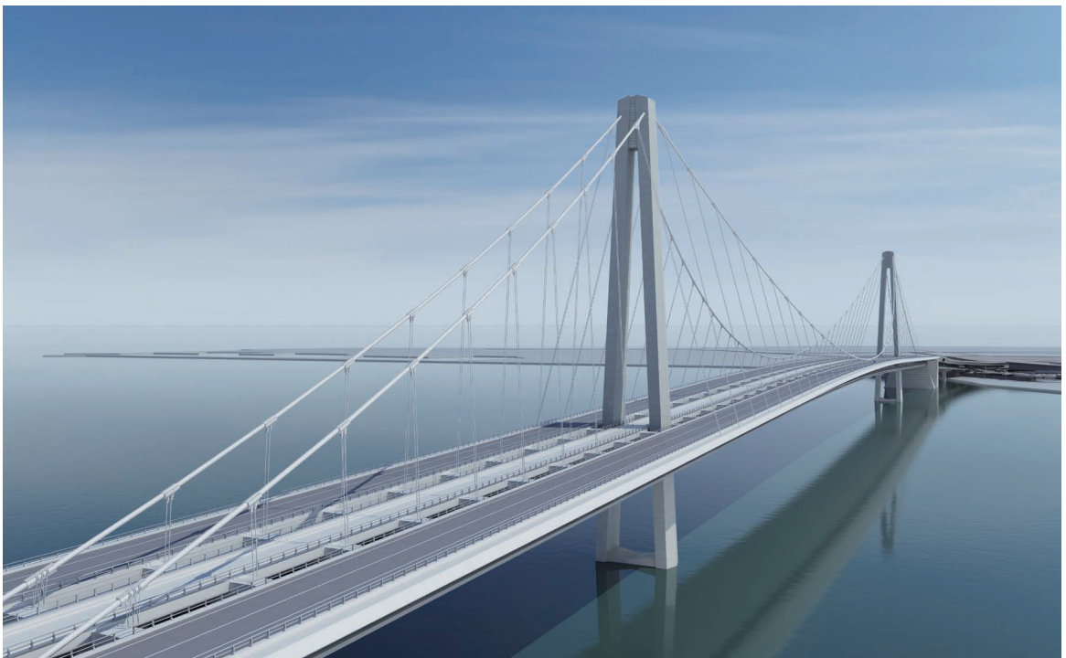
完工後將為臺灣第一座三跨連續吊橋，是現存唯一車行吊橋
