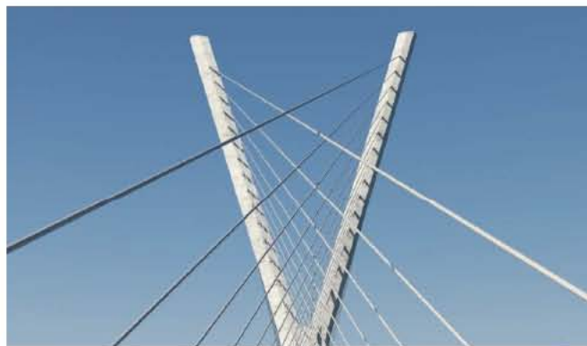
塔柱很高且為開放型 LRT 的銜接
