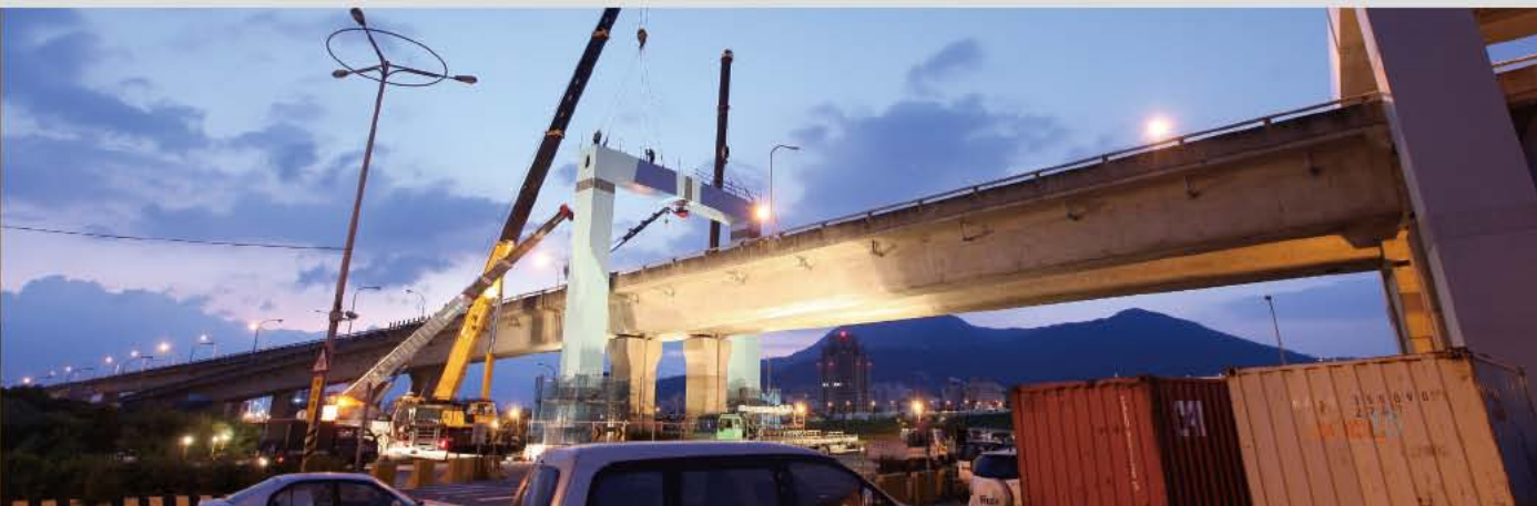
本案工程第一標 P42 墩柱吊裝
