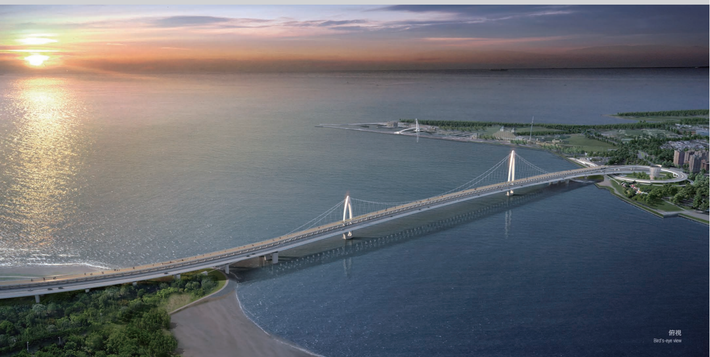
左岸高空俯視淡江大橋
