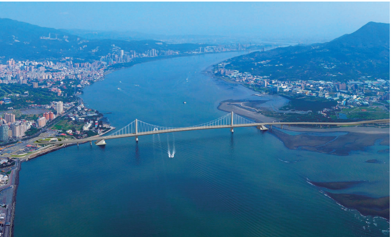
世界首創 3D 立體曲面主纜及吊索佈設 達成最佳視覺平衡與最佳經濟性目標
