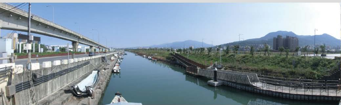
隔離水道現況
