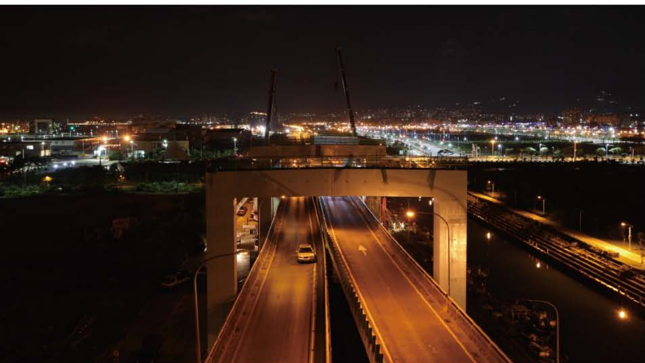
第一標工程與台 61 甲線銜接處
