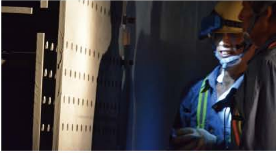
104 年 09 月 12 日 第一標鋼橋墩柱帽梁吊裝
