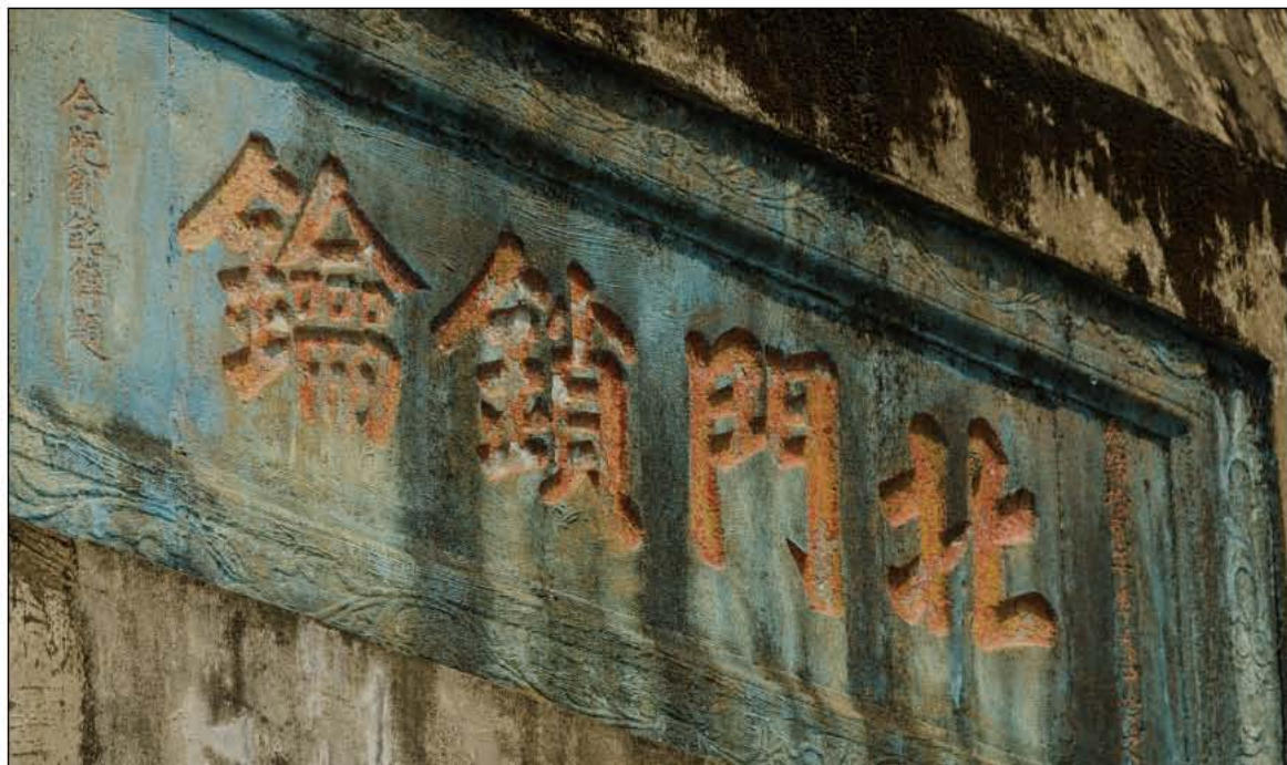
清法戰爭後設置滬尾砲台
