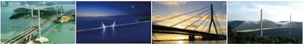
業績（依序由左到右） 汲水門大橋 / Kap Shui Mun Bridge、海口東海岸如意島跨海大橋 / Haikou East Coast Ruyi Island Cross-Sea Bridge 萊茵橋 韋瑟爾 / Rhine Bridge Wesel、巴拿馬運河第二大橋 / 2nd Bridge across the Panama Canal
