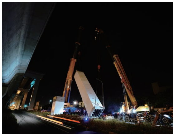
105年10月30日 P52R P55R 吊第一節鋼柱 P01
