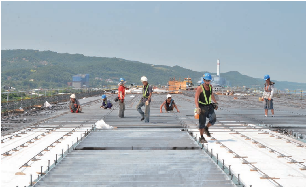
橋面板鋼筋綁紮
