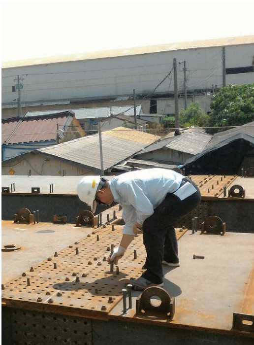
鋼構件假安裝貫穿率及阻塞率檢測
