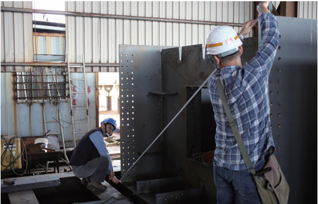
鋼構件尺寸量測
