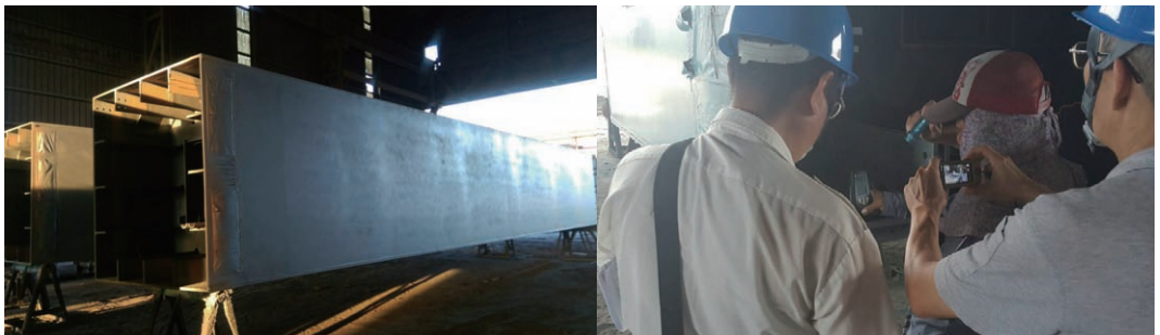
鋼構件膜厚檢測
