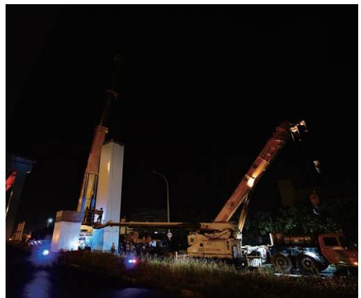
105年10月30日 P52R P55R 吊第一節鋼柱 P01
