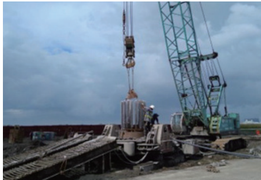
105年10月15日 基樁工程施工
