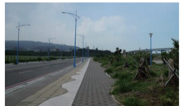
移入地點：八里區公六用地環境現況
