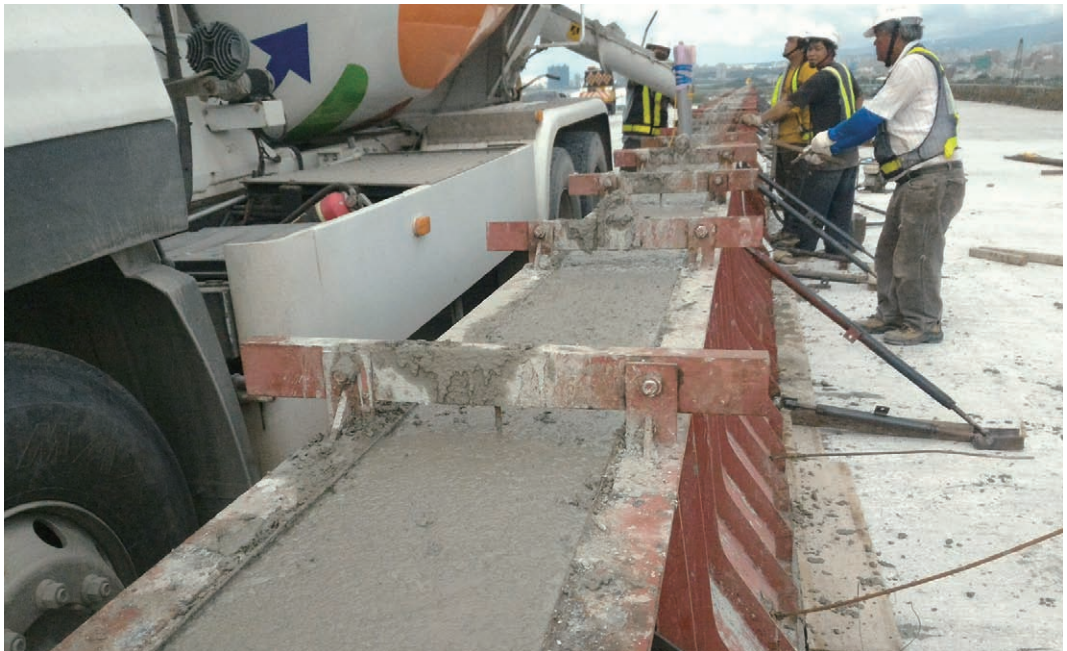
橋隔欄鋼模組立
