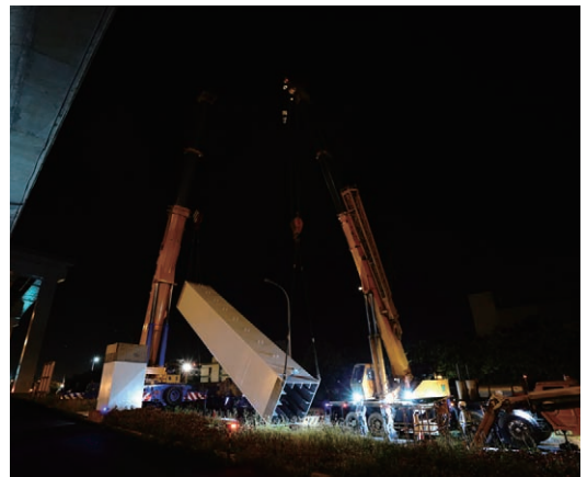
鋼構吊裝作業
