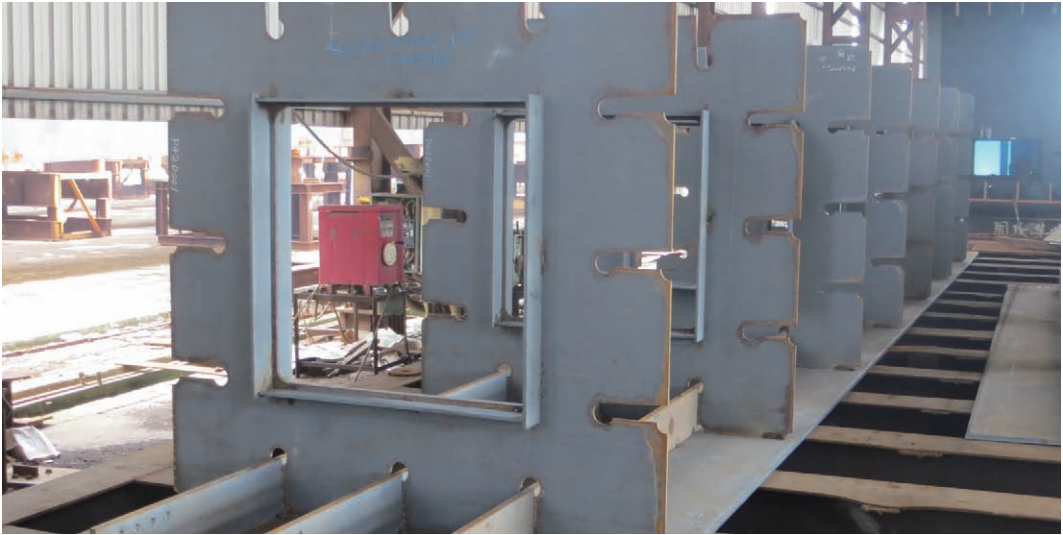
鋼構件大組立
