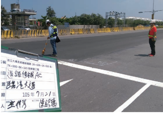
105年07月21日 道路 AC 修補數量量測
