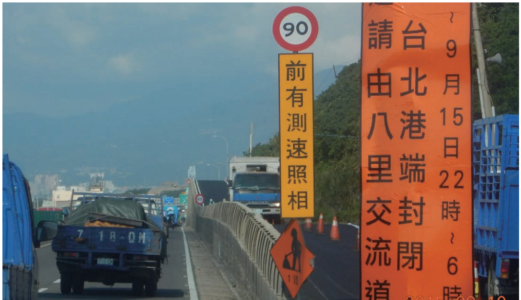
交通告示牌掛設
