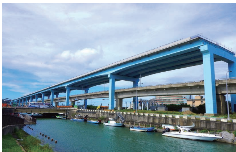
第一標全鋼結構工程
