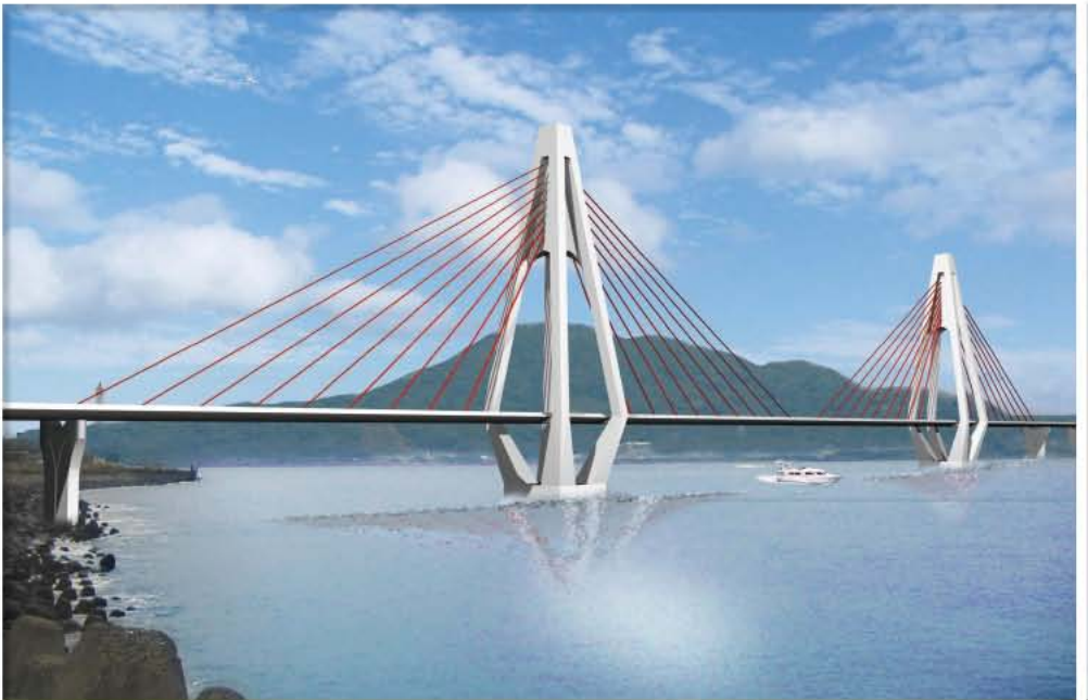
淡江大橋及其連絡道路工程規劃 (民國 87 年) - 鑽石型橋塔斜張橋橋型
