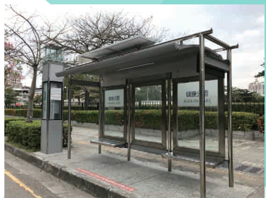
圖 4 臺中太陽能候車設施
