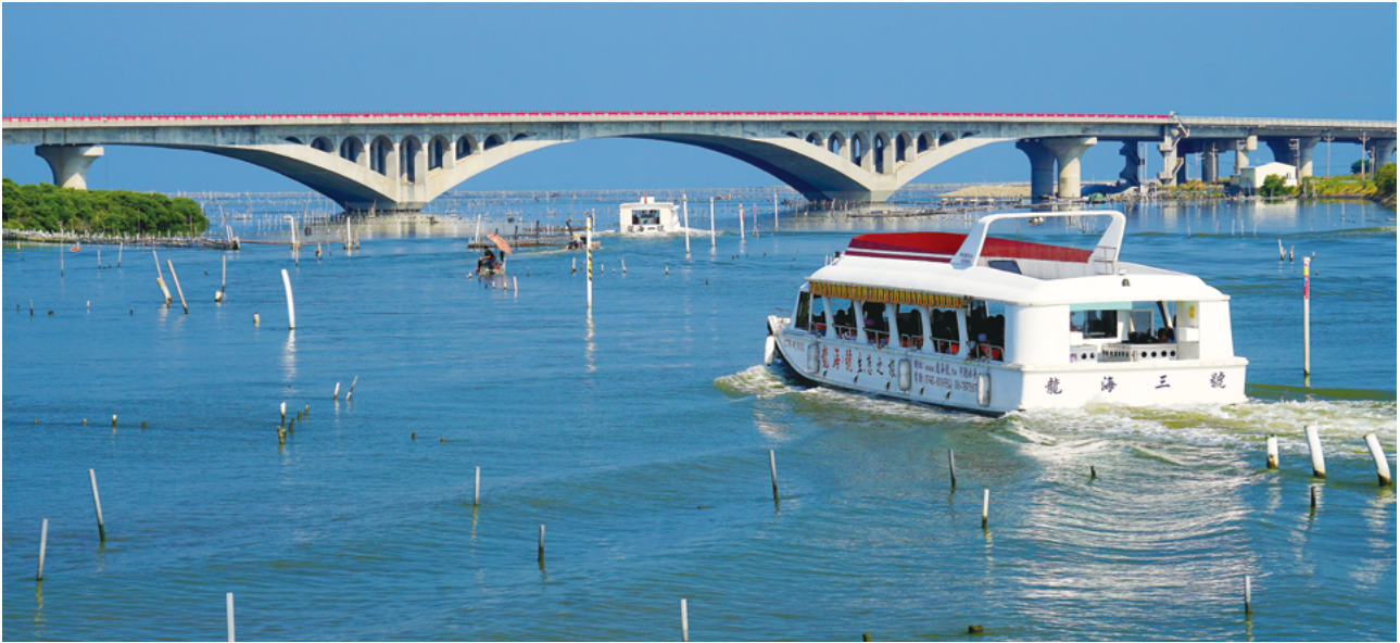
宏偉壯闊的七股溪橋位於西濱公路台6線298k處
