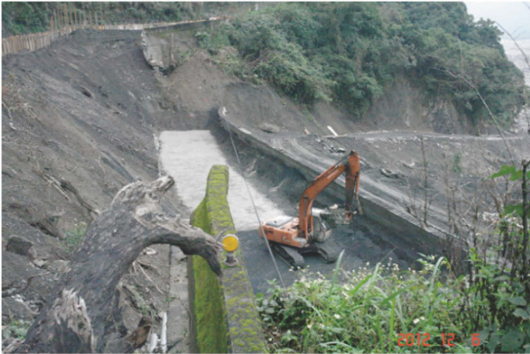
● 台 7 甲線 2K+600 擋土牆施作情形
