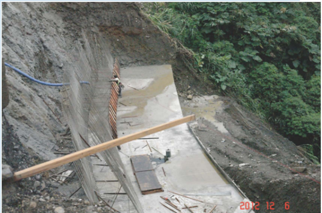
● 台 7 甲線 18K+000 擋土牆施作情形
