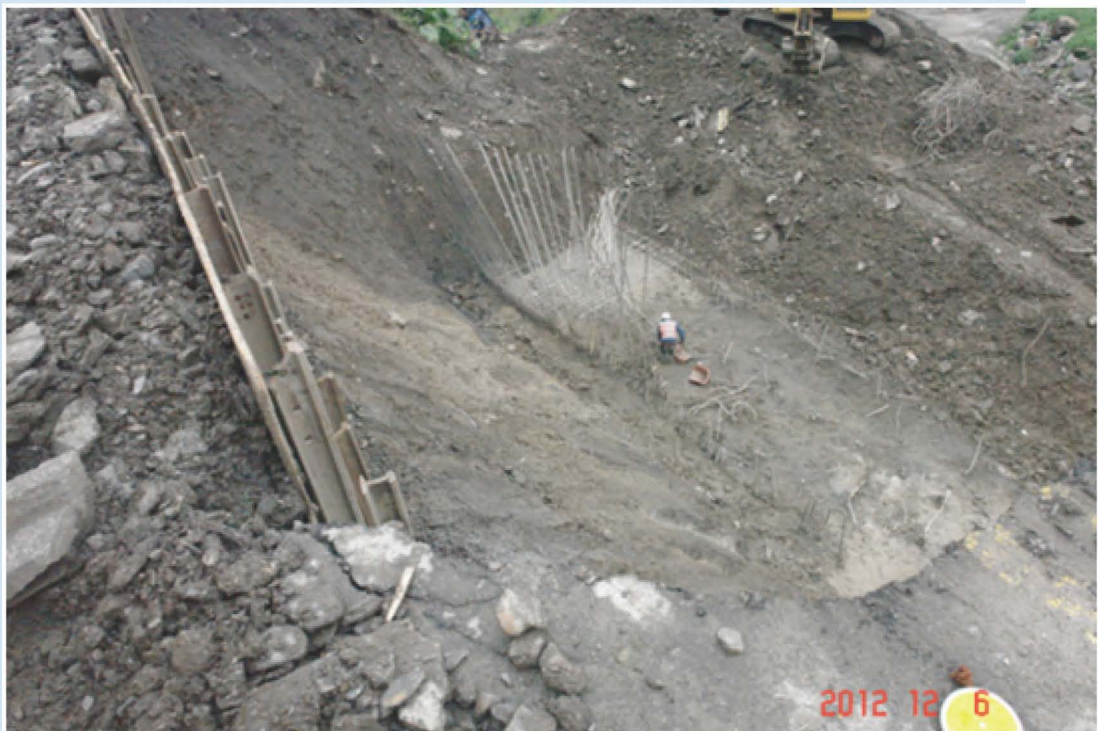
● 台 7 甲線 17K+050 擋土牆施作情形
