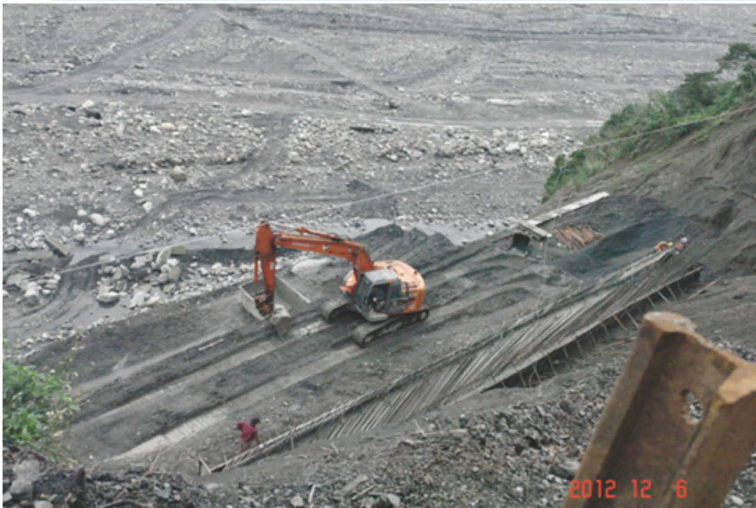
● 台 7 甲線 1K+700 擋土牆施作情形
