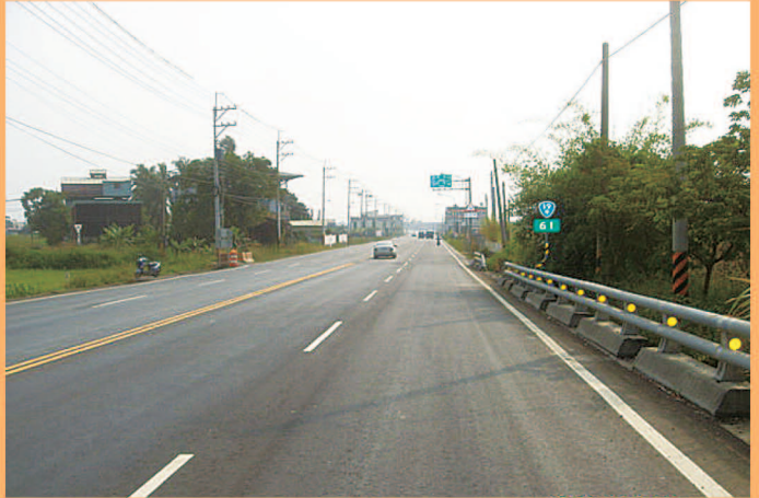
台19甲線61K+372~62K+339路基路面拓寬工程
