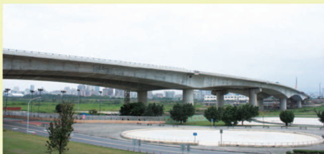
跨越大漢溪懸臂工法橋
