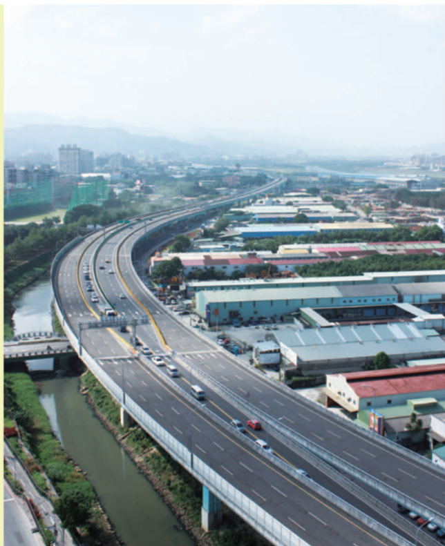
浦仔溝路段高架橋
