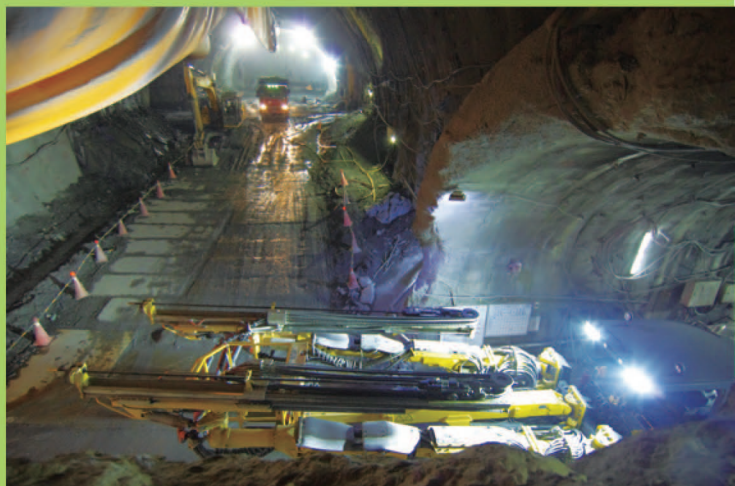
隧道施工狀況
