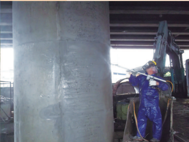
華江橋耐震補強工程（混凝土墩柱進行水刀處理）
