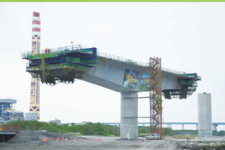
南澳至和平段橋梁工程
