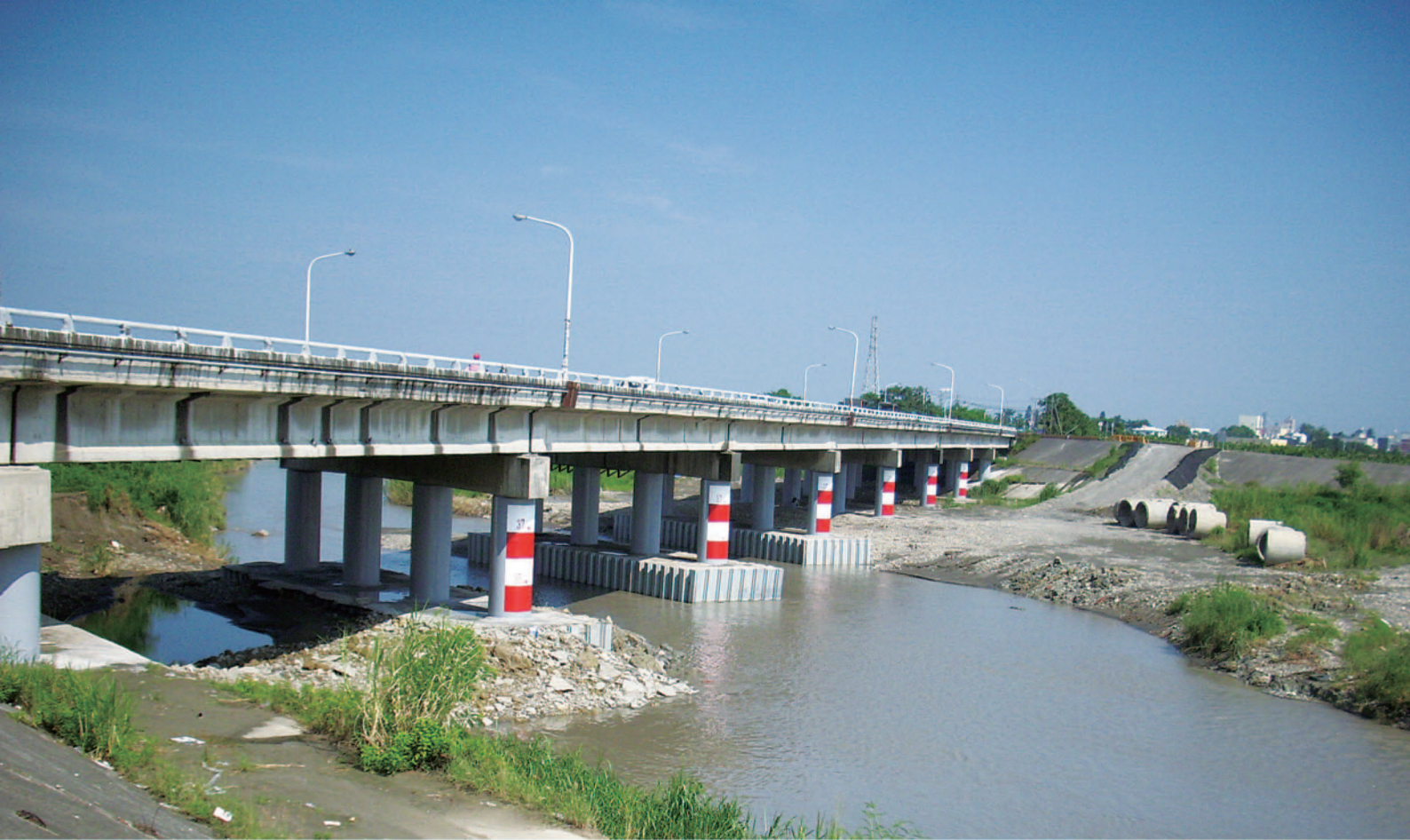
台1線新榮橋耐震補強工程（鋼板包覆補強以增加耐震能力）
