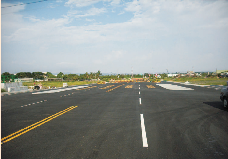
臺南市台19甲線33K+980~35K+580段（第一標）外環道新闢工程
