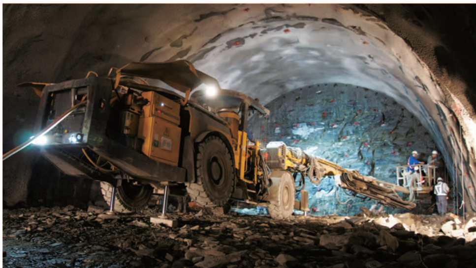
觀音隧道施工情形
