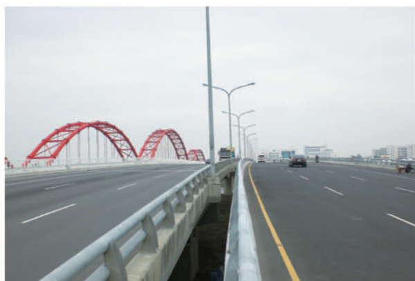
配合二仁溪治理計畫進行台1線340K+110二層行橋全橋改建
