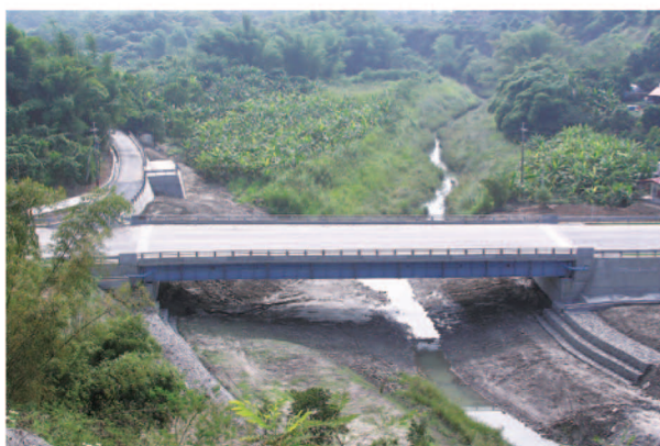
配合曾文溪支流菜寮溪治理計畫進行九空橋全橋改建
