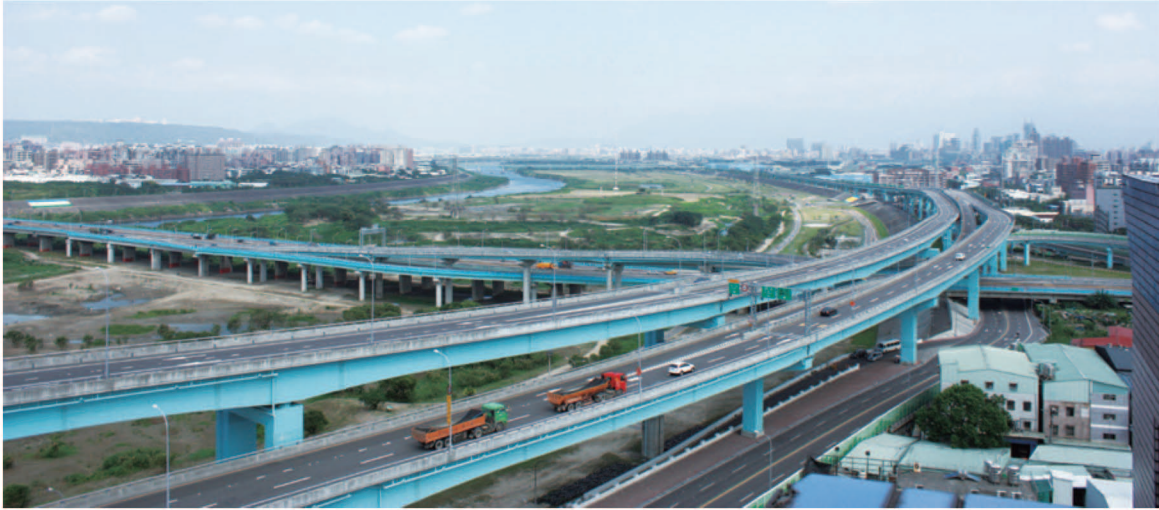
土城段鋼構高架橋
