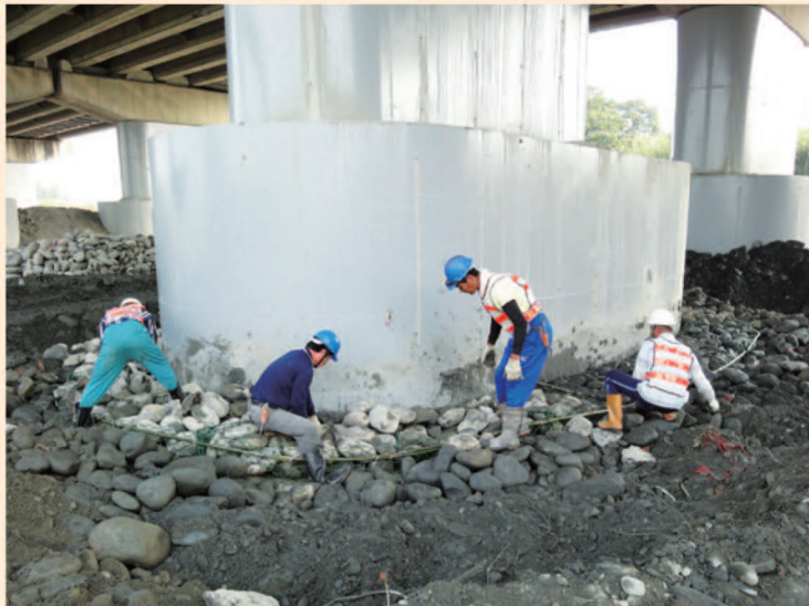
虎尾溪橋耐震補強工程（橋墩拋石固床工施作）
