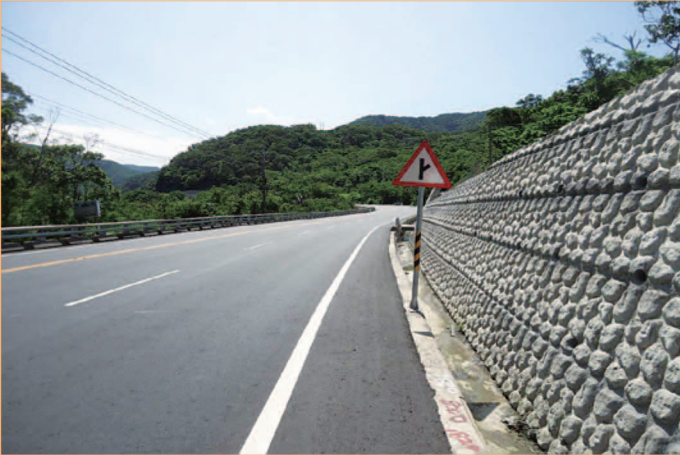
台9線466K+300~467K+050(舊樁號480K+220~480K+970)路 基路面拓寬工程
