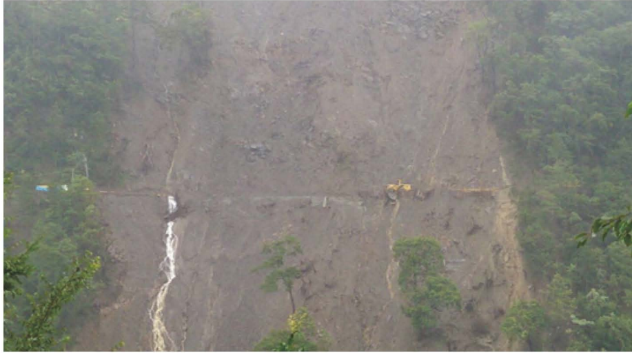
圖 6- 8 台 8 線 93K+300 南投縣仁愛鄉碧綠溪道路邊坡坍方
