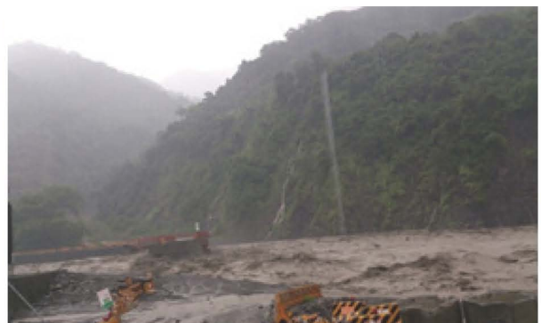
圖 7- 22 台 20 線 093K+783 橋梁，橋梁引道流失。
