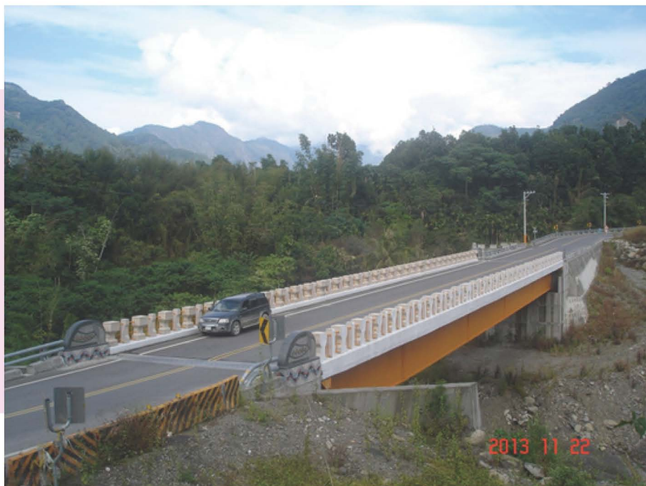
圖 6-16 達卡努瓦橋完工後現況
