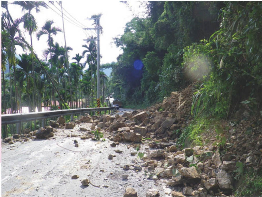
圖 6-12 台 16 線 22K~36K 落石坍方
