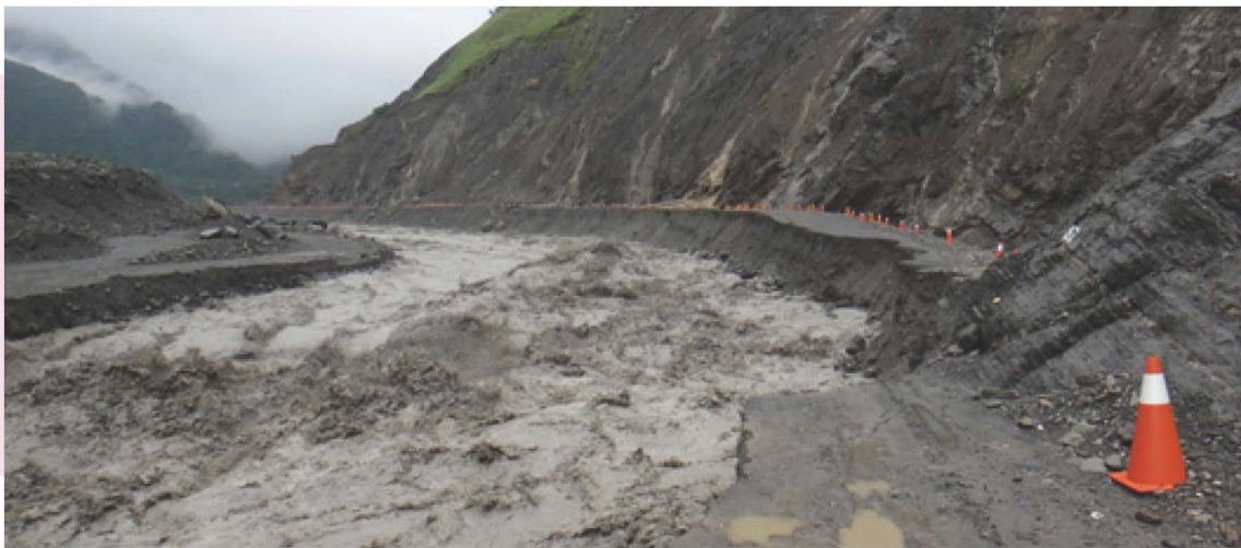
圖 6- 1 台 20 線勤和溪底便道預警性封閉後致災
