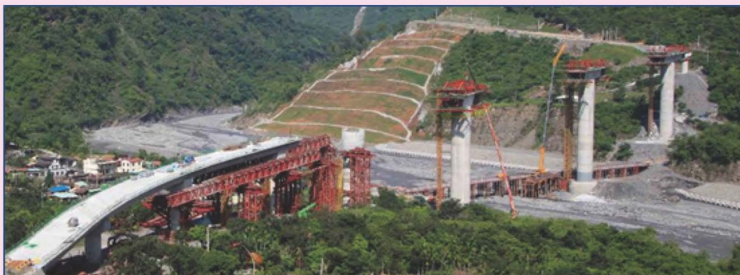
圖 6- 18 霧台谷川大橋施工中照片
