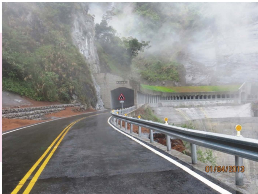
圖 6- 15 栓兒明隧道完工後現況
