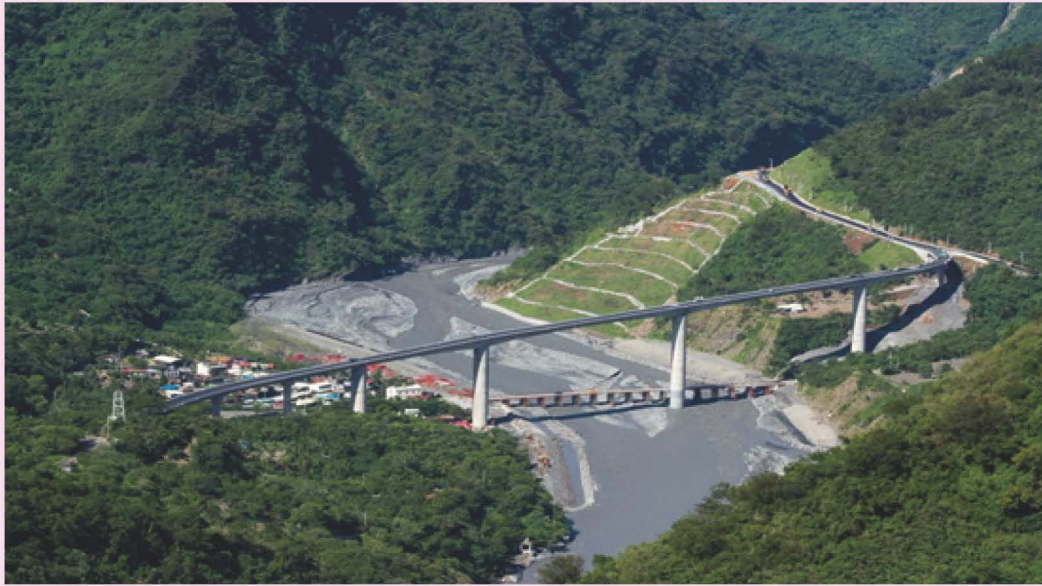
圖 6-19 霧台谷川大橋完工後全景
