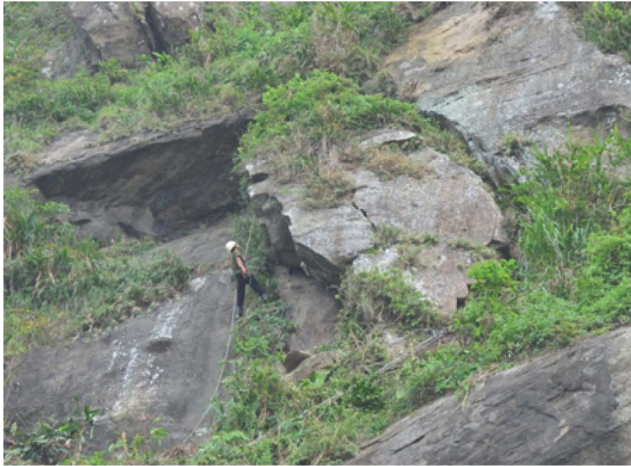
圖 6- 10 台 2 線 82K+200 路段邊坡危石移除作業 ( 一 )
