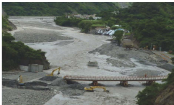
圖 7- 22 台 20 線 093K+783 橋梁，橋梁引道流失。
