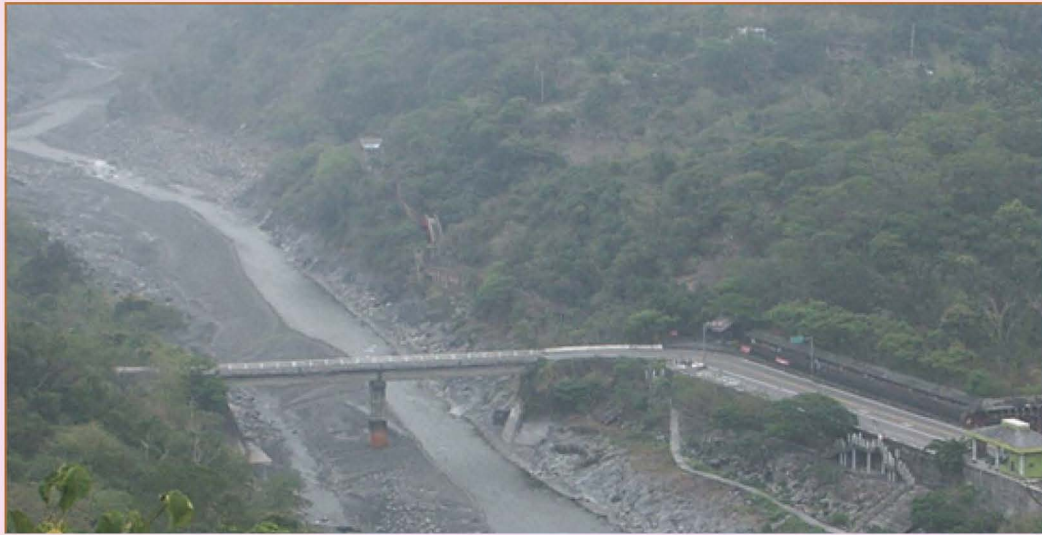
圖 6- 17 霧台谷川大橋 (原名第一號橋) 受災前舊橋全景
