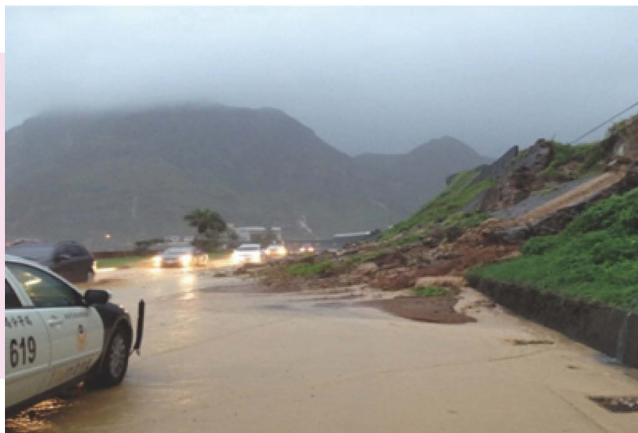
圖 6-7 台 2 線 75K+000~84K+000 邊坡落石
