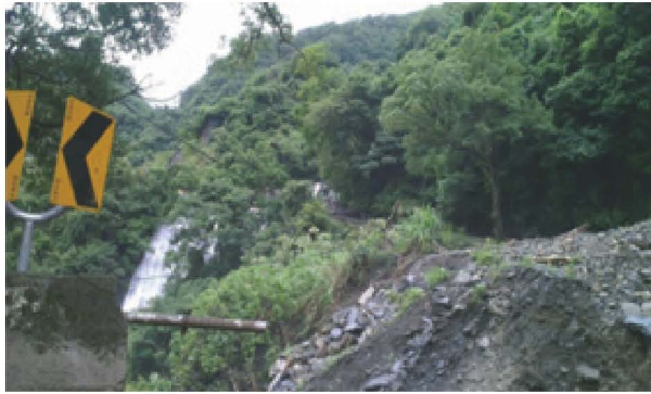
圖 7- 18 台 7 線 22K ~ 61K 多處坍方道路中斷，道路邊坡坍方
