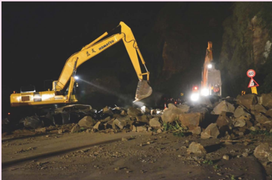
圖 6- 11 台 2 線 82K+200 路段邊坡危石移除作業 ( 二 )
