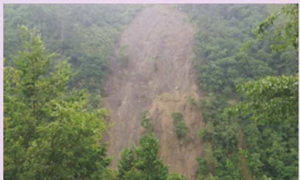
圖 7- 20 台 8 線 93K+300 道路邊坡坍方
