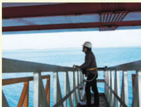
澎湖跨海大橋使用橋檢車辦理檢測
