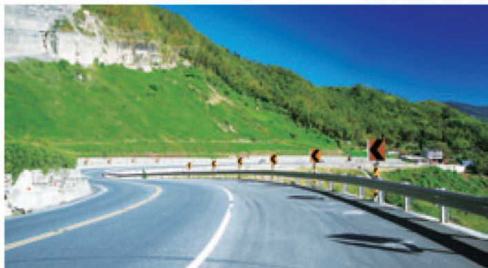
台18線59k復建完成
