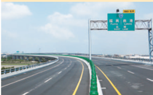
西濱快速公路彰化縣福興至王功路段現況
