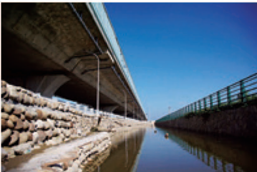
北門玉井線E707-3標工程
