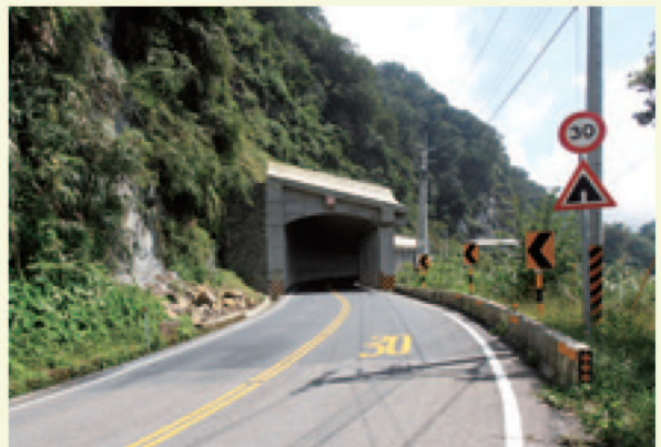
台18線79.9k明隧道施作完成
