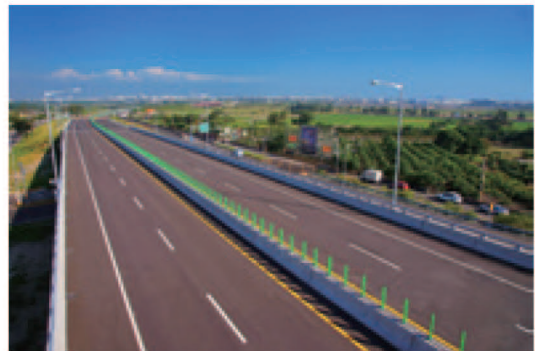
臺南關廟線C821標工程
