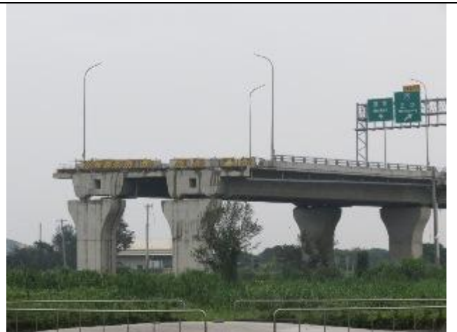
計畫道路尚未施工
