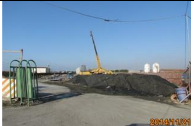
進入施工階段(11月)
