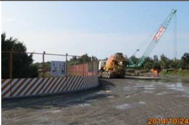
進入施工階段(10月)
