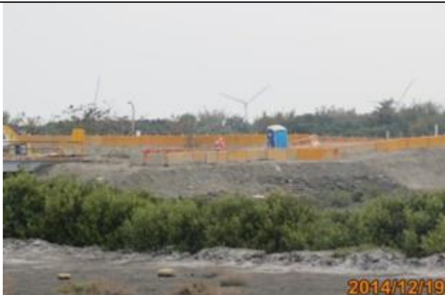
進入施工階段(12月)
