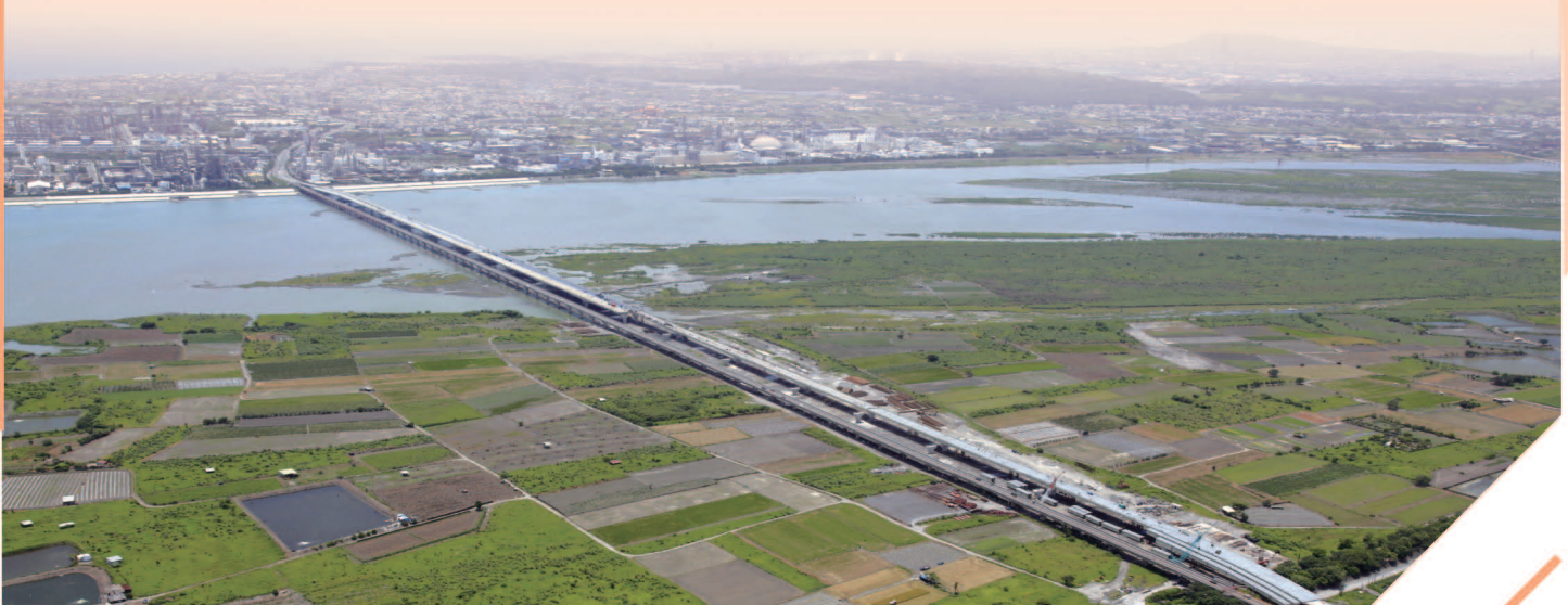
台17線高雄 屏東雙園大橋（莫拉克風災復建工程）
