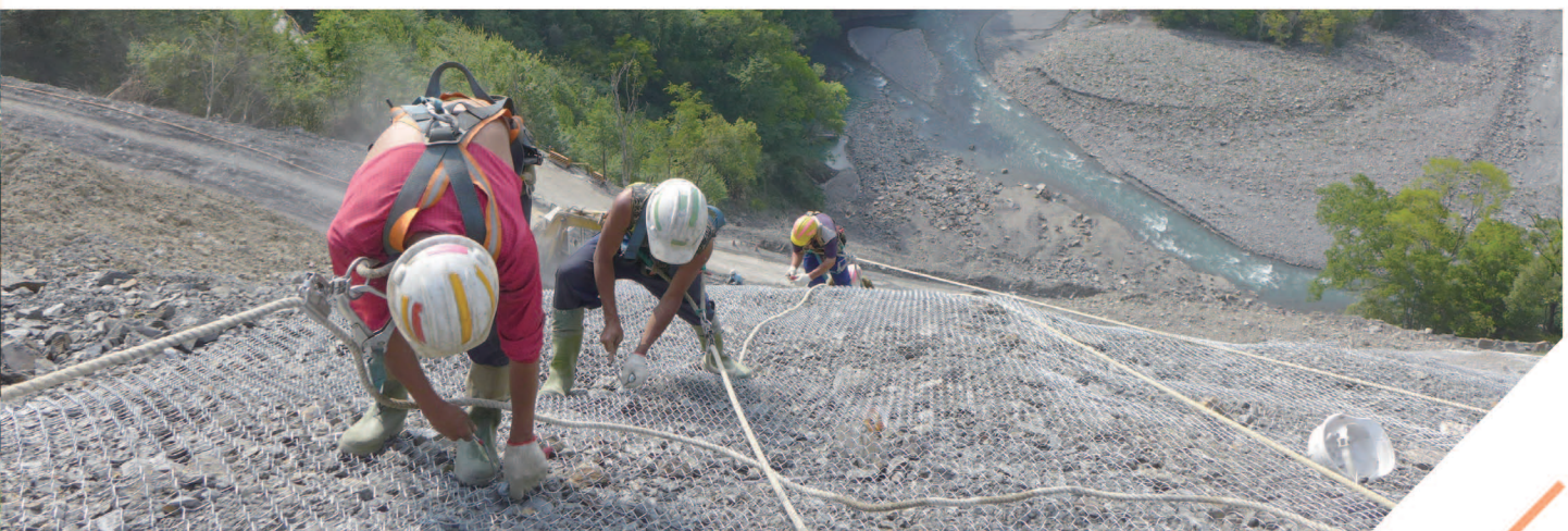
台7甲線邊坡掛網
