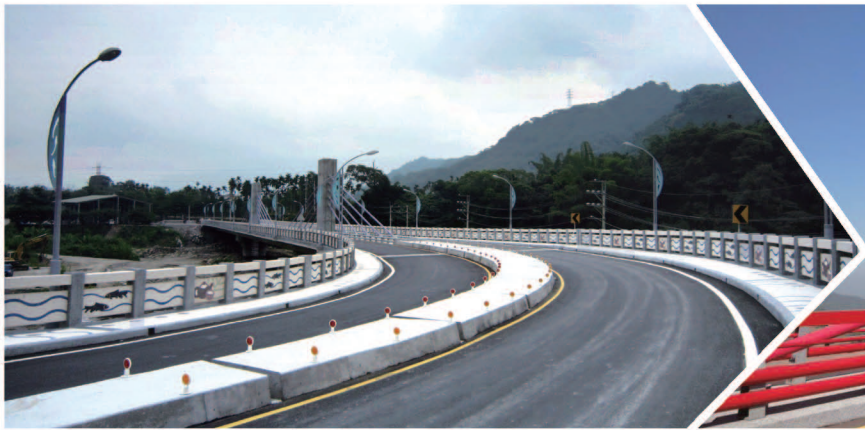
南投縣「131線43K+145~43K+600（含清秀橋）道路及橋梁拓寬改善工程」
