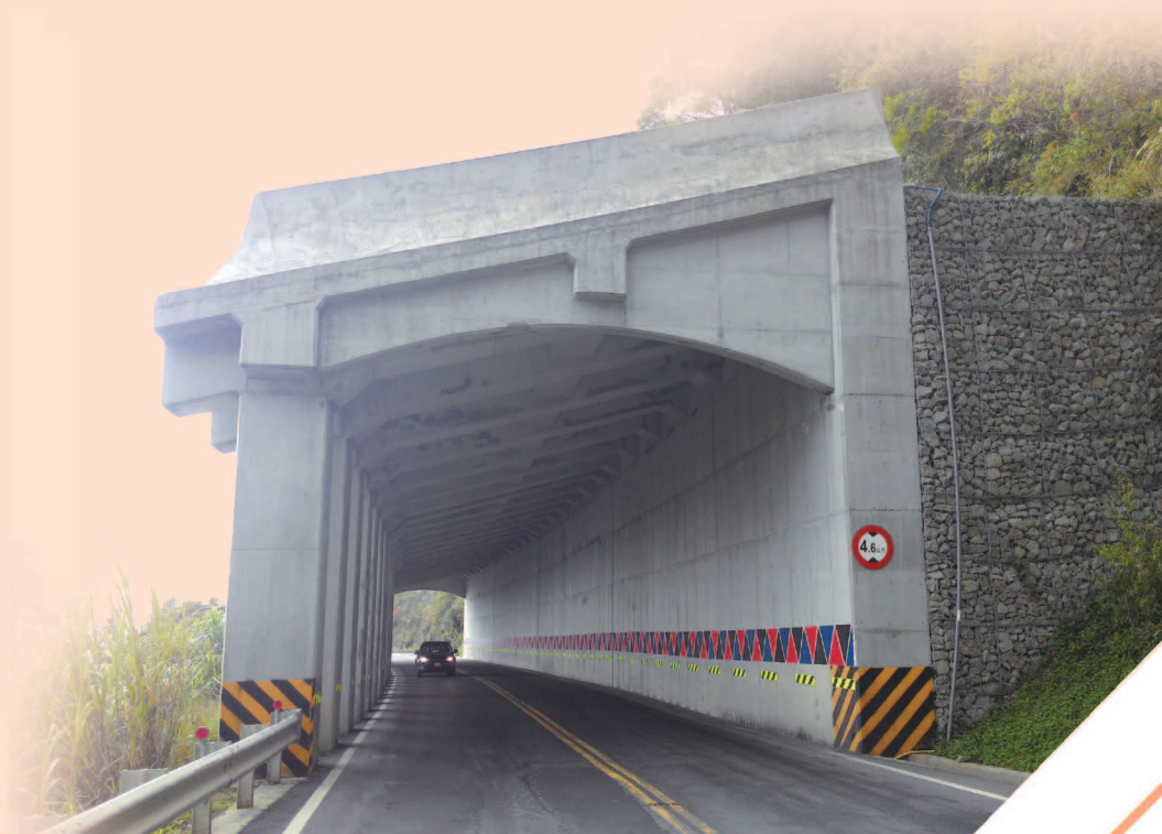
台18線70k+835~70k+915#2明隧道
