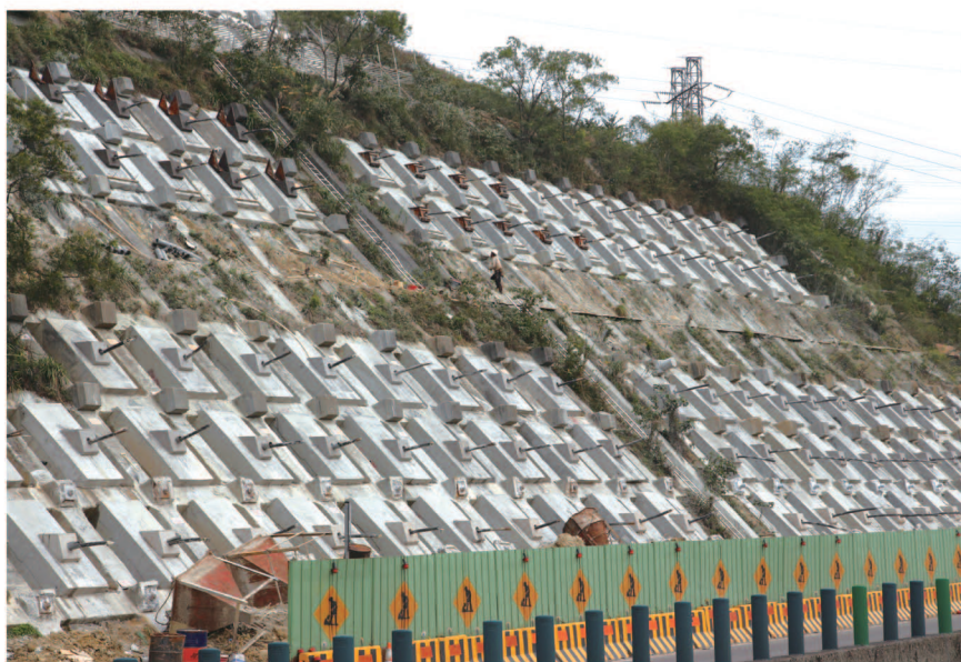
台62線7K+140~7K+760順向坡補強
