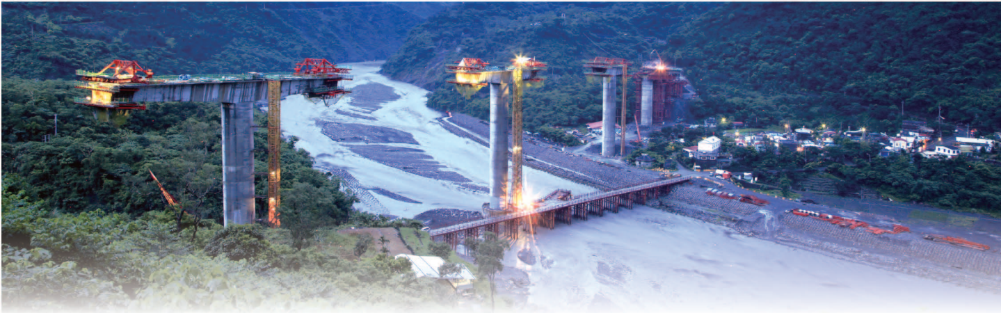
台24線屏東霧台谷川大橋 挑燈夜戰（莫拉克風災復建工程）
