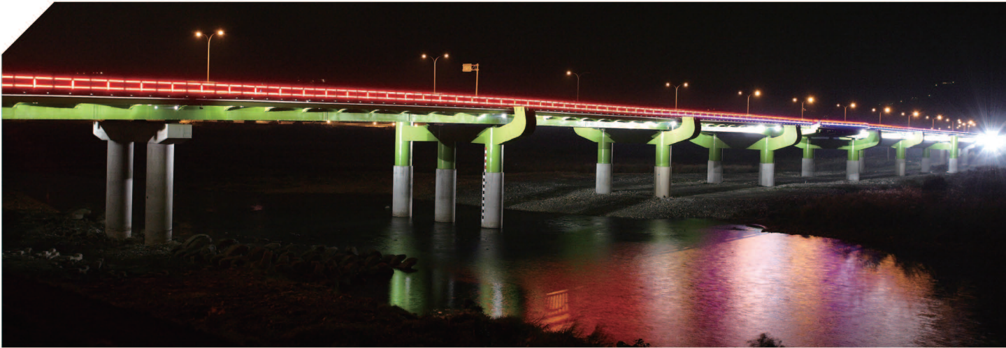
新北市「柑園二橋新建工程」
