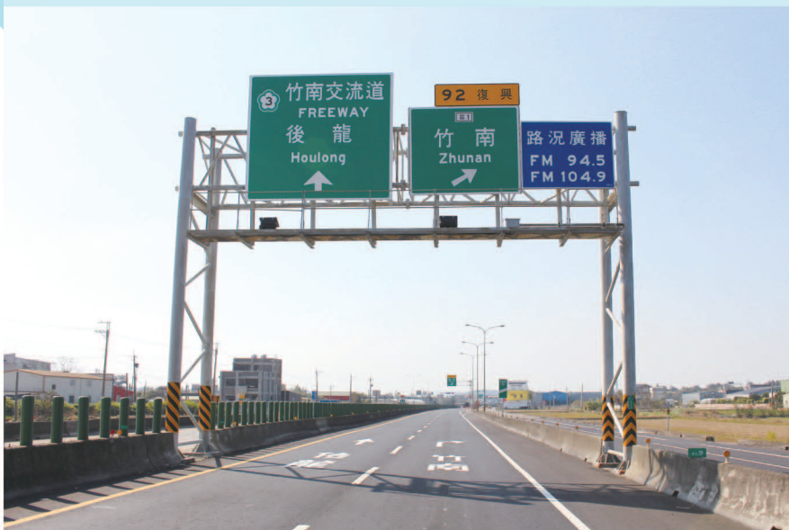
南下91K+900：交流道名稱標誌+快速公路出口預告標誌+地名方向指示標誌+地名方向指示標字
