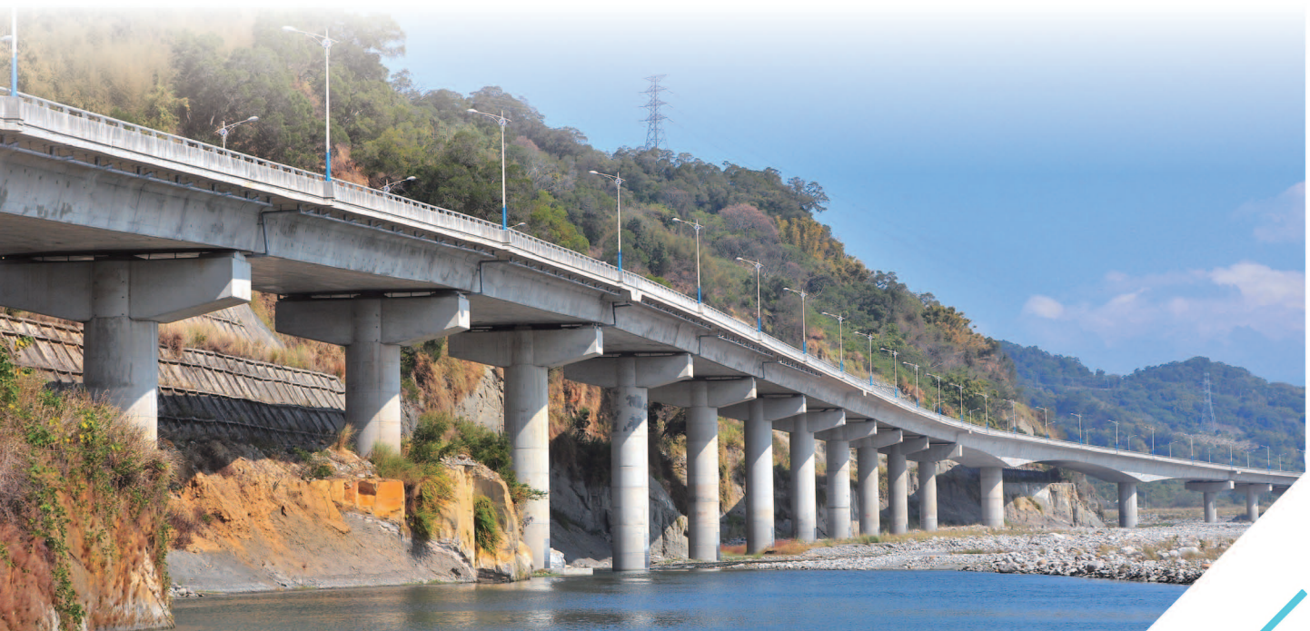
苗栗縣「大安溪卓蘭至三義聯絡道路新闢工程」
