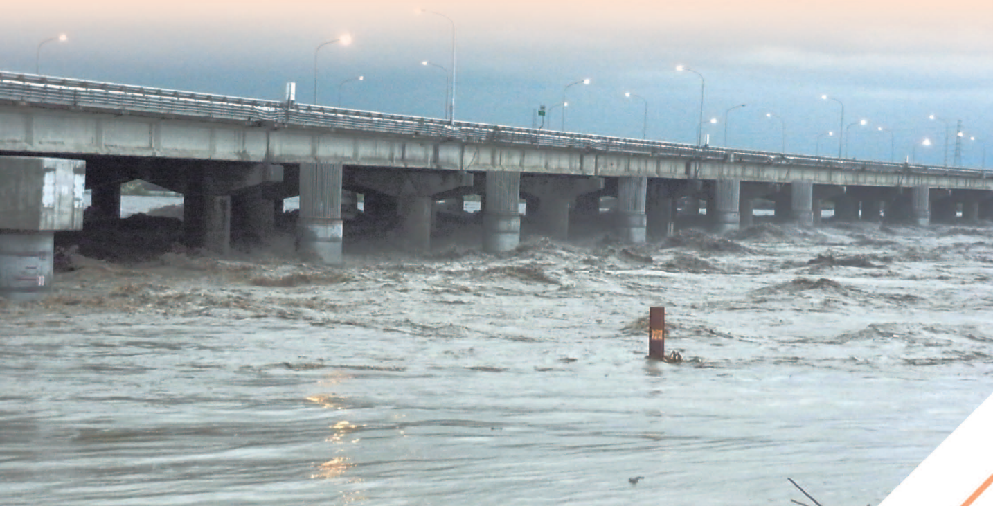
施工期間洪水侵襲，淹沒工區
