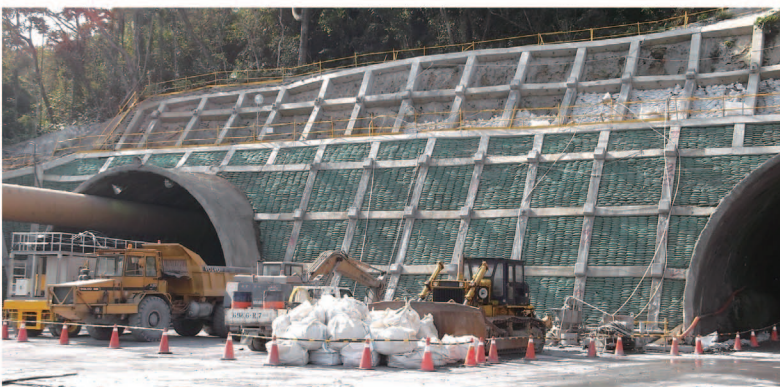
北口格框護坡植生袋鋪設現況
