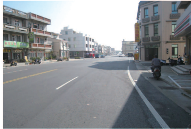
澎湖縣「202號線（7K+143~11K+273）（湖西—龍門段）路基路面拓寬工程」
