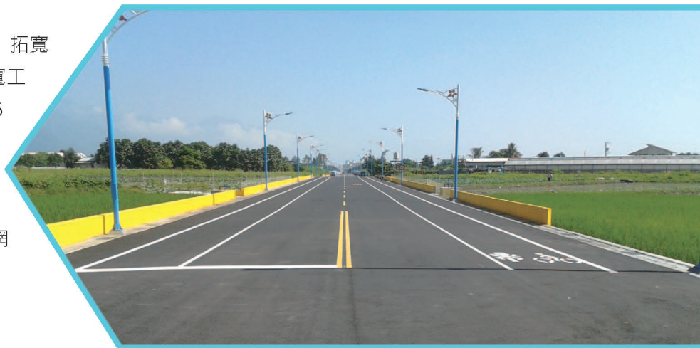
花蓮縣「吉安鄉中正路（花29線）南段道路拓寬工程」
