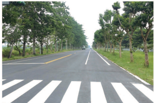
屏東縣「屏37線道路拓寬工程」
