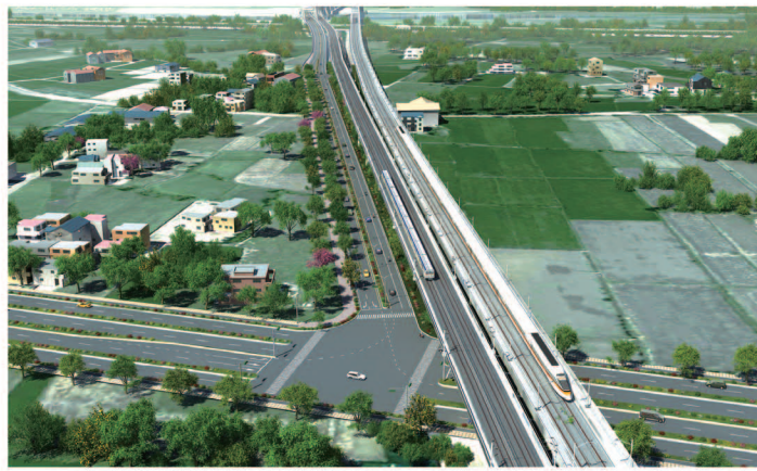
新竹縣「高鐵橋下聯絡道延伸至竹科工程〈至公道五段〉」
