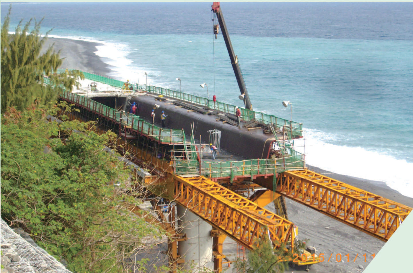
多良U2-2 (P6-P7) 箱型梁鋼筋綁紮
