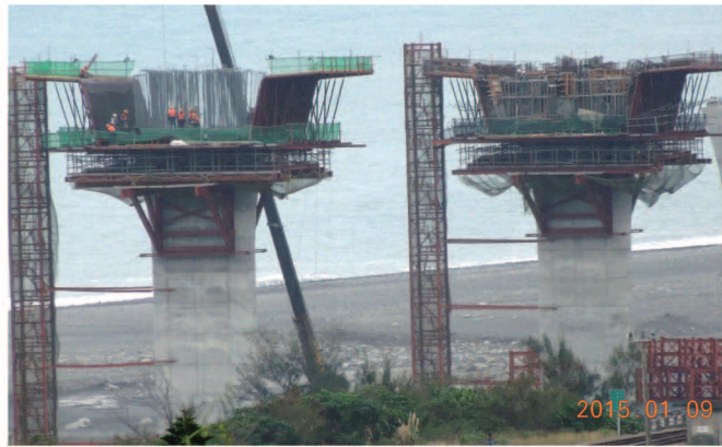
金滿P9-P10柱頭節塊鋼筋綁架及內模支撐搭設
