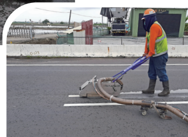
水刀施工情形 ▶
