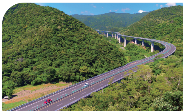
台 9 線南迴公路安朔高架橋
