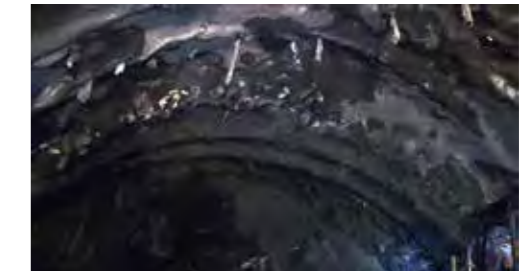
南口南下線-片岩區剪裂帶6k+100~80中央頂拱小坍落
