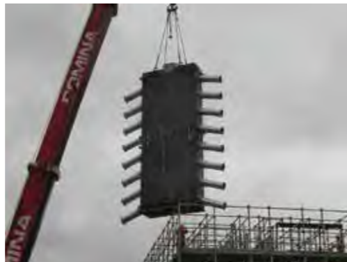
鋼殼現場吊裝
