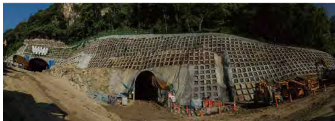
洞口邊坡保護工程
