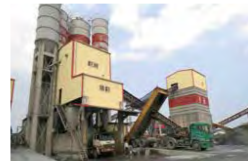
104年1月23日 享正、久屋混凝土廠（A1標供應商）
