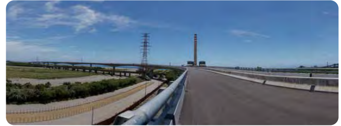
B4標和平溪橋全景
