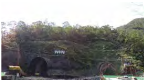
東澳隧道南口
