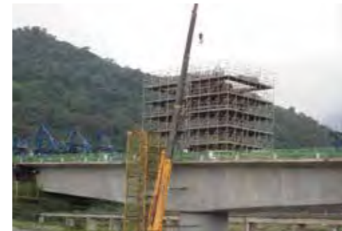
北溪橋P1橋塔第三昇層鋼模吊裝、實固架吊裝
