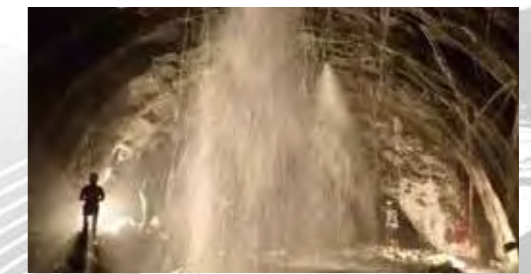
南口南下線-片岩區剪裂帶6k+330~317大理岩大湧水
