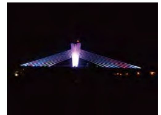
南澳北溪橋P2橋塔春節期間設置夜間七彩投射燈
