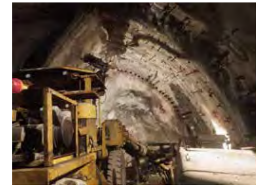
海側導坑管幕施工
