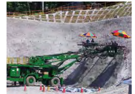
隧道進洞於上半部鑽設管幕
