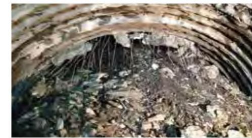
南口南下線-片岩區剪裂帶6k+187~150大規模抽坍
