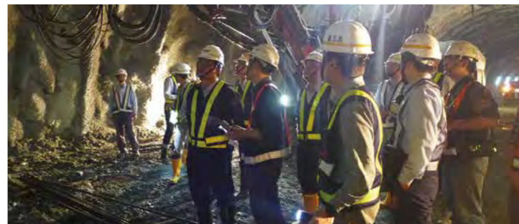
局長視察東澳隧道南口南下線工區現況
