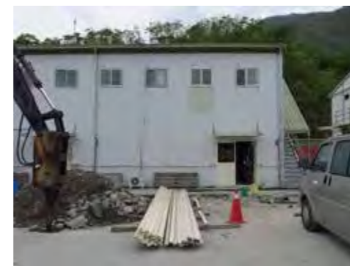
員工宿舍補強重建
