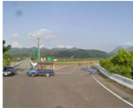
縣道 193 線鶴岡村南端出入瑞岡大橋現況
