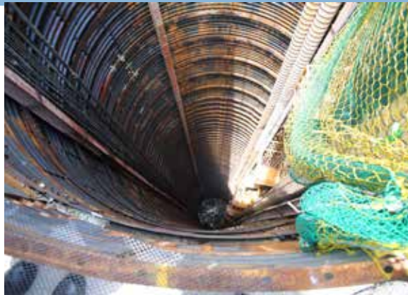
1 | 2 1. 集水井內設施工平臺以強化施工安全。 2. 台18線為阿里山地區重要交通命脈。
