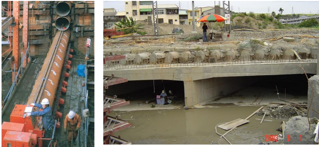
圖 4.4-3 管幕工法施工案例照片
