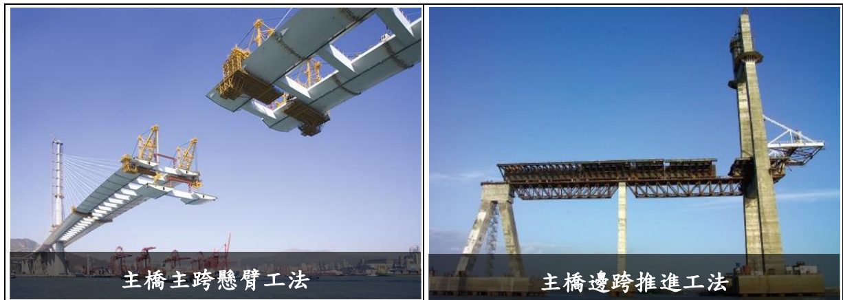
圖 2-12 主橋施工示意圖
