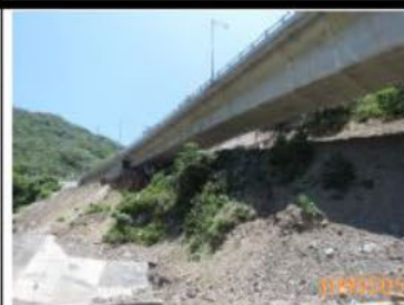
台九線下邊坡植被
