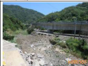
工區內楓港溪溪況
