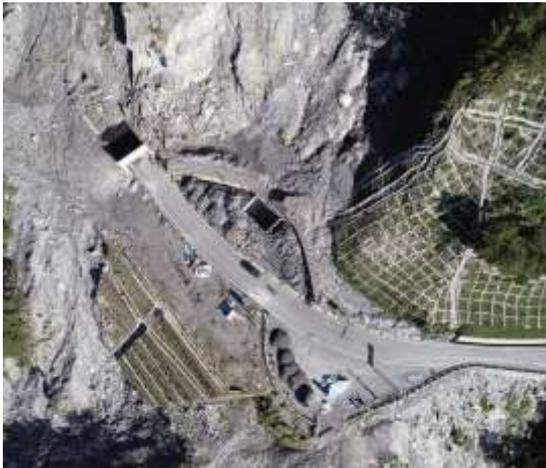
圖 6-75 大關山隧道東出口路基與邊坡復建工程。
