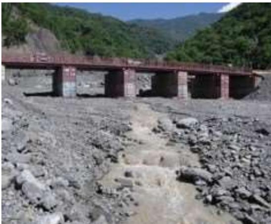
圖 6-29 塔拉拉魯芙橋鋼便橋。
