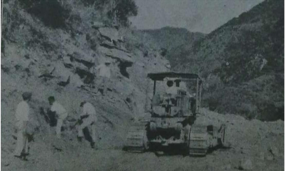
圖4-30 新武附近路基土石方工程。說明：推土機僅路線前端較平坦路線使用，上山後仍以人工為主。
