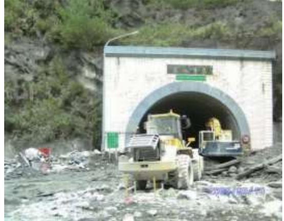
圖 6-21 碧山隧道土石淤積搶通情形。
