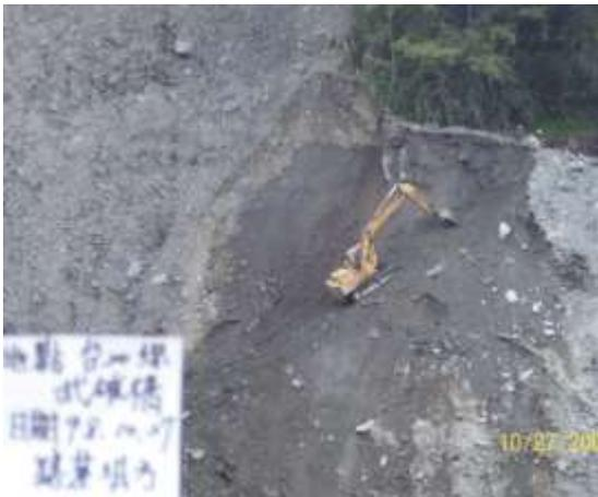
圖 6-18 武雄橋崩塌處挖掘便道的推土機。
