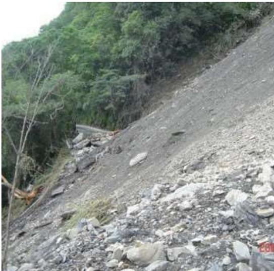
圖 6-10 176K+400 上邊坡崩塌與路基流失。
