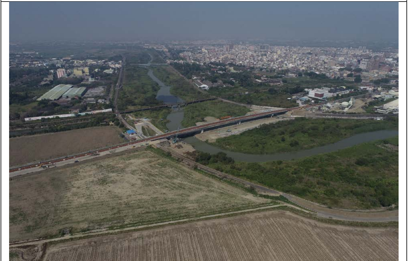
開發基地及急水溪空拍
