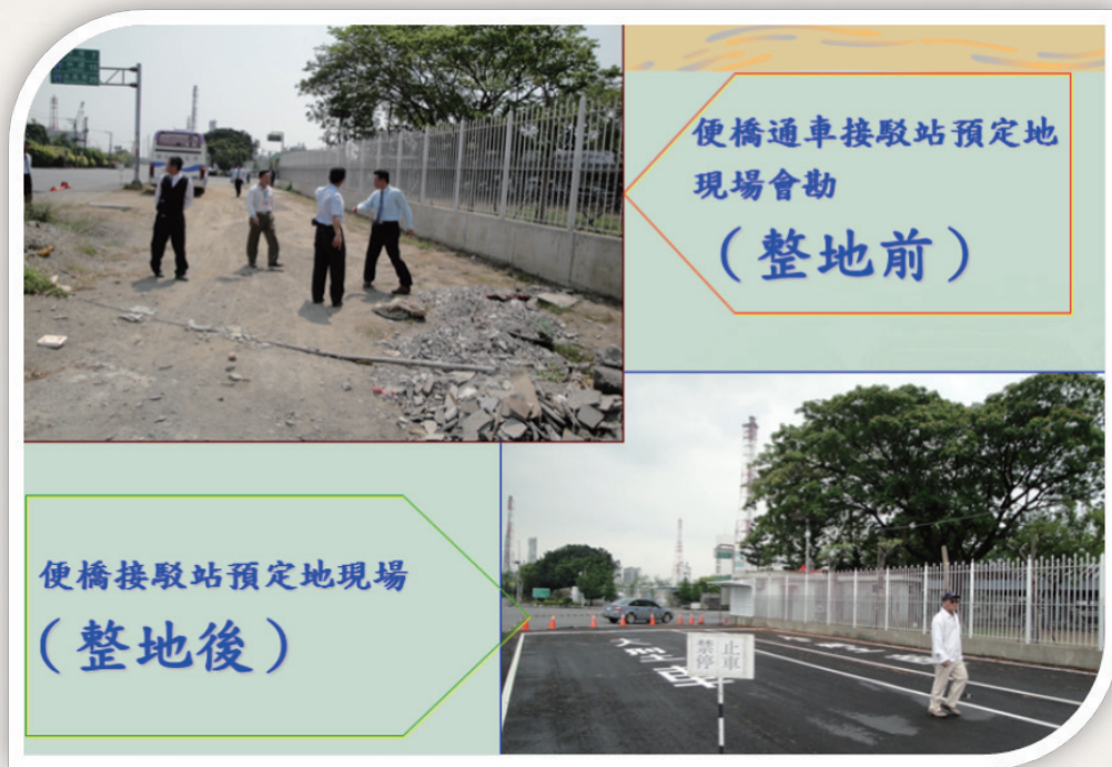
接駁站整地工程前後比較
