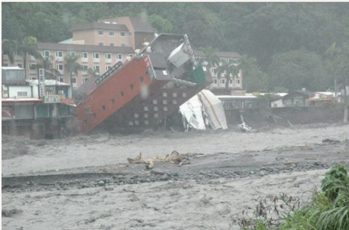
臺東縣知本鄉金帥飯店倒塌瞬間
