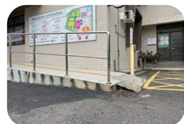
無障礙斜坡道
