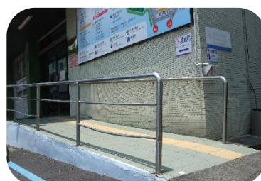
無障礙斜坡道
