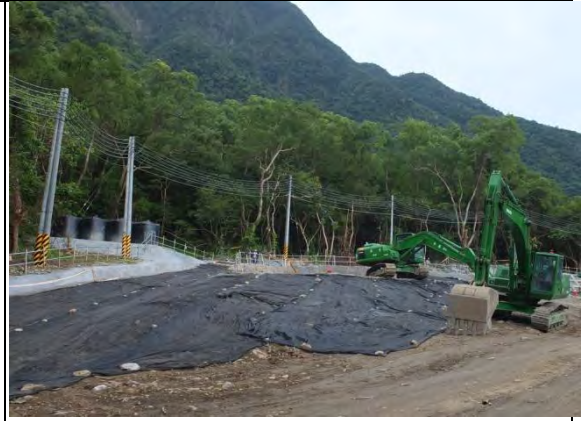
➤ C1 標工區實景：隧道洞口保護及排水工程
