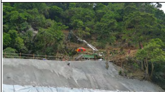
➤ A3 標工區：洞口平台與邊坡保護(ME-配特 04 空壓機)
