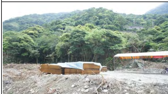
➤ A2 標工區巡訪：鋪築施工便道將使用之銲接鋼線網(MA-元山 01)
