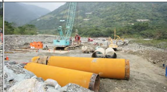
➤ A3 標工區實景：基樁工程用套管
