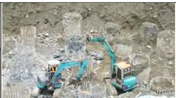
➤ A3 標工區巡訪：樁頂劣質混凝土敲除。
