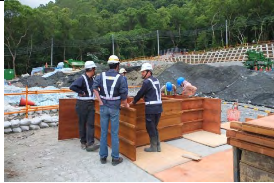
➤ C1 標工區巡訪：混凝土塊試體模板組立
