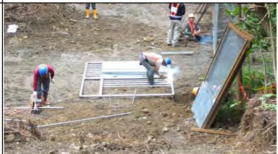
A2 標工區巡訪：工區圍籬鐵柵門銲接組立
