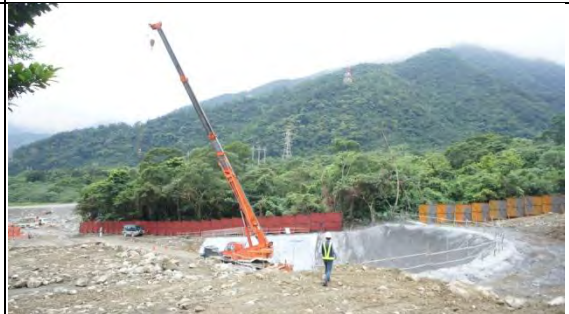
➤ A3 標工區巡訪：井式基礎工程與吊車(ME-田大 01)。
