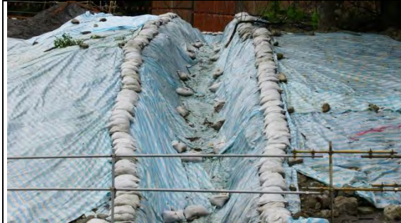
➤ A2 標工區巡訪：沉砂池進水口
