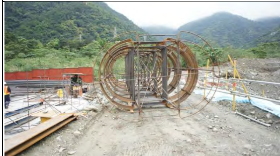
➤ A3 標工區巡訪：墩柱柱筋(田大公司負責)。
