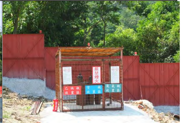
➤ A2 標工區(北口)：氧氣乙炔暫存區
