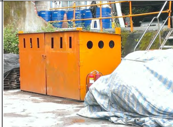
➤ C1 標工區巡訪：氣體鋼瓶暫置區
