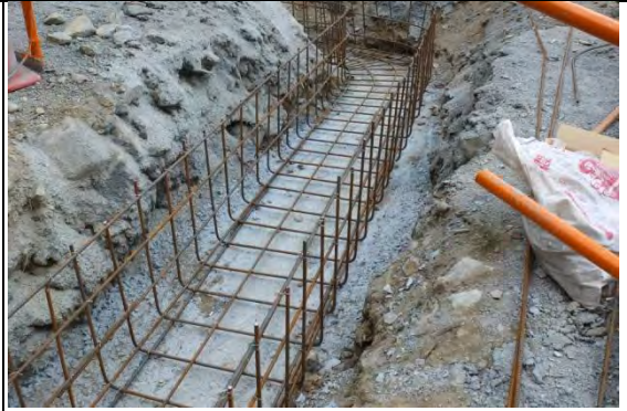
➤ C1 標工區巡訪：截水溝牆身模板組立
