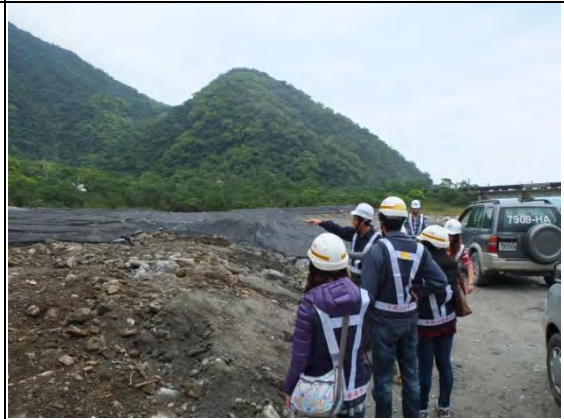
➤ C1 標工區實景：替代道路之填方工區
