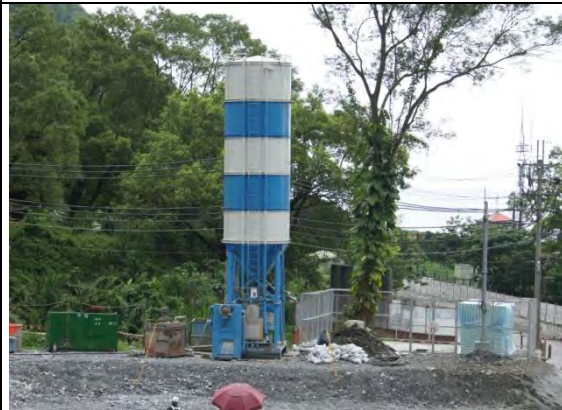
➤ C1 標工區巡訪：水泥置放桶
