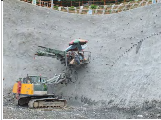
➤ C1 標工區：地盤改良孔鑽設
