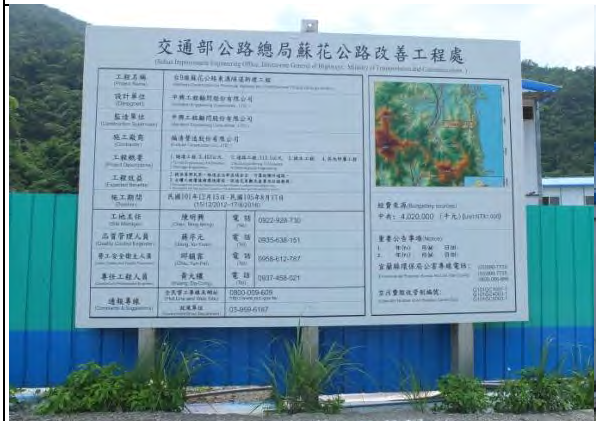
➤ A2 標工區：告示牌
