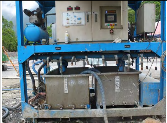
➤ C1 標工區：南口北上線地盤改良作業-灌漿水泥漿液調和槽
