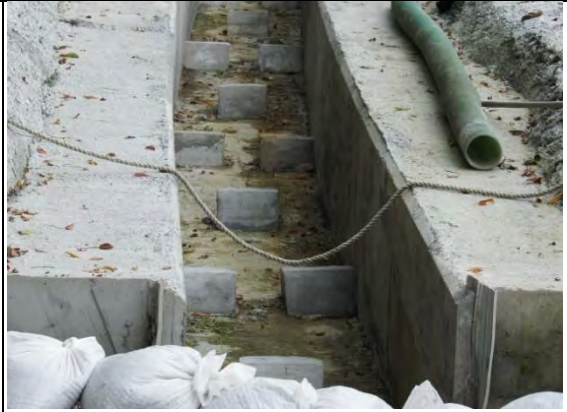
➤ C1 標工區巡訪：截水溝
