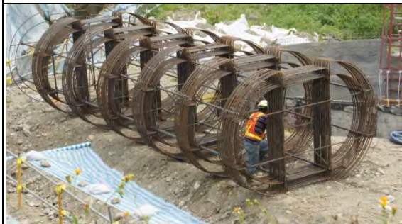
➤ A3 標工區：墩柱主筋鋼筋綁紮
