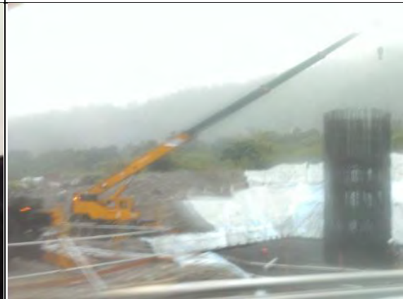
➤ A3 標工區巡訪(雨中)：ME-田大01 吊車(35t)
