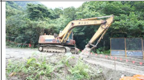
➤ A2 標工區巡訪：清除掘除所使用之挖土機(ME-長鴻 02)。
