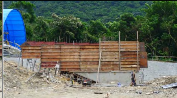
➤ A3 標工區：AN1 井基牆身
