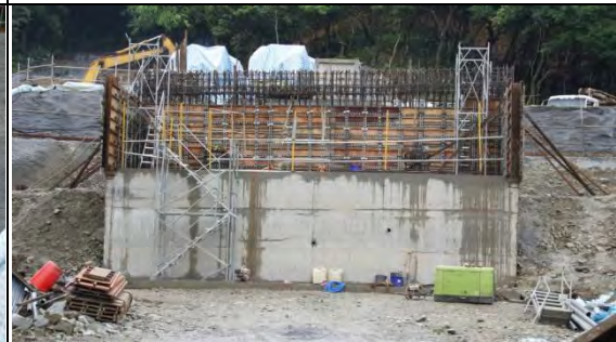
➤ A2 標工區巡訪：A2 標與 A3 標交接之橋臺-2(A3 標施作)
