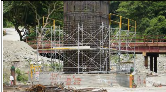
➤ A3 標工區：PN1 井基與墩柱
