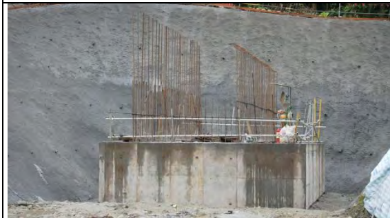
➤ A2 標工區巡訪：A2 標與 A3 標交接之橋臺-1(A3 標施作)
