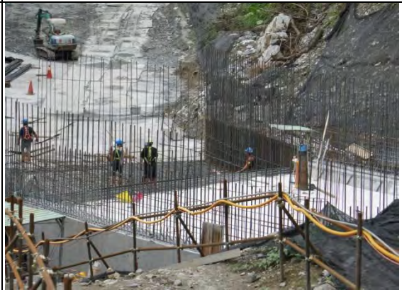
➤ C1 標工區巡訪：排水箱涵鋼筋綁紮
