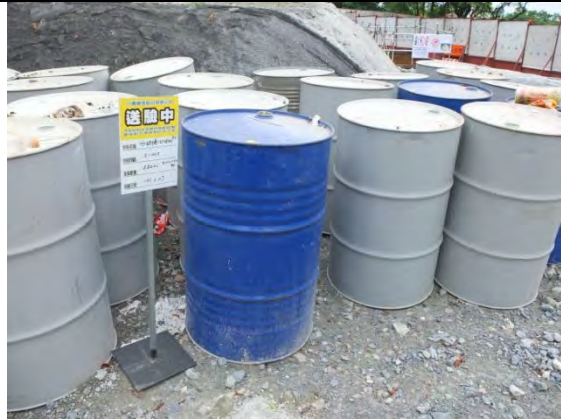
➤ C1 標工區：地盤改良作業用料-水玻璃桶暫存區
