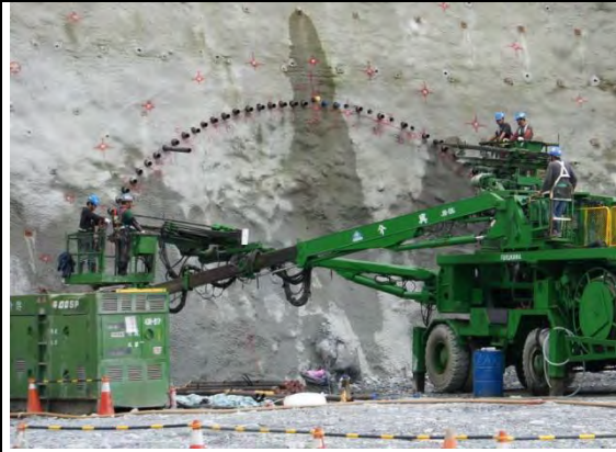
➤ C1 標工區巡訪：先撐管幕鋼管鑽設作業
