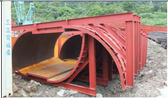
➤ A3 標工區巡訪：墩柱鐵模。
