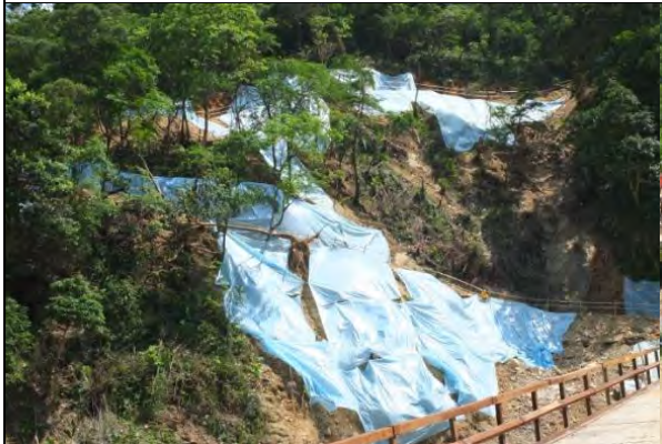
➤ A2 標工區(北口)：洞口施工情形
