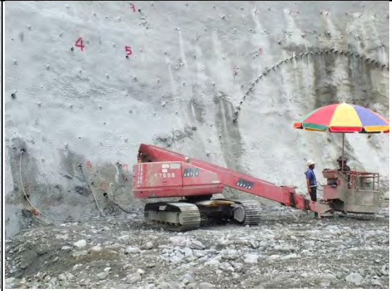
➤ C1 標工區：封堵材灌注
