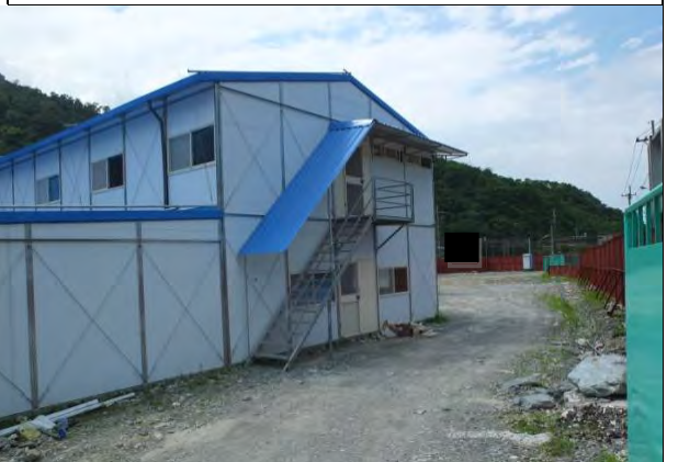
➤ A2 標工區：福清公司工務所
