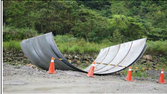
➤ A3 標工區巡訪：MA-田大 09 防撞鋼板
