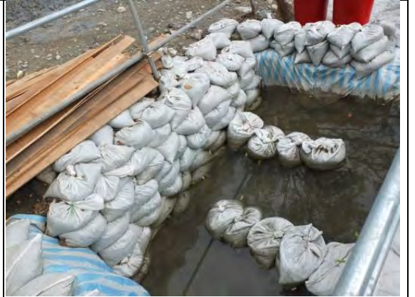
➤ C1 標工區實景：臨時沉砂池
