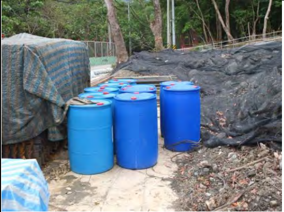
➤ C1 標工區實景：工程材料-速凝劑
