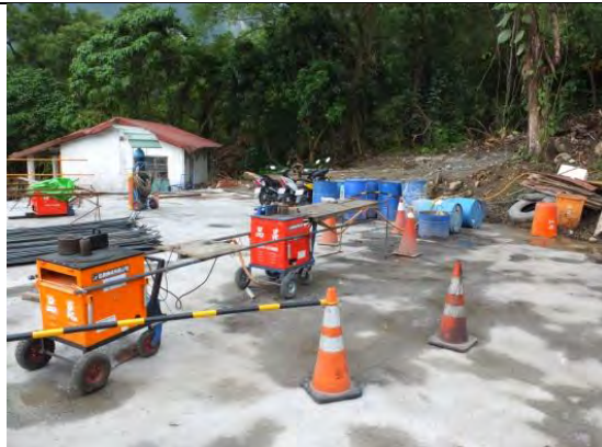
➤ C1 標工區巡訪：混鋼筋加工區
