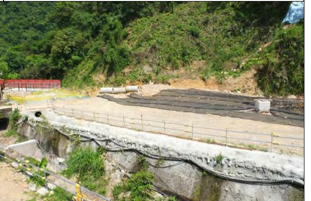
➤ A2 標工區(北口)：排水工程
