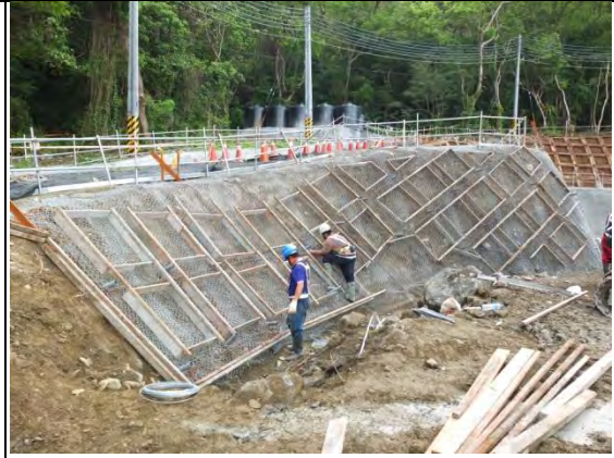
➤ C1 標工區實景：邊坡保護工程
