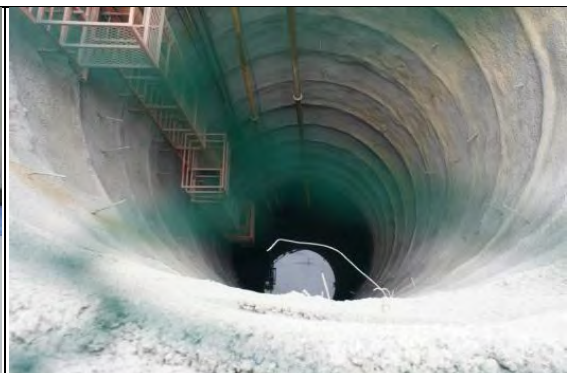
➤ A3 標工區實景：已完成之井基
