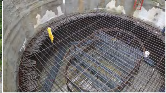
➤ A3 標工區巡訪：施做中井基
