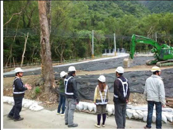
➤ C1 標工區實景：承商說明現場工作情形
