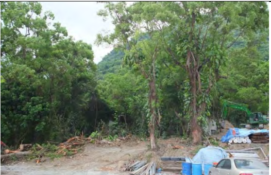
➤ C1 標工區巡訪：臨時鋼筋加工場
