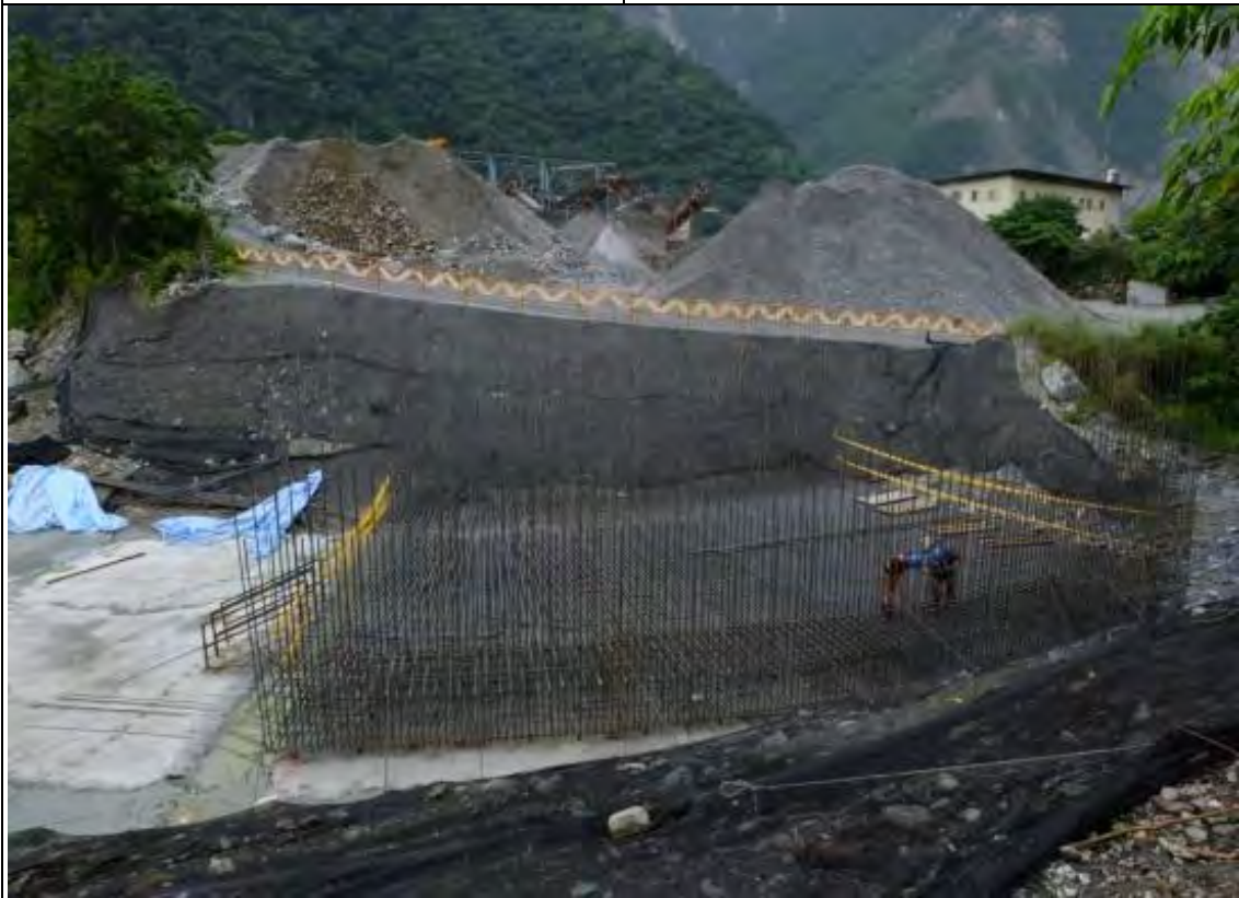
➤ C1 標工區巡訪：排水箱涵鋼筋綁紮作業
