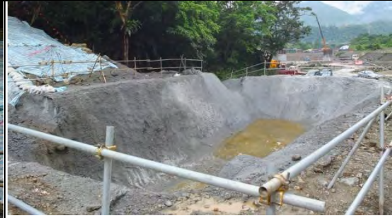
➤ A2 標工區巡訪：沉砂池與沉砂池出水口
