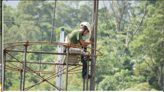
➤ A3 標工區：幸福高架橋工區 PS1 墩柱鋼筋綁紮
