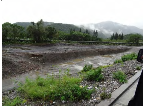
➤ A1 標工區：土方回填區
