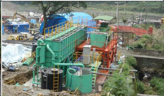
➤ A2 標工區(北口)：汙水處理設備設置
