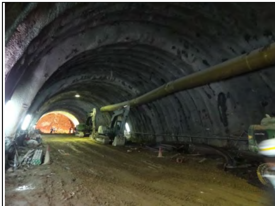
➤ C1 標南口：北上線隧道作業情形
