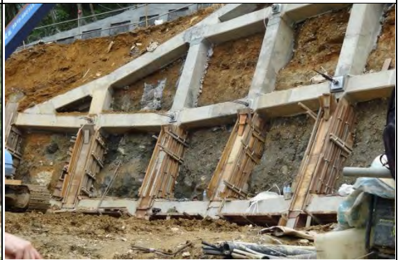
➤ A2 標工區(北口)：坡頂混凝土格樑(豎樑)模板組立
