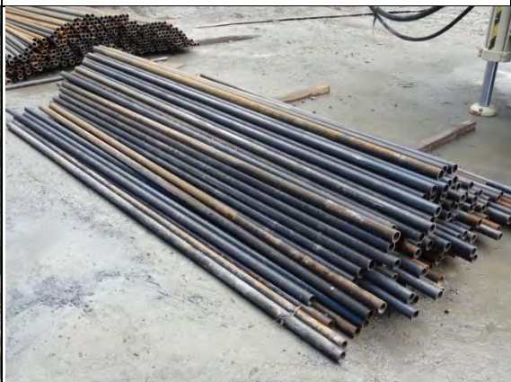
➤ A2 標工區(北口)：MA-威建 07 先 撐鋼管
