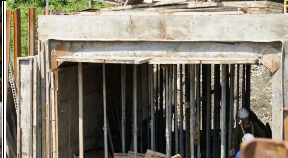
➤ A3 標工區：排水箱涵
