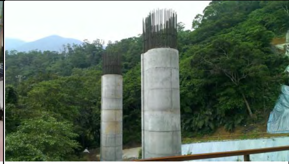
➤ A3 標工區：幸福高架橋工區 PS&PS1 墩柱現況
