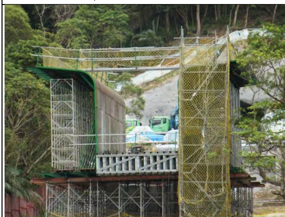
➤ A3 標工區：PS1 柱頭板組立
