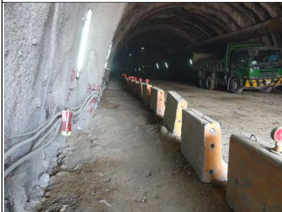
➤ C1 標南口：北上線隧道人行通道設置，使用 MA-00035 混凝土 175
