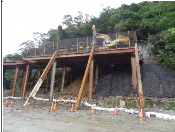
➤ A1 標工區：施工便橋與 PN6 井基 施工情形
