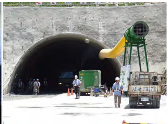
➤ C1 標工區：北上線隧道洞口
