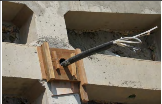
➤ A2 標工區(南口)：邊坡格梁預力鋼腱混凝土底座
