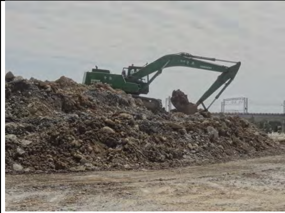
➤ C1 標南口二工區：土方暫置區整理作業，使用機具-挖土機 BH-93
