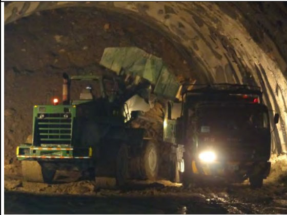
➤ C1 標南口北上線：隧道開挖作業使用機具-裝載機 PL-10、傾卸車 DT-32
