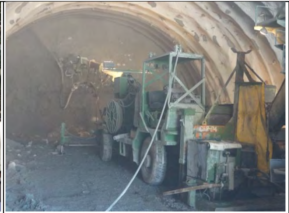
➤ C1 標工區：北上線隧道開挖作業-鋼纖噴凝土作業
