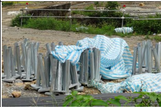
➤ A2 標工區(北口)：預力地錨鋼襯板
