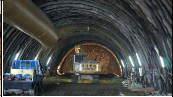
➤ A2 標工區：東澳隧道南口南下線
