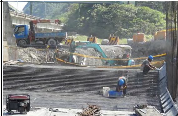
➤ C1 標南口：排水箱涵底板鋼筋綁紮作業
