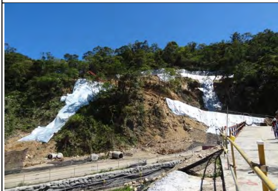
➤ A2 標工區(北口)：邊坡降挖情形
