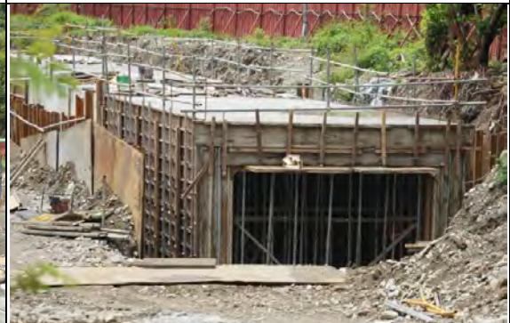
➤ A3 標工區：排水箱涵頂板灌漿
