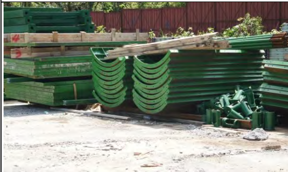
➤ A3 標工區：MA-樂志 04 工作車構件
