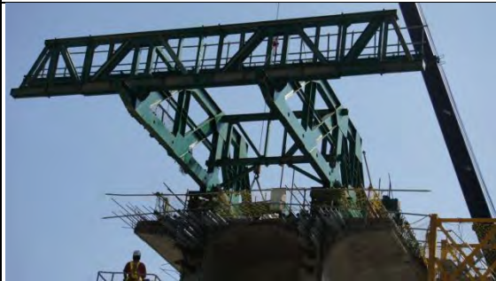
➤ A3 標工區：東澳北溪河川橋工區 PS2 墩柱工作車設置
