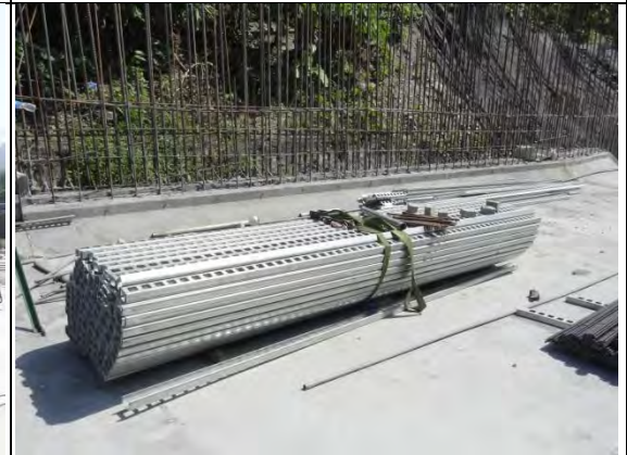
➤ C1 標南口：排水箱涵牆身模板組立工料堆置區
