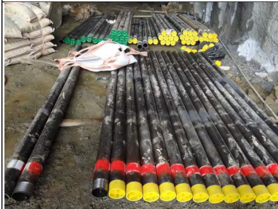
➤ A2標南口南下線：管幕鋼管
