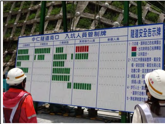
➤ C1 標工區：北上線隧道洞口安全告示牌
