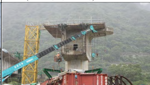
➤ A3 標工區：PN3 柱頭板施作
