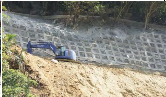
➤ A3 標工區：東岳隧道自由型格梁
