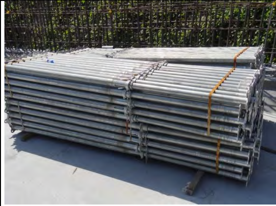
➤ C1 標南口：排水箱涵頂板支撐系統 工料堆置區
