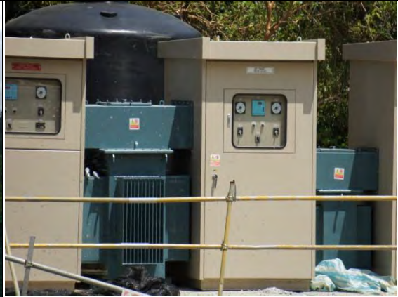
➤ A2 標工區(南口)：工區變電箱設置
