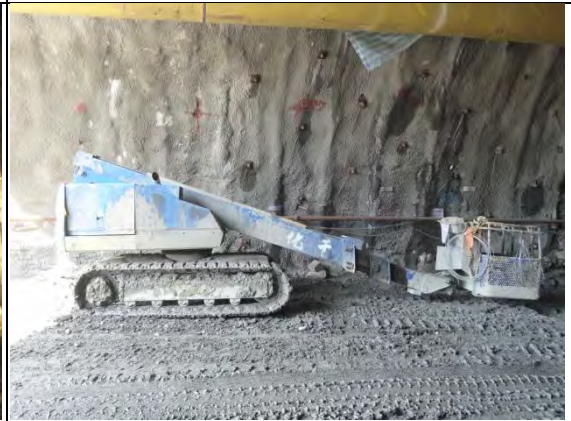
➤ C1 標南口北上線：隧道開挖作業使用機具-高空作業車 千化-01
