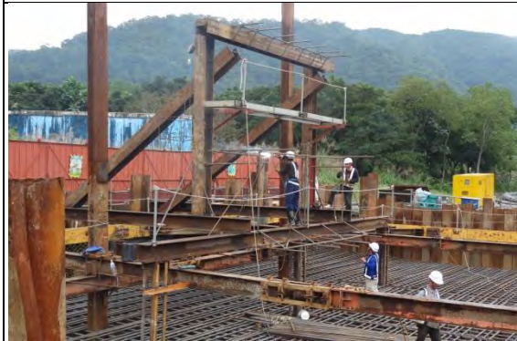
➤ A1 標工區：P38 基樁景觀橋輔助施工架組立
