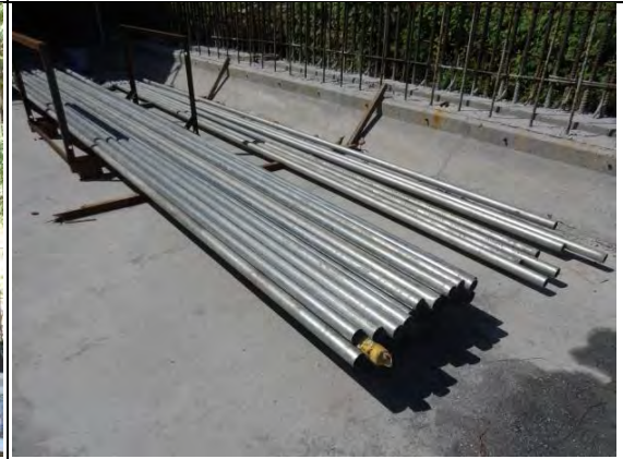
➤ C1 標南口：排水箱涵模板支撐工料堆置區
