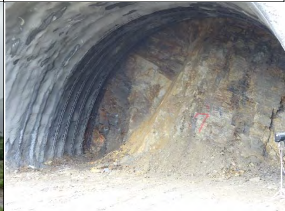
➤ A2 標工區(北口)：北上線隧道開挖作業
