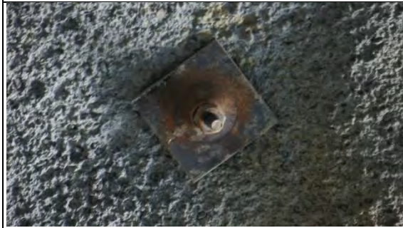
➤ A3 標工區：東岳隧道北口使用工料，MA-配特 10 岩栓
