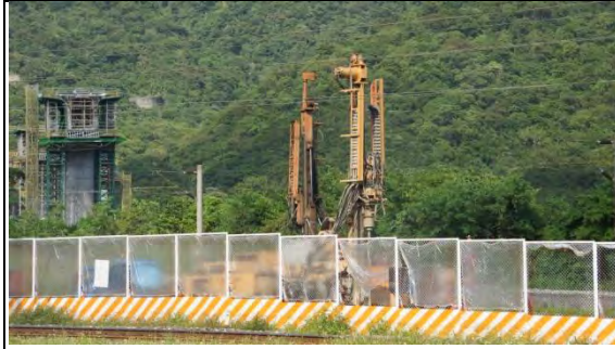
➤ A3 標工區：東澳北溪河川橋工區 PS9 井基地質改良機具 ME-弘大 鑫 21 鑽機
