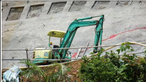
➤ A3 標工區：東岳隧道南口洞口平台與邊坡保護所使用機具，ME-配特 05
