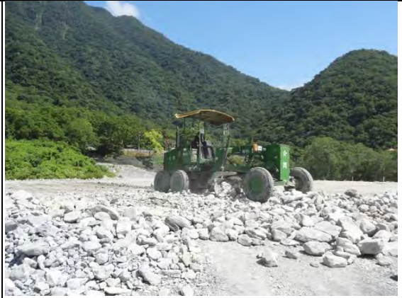
➤ C1 標南口二工區：路堤填築整平作業，使用機具-平路機 MG-01
