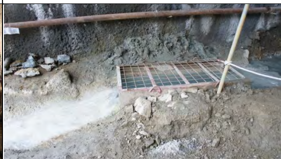
➤ A2 標工區：量水堰- 直角三角堰(回收再使用工料)
