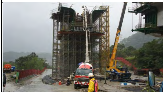
➤ A3 標工區：PN4 柱頭板腹板混凝土澆置
