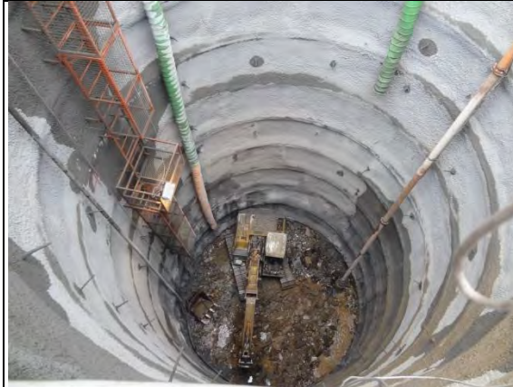
➤ A1 標工區：PN7 井基挖掘及北勝 機具 ME-北勝 07
