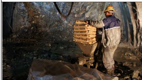
➤ A2 標工區：預力岩栓所用之水泥
