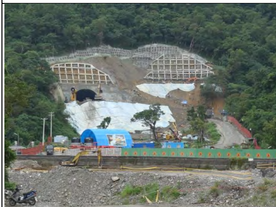
➤ A2 標工區(北口)：北口南下線隧道 與北上線降挖工程
