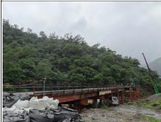
➤ A1 標工區： 施工便橋
