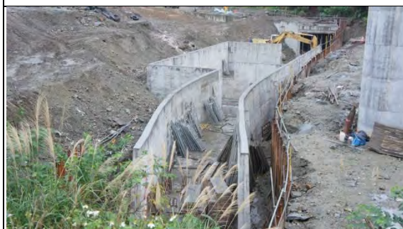
➤ A3 標工區：排水箱涵及挖土機 ME-弘大鑫 01
