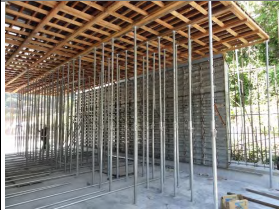
➤ C1 標南口：排水箱涵頂版底模支撐系統
