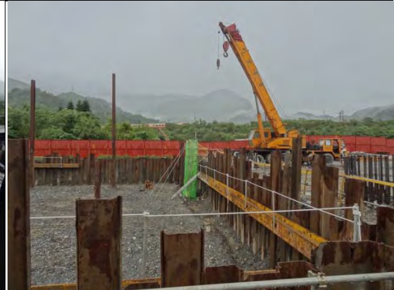
➤ A1 標工區：P38 基礎鋼板樁施作
