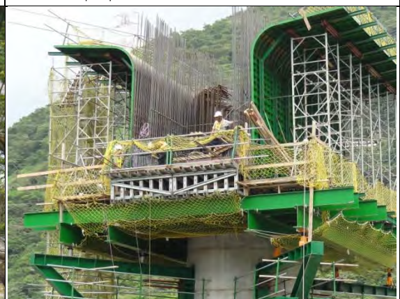
➤ A3 標工區：PS2 柱頭板鋼筋綁紮
