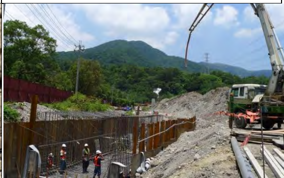
➤ A3 標工區：幸福高架橋排水箱涵混凝土澆置
