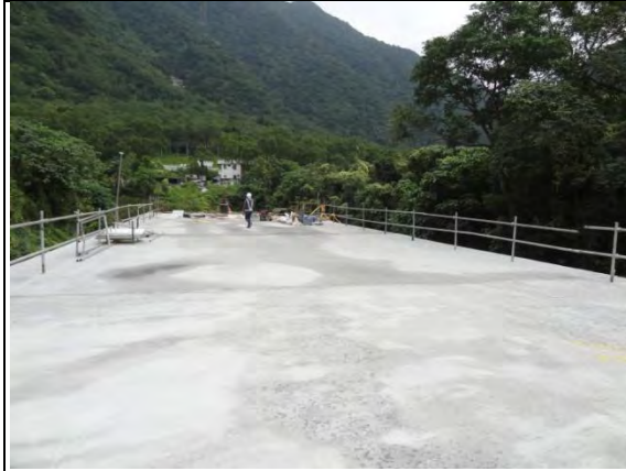
➤ C1 標南口：一工區排水箱涵頂版混凝土養護
