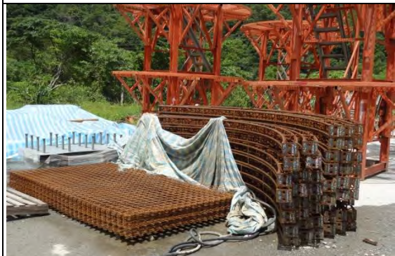
➤ A3 標工區：MA-弘大鑫 02 桁架支保、點焊網
