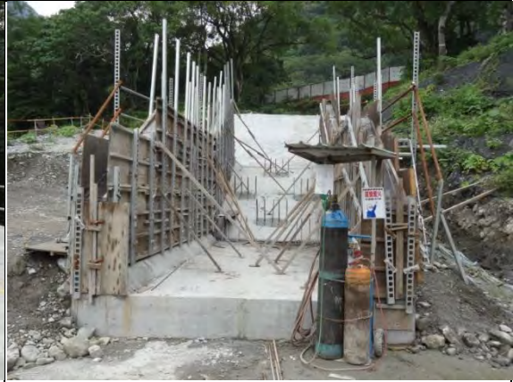
➤ C1 標南口：二工區明溝側牆模板組立作業
