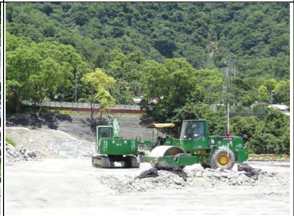
➤ C1 標工區：二工區棄土回填作業
