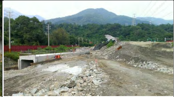
➤ A3 標工區：幸福高架橋工區排水箱涵施作情況
