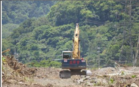
➤ A3 標工區：ME-益群豐 01 挖土機
