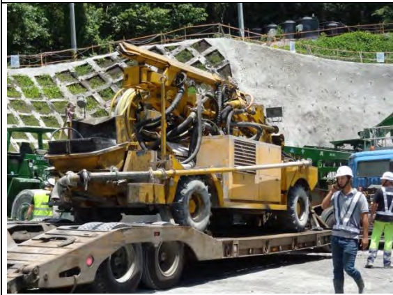
➤ C1 標工區：機具運入(高效能噴漿機)
