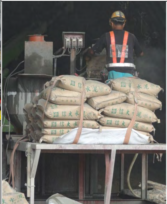
➤ A2標南口南下線：管幕灌漿水泥漿液拌合設備
