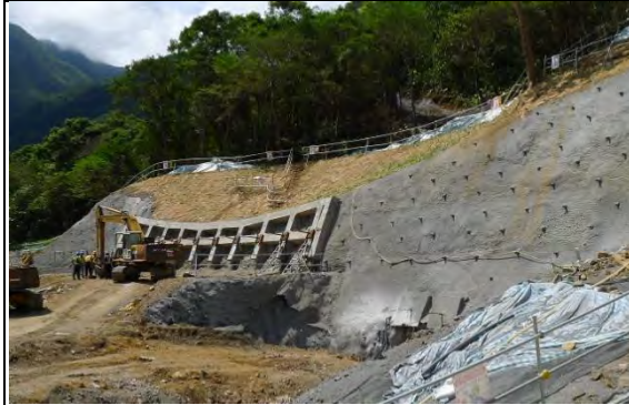
➤ A2 標工區(南口)：邊坡地盤改良及混凝土格梁作業
