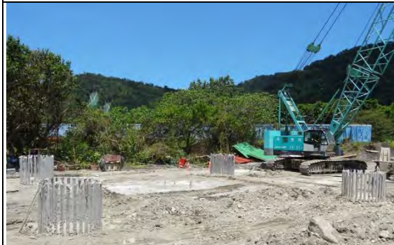
➤ A1 標工區：頤達 P38 試樁
