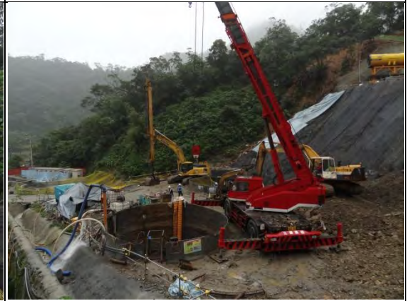
➤ A2 標工區(北口)：北勝吊車
