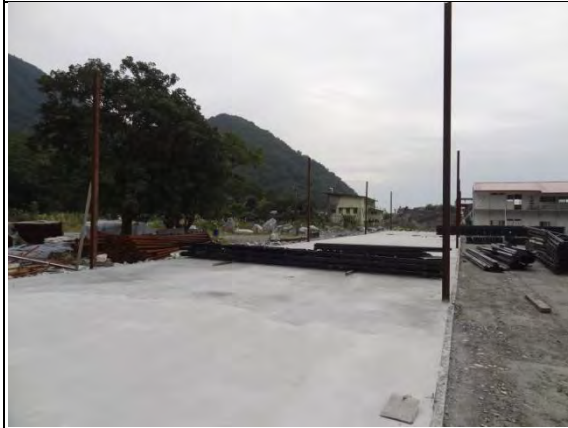
➤ C1 標南口：辦公房舍組合屋底板澆置，使用工料：MA-0005 混凝土 210
