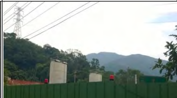
➤ A3 標工區：幸福高架橋工區 PS2 與 PN2 墩柱(PS2 墩柱已裝設盤式支承、PN2 尚未裝設)
