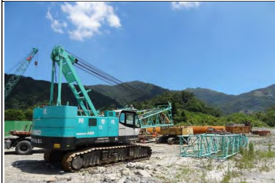
➤ A1 標工區：ME-頤達 02 吊車(尚未組裝)
