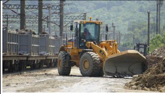
➤ A2 標工區：東澳車站棄土暫置場 AB019 鏟裝機
