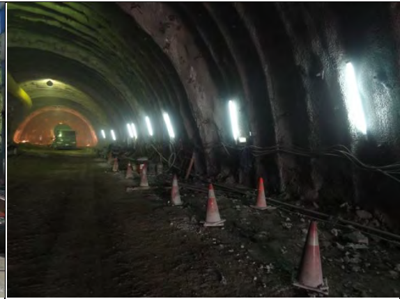
➤ C1 標南口：隧道用電設備檢視
