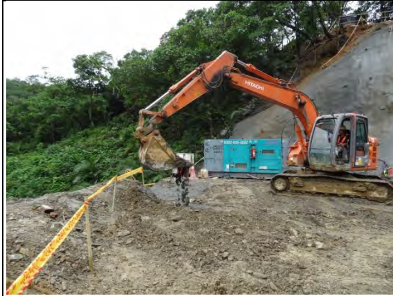
➤ A2 標工區(北口)： 隧道洞口混凝土排水溝澆置
