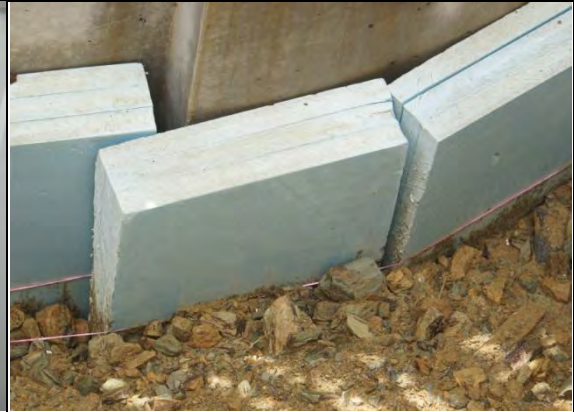
➤ A3 標工區：MA-益群豐 04 成型填縫板
