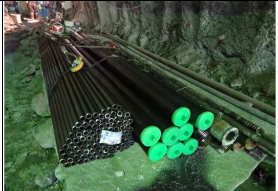
➤ C1 標南口北上線：隧道開挖及支撐工料-管幕鋼管、自鑽式岩栓
