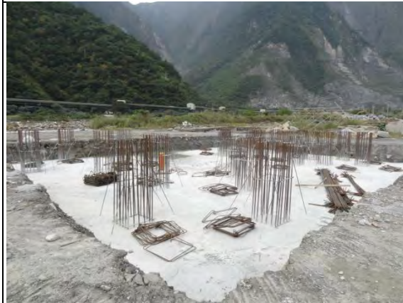
➤ C1 標南口：預拌廠基礎鋼筋綁紮
