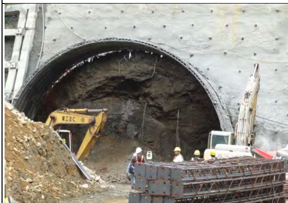
➤ A2標南口北上線：洞口假隧道支保組立
