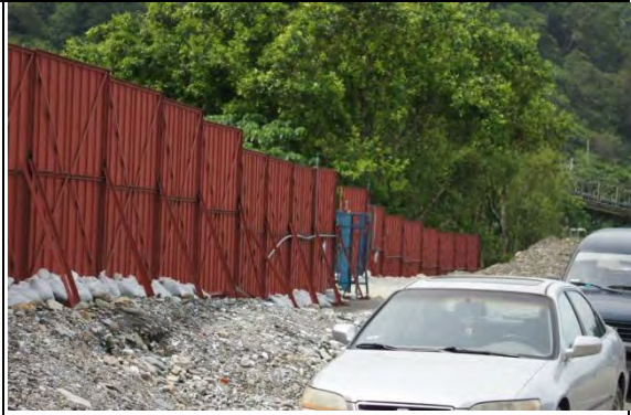
➤ A1 標工區：已完成之圍籬工程 (P38 基樁旁)
