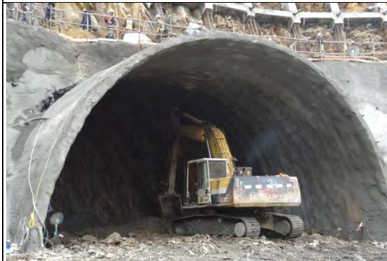
➤ A2 標工區(北口)：南下線隧道開挖作業
