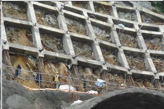
➤ A2 標工區(北口)：南下線隧道護坡混凝土格樑鋼筋綁紮
