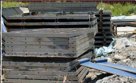
➤ A3 標工區：MA-益群豐 08 鋼模板
