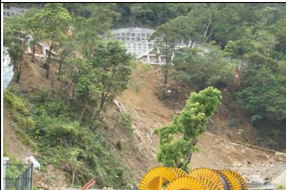
➤ A2 標工區(北口)：洞口邊坡降挖
