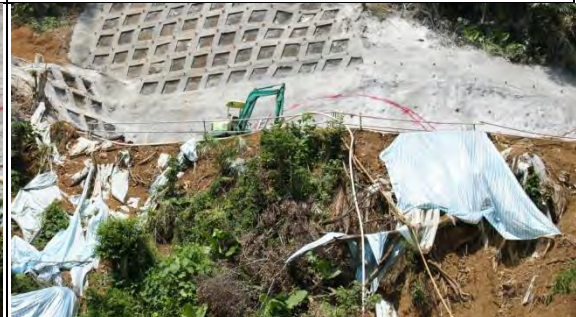
➤ A3 標工區：東岳隧道南口洞口平台與邊坡保護工程
