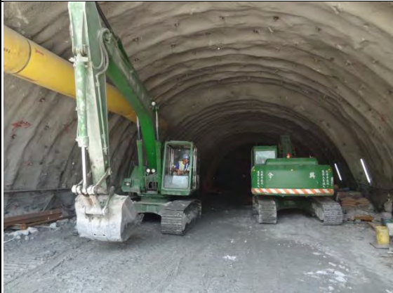
➤ C1 標南口南下線：隧道開挖及支撐工程-隧道開挖作業
