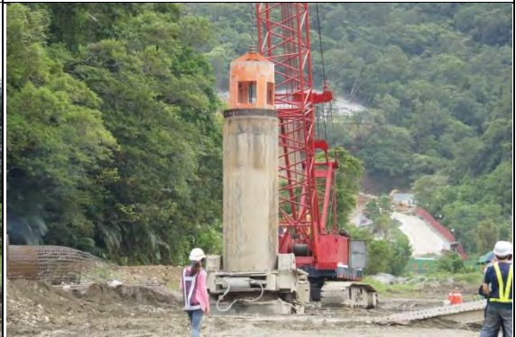
➤ A1 標工區：P5 基樁施作(旭盛營造)
