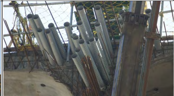
➤ A3 標工區：東澳北溪河川橋工區 PS2 墩柱使用工料，MA-樂志 05 預力套管
