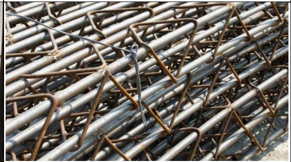
➤ A2 標工區：MA-威建 03 桁架型鋼支堡
