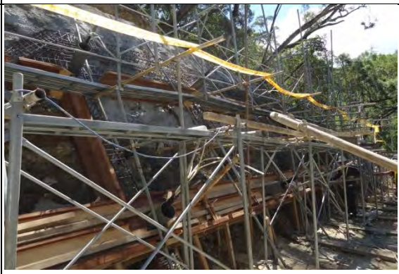
➤ A2 標工區(北口)：混凝土格樑模板組立
