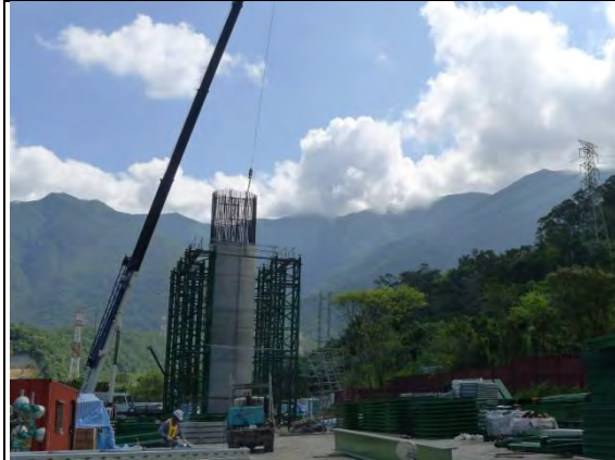
➤ A3 標工區：東澳北溪河川橋墩柱柱頭支撐架準備工作
