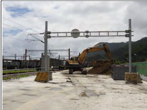
➤ A2標：東澳車站土方暫置區
