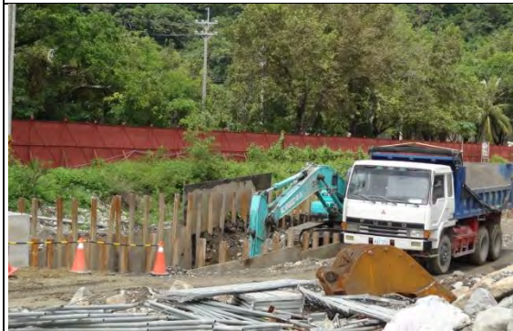
➤ A3 標工區：排水箱涵鋼軌樁
