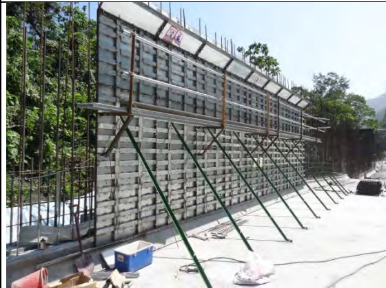
➤ C1 標南口：排水箱涵牆身模板組立
