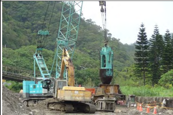
➤ A1 標工區：P37 基樁施工(頤達營造)
