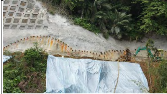
➤ A3 標工區：幸福高架橋工區東岳隧道南口施作情形
