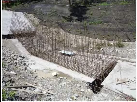
➤ C1 標南口二工區：排水箱涵底板 鋼筋綁紮
