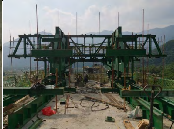
➤ A3 標工區：東澳北溪河川橋工區懸臂工作車鋼模調整
