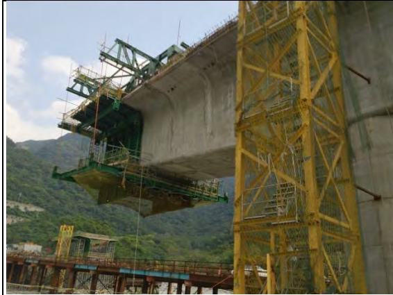
➤ A3 標工區：東澳北溪河川橋工區 PS2 墩柱與懸臂工作車
