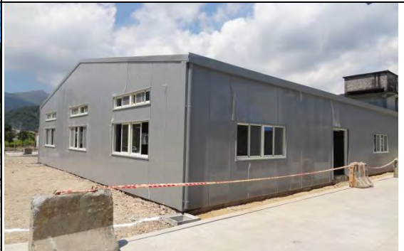
➤ A2 標工區(工程展示館)
