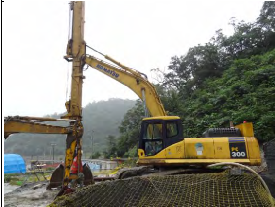
➤ A2 標工區(北口)：機具 ME-北勝 01 PC300 挖土機
