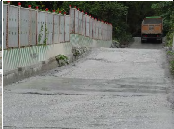
➤ C1 標南口：進出道路破損修復，使用工料：MA-0007 混凝土 280
