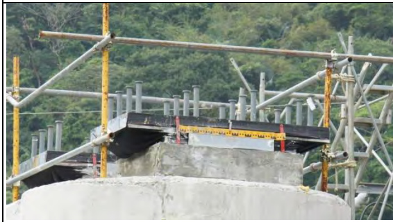
➤ A3 標工區：幸福高架橋工區 PS2 墩柱與已裝置盤式支承
