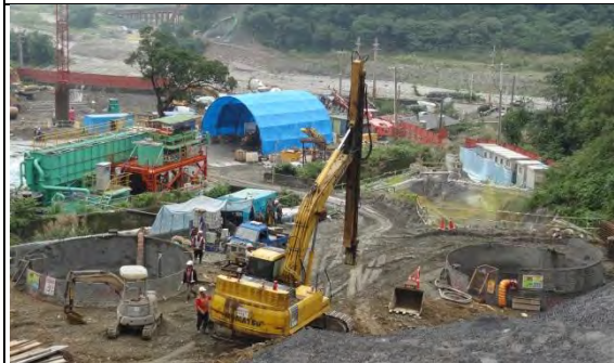
➤ A2 標工區(北口)：PA1、PA2 井基協力廠商-北勝進場施作
