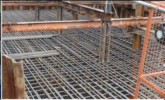
➤ A1 標工區：P38 基樁工程基礎鋼筋綁紮
