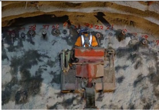
➤ C1 標南口北上線：隧道開挖及支撐工程-管幕灌漿作業
