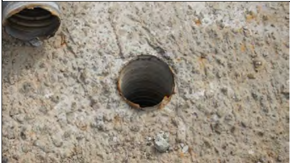
➤ A3 標工區：工作車套件預力鋼棒預留孔
