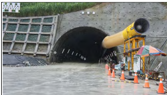
➤ A2 標工區：南口北上線洞口與風機
