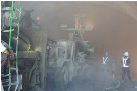
➤ C1 標南口南下線：隧道開挖及支撐工程-鋼纖噴凝土施噴作業
