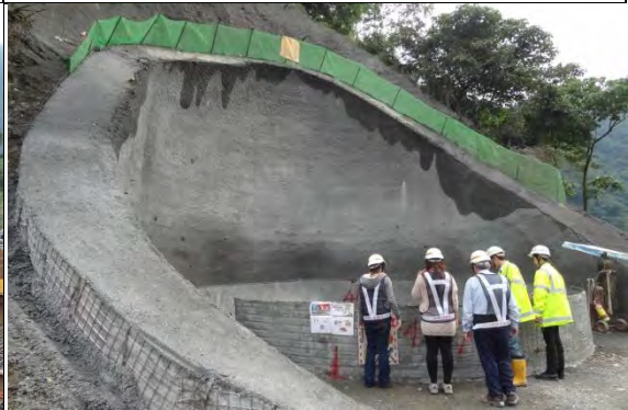
➤ A1 標工區：PN7 井基工程護坡竹削施作
