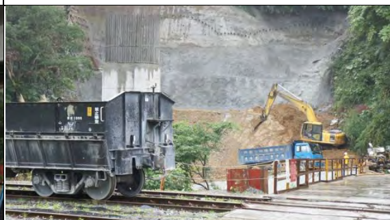
➤ A3 標工區：東岳隧道南口邊坡保護工程
