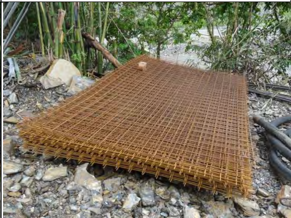
➤ A1 標工區：工料 MA-北勝 01 點 焊網
