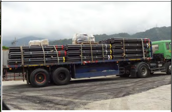
➤ A2 標工區(北口)：管幕鋼管運入
