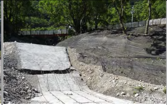
➤ C1 標南口二工區：排水箱涵位置
