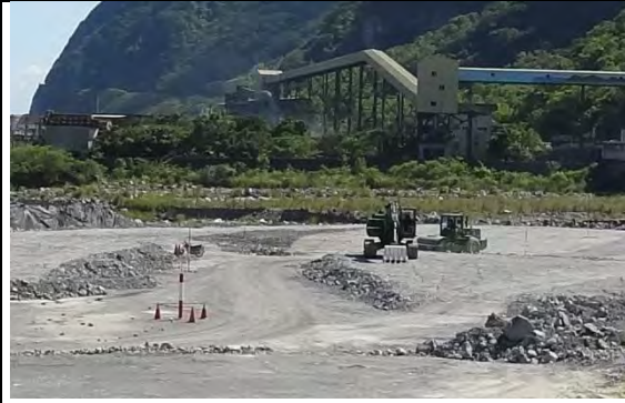
➤ C1 標南口二工區：路工工程土方回填
